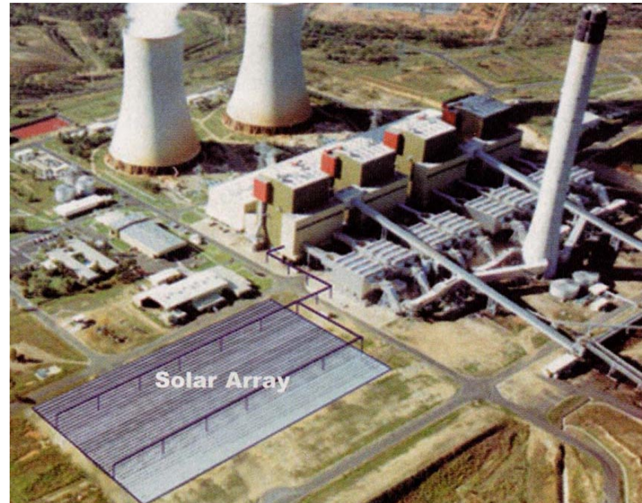
Abb. A1.2: Visualisierung des 17.000\text{ m}^2 großen CLFR-Solarfeldes ( 13\text{ MW}_{\text{th}} ) neben dem Kohlekraftwerk ( 1,44\text{ GW}_{\text{el}} ) bei Rockhampton, Australien. Darstellung aus Mills et al. (2000).
