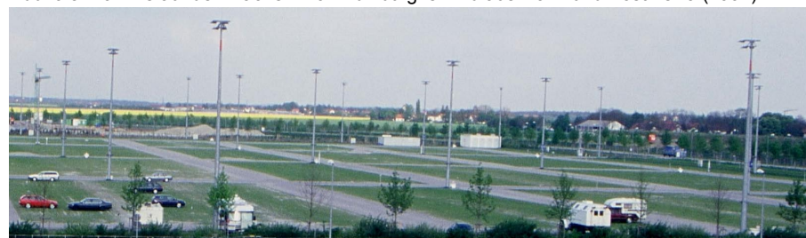
Abb. 9.9: Parkplatz und Ausstellungsfläche mit Lichtmasten der neuen Messe in München.
