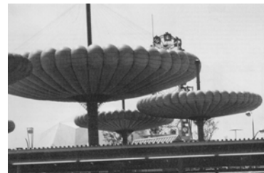
Abb. 3-85. Pneumatische Schirme, Osaka (14)
