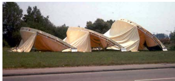
Abb. 4-79. Aufrichten der Bögen (59)
