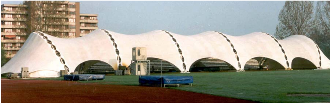
Abb. 4-74. Überdachung einer Leichtathletikanlage (59)
