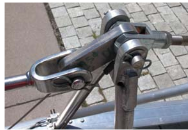
Abb. C-59. Anschlussvarianten Obergurt - A Frame
