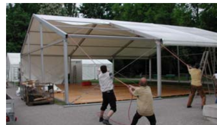
Abb. 4-30. Membranmontage
