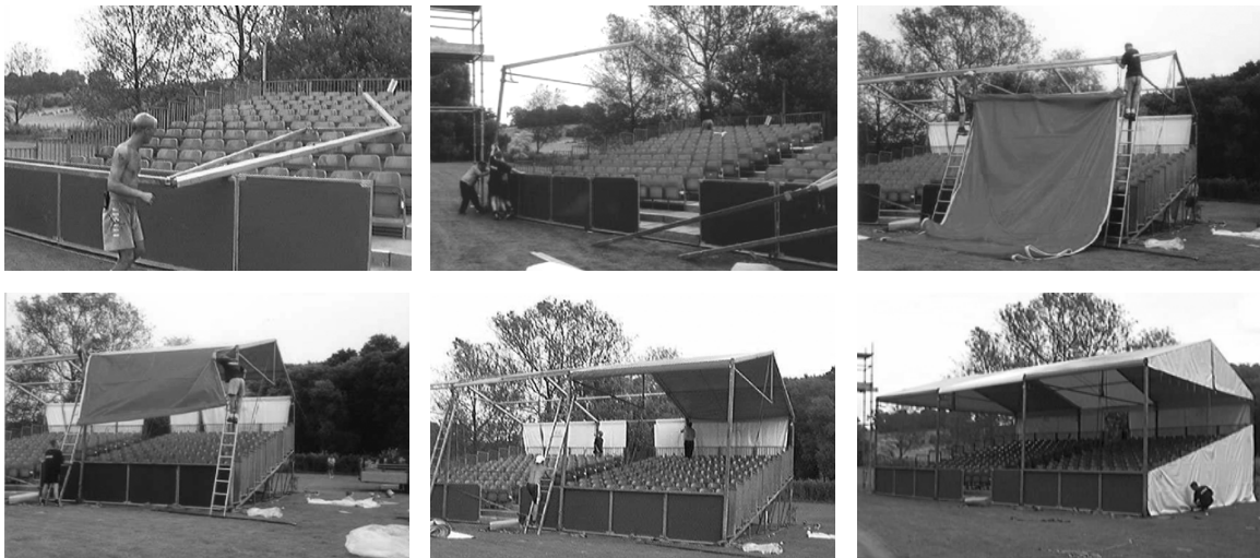
Abb. 7-1. Aufbausequenzen der bestehenden Überdachung der Firma ARENA
