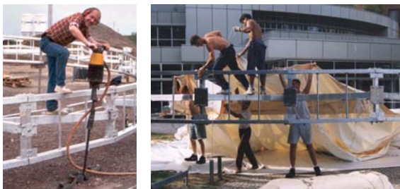
Abb. 4-78. Setzen der Erdnägel und Bogenmontage (59)
