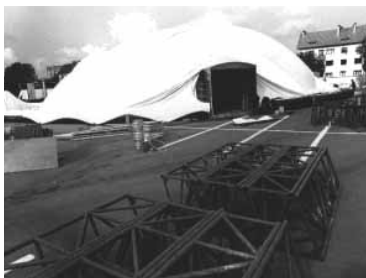
Abb. 4-91. Aufblasen der Membran (58)
