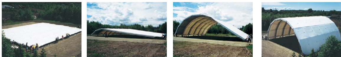
Abb. 4-73. Aufrichtvorgang (66)
