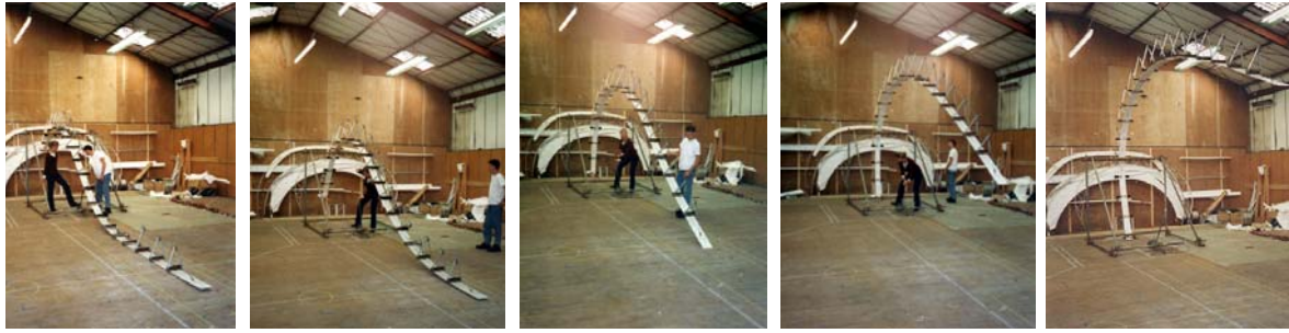
Abb. 7-11. Konzeptmodell während des Aufrichtvorgangs
