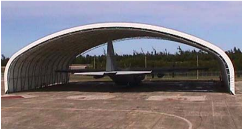
Abb. 4-36. Sonnenschutz Spannweite 46 m (41)
