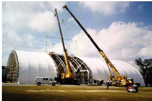
Abb. 4-40. Membranmontage (41)
