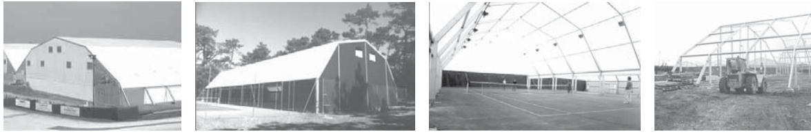
Abb. 6-1. Verschiedene Tennishallen der Firma Walther UK Ltd. (46)
