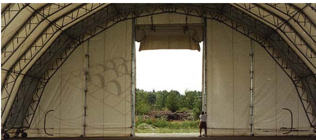
Abb. 4-67. Innenansicht einer Lagerhalle, (66)
