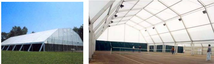
Abb. 4-24. Walu Tennishalle Aussen- Innenansicht (46)
