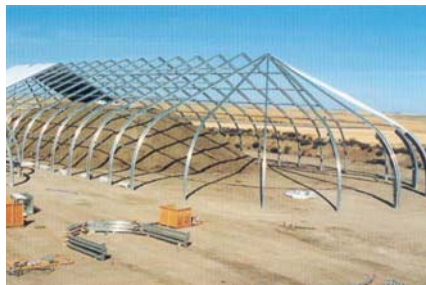
Abb. 4-46. Klemmprofil, Rahmenhalle im Aufbau, Montage Dämmung (60)
