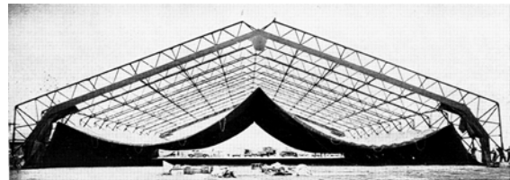
Abb. 3-41. Membranmontage (23)
