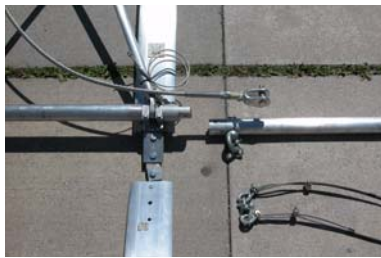
Abb. C-58. Anschluss Verband - Kragträger
