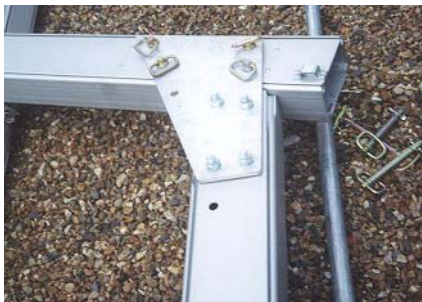
Abb. 4-27. Varianten der Rahmenecke
