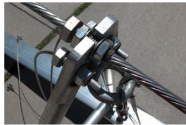
Abb. C-59. Anschlussvarianten Obergurt - A Frame
