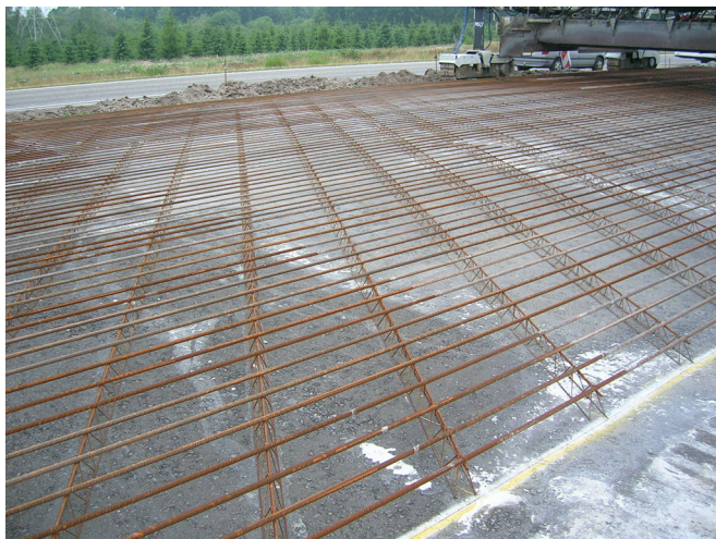
Abb. 1.2: Durchgehend bewehrte Betonfahrbahn – ausgelegte Längs- und Querbewehrung A 50 (N 265) Veghel-Uden, Niederlande (2004)
