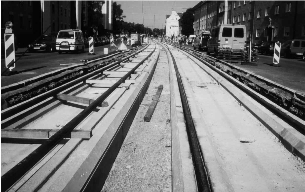
Abb. 2.2: Betontragplatte mit trogförmigen Aussparungen (im rechten Gleis sind die Schienen SA 42 bereits in den Trögen ausgerichtet), Agnes Bernauer Straße, München
