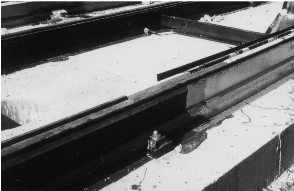
Abb. 2.6: Kontinuierlich eingegossene Rillenschiene mit Schalung (Im Vordergrund ist die Blechschalung bereits entfernt.)
