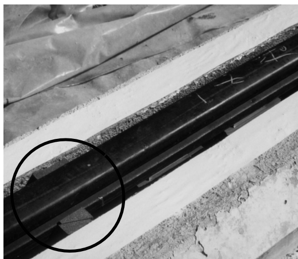
Abb. 2.4: Klemmkeile zur Ausrichtung der Schiene SA 42 in der Lage
