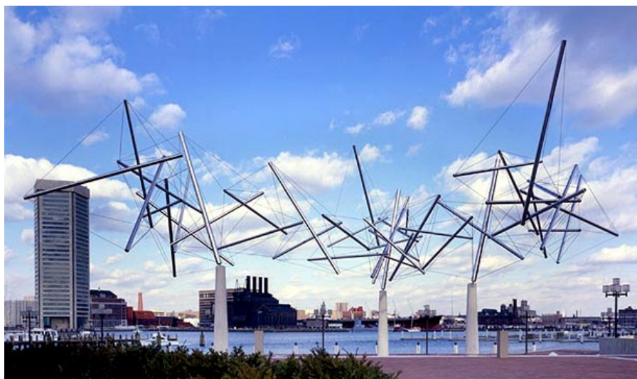
4.76: Easy Landing, Baltimore, Kenneth Snelson, 1977, Beispiel für Tensegrity -Tragwerk
