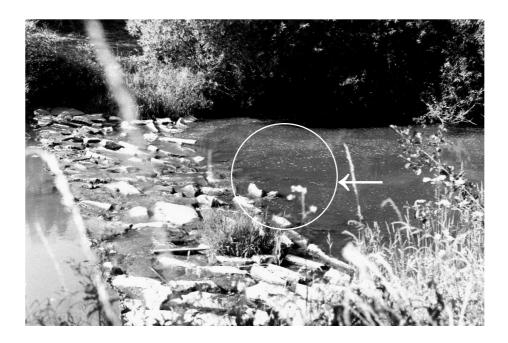
Abb. 51: Flach überströmte Rampe, die von größeren Fischen nicht überwunden werden konnte. Pfeil: Bevorzugter Standort der Fische im Unterwasser, Rott
