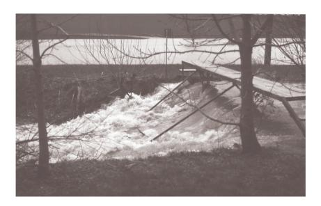
Abb. 73: Hochwasserabfluß, Bina: Vorne: Ausleitungswehr der Loichlmühle, hinten: bei Hochwasserabfluß frei durchwanderbares Tertiärgerinne (normalerweise Dauergrünland)
