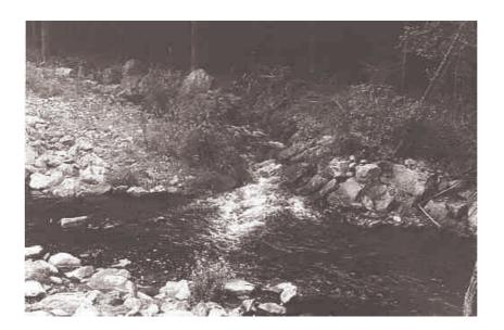
Abb. 24: Wanderhilfe Linden, zu steil errichteter Abschnitt, Saußbach
