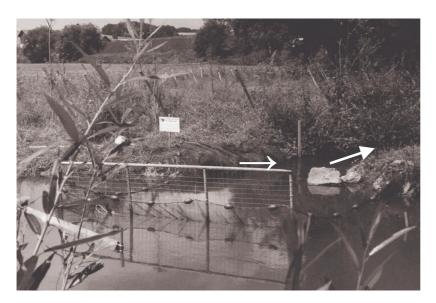
Abb. 22: Ausleitung der Wanderhilfe Eitting (Pfeil), abgesperrt durch Fangreuse mit Stahlrahmen und Schwimmbalken zur Vermeidung von Treibgutanlagerungen und Anheben des Netzflügels, Kleine Laber
