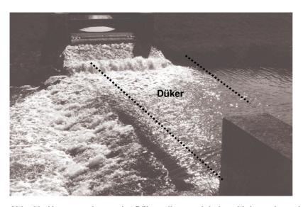
Abb. 38: Kreuzungsbauwerk / Düker, die gestrichelten Linien zeigen den unter dem Flutkanal liegenden Verlauf des Dükers, Bewertung flußauf: 5, flußab: 3, Rott
