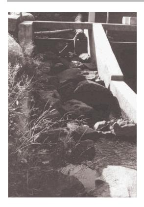
Abb. 56: Bei Niedrigwasserabfluß nur gering durchströmte Wanderhilfe, Saußbach
