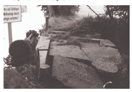
Abb. 46: Baufälliges Ausleitungswehr, Kleine Laber
