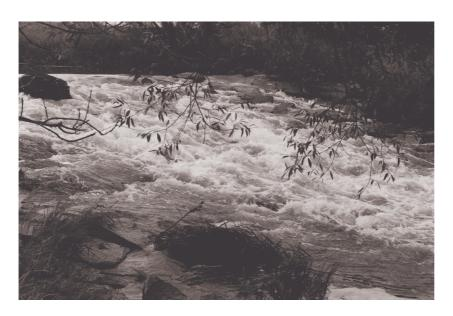
Abb. 49: Erheblich zu steil errichtete Sohlrampe, Bewertung flußauf: 4, flußab: 2, Vils
