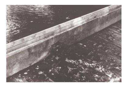
Abb. 76: Bei NQ knapp über Staupegel liegende Restwasseröffnung, Reschbach, Abfluß << 1 l/s
