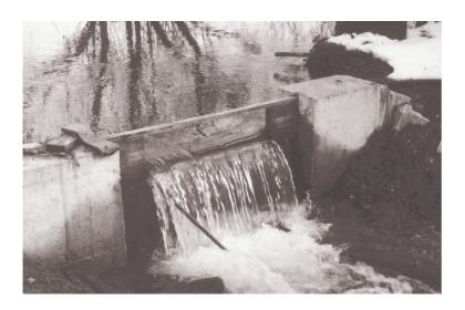
Abb. 58: Detailansicht zu Abb. 57, Schützbrett am Entnahmebauwerk
