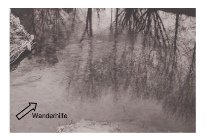
Abb. 55: Zu geringe Lockströmung (v ≤ 0,1 m/s) an der Mündung einer Wanderhilfe, Große Vils
