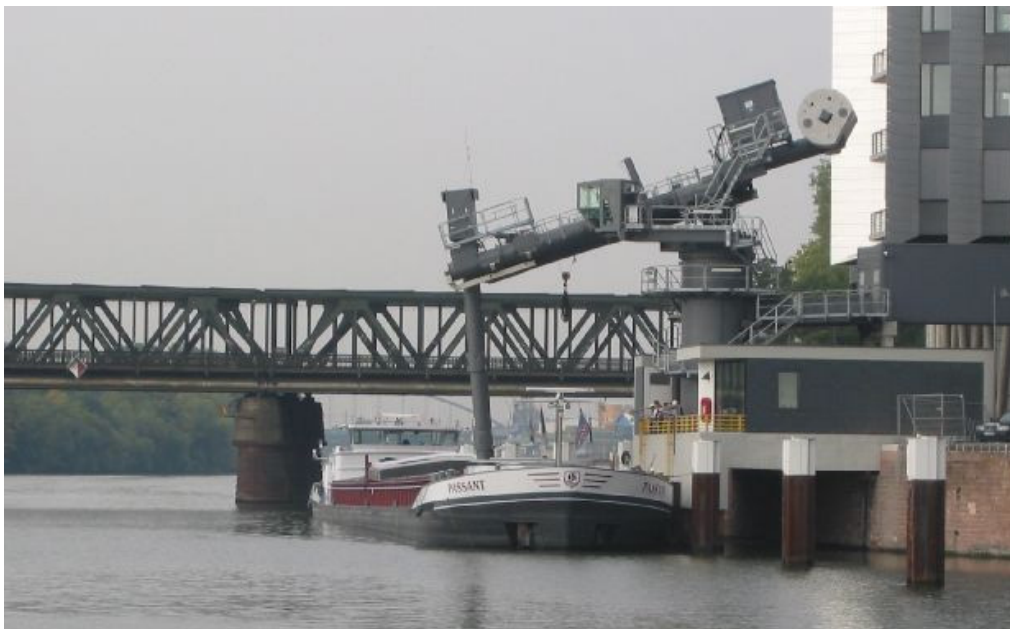
Abbildung 1-3: Schnecken-Schiffsentlader der Firma BMH Marine im Westhafen von Frankfurt am Main
