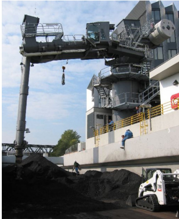
Abbildung 5-1: Schnecken-Schiffsentlader bei der Entladung von Kohle
