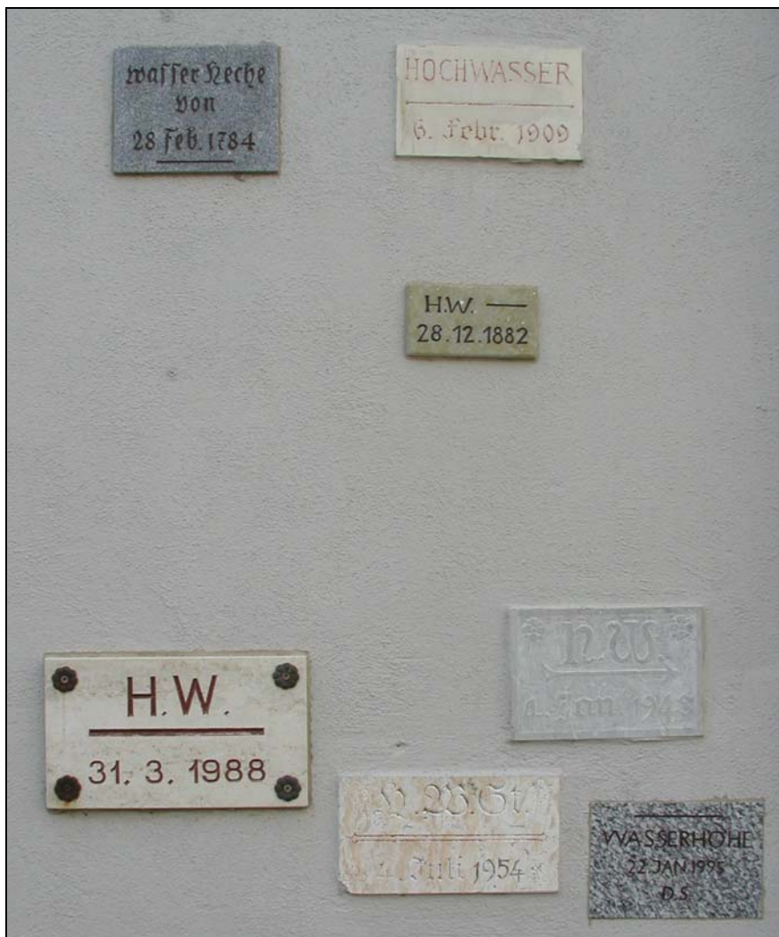
Abb. 56: Hochwassermarken an einem historischen Gebäude in Heitzenhofen an der Naab. Das Hochwasser von 1909 markiert das hundertjährige Ereignis.
