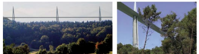
exemplarische Prüfung der Wirkung von Hochstraßen im naturnahen Raum
