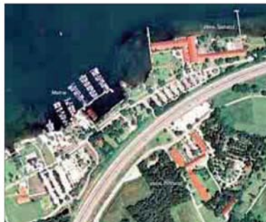
Das Gelände der ehemaligen Raststätte von oben: Das Areal erstreckt sich zu beiden Seiten der vielbefahrenen A 8.
