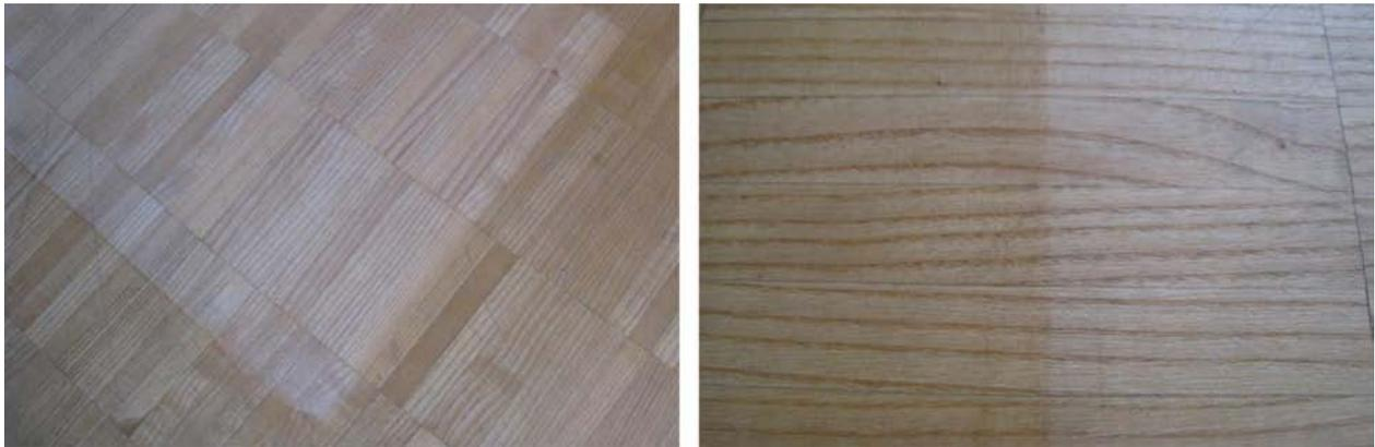
Abbildung 1.4: Vergleich von Farbänderungen bei geöltem Eschenfußboden
