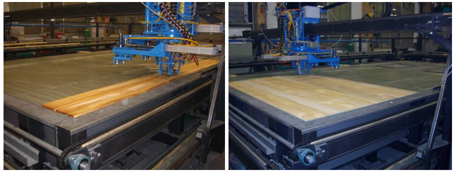
Abb. 5-93: Herstellung der Rohkörper
