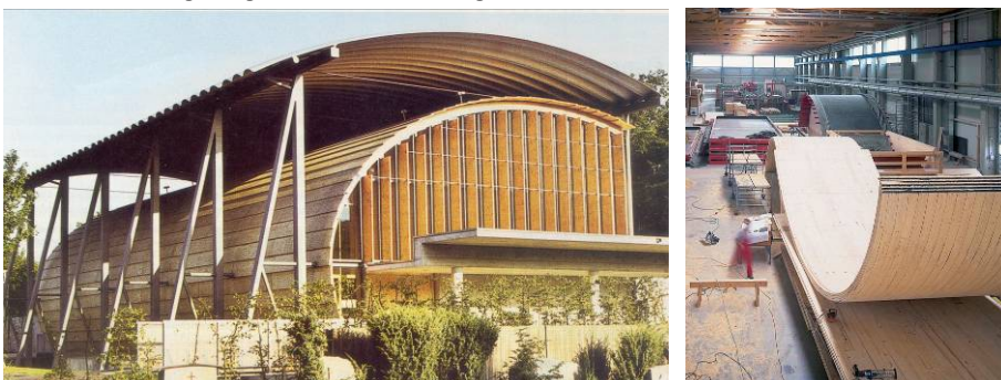
Abb. 5-5: Aussegnungshalle Gräfelfing (Fotos: [18] bzw. Finnforest Merk)
