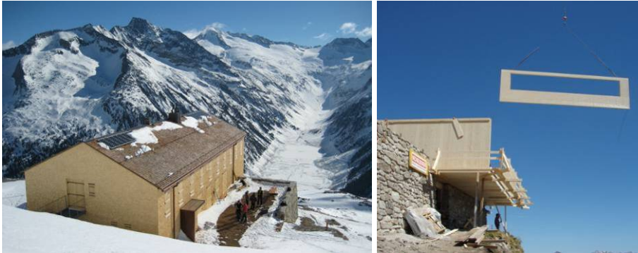
Abb. 5-3: Neubau Olperer Hütte
