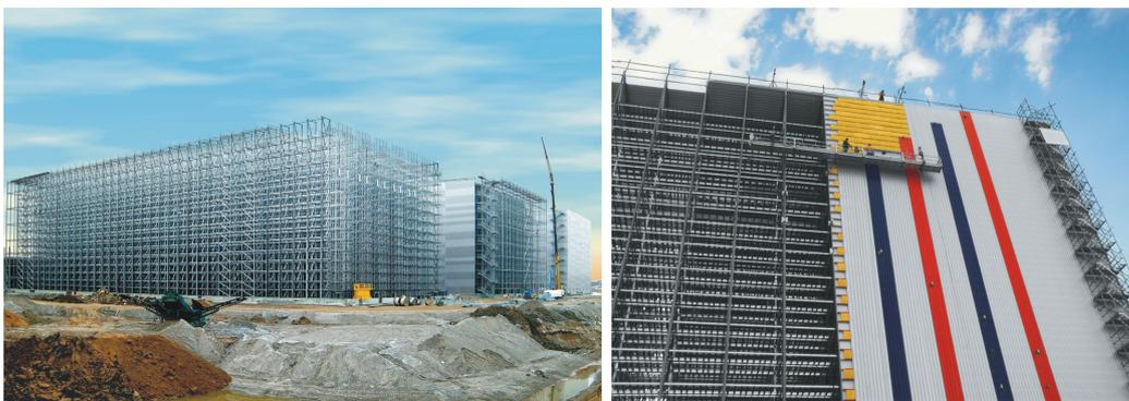
**Abb. 1.1:** Stahlbau eines Hochregallagers in Silobauweise [Quelle: SSI Schäfer Noell GmbH]
