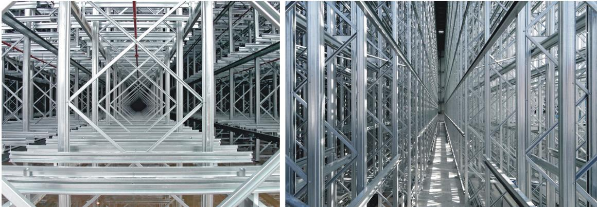
**Abb. 1.3:** Blick in das Innere eines Hochregallagers [Quelle: SSI Schäfer Noell GmbH]
