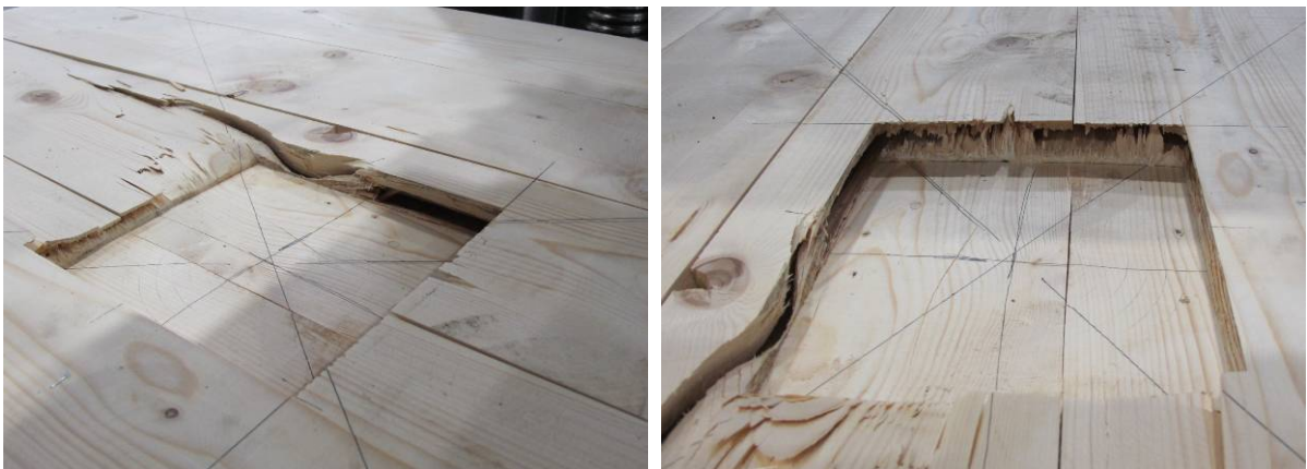
Abbildung 7-7: Versagensbild des Lasteinleitungsbereiches
