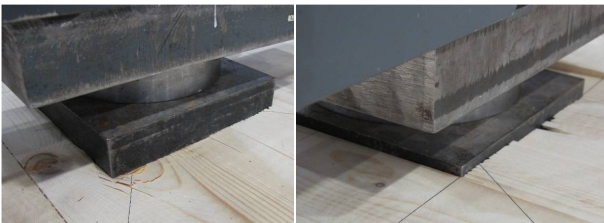
Abbildung 7-5: Versagen des Lasteinleitungsbereiches
