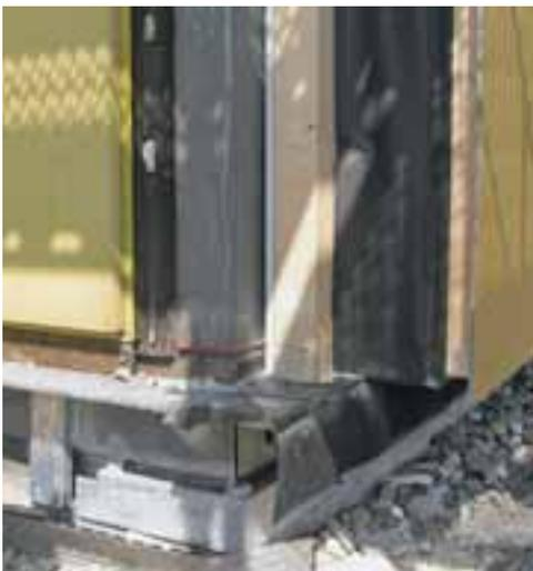
Abb. 9: Die gebäudehohen Holzelemente im Achsraster des Bestands von 2,10 m sind am Sockel auf eine Stahlkonsole aufgestellt und an vier Punkten kraftschlüssig an die Stützen angeschlossen. Im Fassadeneck an der Stahlstütze ist der Versatz für den vertikalen Elementstoß.
