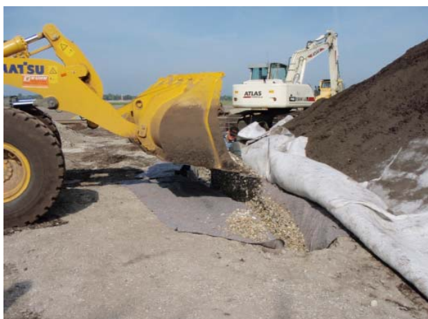
Abb. A3.10: Herstellen der Sickerleitung
