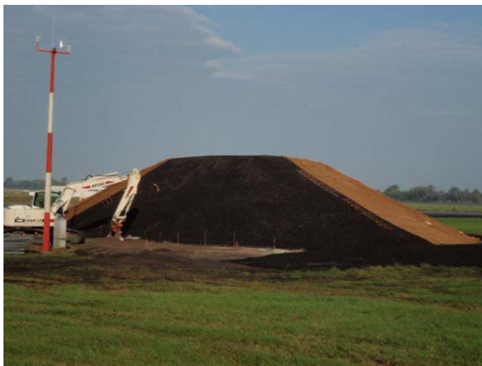
Abb. A3.15 : Erosionsschutzmatten
