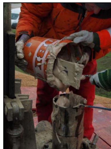
Abb. A3.30 : Befüllen des Bohrlochs mit einem Kaolin-Zement-Gemisch
