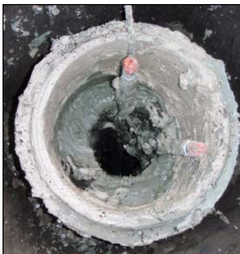
Abb. A3.28 : Draufsicht auf eingebauten 2-fach Extensometer
