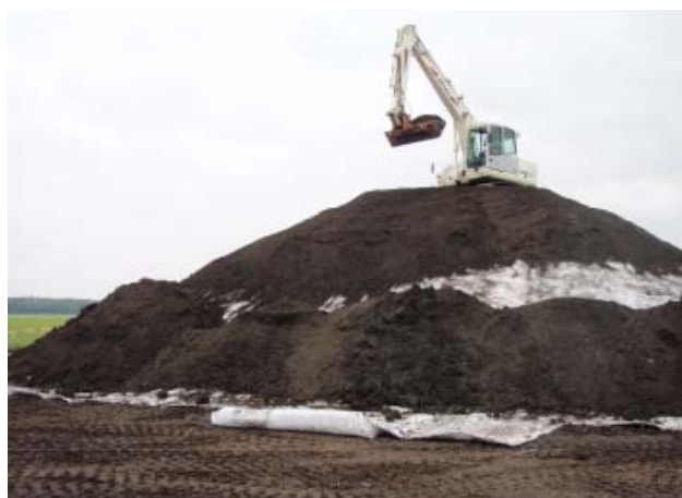
Abb. A3.11: Aufbringen des Oberbodens
