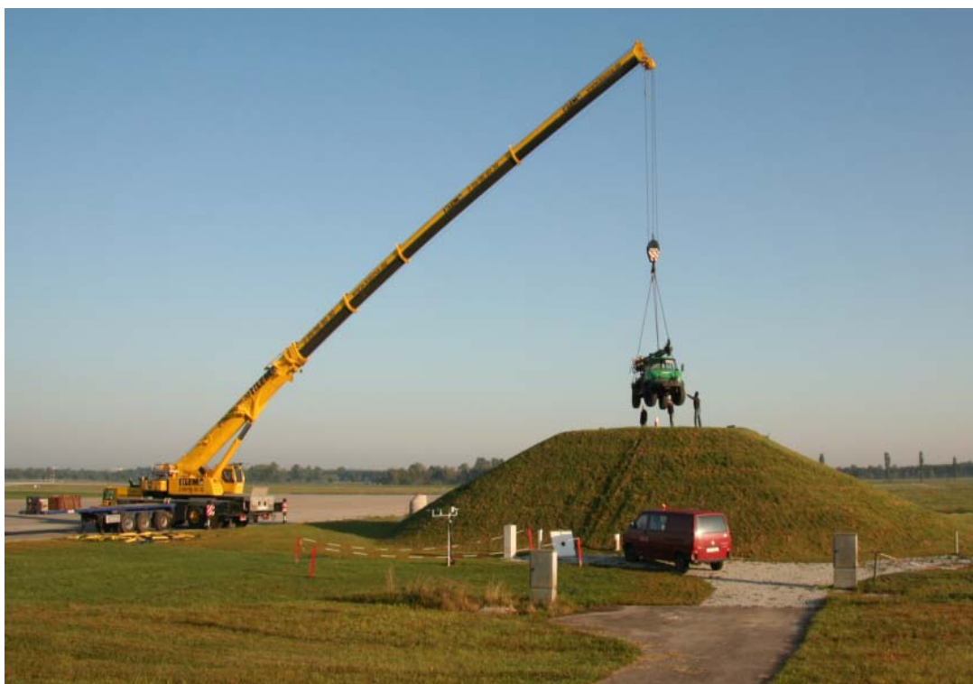
Abb. 8.5 : Versuchsschüttung mit Autokran und Bohrgerät
