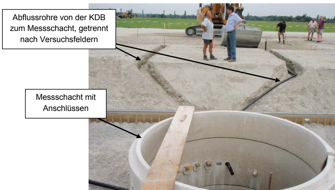
Abb. A3.3: Anschlüsse in der Aufstandsfläche der Versuchsschüttung
