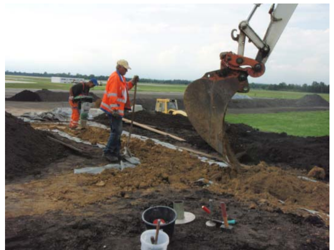
Abb. A3.7: Einbau und Verdichtung des Lösslehms
