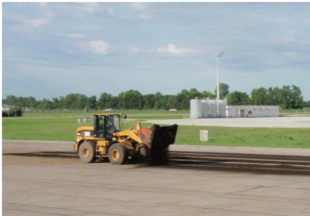
Abb. A3.1: Ausbreiten des Kernmaterials zum Trocknen
