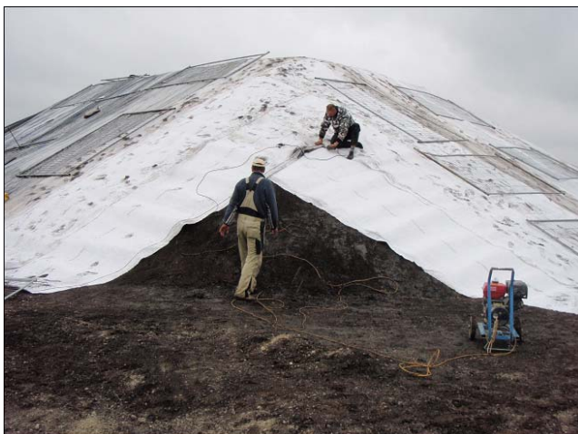
Abb. A3.8: Verlegen der Dränmatte
