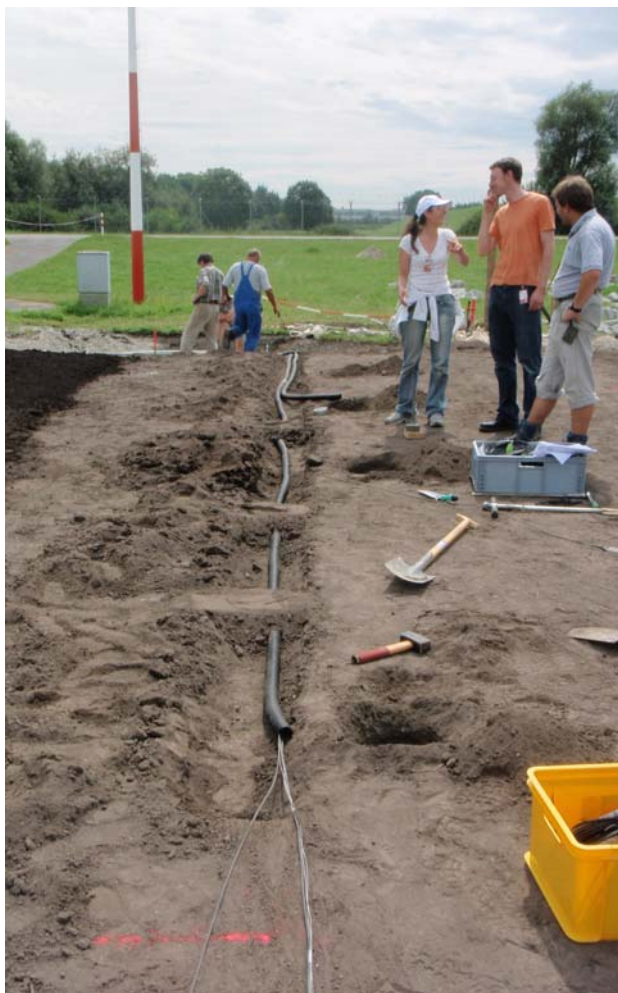
Abb. A3.13: Verlegen der Leerrohre
