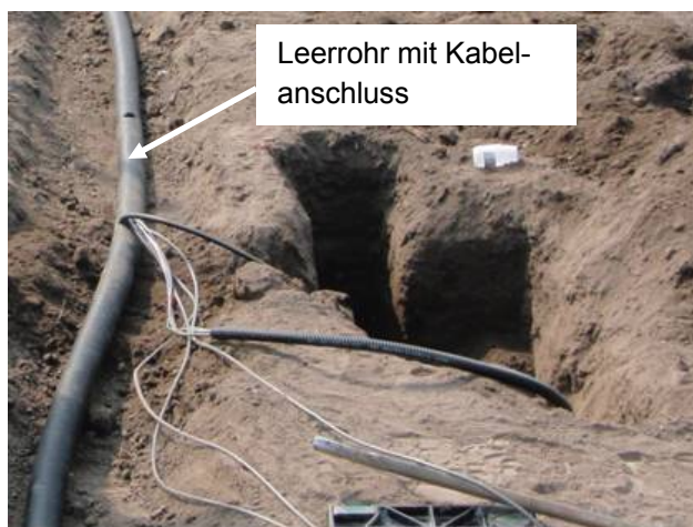
Abb. A3.12: Kabelanschluss
