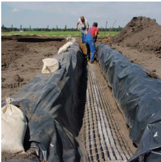
Abb. A3.6: Dichtwandanschluss an Geogitter und Dränmatte
