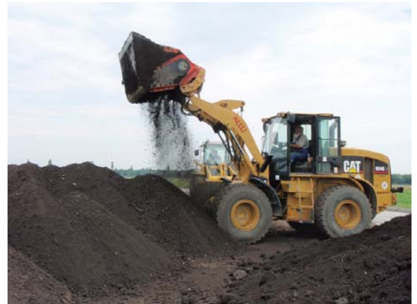
Abb. A3.2: Homogenisieren des Kernmaterials
