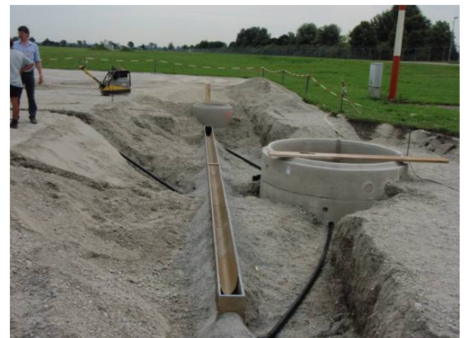
Abb. A3.9: Rinnenkörper und Anschluss an Messschacht
