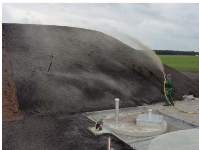
Abb. A3.16 : Aufbringen der Anspritzbegrünung
