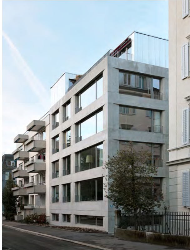
Abbildung 4.2.7: Mehrfamilienhaus in Zürich, Gesamtansicht von der Straße
