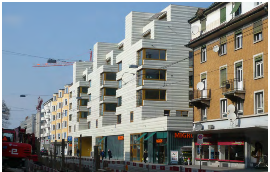
Abbildung 3.3.15: Foto des Wohn- und Geschäftshauses in der Badenerstraße, Zürich von Pool Architekten
