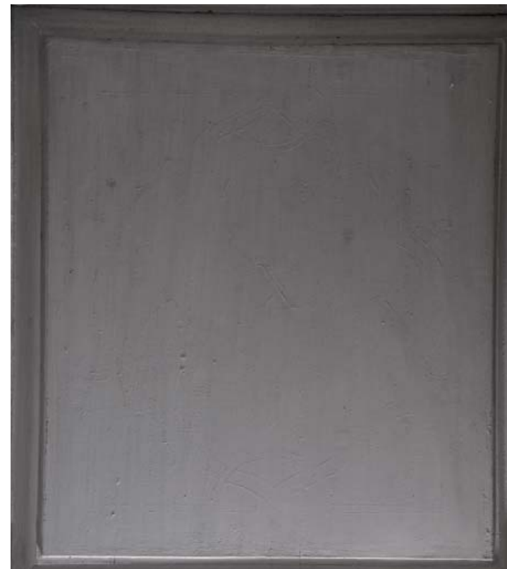
6: Tür T2/15 Füllung oben gangseitig: Römische X. (Streiflicht)
