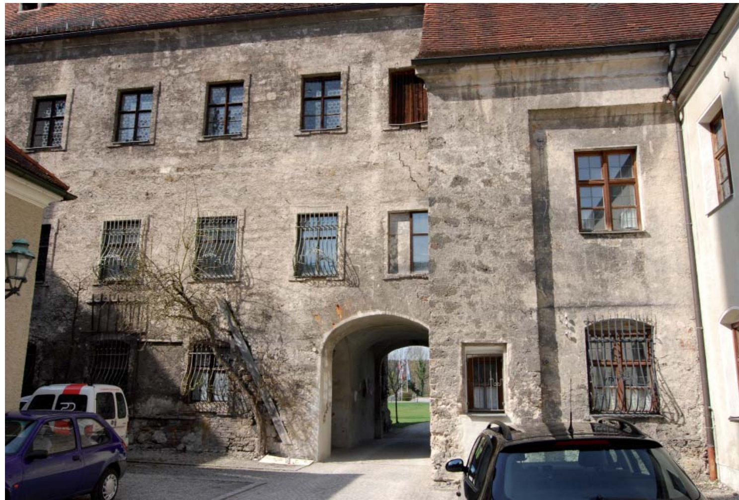
16: Prälatenstock, Ostfassade. Die Ostfassade ist schlicht gestaltet. Die Fenstergewände sind mit Ohren gestaltet und haben keine Ziergiebel. Die Wandflächen sind ungliedert und mit Putz geglättet. Glatte Werksteinflächen bleiben sichtbar, Ziegel werden verputzt.
