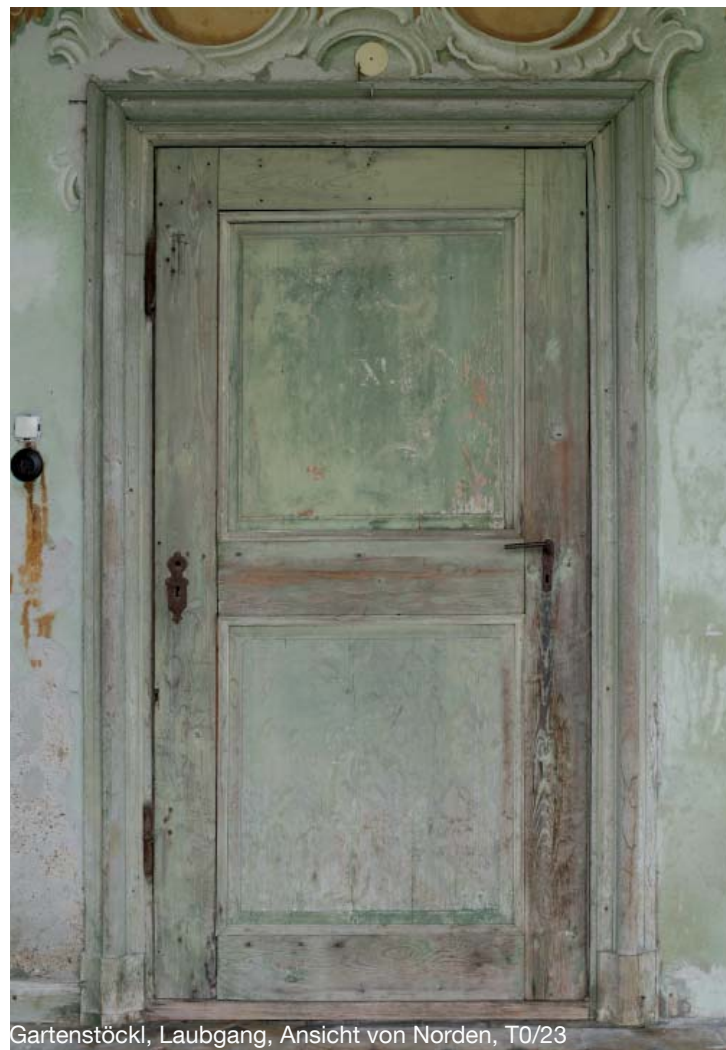
Gartenstöckl, Laubgang, Ansicht von Norden
