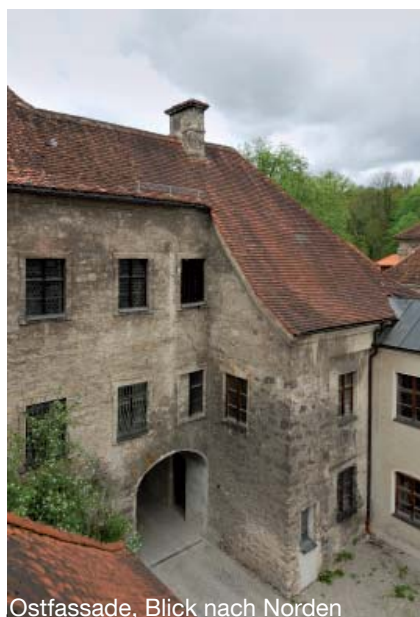
Ostfassade, Blick nach Norden
