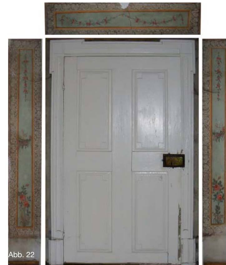
22: B 146 Nordwand Tür-laibung Laibung und Türe in Raum B 146. Die Tür-laibung ist freskal gestaltet. Die Malerei bricht 40 cm oberhalb des Fußbodens ab. Vermutlich war dieser Sockel mit einer hölzernen Verkleidung versehen.
