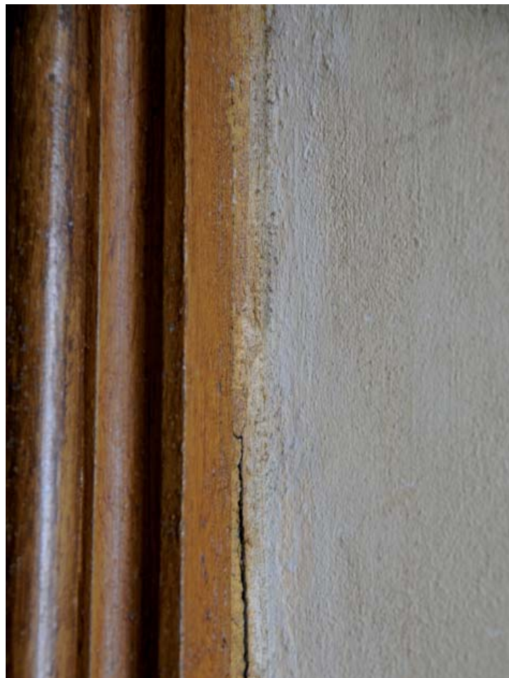
1: Putzanschluss Falzbekleidung Türe T2/10 (Raum A 208)
