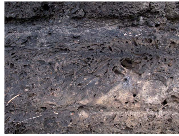
7: Prälatenstock, Kalktuffwerkstein, zellig-porös, erkennbaren Pflanzenstengel
