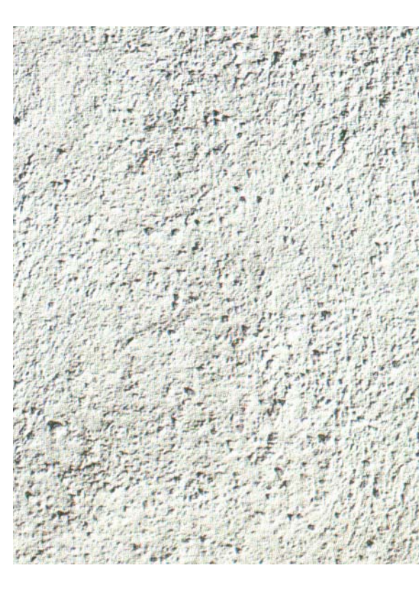
kalkputz starker geglättet
