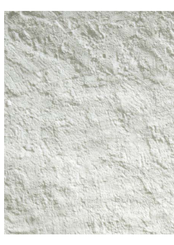
kalkputz als kellenwurfputz, leicht geglättet
