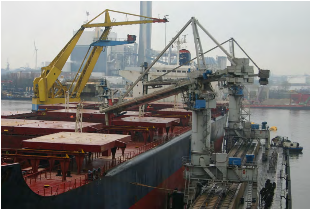
Abbildung 1-4: Schiffsentlader mit Schneckenförderern beim Massengutumschlag
