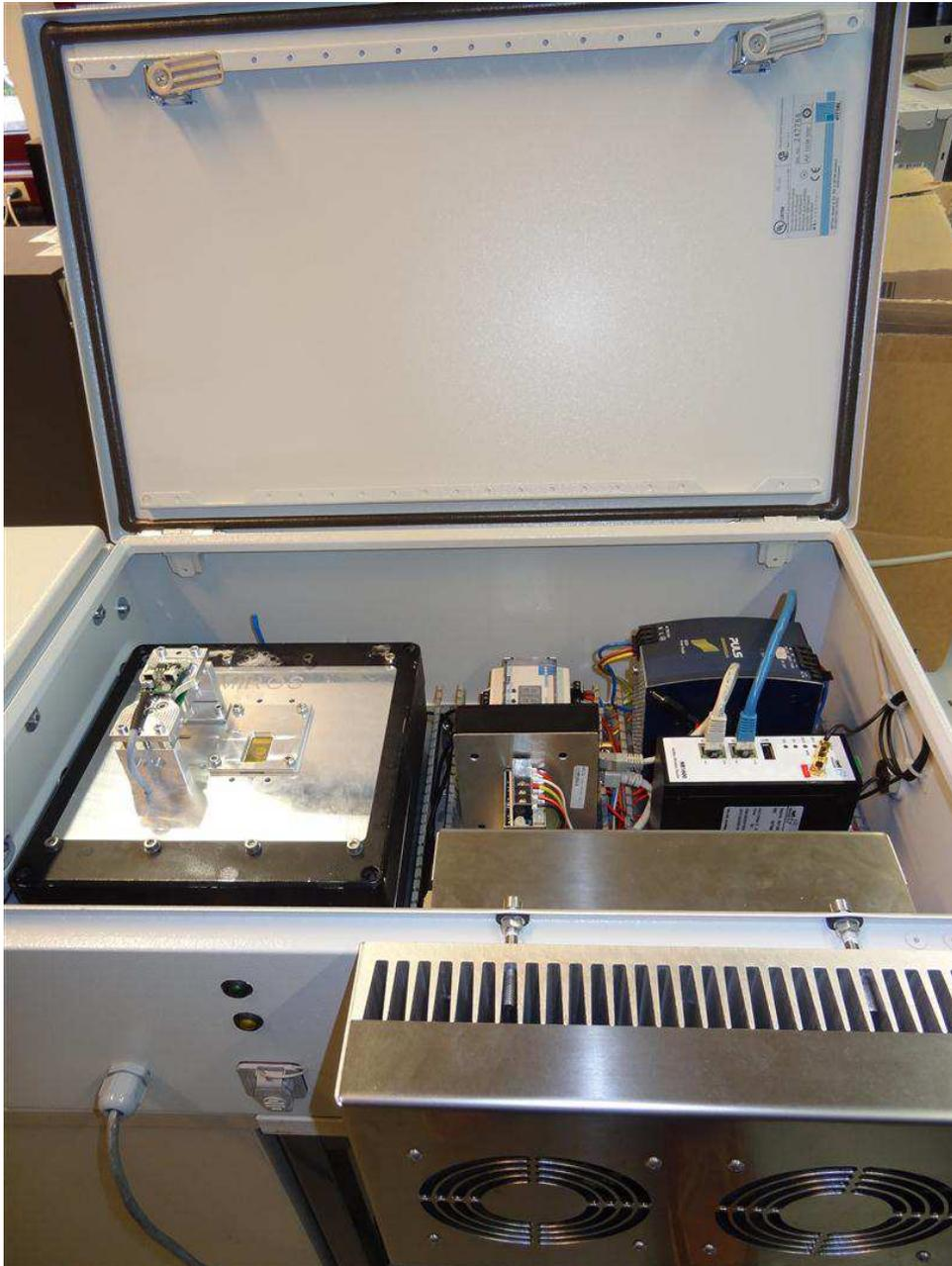
**Abbildung 6.2** Schaltschrankinstallation eines LVF-Spektrometers zur kontinuierlichen Überwachung eines 5 MW Windgetriebebeprüfstands.
