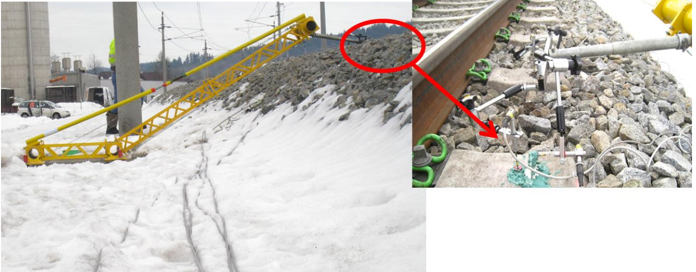
Bild. A. 10: Außerhalb des Gleises fixierte Messbasis
