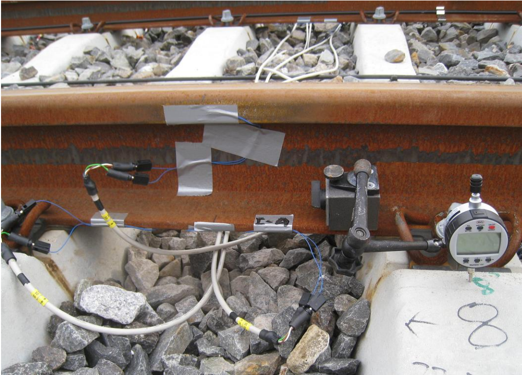
Bild. A. 15: Anwendung und Test des neuen Messverfahrens im Betriebsgleis – (1)
