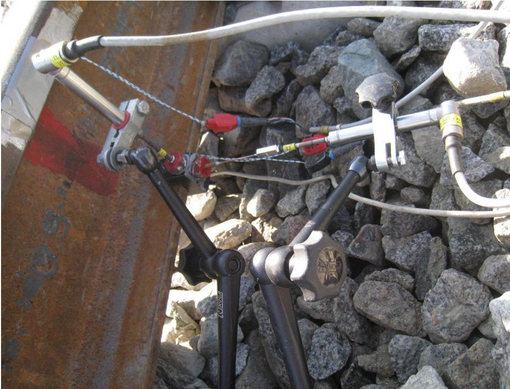
Bild. A. 9: Dehnmessstreifen am Schienenkopf (DMS2) und am Schienenfuß (DMS1), DMS1 ist verdeckt durch die Schiene und nur das dazugehörige Kabel sichtbar
