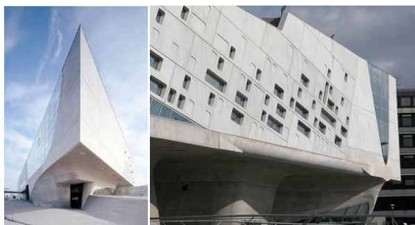
Bild 3: Phæno Science Centre, Architektin: Zaha Hadid
