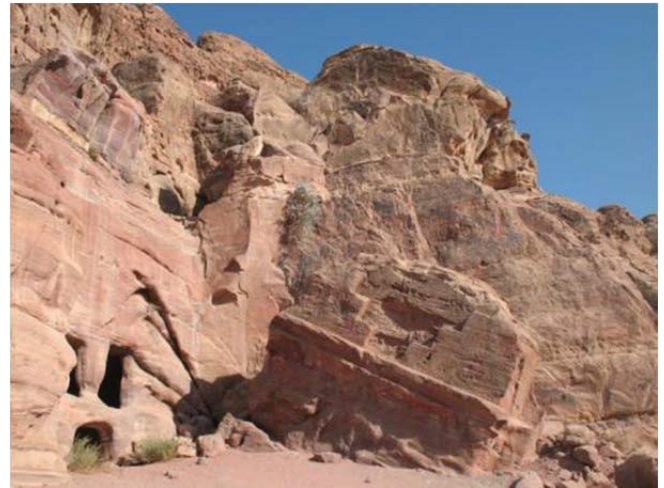
Abb. 10: Monument Nr. 198. Einsturz infolge ebenen Gleitens entlang einer Kluft.
