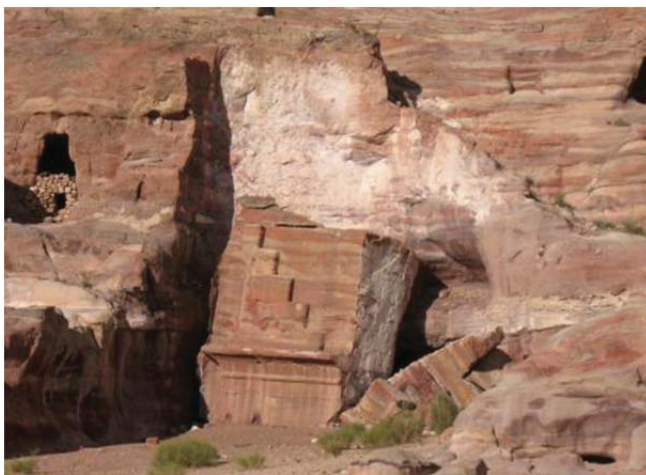
Abb. 3: Monument Nr. 609. Einsturz im März 2010. Fig. 3: Monument No. 609. Collapse in March 2010.
