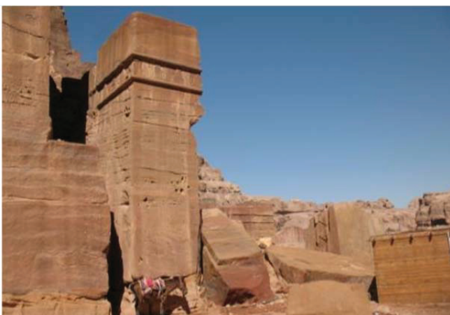
Abb. 14: Monument Nr. 73. Rechter Teil des freistehenden Monumentes infolge Kippens an einer steil einfallenden Kluft zerstört.
