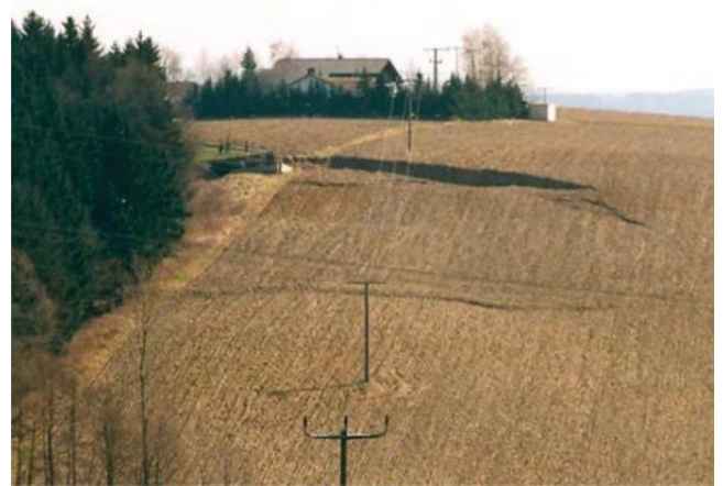
Abb. 3: Erstreckung der Rutschung nach dem ersten Abriss 1988 (Foto: ASEN, Blickrichtung nach Osten).
