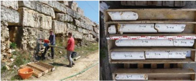
Abb. 2: Probenahme mit HILTI-Bohrgerät und Kernablage in Kernmärschen zu je 1 Meter
