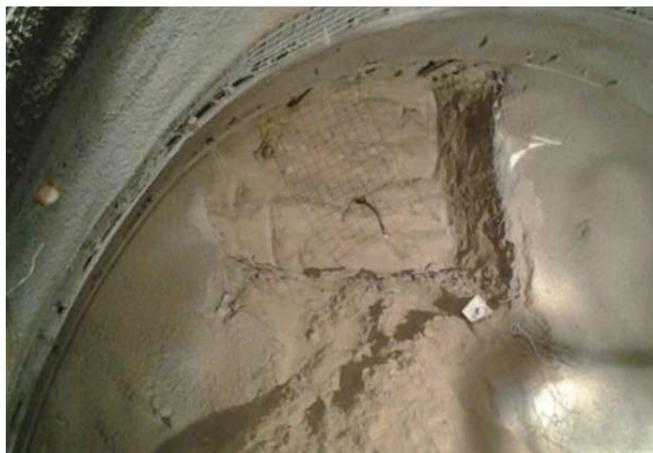
Abb.-4: Geschichtete Fein- bis Mittelsande mit nachfallendem bis nachrieselndem Ausbruchverhalten; Öffnen in Teilflächen, Ortsbrustsicherung mittels Anker, Baustahlgitter und Spritzbeton.
