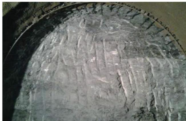
Abb.-7: Vollflächiger Anschnitt der Kernzone einer Störung in Fault-Gouge-Ausbildung bei TM 532 (Lösung mittels Bagger).
