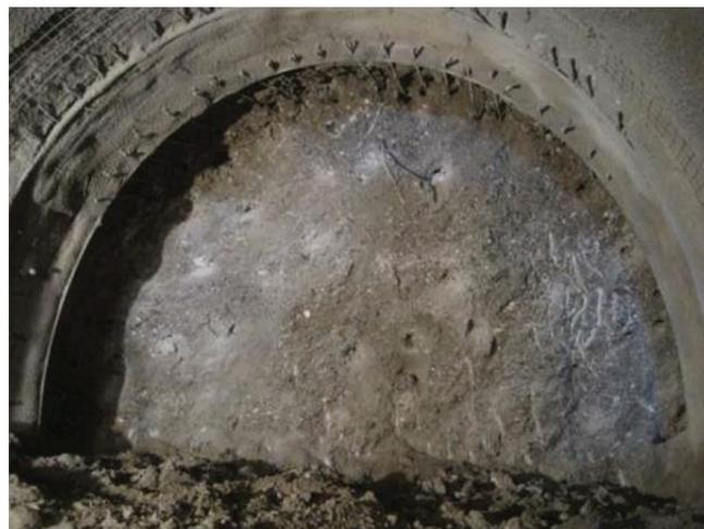
Abb.-2: Kalotten-Strossen-Ortsbrust bei TM 78 in standfesten verkitteten Schottern, die mittels Auflockerungssprengungen gelöst wurden.
