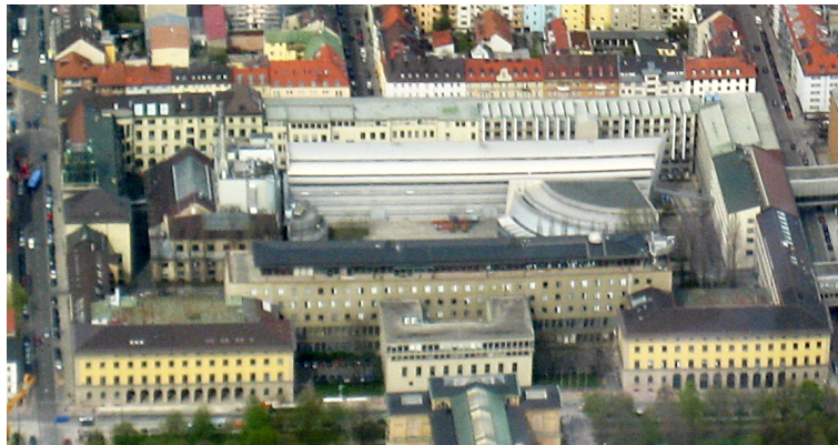
Abbildung 6.10: Schrägluftbild mit Blick auf die Ostfassade
