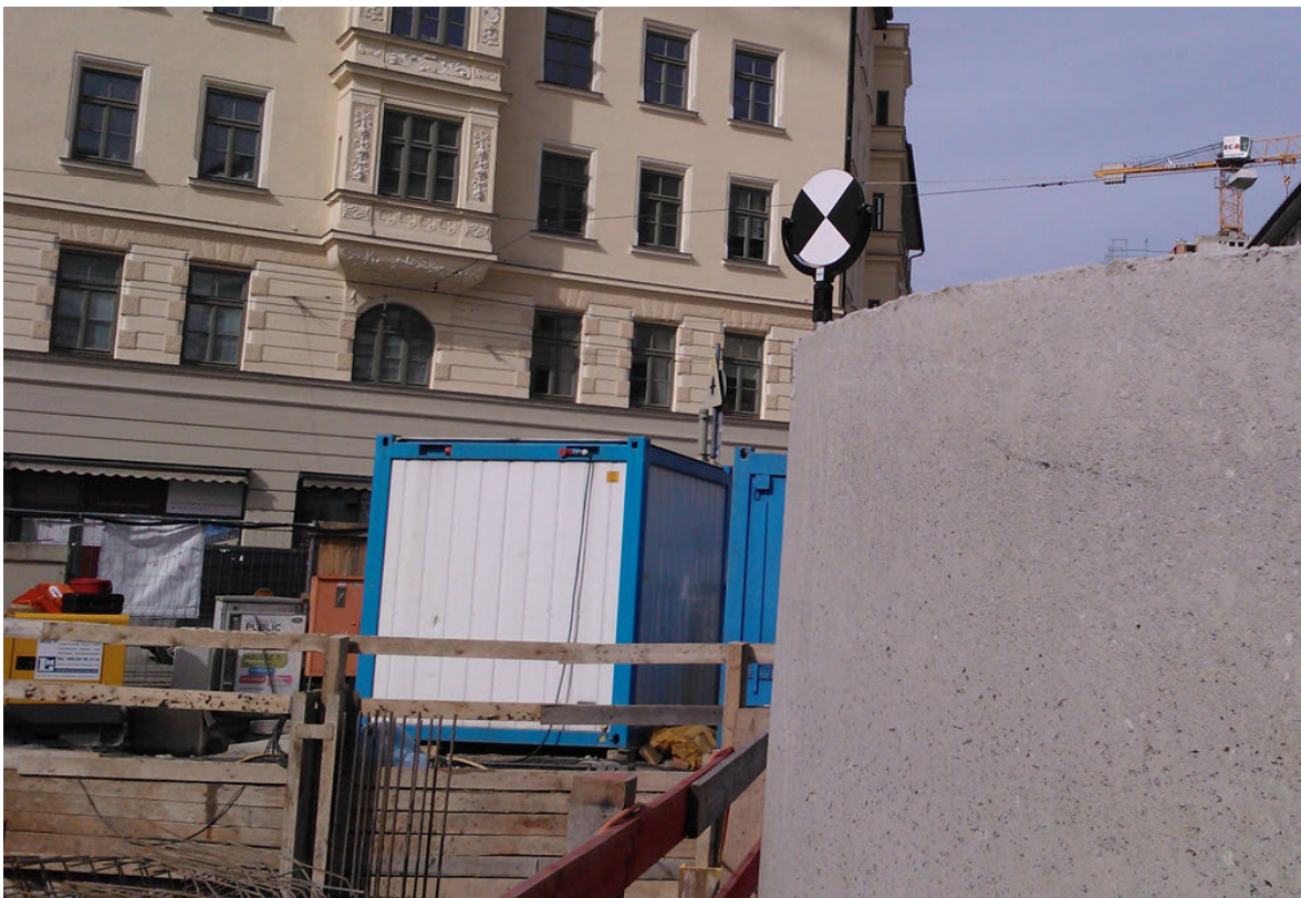
Abbildung 3.1: Zielmarken auf der Demonstrationsbaustelle. Quelle: eigene Aufnahme
