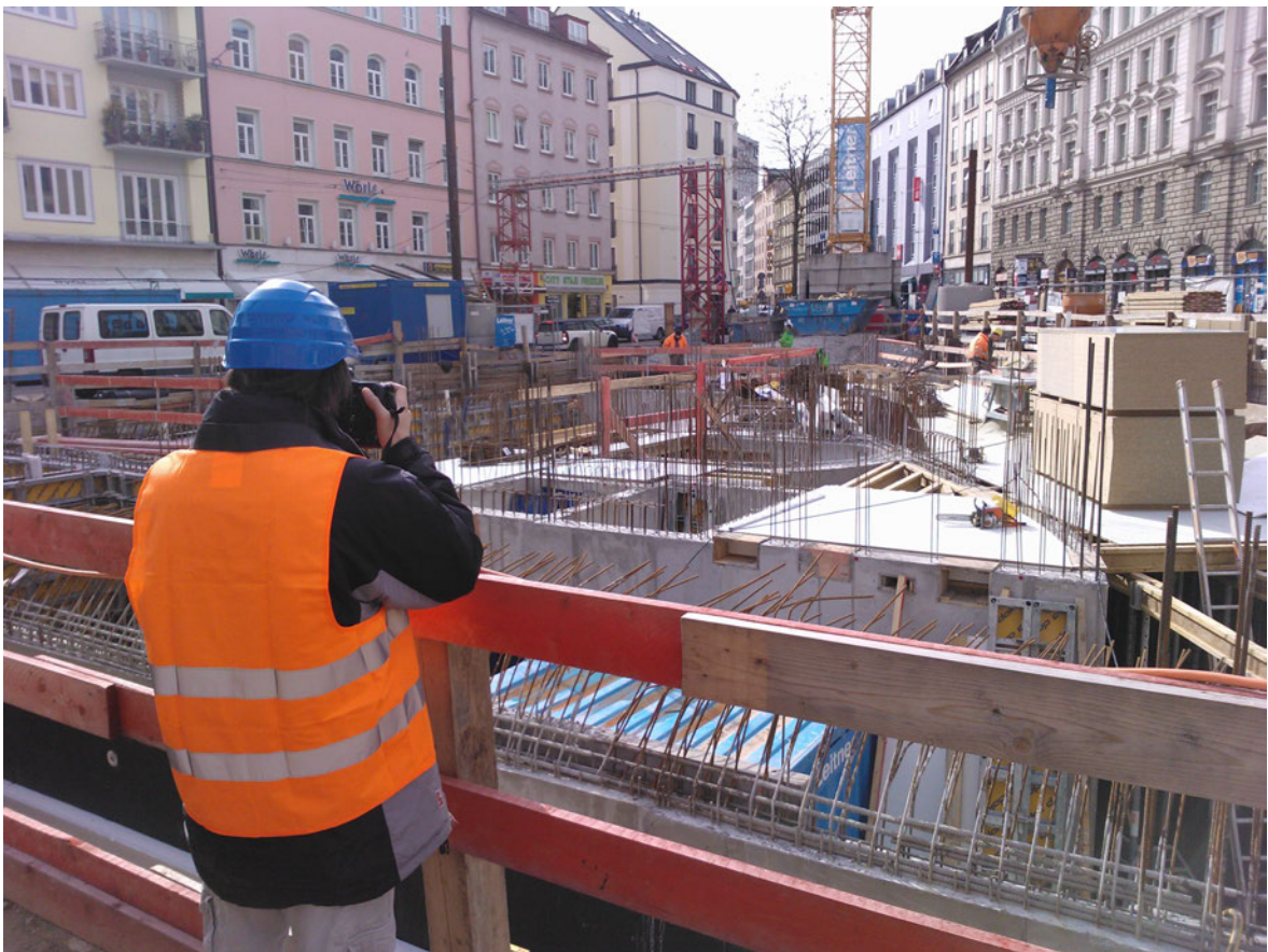
Abbildung 9.3: Aufzeichnungen auf der Baustelle
