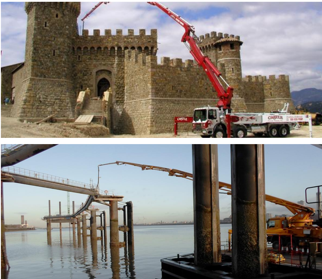
Abbildung 1: Verpumpen von Beton an schwer zugänglichen Einsatzgebieten unter Verwendung von Fließmitteln [1, 2].
