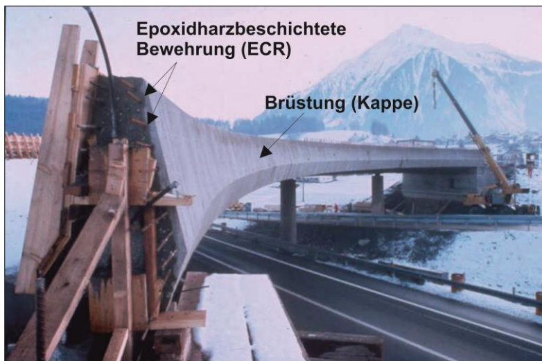
Bild 10-4: Außenansicht der Brücke in Spiez im Bauzustand 1988 [ZINT14]
