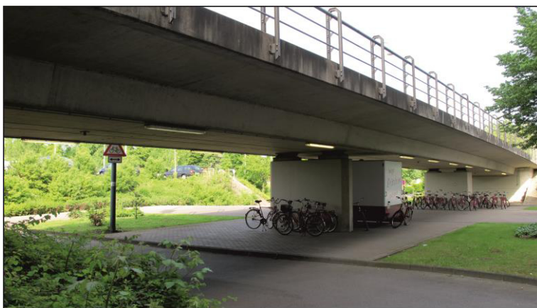
Bild 10-1: Außenansicht der Brücke Schießbergstraße in Leverkusen im Jahr 2012 [ZINT14]
