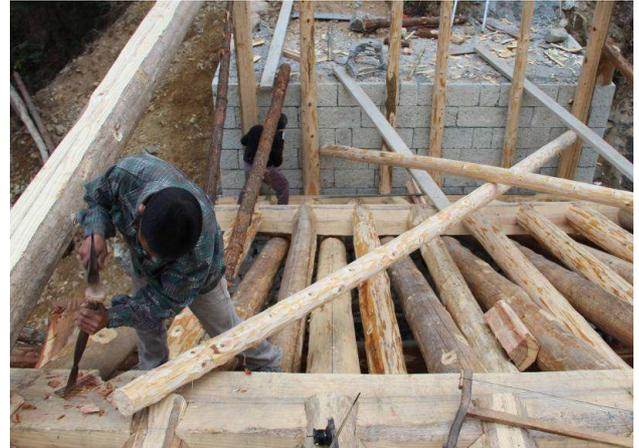
b. Das obere Ende des Balkens einer X-förmigen Stütze wird durch eine einfache Kerbe mit dem Querbalken verbunden, die Verbindung wird später durch eiserne Nagel feststellt.
