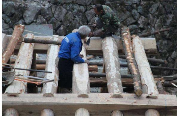
Abb. 66 Baustelle der Dongtang-Brücke. Landkreis Jingning, Zhejiang. Wenn die Aussparungen in den Querbalken zu eng sind, wie es oft der Fall ist, werden sie vor Ort angepasst.
