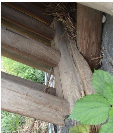
Abb. 29 Helong-Brücke, Landkreis Minqing, Fujian. Querschnitt. Die U-S-Balken(2) müssen nach O-S-Balken einstellt werden. An den Bogenfuß des 2. Systems, werden zwei Stücke von Fußbalken zusammen gesetzt. Die äußeren Stücke sollen zuletzt eingesetzt werden. Durch dem Einsieben des zweiten (äußeren) Fußbalkens, würde der Gewebebogen dicht gedrückt.
