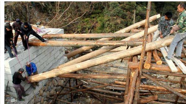
b. Dann wird ein Ende des S-Balkens mit Seilen auf das Auflager herabgelassen.
