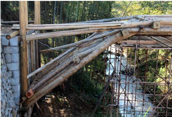
Abb. 76 Baustelle der Shengshuitang-Brücke. Landkreis Qingyuan, Zhejiang. Die Kantenbalken und die Feldherrensäulen sind verbunden durch durchgehende Zapfen an den Enden der Kantenbalken.
