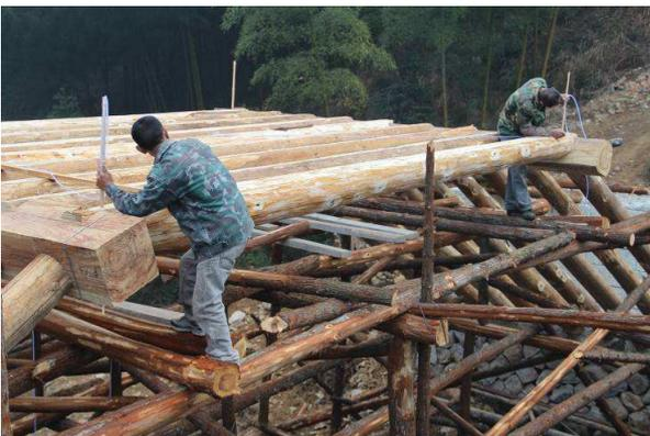
Abb. 68 Baustelle der Dongtang-Brücke. Landkreis Jingning, Zhejiang. Meister Wu Dagen (links) prüft die waagerechte Ausrichtung des Bogens.
