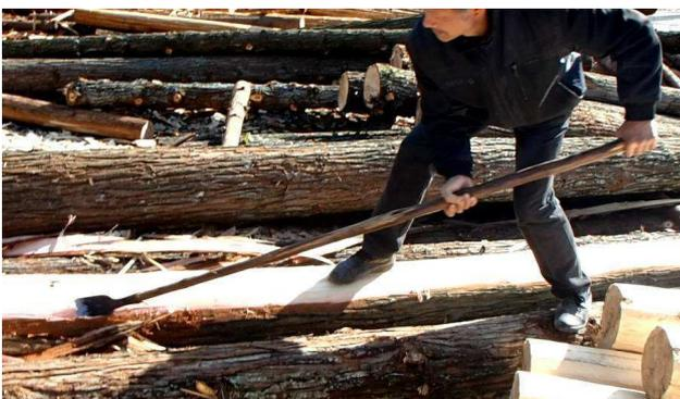
Abb. 2 Baustelle der Dongtang-Brücke. Landkreis Jingning, Zhejiang. Entrinden von Baumstämmen mit dem Spatenmesser.
