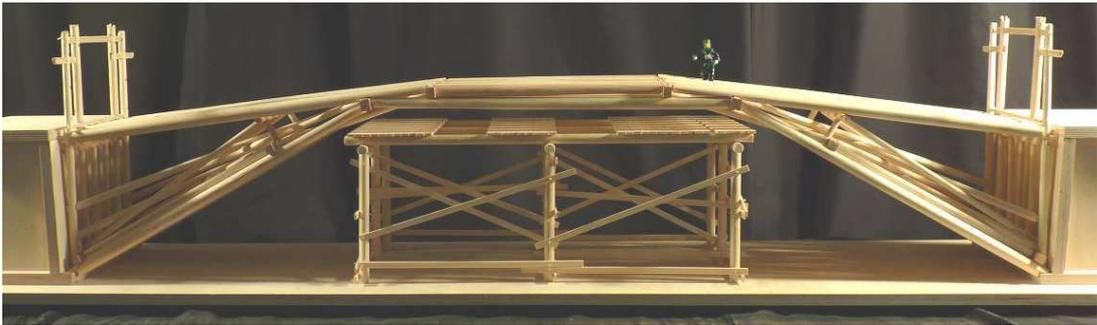
i. Fertigstellung der Unterstruktur mit den seitlich liegenden Balken
