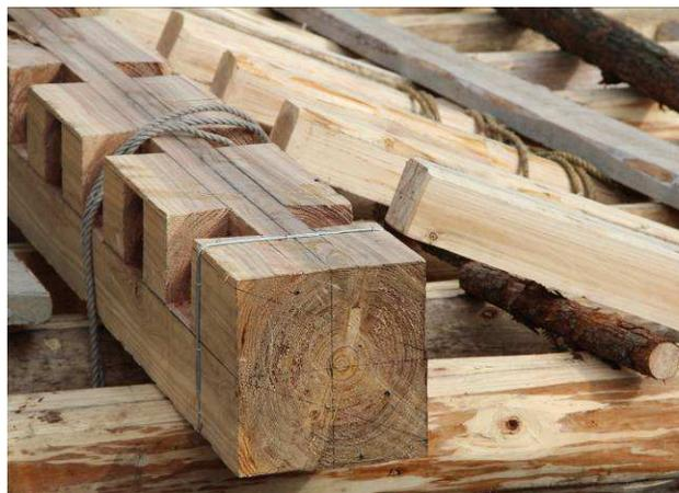
Abb. 43 Baustelle der Dongtang-Brücke. Landkreis Jingning, Zhejiang. O-Q-Balken(2) mit Tintenlinien auf der Stirnseite. Die Linien geben die Neigung der Zapfenlöcher mit 4-Zehntel-Wasser an.
