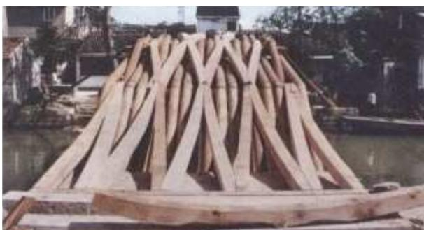
Abb. 4 Jinze-Brücke. Jinze, China. X-förmige Stützen in der Konstruktion. (aus: Tang, 2010, S. 121)
