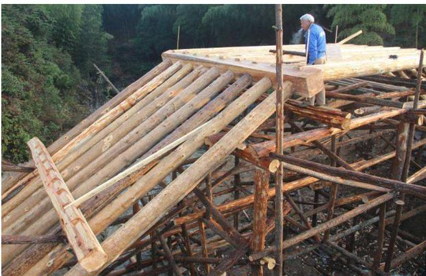
Abb. 27 Baustelle der Dongtang-Brücke. Landkreis Jingning, Zhejiang. Methode der Xiaodong-Meister. Der U-Querbalken wird zeitlich durch Dübel oder Eisenklammern positioniert. Dann werden mit Hilfe einer langen Stange der Verlauf des O-S-Balkens und die Lage des O-Querbalkens geprüft.
