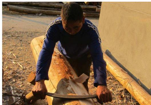
Abb. 3 Baustelle der Dongtang-Brücke. Landkreis Jingning, Zhejiang. Ein Zimmermann beim Entrinden eines Baumstammes mit einem gekrümmten Messer.
