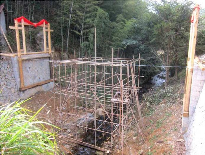
Abb. 55 Baustelle der Shengshuitang-Brücke. Landkreis Qingyuan, Zhejiang. Stahlrohrgerüst an der Baustelle. Das Seil, das beide Uferseiten verbindet, dient als Richtwaage, um die Höhe des Gerüsts zu kontrollieren.
