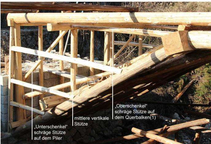
b. Die fertiggestellte „Froschschenkel“-Konstruktion“ mit oberem Querbalken, vertikalen Stützen auf dem U-Q-Balken(2), schrägen Stützen auf dem Pfeiler (die „Unterschenkel“) und schrägen Stützen auf dem Q-Balken(1) (die „Oberschenkel“).
