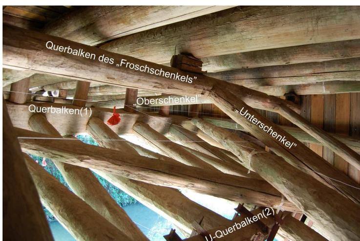
Abb. 10 Rulong-Brücke, Landkreis Qingyuan, Zhejiang. „Froschschenkel“-Konstruktion, Nordseite.
