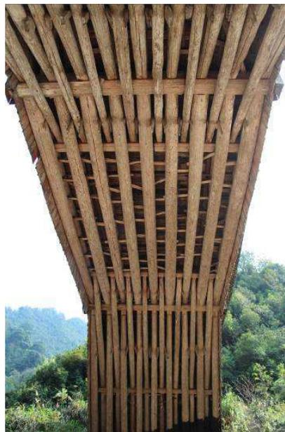
Im vorangegangenen Kapitel wurde bereits erwähnt, dass die Bearbeitung des oberen Endes des O-S-Balkens(2) ein Symbol für die Reife der Brückentechnik ist. Der entsprechende Bauabschnitt ist der Querbalkenschlag bzw. *Choudu* – der für die Dichtigkeit des Gewebebogens wichtigste Bauabschnitt. Das Aussehen des Gewebebogens einer Holzbogenbrücke ermöglicht uns heute, die historischen Brücken zu prüfen:
