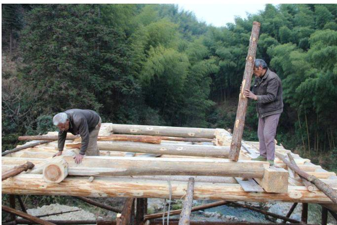
m. Einstellen der L-Balken. Ihre Zinken werden mit einem Baumstamm in die Schwalbenschwänze eingedrückt. Wenn die Arbeit mit den L-Balken beendet ist, ist der gesamte Gewebebogen geschlossen.
