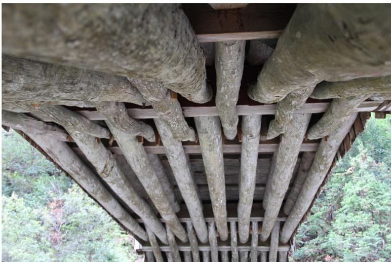
Abb. 19 Shunde-Brücke, Yangshun, Landkreis Longquan, Zhejiang. Nutzung der natürlich gewachsenen Hölzer.
