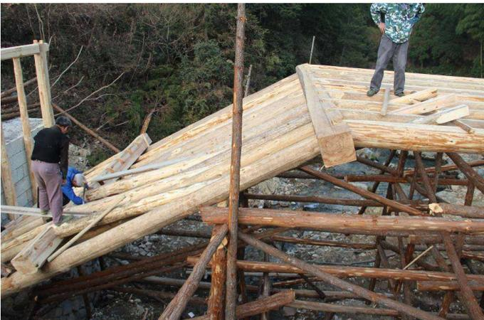
i. Einsetzen der O-S-Balken. Die Zinken an ihren unteren Enden werden in die Ausarbeitungen (Schwalbenschwänze) in dem U-Q-Balken(2) eingesetzt. Ihre oberen Enden werden mit kleinen Hölzern unterstützt.
