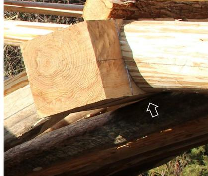
Abb. 26 Baustelle der Dongtang-Brücke. Landkreis Jingning, Zhejiang. Das „Kinn“ des Querbalkens drückt auf die unteren S-Balken.
