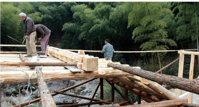
k. Nachdem die Querbalke eingesetzt sind, wird vor Ort die Länge der L-Balken und SL-Balken bestimmt.
