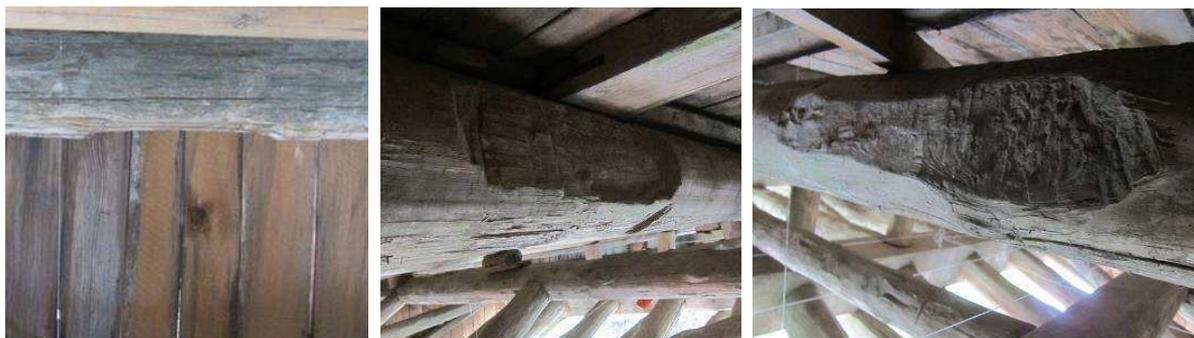
Abb. 9 Rulong-Brücke, Landkreis Qingyuan, Zhejiang. Hackspuren auf den Deckenbalken. Wahrscheinlich von einer Axt.
