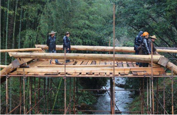
Abb. 65 Baustelle der Shengshuitang-Brücke. Landkreis Qingyuan, Zhejiang. Einstellung der L-Balken(1). Zuerst wird das Paar der seitlichen L-Balken eingestellt.
