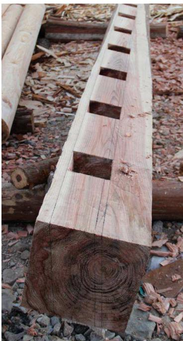
Abb. 39 Baustelle der Dongtang-Brücke. Landkreis Jingning, Zhejiang. Meister Wu Dagen legt den Querbalken in eine entsprechende Neigung, so dass die Zapfenlöcher senkrecht ausgearbeitet werden können.
