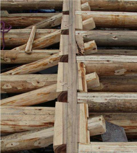
Abb. 38 Baustelle der Dongtang-Brücke. Landkreis Jingning, Zhejiang. Die oberen Zapfen der O-S-Balken(2) gehen durch die O-Querbalke hindurch. Sie haben keine Balkenschulter. Dies ist eine typische Holzverbindung der Xiaodong-Meister.
