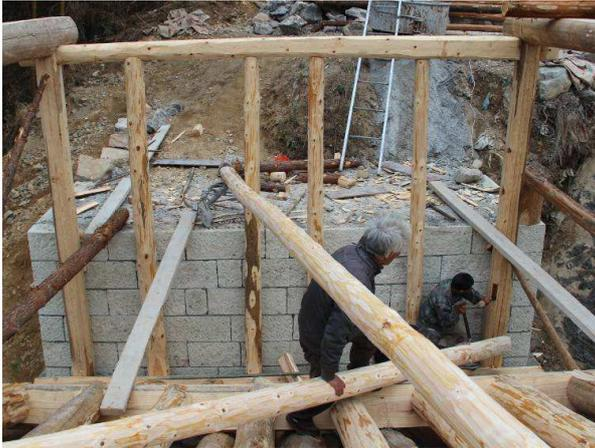
a. Das untere Ende des Balkens einer X-förmigen Stütze wird durch ein Zapfen mit dem Halfeldherrenbalken verbunden.
