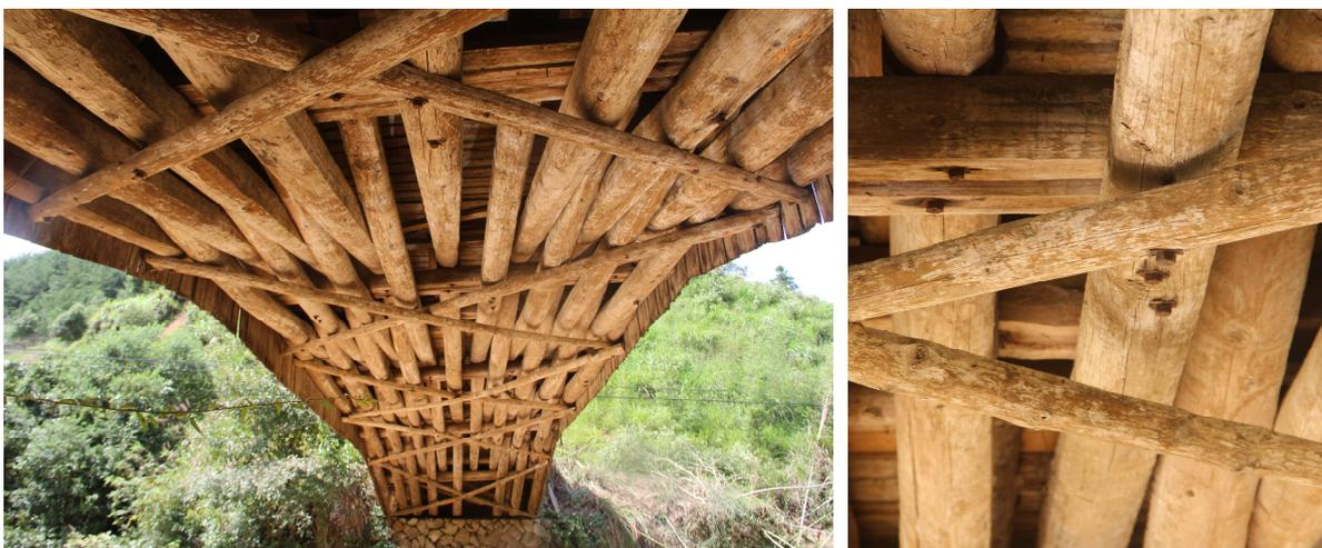
Abb. 30 Yongge-Brücke, Shangyong Zhen. Landkreis Dehua, Fujian. Die untere Konstruktion und die Eisenbolzen.
