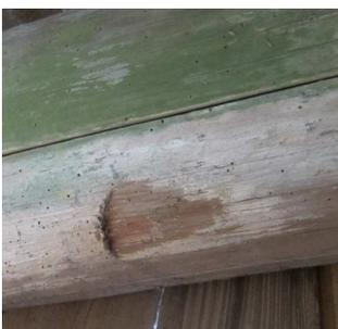
Abb. 13 Rulong-Brücke, Landkreis Qingyuan, Zhejiang. Druckspur am Deckenbalken
