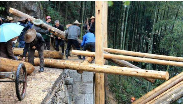
a. Das Holz am oberen Rand des steinernen Pfeilers dient als Drehachse. Dort lässt eine Gruppe Arbeiter über Seile den S-Balken nach unten, so dass sein Balkenfuß auf dem Auflager aufsetzt.
