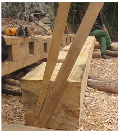
Abb. 42 Baustelle der Shengshuitang-Brücke. Landkreis Qingyuan, Zhejiang. Meister Wu Fuyong benutzt für Anzeichnung und Kontrolle der Ausarbeitung der schrägen Zapfenlöcher zwei in einem bestimmten Winkel miteinander verbundene Bretter.
