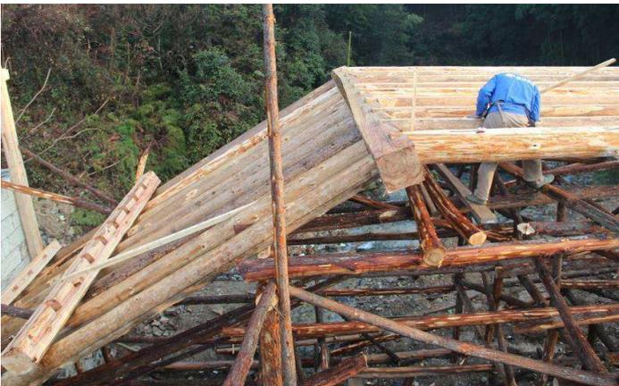
Abb. 56 Baustelle der Dongtang-Brücke. Landkreis Jingning, Zhejiang. Der seitliche Rand des Gerüsts befindet sich 1,5 m von den Q-Balken(1) entfernt. Höhe und Positionierung des seitlichen Rands des Gerüsts dürfen die O-S-Balken(2) nicht behindern. In der Abbildung prüft ein Zimmermann die Positionierung des O-S-Balkens mit der Maßlatte.
