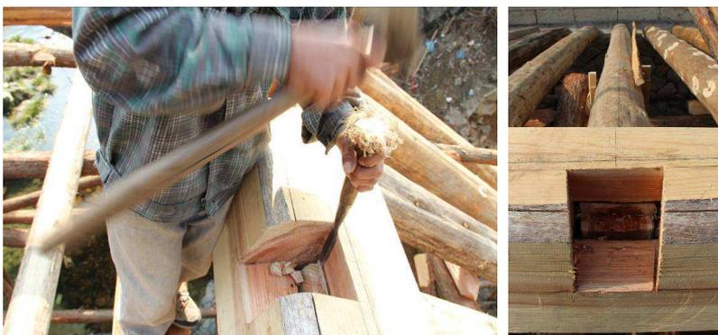
Abb. 64 Baustelle der Dongtang-Brücke. Landkreis Jingning, Zhejiang. Die Ecke des Zapfens wird der Form der Aussparungen im Querbalken entsprechend abgearbeitet.
