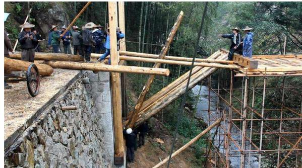
b. Dann wird der Balken mit den Seilen langsam zur Gerüstplattform bewegt. Sein Zapfen wird gegen das Zapfenloch des Querbalkens gelegt.
