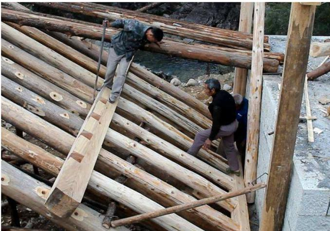
e. Die Verbindung zwischen U-S-Balken und Querbalken wird mit einer Eisenstange verdichtet.
