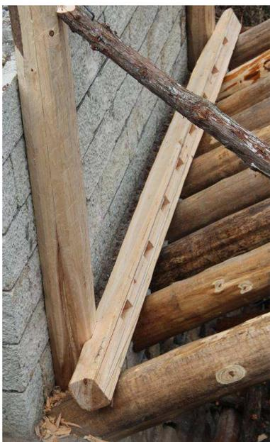
Abb. 36 Baustelle der Dongtang-Brücke. Landkreis Jingning, Zhejiang. Ein Fußbalken(2) mit eingearbeiteten Zapfenlöchern. In den Fußbalken sind zwei Kerben eingearbeitet, womit sich der Balken an die zwei Feldherrensäulen anpasst.
