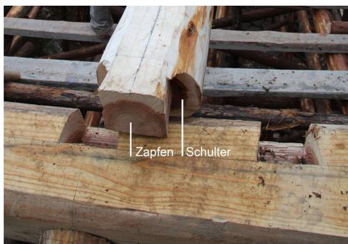
Abb. 88 Baustelle der Dongtang-Brücke. Landkreis Jingning, Zhejiang. Balkenschulter eines L-Balkens(1)
