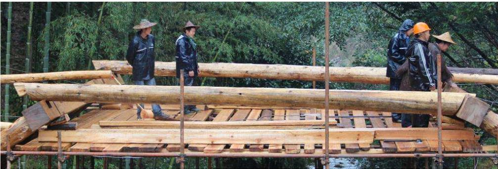
Abb. 34 Baustelle der Shengshuitang-Brücke. Landkreis Qingyuan, Zhejiang. Die Enden der liegenden Balken sind trapezförmig.
