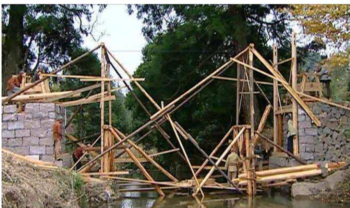
Abb. 57 Shijin-Brücke, Landkreis Pingnan, Fujian. Konstruktion mit dem Pfahlrahmen-Gerüst. Ein Demonstrationsprojekt für die UNESCO. Bauleiter ist Meister Huang Chuncai. (aus: Pingnan, 2009)
