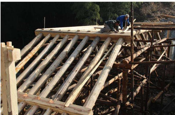
g. Sobald die Unterkonstruktion des fünfseitigen Bogens fertig ist, wird die genaue Länge der O-S-Balken bestimmt. Sie werden vor Ort eingepasst.
