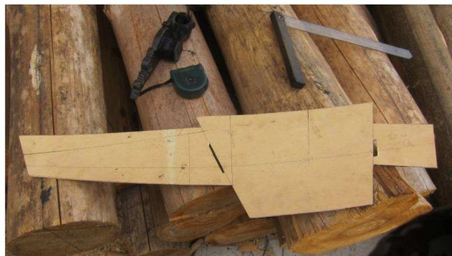
Abb. 37 Baustelle der Shengshuitang-Brücke. Landkreis Qingyuan, Zhejiang. Schablone des S-Balkens(2) bei Meister Wu Fuyong.
