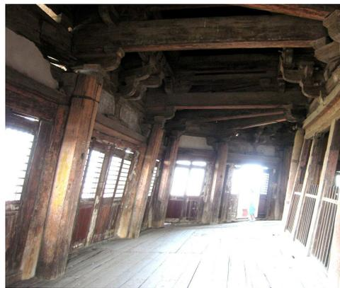
a. Die schräge Balken sind nur in den Zwischengeschossen, zwischen den sichtbaren Vollgeschossen, zu finden.      b. Verformung in der Pagode.
