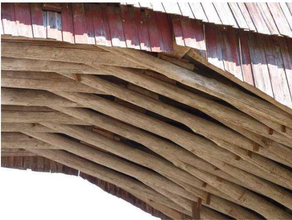
Abb. 17 Lanxi-Brücke, Landkreis Qingyuan, Zhejiang. Nach dem Umbauen und der Reparatur der Brücke sind die Abstände zwischen den O-S-Balken(2) und den Q-Balken(1) heute mit Holzabschnitten gefüllt.
