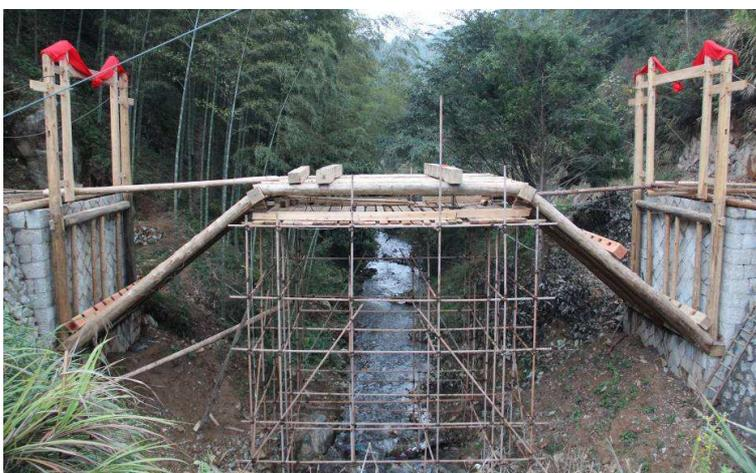
Abb. 72 Baustelle der Shengshuitang-Brücke. Landkreis Qingyuan, Zhejiang. Die Fußbalken(2) an den Bogenfüßen liegen auf den Feldherrensäulen.
