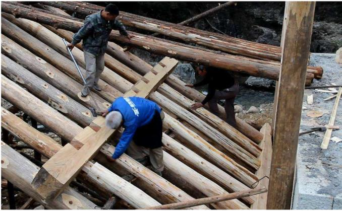
d. Nachdem die U-S-Balken in Position gebracht sind, wird der Querbalken auf die Zapfen der U-S-Balken gesetzt.
