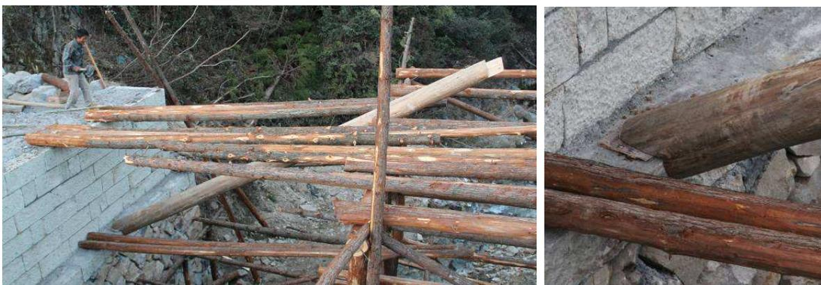
Abb. 47 Baustelle der Dongtang-Brücke. Landkreis Jingning, Zhejiang. Für das *Xiatu* am kommenden Morgen wurde der mittlere S-Balken(1) am Abend zuvor an seine Stelle gesetzt, und mit einem kleinen Holzstück wurde verhindert, dass er den Boden berührt.
