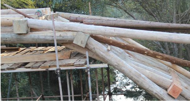
Abb. 29 Baustelle der Shengshuitang-Brücke. Landkreis Qingyuan, Zhejiang. Eine Kerbe ist in den SL-Balken gehackt worden, weil der Q-Balken(1) ihm im Wege steht.
