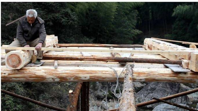
l. Die Länge jedes einzelnen L-Balkens wird vor Ort bestimmt. Danach werden die L-Balken kontrolliert und angepasst.
