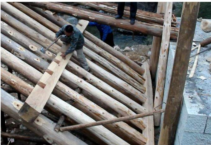
f. Für die Verfestigung der Verbindung zwischen U-S-Balken und Querbalken wird auch der Hammer verwendet.
