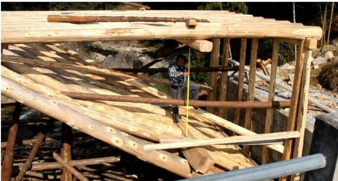
a. Nachdem die SL-Balken in Position gebracht sind, werden die oberen Balken der „Froschschenkel“-Konstruktion seitlich an den SL-Balken befestigt. Die genaue Länge der Stützen wird vor Ort bestimmt.
