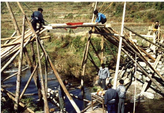
Abb. 48 Baustelle der Demonstration-Brücke, Landkreis Shouning, Fujian. 2001. Ein Brückenbauprojekt für den Dokumentarfilm „Suche nach der Regenbogenbrücke“ von Meister Zheng Duojin. „Den Drachen schließen“. (Foto von Gong Difa).
