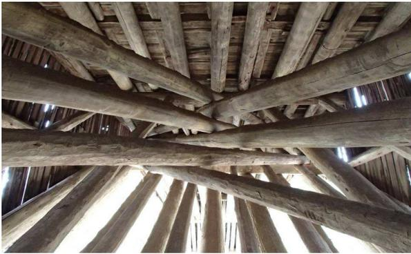
Abb. 78 Fushou-Brücke. Landkreis Shouning, Fujian. Drei Paar X-förmiger Stützen.
