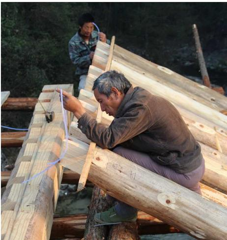
Abb. 12 Baustelle der Dongtang-Brücke. Landkreis Jingning, Zhejiang. Prüfung der waagerechten Ausrichtung mit einem durchsichtigen Gummischlauch.
