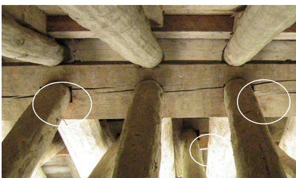
Abb. 15 Wenxing-Brücke, Ortschaft Xiaocun, Landkreis Taishun, Zhejiang. Detail der inneren Konstruktion. Die Zapfenlöcher der beiden Bogensysteme haben die Form querformatiger Rechtecke. Die vielen (mit weißen Kreisen markierten) Zapfenlöcher sind größer als die Zapfen, was erfahrene Zimmermänner vermeiden.
