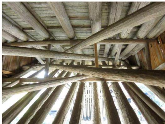
Abb. 18 Beijian-Brücke, Sixi, Landkreis Taishun, Zhejiang. Sie besitzt recht lange U-S-Balken(2). Weil die U-Querbalken sehr hoch sind, stehen die mittleren Stützen nicht auf dem Querbalken, sondern auf einem zusätzlichen kleinen Balken. Vgl. mit der Xuezhai-Brücke der Xiaodong-Meister (Abb. 11).
