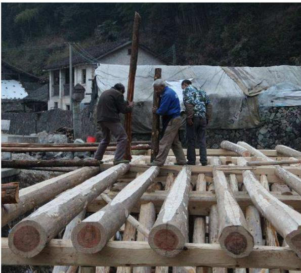
Abb. 80 Baustelle der Dongtang-Brücke. Landkreis Jingning, Zhejiang. Mit Baumstämmen als Hammer werden die Zinken der SL-Balken in ihre Schwalbenschwänze eingeschlagen.
