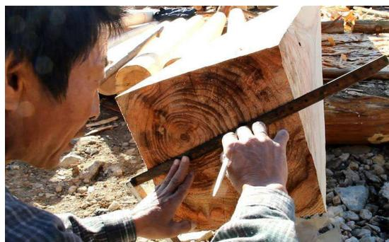
a. Der Q-Balken(1) wird in eine Neigung von 3-Zehntel-Wasser gebracht, was seiner Lage in der aufgebauten Konstruktion entspricht. Dann werden die senkrechten und waagerechten Grundlinien darauf gezeichnet, womit die Linien für die Zapfenlöcher definiert werden.
