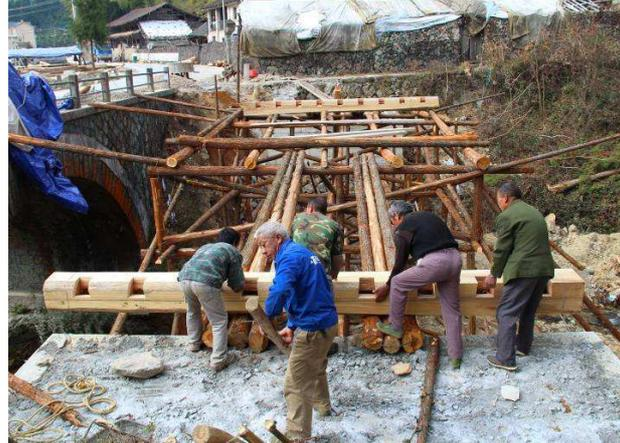
Abb. 60 Baustelle der Dongtang-Brücke. Landkreis Jingning, Zhejiang. Die Q-Balken(1) werden über ein Gleis auf die Plattform gerollt.
