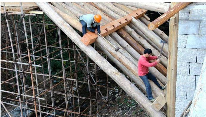
b. Die U-S-Balken werden zuletzt eingesetzt. Sie haben Schwalbenschwanzverbindungen an beiden Enden.
