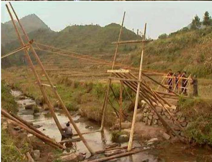
Abb. 58 Baustelle der Demonstration-Brücke, Landkreis Shouning, Fujian. 2001. Errichtung der Pfahlrahmen mit Seilen und Hebevorrichtung. (aus: CCTV, 2001)
