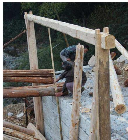
Abb. 73 Baustelle der Dongtang-Brücke. Landkreis Jingning, Zhejiang. Halbfeldherrensäulen. An den oberen Enden befinden sich Zapfen, womit die seitlichen SL-Balken verbunden werden.
