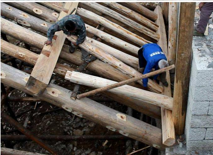
c. Nachdem die U-Querbalken befestigt sind, werden die U-S-Balken eingestellt. Bei den Brücken der Xiaodong-Meister haben die U-S-Balken an beiden Enden Zapfen, die in die Zapfenlöcher in den Fußbalken und den U-Querbalken eingesetzt werden. Bevor der Querbalken auf den U-S-Balken gesetzt wird, werden die oberen der S-Balken mit kleinen Hölzern unterstützt.
