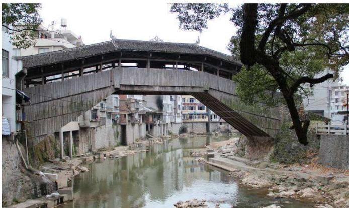
Abb. 11 Xuezhai-Brücke, Sankui, Landkreis Taishun. Sie wurde 1857 durch den Xiaodong-Meister Xu Yuanliang in ausgereifter Technik errichtet und befandete sich in gutem Zustand zur Zeit des Fotos in 2012.
