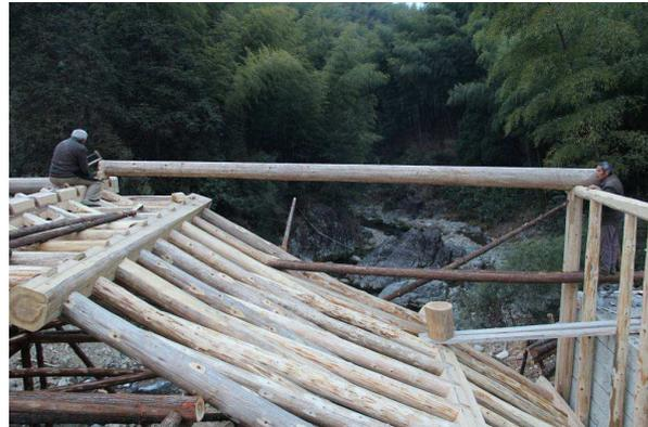
Abb. 77 Baustelle der Dongtang-Brücke. Landkreis Jingning, Zhejiang. Ein SL-Balken liegt auf einer Halbfeldherrensäule. Die Länge des Balkens wird vor Ort mit einer Säge angepasst.
