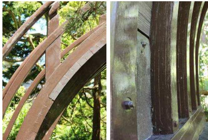
b. Die Konstruktion des gebogenen Balkens: jeder Balken unter dem Brückendeck ist aus sechs dünnen Holzschichten, drei dickeren und drei dünneren, zusammengesetzt. Die dickeren Schichten sind oberflächlich im Abstand von etwa 10 cm regelmäßig eingeschnitten und damit biegsam. Die Schichten werden durch Metallbolzen zusammengehalten. Das Brückendeck ist aus quadratischen Holzblöcken zusammengesetzt; sie haben halbkreisförmige Zapfen und Zargen an ihren Enden.
