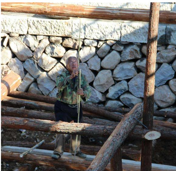
Abb. 9 Baustelle der Dongtang-Brücke. Landkreis Jingning, Zhejiang. Ein Zimmermann misst die lichte Höhe des Gerüstrahmens mit zwei Bambusstreifen.
