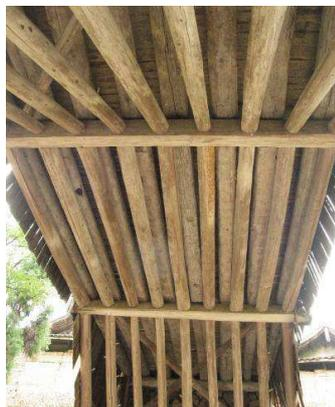
Abb. 5 Shengxian-Brücke, Landkreis Shouning, Fujian. Ansicht und die untere Konstruktion einer typischen Sprengwerkbrücke.
