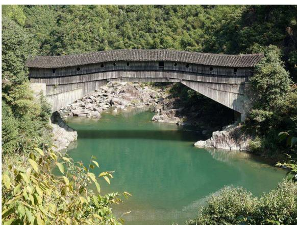
Abb. 1 Yangmeizhou-Brücke. Landkreis Shouning, Fujian. Um die natürlichen Gesteine für das Fundament zu nutzen, wurde die Brücke an einer Stelle errichtet, wo ist das Flussbett mehr als 20 m tief, während an der Stelle nur ein paar Dutzend Meter flussaufwärts ist das Wasser sehr seicht.
