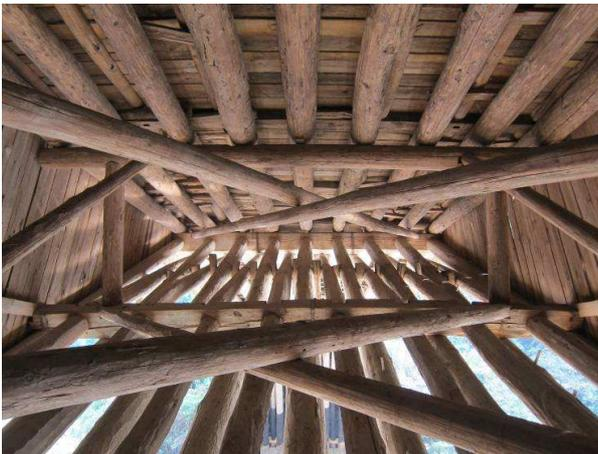
Abb. 2 Qiongdai-Lingjiao-Brücke, Landkreis Jingning, Zhejiang. Gebaut 1870 durch einen Xiaodong-Meister. Auffallend saubere Konstruktion des durch einen erfahrenen Brückenbaumeister errichteten Holzbogens.
