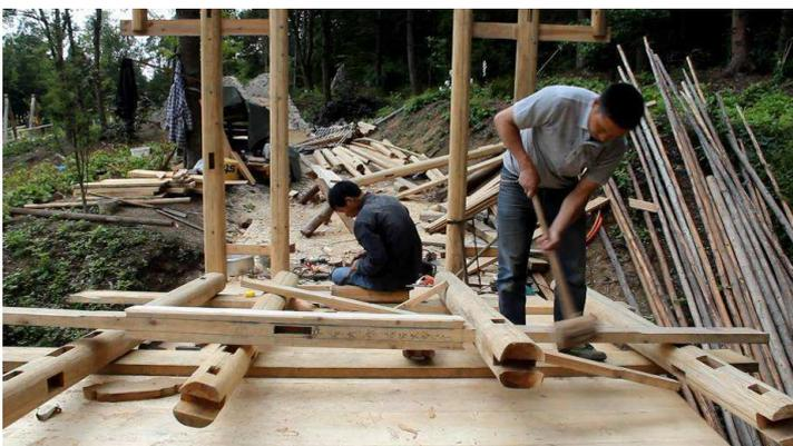
a. Der Rahmen des Fachwerks wird auf dem Boden zusammengebunden.
