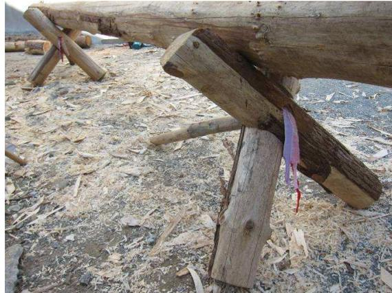
Abb. 45 Baustelle der Dongtang-Brücke. Landkreis Jingning, Zhejiang. Die Holzpferde dienen als Werkbank. Das farbige Stück Stoff wurden für das Ritual angefügt und soll Glück bringen.
