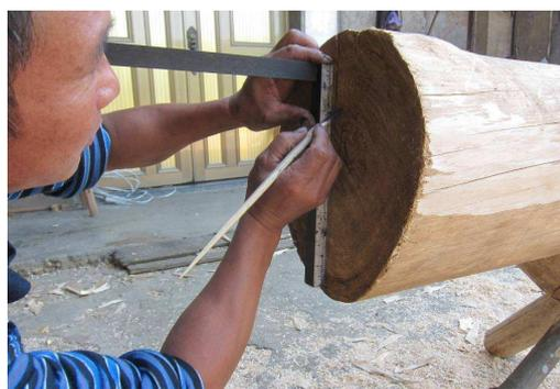
Abb. 5 Baustelle der Dongtang-Brücke. Landkreis Jingning, Zhejiang. Ein Zimmermann trägt eine Markierung auf einem Balken mit dem Lubanswinkel auf.
