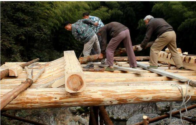
j. Nach Einsetzen der O-S-Balken, werden die O-Querbalke auf die Zapfen aufgesetzt und andrückt. Das Festdrücken der Verbindungen ist die Stufe „Querbalkeenschlag“ bzw. das Choudu. Ein Baumstamm wird dafür als Hammer benutzt. Eine Eisenstange dient dem gleichen Zweck.
