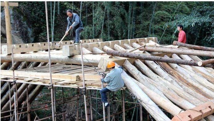
a. Zuerst werden die O-S-Balken in den Bogen gewebt. Um die O-S-Balken dicht an der Konstruktion zu drücken, werden Stahlseile benutzt.
