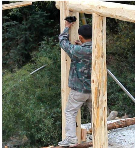
Abb. 13 Baustelle der Dongtang-Brücke. Landkreis Jingning, Zhejiang. Die vertikale Ausrichtung wird mit der Tintenschlagschnur geprüft.
