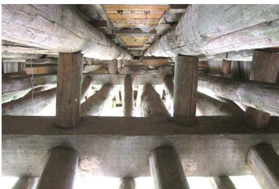
Abb. 7 Rulong-Brücke, Landkreis Qingyuan, Zhejiang. Klaffung zwischen dem Gewebebogen und den oberen Deckenbalken.
