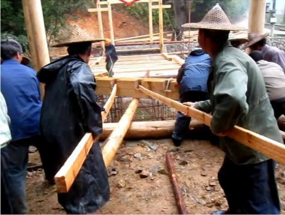
Abb. 59 Baustelle der Shengshuitang-Brücke. Landkreis Qingyuan, Zhejiang. Die Q-Balken(1) werden mit Seilen und Holzstangen über ein Gleis in Richtung der mittleren Plattform bewegt.
