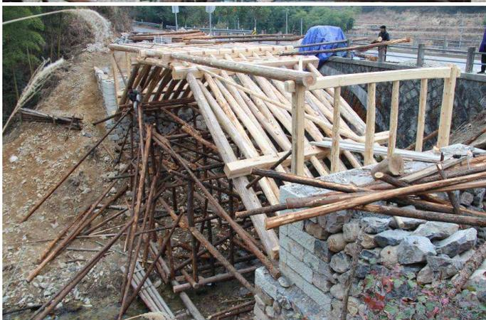
n. Nach Fertigstellung des Gewebebogens wird das Gerüst teilweise abgebaut. Es darf nun nicht mehr den Bogen der Brücke berühren. So wird vermieden, dass im Falle einer Beschädigung des Gerüsts durch Wasser auch der Brückenbogen beschädigt wird.
