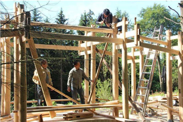
c. Nach Aufrichtung der Rahmen für den Korridor werden sie über Längsbalken miteinander verbunden.
