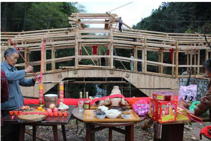
Abb. 50 Baustelle der Shengshuitang-Brücke. Landkreis Qingyuan, Zhejiang. *Dong*-Fest für die Brücke. Das *Dong* (in dieser Brücke ist es die Dachpfette) wird vor dem Fest mit rotem Stoff abgedeckt. Das Fest wird neben der Brücke gefeiert.
