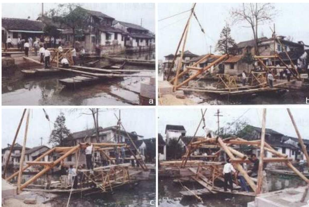
Abb. 8 Konstruktionsprozess der Jinze-Brücke. Jinze, China. (aus: Tang, 2010, S.118)
