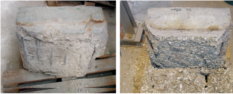
Bild 4. Nachträgliches Abfallen von Betonschichten an den Kleinprobekörper vier Tage nach den Brandversuchen
