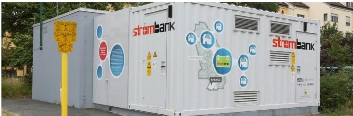
Abbildung 5.6: Ortsnetzspeicher „Strombank“ der MVV Energie [MVV16]
