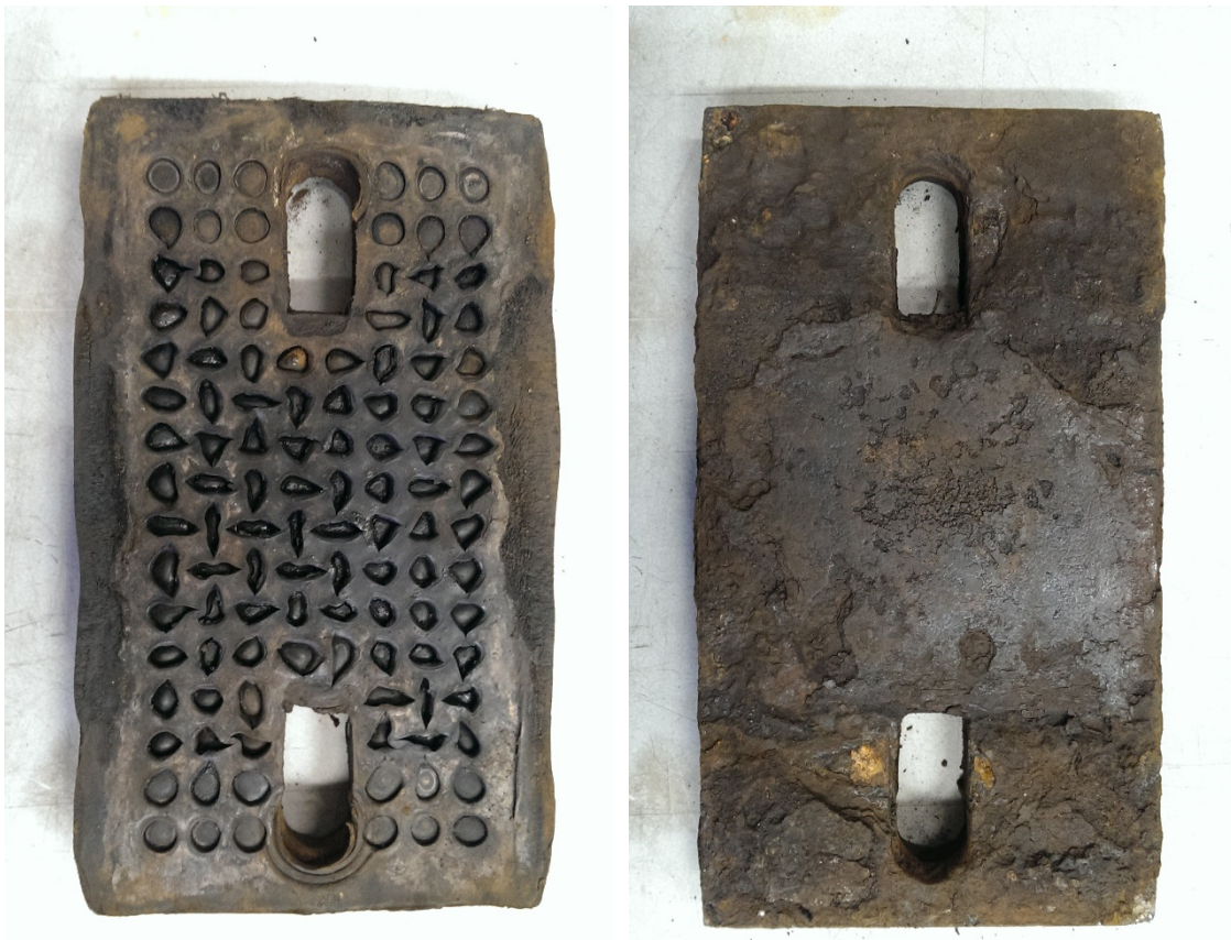
Abbildung 8.17 Ausgebaute Zwischenplatte (links) und Grundplatte (rechts) aus dem Tauerntunnel
