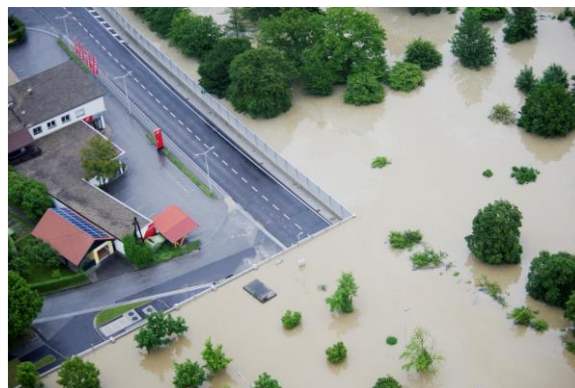
Figure 6.13 Mobile flood protection (Hochwasserleitwände) (Rudolf-Miklau & Rimböck, 2016)
