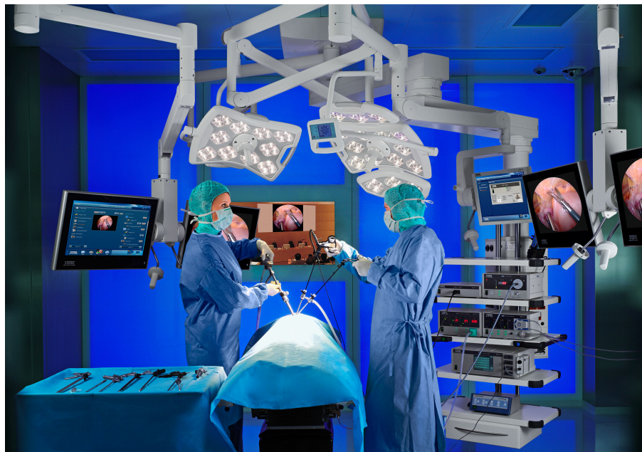
Abbildung 3 Integrierter Operationssaal „OR1“ der Firma KARL STORZ GmbH & Co. KG (Karl Storz). Die Geräte am Geräteturm (rechts im Bild) sind allesamt über ein firmeneigenes, proprietäres Bussystem miteinander verbunden. Geräteparameter können von der zentralen Bedieneinheit (Touchscreen links im Bild) aus dem sterilen Bereich heraus eingestellt werden. Alarm- und Statusmeldungen einzelner Geräte können auch zentral auf dem Touchscreen angezeigt werden. Außerdem können Videosignale anforderungsbasiert auf individuelle Bildschirme geroutet werden. Je nach Ausprägung können zudem Elemente der Haustechnik, wie etwa die Raumbelichtung, eingestellt werden. Quelle: KARL STORZ GmbH & Co. KG .
