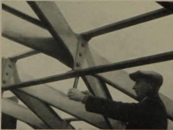
14 Knotenpunktverbindung eines Junkers-Stahllamellendaches; drei Bauelemente: die Lamelle, die Knotenbleche, die Pfetten.
