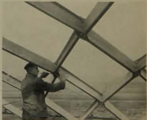
15 Einzelheit des Stahllamellen-Netzwerks Bauart Hünnebeck; zwei Bauelemente: die Stahllamelle und das Knotenblech.
