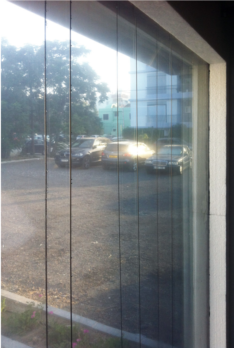
Abbildung 138: Fluidglasprototypen mit eingefärbtem Fluid; Blick von innen nach außen; Nicosia, 4.07.2017; EU-Projekt „FLUIDGLASS“
