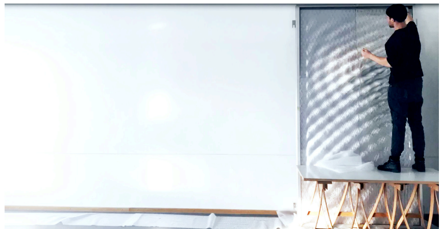
[Abb. 10.3.2_4] 3D-gedruckte Fassadenelemente M 1:1 Element 2+5 werden paarweise in den Aluminiumrahmen gesetzt
