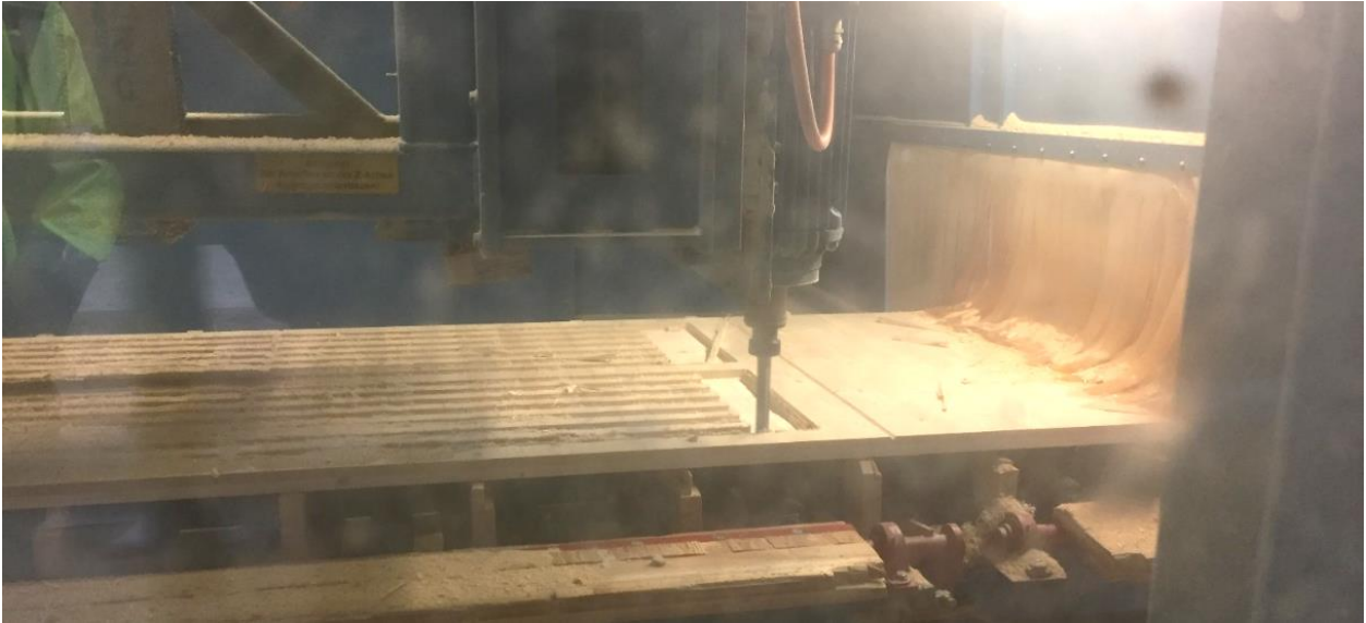
Abbildung 4.5: Der Abbund der Halbelemente erfolgt mit einem 30 mm-Fingernutfräser
