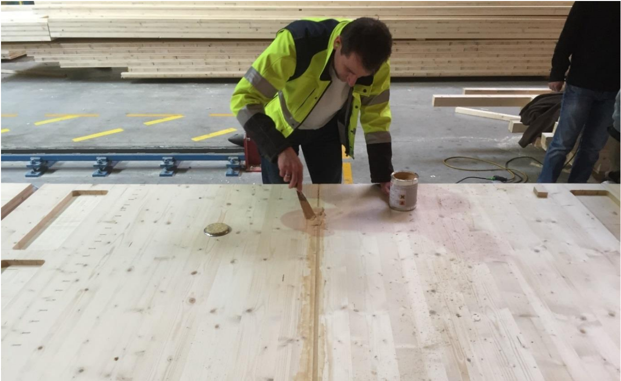
Abbildung 4.14: Versiegelung zur Vermeidung hydraulischer Kurzschlüsse entlang der V-Nut
