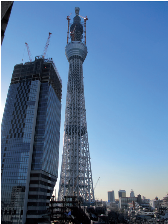
Bild 2. Vom Boden bis zur Spitze ändert der Turm mehrmals seine Form, um verbesserte Eigenschaften zu erreichen; trotzdem erscheint er als eine wohlgestaltete Einheit. © T. Bock Fig. 2. In order to achieve enhanced performance, the tower changes its form several times. Nevertheless, it appears as a well-designed entity.
