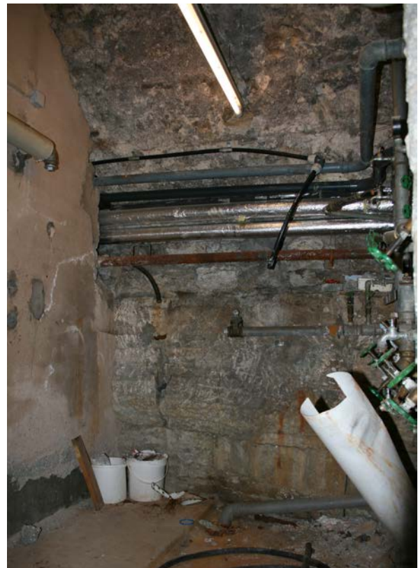
22 | 2. UG, Kammer (HbN-2UG2a) im hinteren Teil des großen Gewölbekellers (HbN-2UG01) gegen Norden, zuunterst grob gespitzter, anstehender Felsen, wohl in Bauphase I.1 abgearbeitet, Gewölbe in Bauphase III.1b neu aufgeführt (Nov. 2012); vgl. VIII.24
