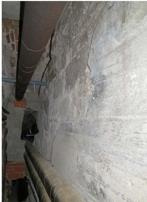
9 | 1. UG, Technikgang (HbW-1UG01) gegen Norden, Ostwand, regelmäßiges Schichtenmauerwerk aus großformatigen, grob gespitzten Kalksteinquadern, gen Süden mit Beton verschalt, entspricht Fundament der barocken Westfassade aus Bauphase IV.2c (Nov. 2015)
