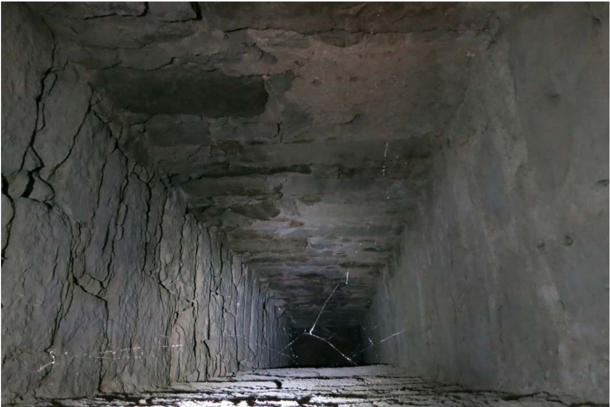
57 | Erdgeschoss, Abortschaft im Bereich der ehem. Gesindekammer (HbS-EG04), ca. 80 x 120 cm, Blick nach unten (Außenansicht s. VII.11) (Nov. 2015)
