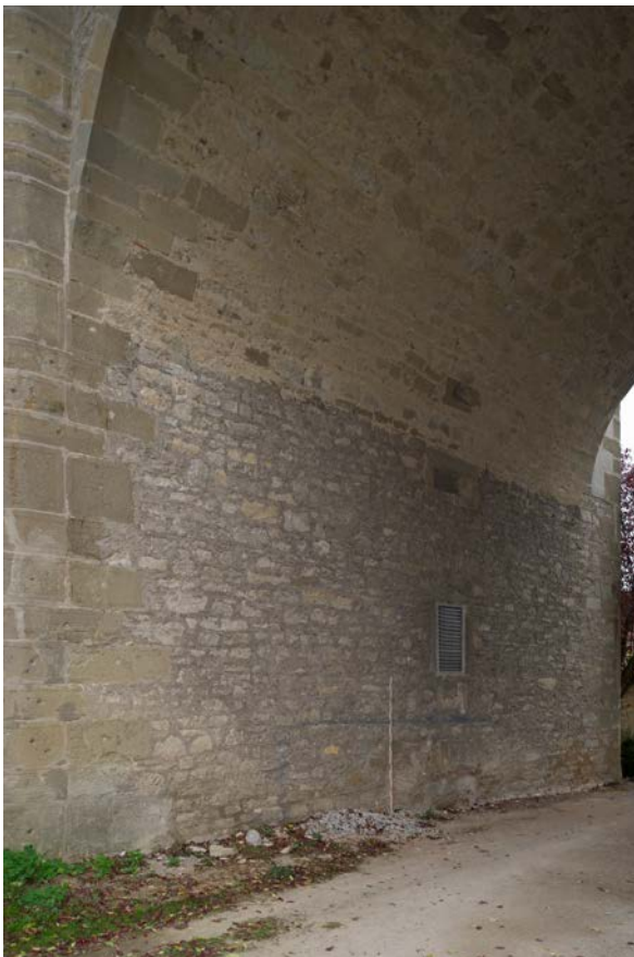
39 | Basteiturm Ost, Südfassade gegen Nordosten im Durchgang unter dem Kommunikationsbau mit überformter Schießchartenöffnungen in der Mitte (Detail s. VII.40) (Okt. 2015) | © Isabel Muehlhaus TUM
