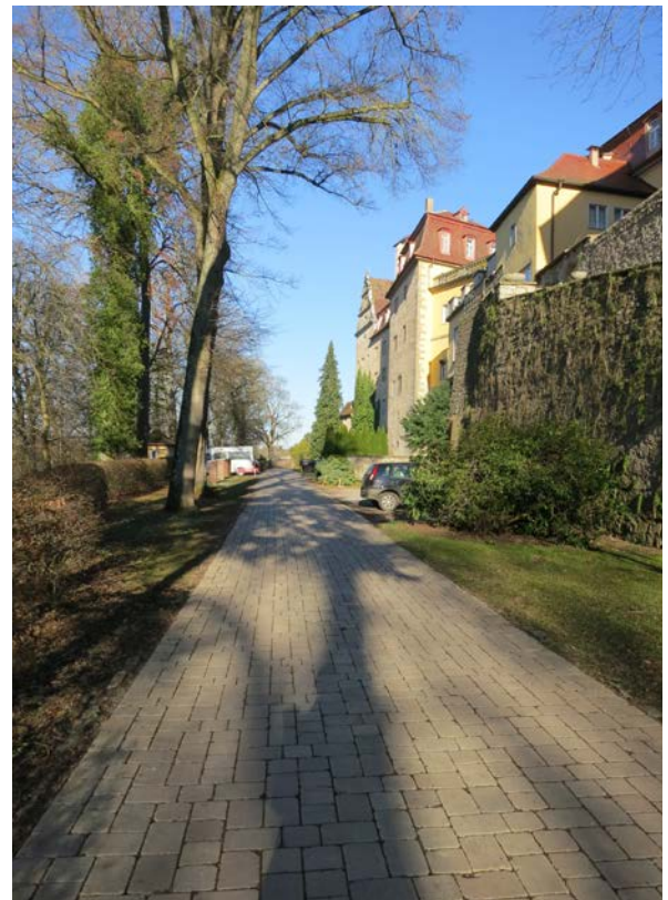
12 | Neuer Weg auf Höhe des Marstallhofs gegen Nordosten (Feb. 2014)
