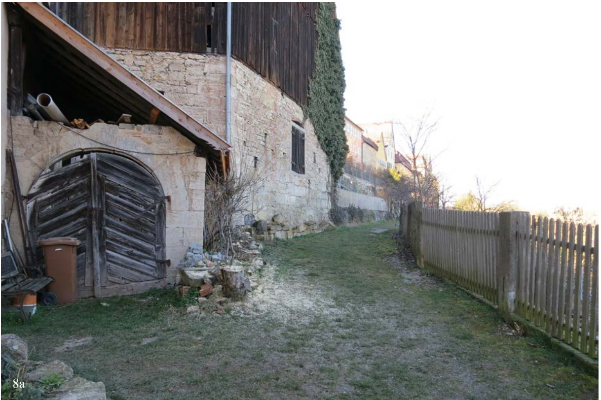
8a/b | Kirchberg, Kirchstraße 2, zweigeschossige Scheune über spitzwinkligem Grundriss, Erdgeschosssockel aus Kalksteinquadern, entspricht wohl ehem. Bastion, im 19. Jahrhundert umgewidmet und aufgestockt (gk, s), Ansicht gegen Norden (8a) und gegen Südwesten (7b) (Feb. 2018)
