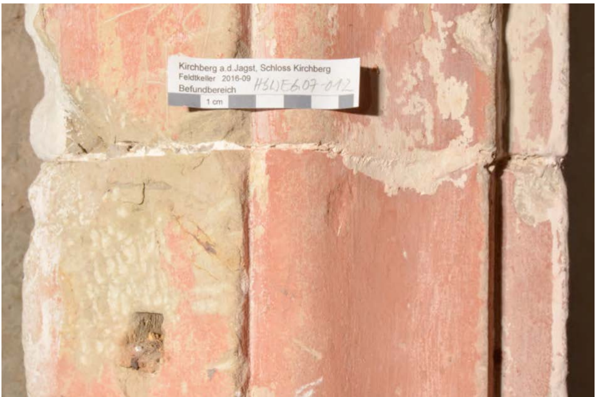
31 | Erdgeschoss, Werksteinrahmen vom Typ A aus Bauphase II (s. Taf. XIVa), Detail nördlicher Türstock am Durchgang (HbW-EG08-Wb-T01) zwischen den Räumen HbW-EG07 & 08, Schichtenfolge Befundstelle 012: Stein, Gelb, Gelb, Rot (Sept. 2016); Gesamtansicht s. X.30, Details Rückseite s. X.33 & 34 | abgeb. in FELDTKELLER 2016
