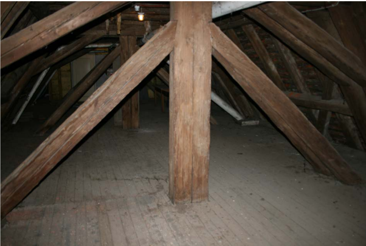
80 | 2. Dachgeschoss gegen Osten (Jan. 2013)
