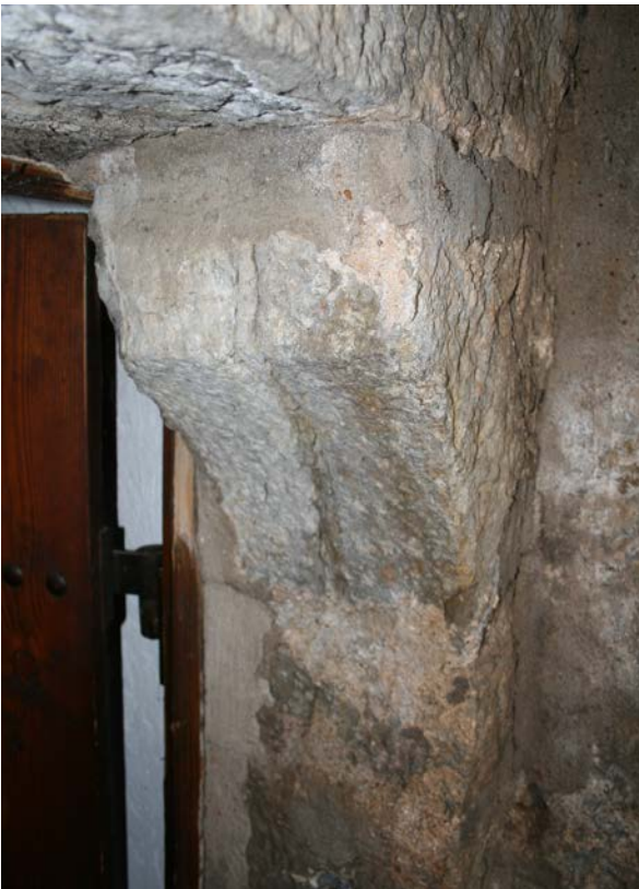
11 | Sturzstein am Werksteinrahmen (Tu-1UG01-Wd-T01) ins 1. UG, Kalkstein, grob gespitzt (Nov. 2012); Gesamtansicht s. XI.10
