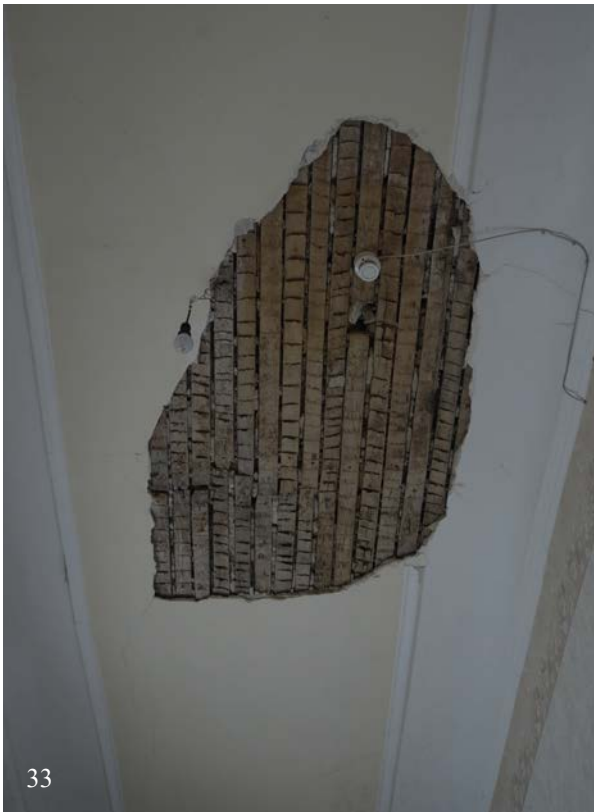
33 & 34 | Marstall, 1. Obergeschoss, stuckierte Decke wohl aus Bauphase IV.2 über dem Flur (Ma-1OG02), Fehlstelle im Mittelteil gibt die sog. Lattenquadratur und den Stuckaufbau zu erkennen (Jan. 2012); im Detail (34 | Nov. 2012 | © BÜCKNER/SCHREIBER 2013) Befundstelle 010
