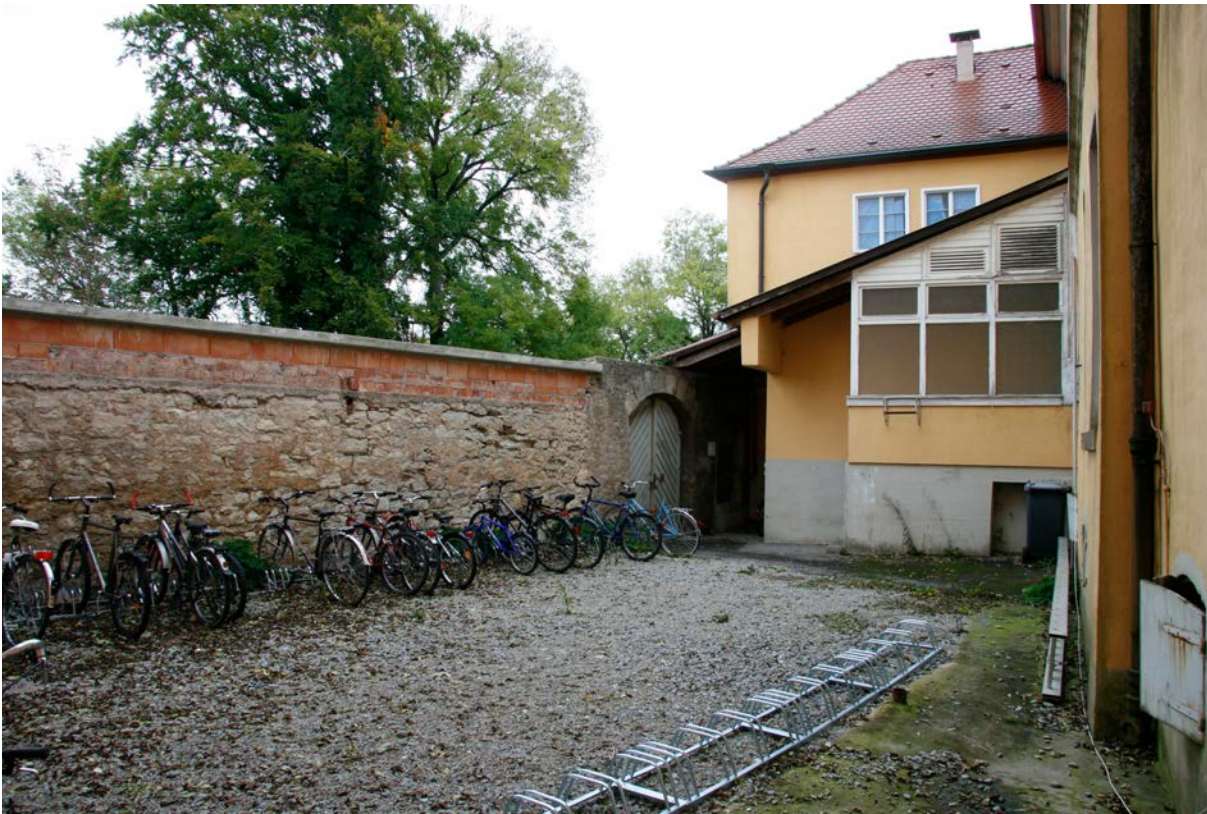
3 | Marstall, Hof auf der Rückseite gegen Norden mit Ausgang auf den Neuen Weg und Blick auf die ehem. Strohkammer und Sattelkammer mit vorgesetztem, modernen Pultdachbau, der den Eingang in den Marstall überdacht, Hofmauer entspricht der ehem. Zwingermauer und datiert im Kern wohl mittelalterlich, das Rundbogentor (Außenansicht s. XIII.4) und die dahinter hinab führende Rampe (XIII.5) wurden um 1744/45 errichtet (Okt. 2017)
