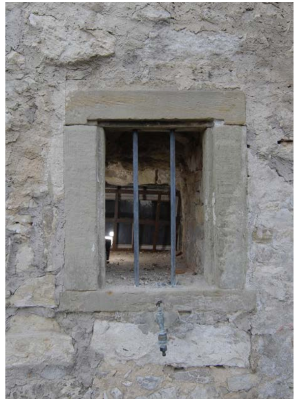
64 | Witwenbau, Fensterschacht (Wi-F-O-1UG10) der ehem. „Metzlerkammer“ in der östlicher Fundamentmauer (ehem. Stadtmauer), wohl nachträglich eingebrochen, Rahmen aus zweitverwendeten Steinen (Jan. 2012); Innenansicht s. XIII.62
