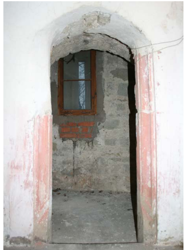
30 | EG, Durchgang (HbW-EG08-Wb-T01) zum ehem. Schießstand gegen Westen mit Werksteinrahmen vom Typ A aus Bauphase II (s. Taf. XIVa), in Bauphase IV.2c zweitverwendet (Nov. 2012); zur Fassung s. X.31 & 32
