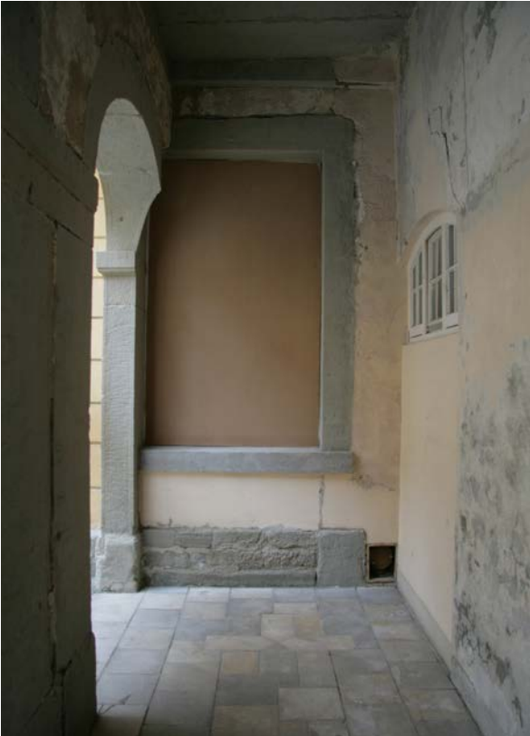
15 | EG, südliche Fensterachse unter dem Altan, ehem. Haupteingang in die Gesinderäume, zw. 1944 und 1954 zum Fenster geschlossen (Okt. 2015); aktueller Zugang s. IX.6
