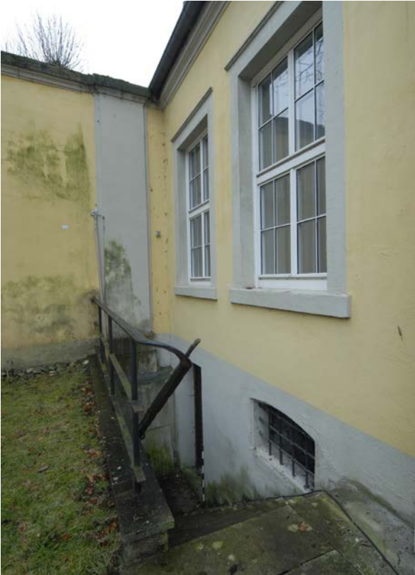
8 | Marstall-Anbäulein, Außentreppe Ma-Tr2-EG(1UG) gegen Südwesten, erschließt die Keller im 2. UG, 1957/58 anstelle des ursprünglich ebenerdigen Zugangs errichtet (Jan. 2012); historische Ansicht s. III.18
