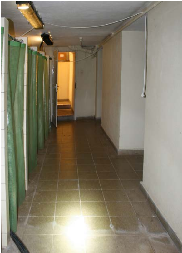
36 | 1. UG, kleiner Keller (HbN-1UG03) im Bereich des Anbaus aus Bauphase III.1b gegen Südwesten (Nov. 2012)
