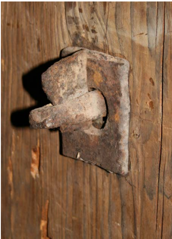
122 | 2. DG, Detail Eisenarmierung an der Hängesäule (März 2013)
