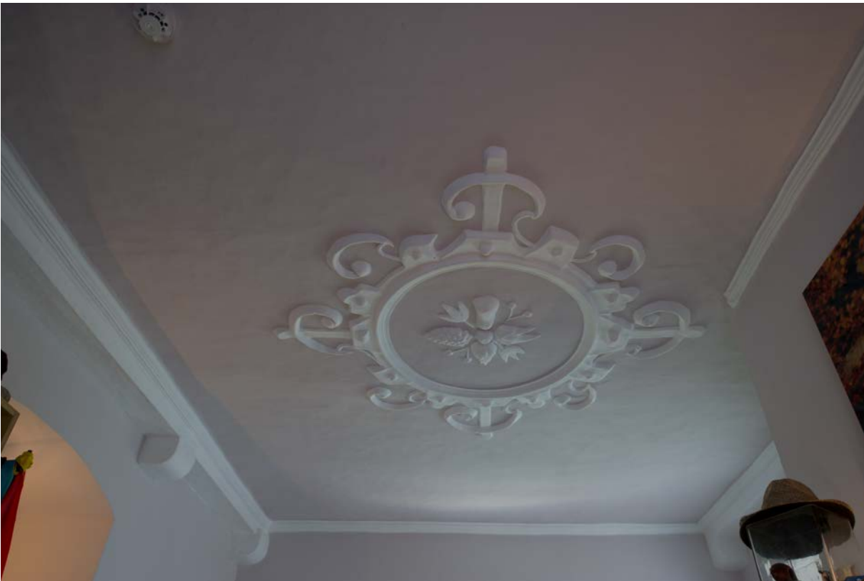
35 | Erdgeschoss, Decke über der ehem. Kammer (Tu-EG02) gegen Osten mit seitlichen Streichbalken auf Konsolen und Stuckwerk wohl aus Bauphase III.1b (Juli 2017); Detail Stuckwerk s. XI.36 | © Isabel Muehlhaus TUM
