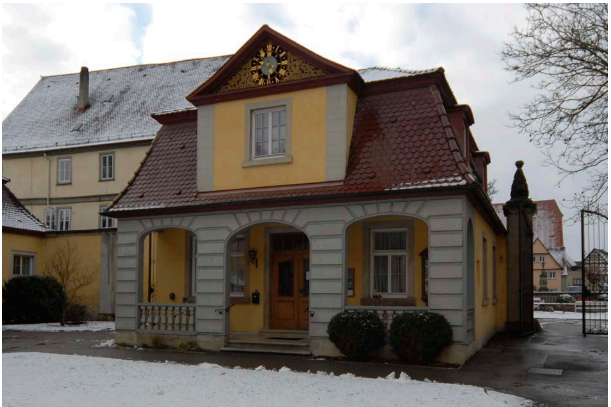
2 | Wachhaus, Hofansicht gegen Süden, eingeschossiger, verputzter Fachwerkbau mit Mansarddach und hofseitiger Loggia, Neubau von 1962 (vgl. III.21) (Jan. 2012); Ansicht des historischen Wachhauses s. III.19 & 20
