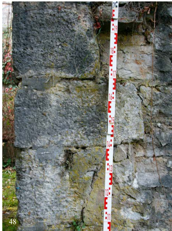
47 & 48 | Südostecke der Schlossgrabenmauer mit Detail (48 | Okt. 2017) der Eckquaderung aus Kalksteinquadern mittleren Formats mit grob gespitzter Spiegelfläche innerhalb eines umlaufenden Randschlags (Jan. 2013); vgl. formgleiche Eckquaderung an der Nordwestecke XVI.34
