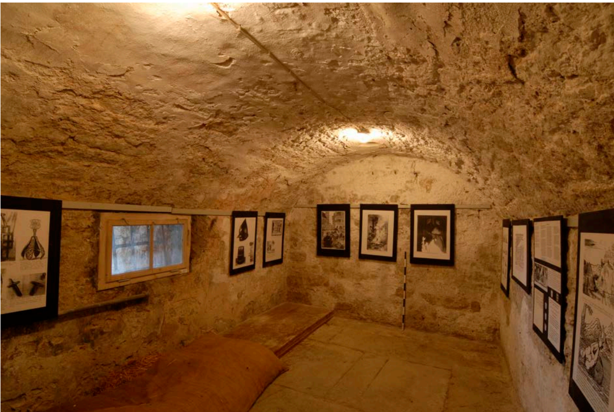
62 | Witwenbau, ehem. „Metzelkammer“ (Wi-1UG02) gegen Süden mit Blick, in der Außenwand links Fensterschacht (Wi-F-O-1UG10) zum rückseitigen Terrassengarten, in Bauphase IV.2a neu überwölbt (gk) (Jan. 2012); Außenansicht Fenster s. XIII.64
