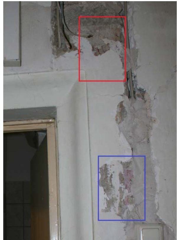
51 | 1. OG, ehem. Abort (HbW-1OG06), historische Farbreste an der Südwand (ehem. Außenwand des vorderen Schlossbaus) mit Befundstellenmarkierung (Jan. 2013); Details Befunde s. X.52 & 53
