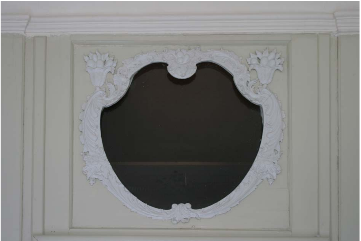
106 | 2. Obergeschoss, ehem. Graues Kabinett (HbS-2OG06), Detail Oberlicht aus Bauphase IV.2c zur Belichtung der ehemals nördlich angrenzenden Kammer (1956 abgebrochen, s. XVII.9), kartuschenförmiger Rahmen aus Laubwerk mit Früchten und zwei seitlichen Vasen, Holz, weiß lackiert (Okt. 2012)
