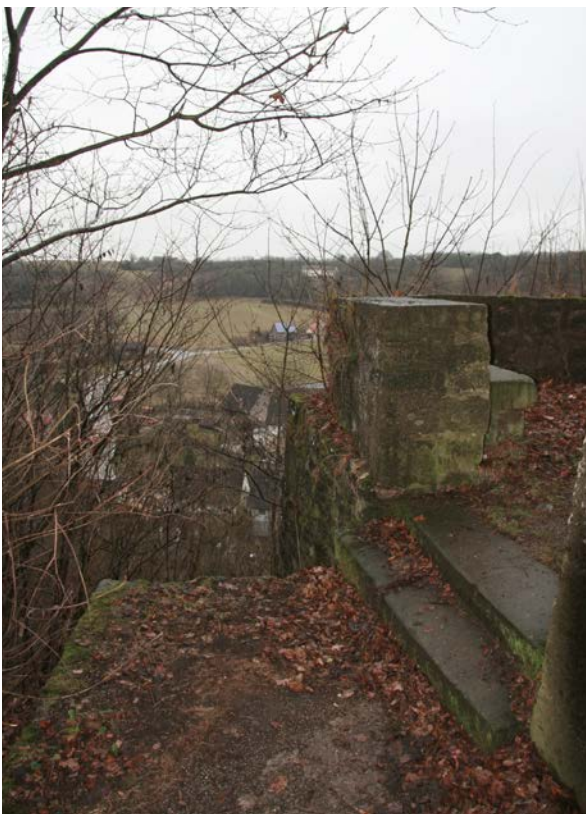
29 | Zugang in den Zwinger an der Spornspitze im Bereich der ehem. Eckbastion, Blick gegen Nordosten, wohl im mittleren 18. Jh. zur Erhaltung des „bürgerlichen Spazierwegs“ geöffnet (Dez. 2016)
