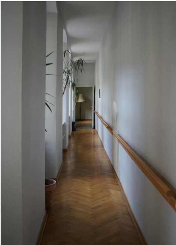
21 | 1. OG, Gang (HbO-1OG01) längs der ehem. herrschaftlichen Gemächer gegen Norden, in der Mitte rechts Feuernische zum Hinterladerofens im ehem. Vorgemach (s. IX.23), Ofenstelle im 20. Jh. geschlossen (Nov. 2012)
