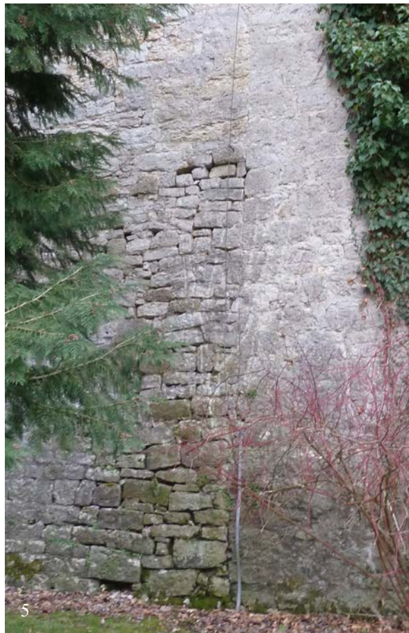
4 & 5 | Vertikale Baufuge zwischen der Remise und dem südlich anstoßenden Saalbau, oberer (4 | Jan. 2018) und unterer Abschnitt (5 | März 2013)
