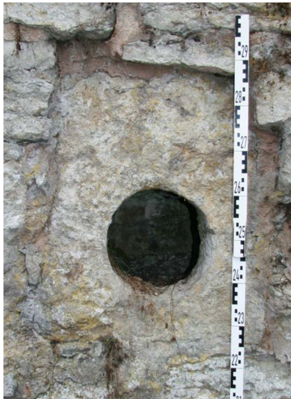
69 | Schlossgrabenmauer, Befundstelle 11: Kugelscharte mit rückseitiger Schießnische (zur Bauzeit vermauert) (Dez. 2016)
