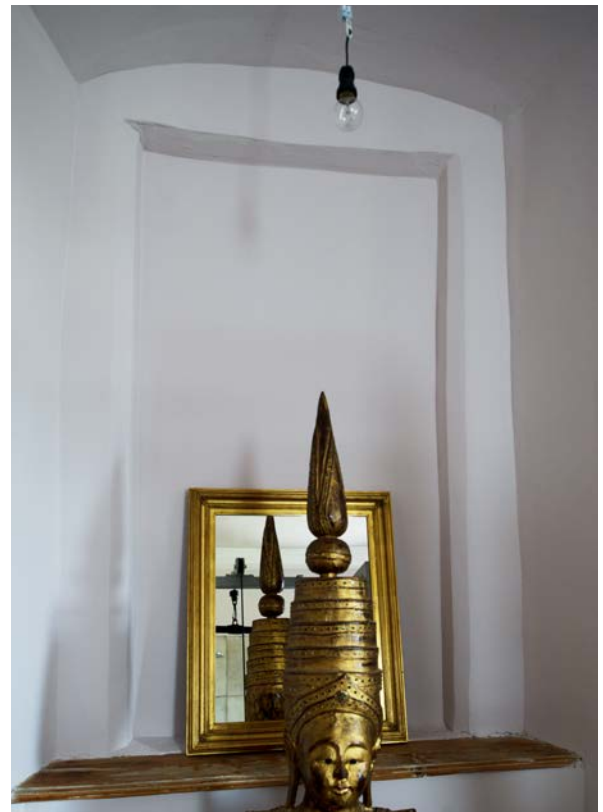
34 | EG, ehem. Kammer (Tu-EG02), ehem. Fensteröffnung (Tu-N-EG-F01) aus Bauphase III.1b an der Nordwand, in Bauphase IV.3b geschlossen (Nov. 2017) | © Isabel Muehlhaus TUM
