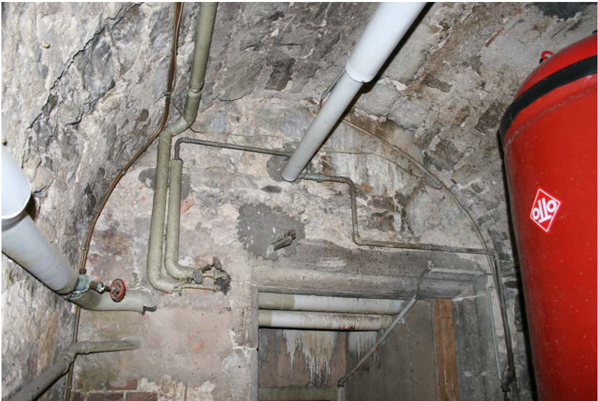
14 | 2. Untergeschoss, großer Gewölbekeller, Nordwand im Stich (HbN-2UG01a) zum Turm, ehem. Turm-Außenwand, in Bauphase III.1b an den Saalbau angeschlossen und das 2. Turm-Untergeschoss dem Saalbaukeller zugeschlagen (Nov. 2012); zum stumpfen Gewölbeanschluss s. VIII.15
