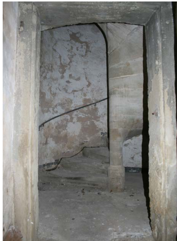
85 | 2. UG, Fuß der Kellerwendeltreppe aus Bauphase II (HbS-Tr1-EG(2UG)) gegen Norden (Jan. 2013)
