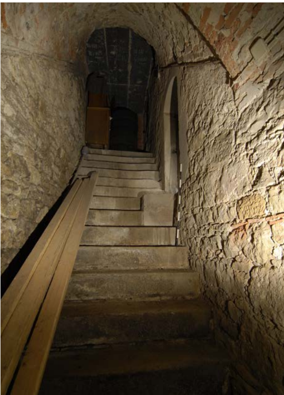
70 | Witwenbau, Treppe (Wi-Tr4-1UG(2UG)) in die Kellergewölbe, Blick vom Viertelpodest zum Eingang, re. Zugang in das obere Gewölbe (Wi-1UG04) (März 2012); s. auch XIII.71
