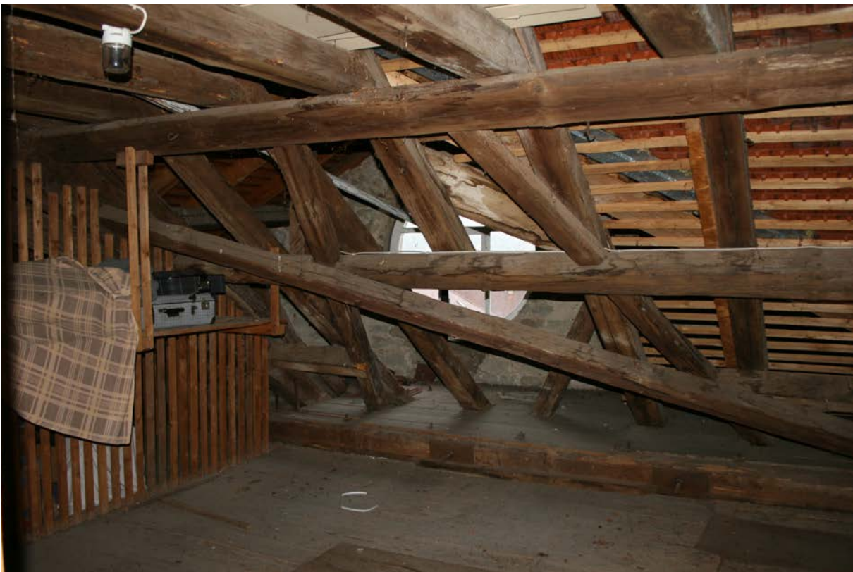
119 | 2. Dachgeschoss, Dachwerk auf Höhe des Querhauses mit Blick gegen Süden auf die Rückseite des gemauerten Giebeldreiecks (Jan. 2013)
