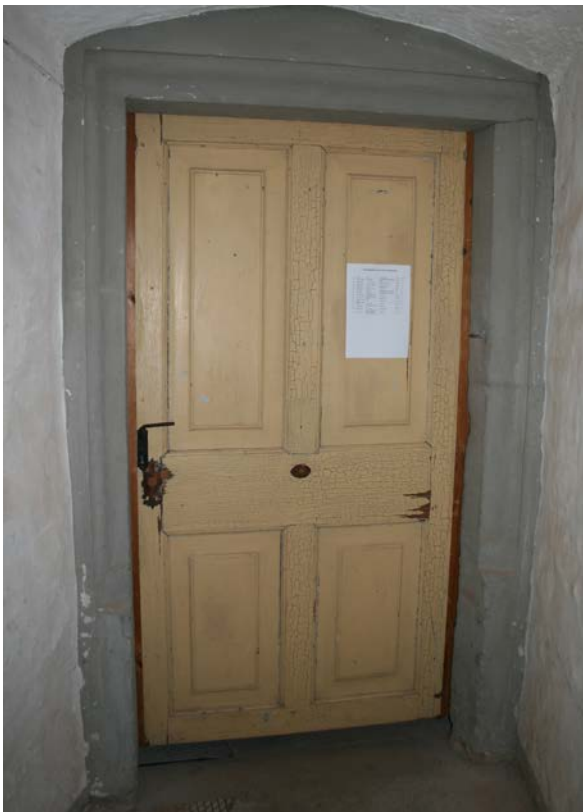
81 | 1. UG, Zugang (BaO-1UG01-We-T01) in den Basteiturm Ost mit Werksteinrahmen vom Typ B (Taf. XIVb) aus Bauphase II (Jan. 2013)
