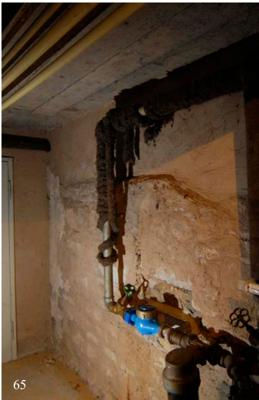
65-67 | Witwenbau, 1. Untergeschoss, rechts (65 & 66) Südwand des Technikraums (Wi-1UG03), historischer Mauerwerksverband, regelmäßiges Schichtenmauerwerk aus mittelgroßen, grob gespitzten Kalksteinquadern, verlängert die Nordwand der östlich angrenzenden, ehem. „Metzlerkammer“, bei der Einrichtung der technischen Versorgung nach 1954 überformt, links (67) Nordwand mit Blick auf den Technikgang (Wi-1UG03a) durch die südliche Halsgrabenwand (März 2012)
