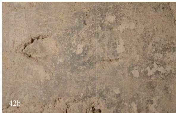
42a/b | EG, Südwestecke von Raum HbW-EG08 im Bereich des ehem. Aborts, Befundstelle 014, Schichtenfolge: Stein, Putz, Grau, helle Tünche (Sept. 2016); Gesamtansicht s. X.41 | abgeb. in FELDTKELLER 2016
