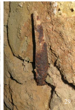
28 & 29 | 2. UG, schmiedeeiserne Eisenkloben seitlich der zugesetzten Öffnung des ehemals wohl abgewinkelten, oberen Treppenlaufs (s. VIII.27) der kleinen Kellertreppe (HbN-Tr3-2UG(3UG)), s. VIII.25 & 26) (Nov. 2015)
