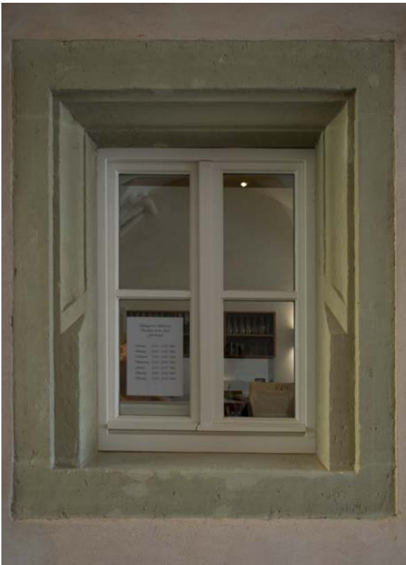
46 | Fenster (HbS-EG00-Wb-F01) in der Hofdurchfahrt mit Werksteinrahmen vom Typ A (Taf. XIVa) aus Bauphase II (Juli 2017) | © Isabel Muehlhaus TUM (bearb. LG)
