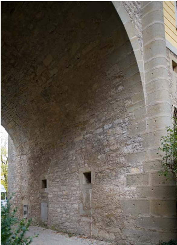
28 | Basteiturm West, 2. UG, Südfassade gegen Norden im Durchgang unter dem Kommunikationsbau mit zwei Schießscharten, je Steigbügelscharten mit Beobachtungsfenstern, sekundär zugesetzt bzw. überformt (Okt. 2015); Detail s. VII.29 & 30 | © Isabel Muehlhaus TUM
