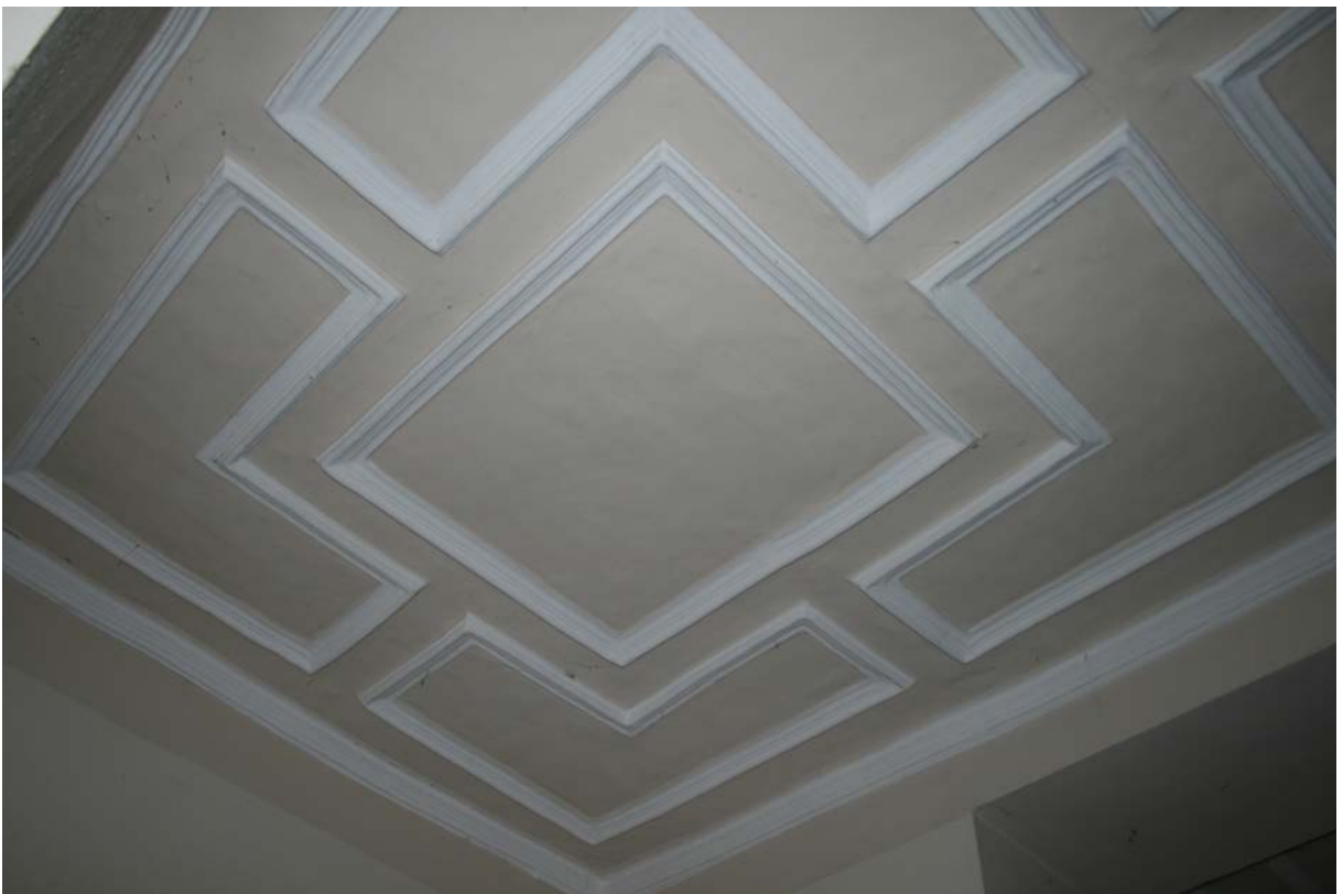
45 | 1. Obergeschoss, geometrisch gegliederte Stuckdecke aus Bauphase III.3 über der Stube des ehem. Stubenappartements (Tu-1OG02)
