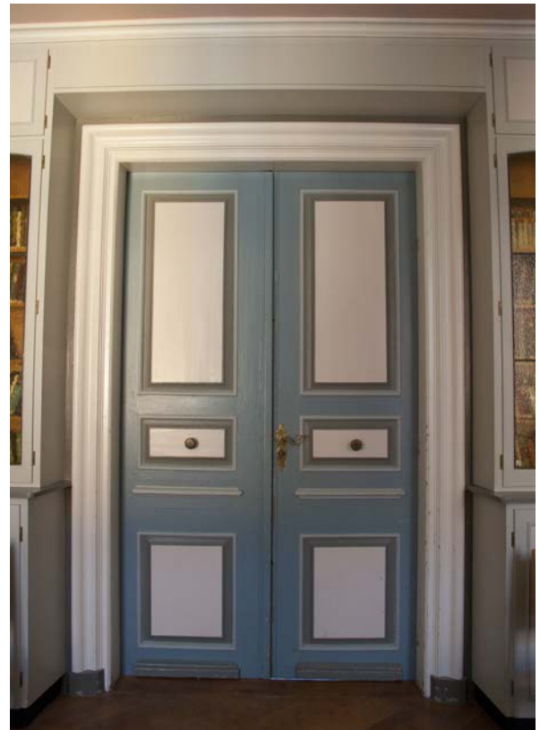
111 | Mansarde, Eingang in die ehem. Bibliothek (HbS-1DG20-Wa-T01), Türrahmen und -blätter aus Bauphase IV.2c, später wohl neu gefasst (Juli 2017)
