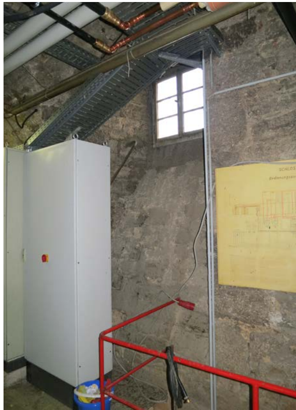
17 | 2. UG, nördliche Schießnische (HbN-O-2UG-F03) in der Ostwand des großen Gewölbekellers (HbN-2UG01), mit der Seitenmauer in Bauphase III.1b angelegt, im 20. Jh. überformt (Nov. 2015)
