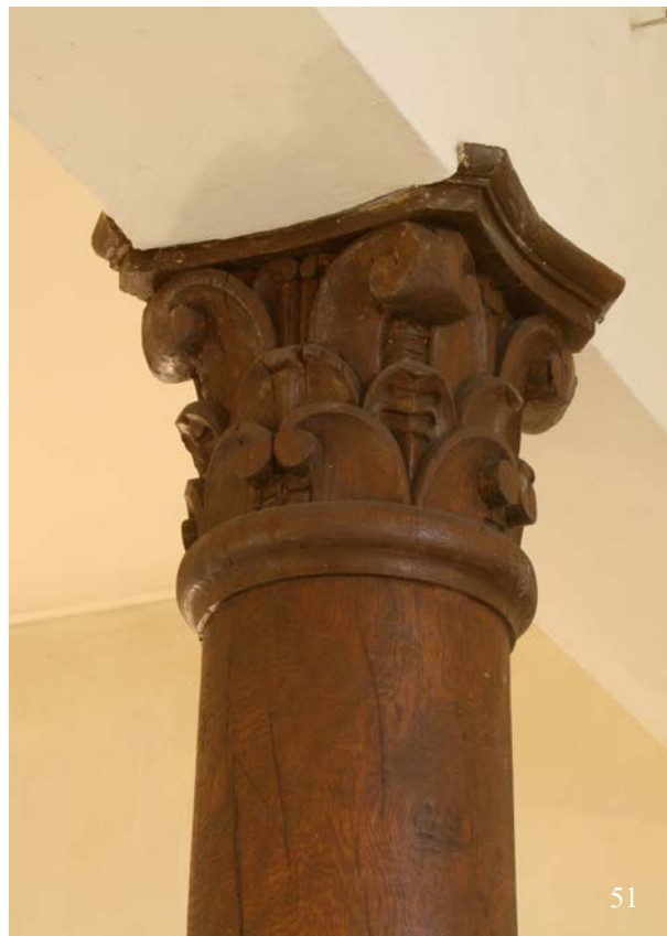
50 & 51 | Erdgeschoss, „Stube“ (HbN-EG09), Säule zur Stabilisierung des nördlichen Unterzugs, Eichenholz, 16./17. Jh., wohl 1954 bei der Unterteilung der ehem. Durchgangshalle anstelle des bauzeitlichen Pfeilerpaares eingestellt (Provenienz nicht bekannt) (Nov. 2012)
