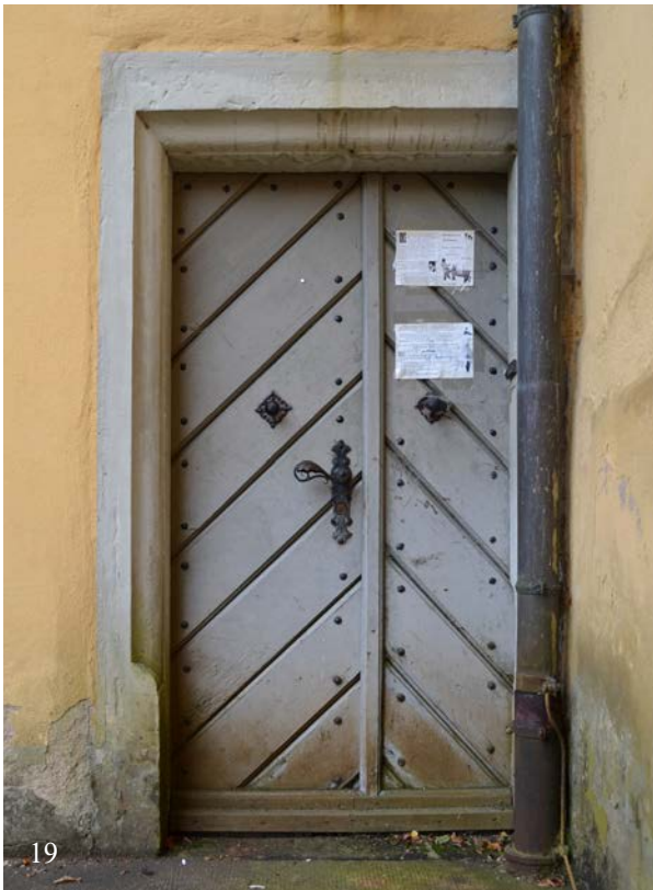
19 & 20 | Erdgeschoss, Eingangstür (Tu-EG01-Wd-T01) mit Werksteinrahmen vom Typ D (Taf. XVI) mit Karniesprofil und einseitig abgeschrägtem Auslauf (20) wohl aus Bauphase III.1b, in Bauphase III.3 zweitverwendet (Okt. 2012); Detail Karniesprofil s. XI.2
