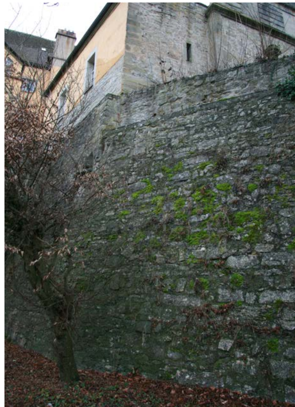
40 | Fundament des hinteren Schlosshofs im Bereich unterhalb von Fahrweg und Torbau, Blick gegen Westen (Dez. 2016)
