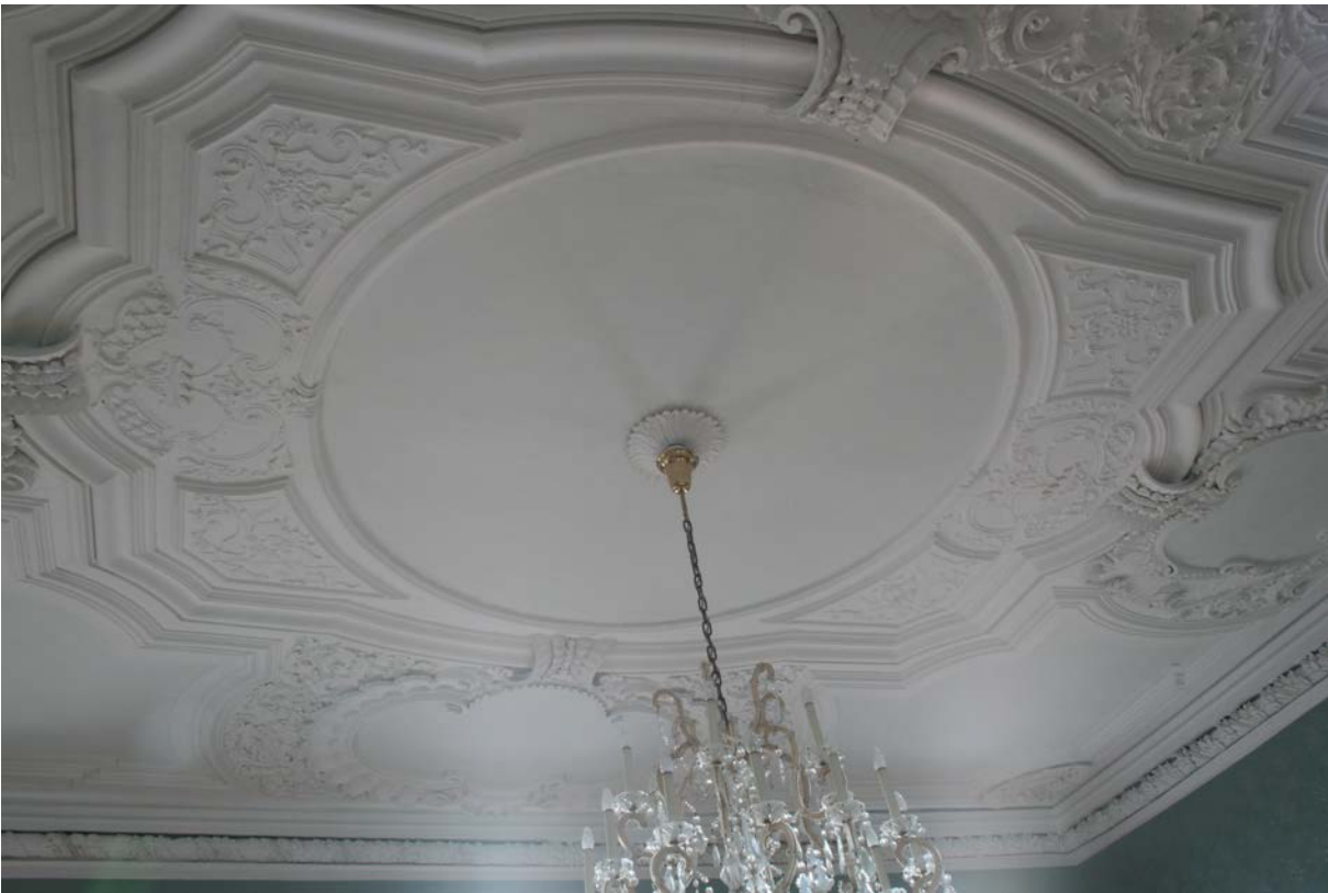
30 | 1. Obergeschoss, bauzeitliche Stuckdecke aus Bauphase IV.1b über der ehem. Hauptstube (HbO-1OG03), um 1709 gefertigt von zwei italienischen Stuckateuren (Nov. 2012); Detail s. IX.31
