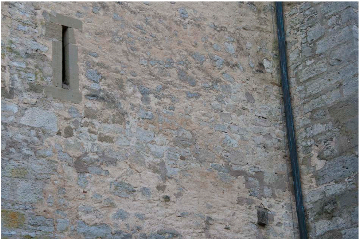
4 | Westfassade auf Höhe des Erdgeschosses, südlicher Abschnitt im Eck zum vorderen Schlossbau, Fensterschlitz (HbW-W-EG-F06) seitlich des ehemaligen Aborts (HbW-EG08; s. IV.2), Zusetzung vor 1866 (vgl. Grundriss IV.9) durch divergentes Mörtelbild im Mauerwerk evident (Jan. 2018); Innenansicht s. X.39-42
