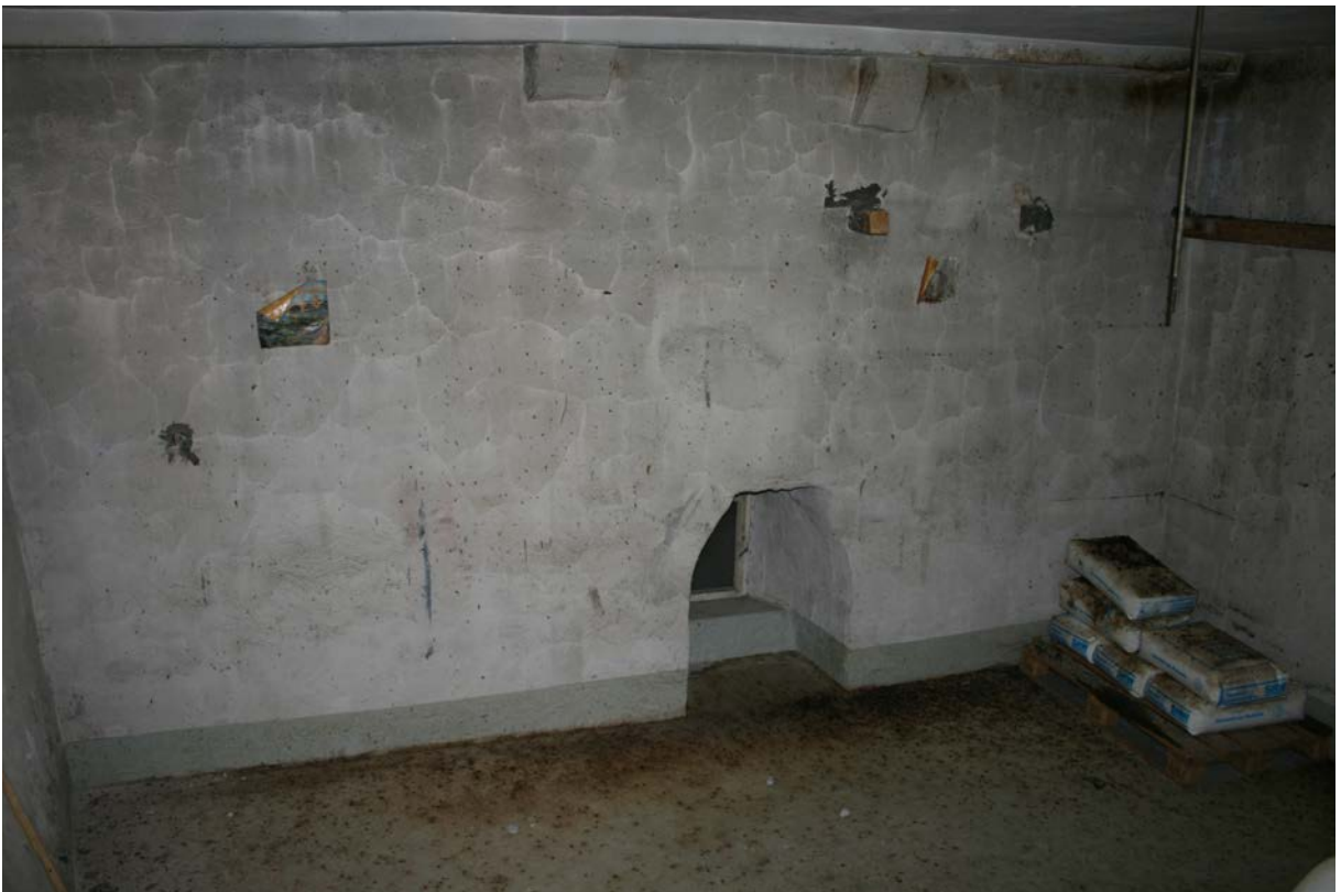
15 | 2. Untergeschoss (Tu-2UG01), Nordwand mit Fußschartenische (Tu-N-2UG-F01), das eichene Deckengebälk wurde laut dendrochronologischer Datierung des südlichen Streichbalkens nach 1646 eingezogen (Nov. 2012); Außenansicht s. XI.5
