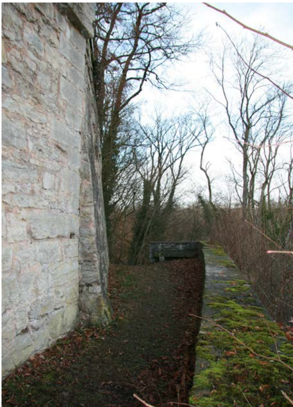
32 | Zwinger im Bereich der ehem. Eckbastion an der Spornspitze gegen Nordwesten, li. nördliche Ende der Schlossgrabenmauer, dahinter die leicht geböschte, barocke Terrassierung (Dez. 2016)
