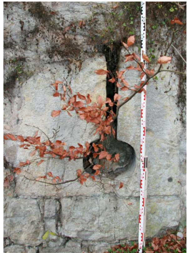
65 | Schlossgrabenmauer, Befundstelle 5: Schlüsselscharte mit rückseitiger Schießnische (ca. 80 cm breit, verschüttet), gebildet aus Spolien (Dez. 2016)
