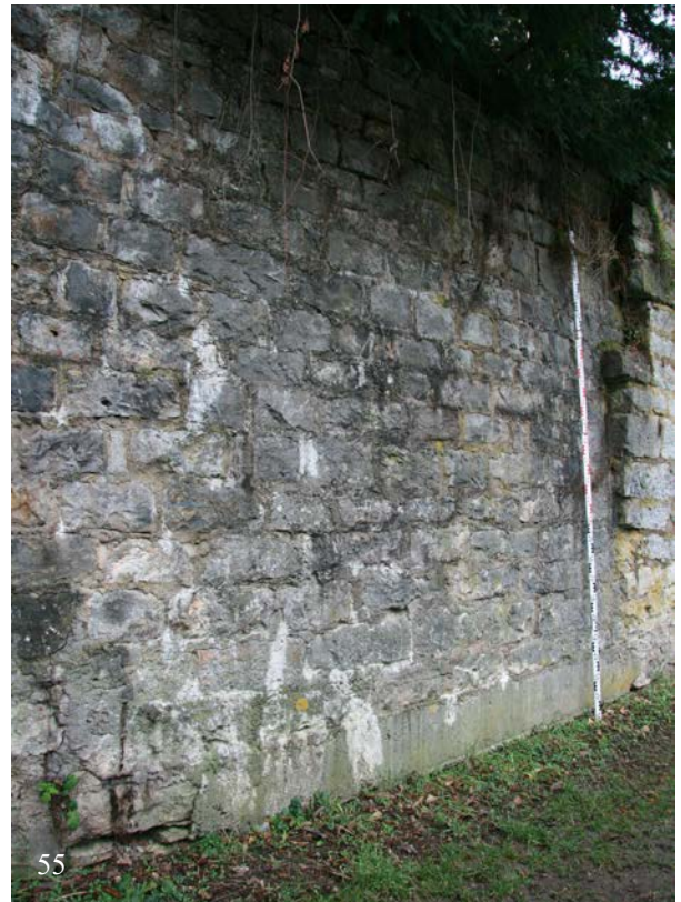
54 & 55 | Befundstelle 1 am südlichen Ende der Schlossgrabenmauer: Über niedrigem Betonsockel wieder aufgemauerter Abschnitt der Schlossgrabenmauer im Bereich vor der Südostecke (Dez. 2016); Rückansicht s. XVI.56
