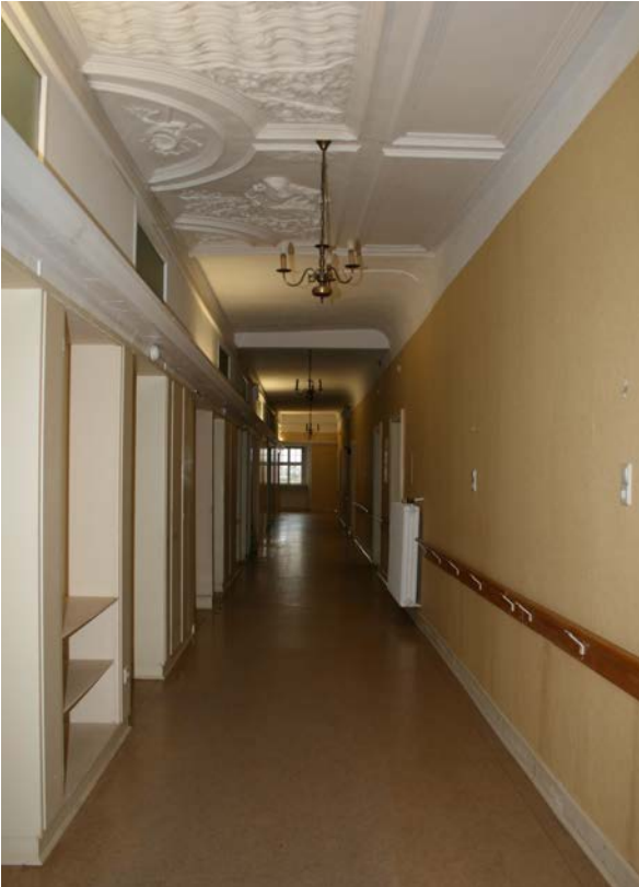
89 | 1. OG, Flur (HbS-1OG01a) gegen Westen, Ausbauzustand nach dem Umbau von 1956 (Nov. 2012); Detail Stuckreste aus Bauphase II s. VII.91a-c
