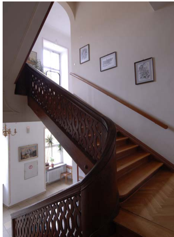
83 | Witwenbau, Haupttreppenhaus (Wi-Tr1-EG(1DG)) zwischen Erdgeschoss und 1. Obergeschoss, dreiläufige U-Treppe mit zwei Viertelpodesten und Baluster-Geländer aus Bauphase IV.2a (Jan. 2012)
