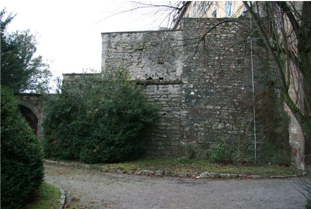
52 | Innenansicht der Grabenmauern, die die Mantelmauer des Halsgrabens bis an die Schlossgrabenmauer verlängern und den anstehenden Felsen unterhalb des Witwenbaus verkleiden, ältester Teil rechts wohl aus Bauphase II, zuletzt bei der Errichtung des Kommunikationsbaus um 1772/74 überformt (Dez. 2016); Schrägansicht s. XVI.53
