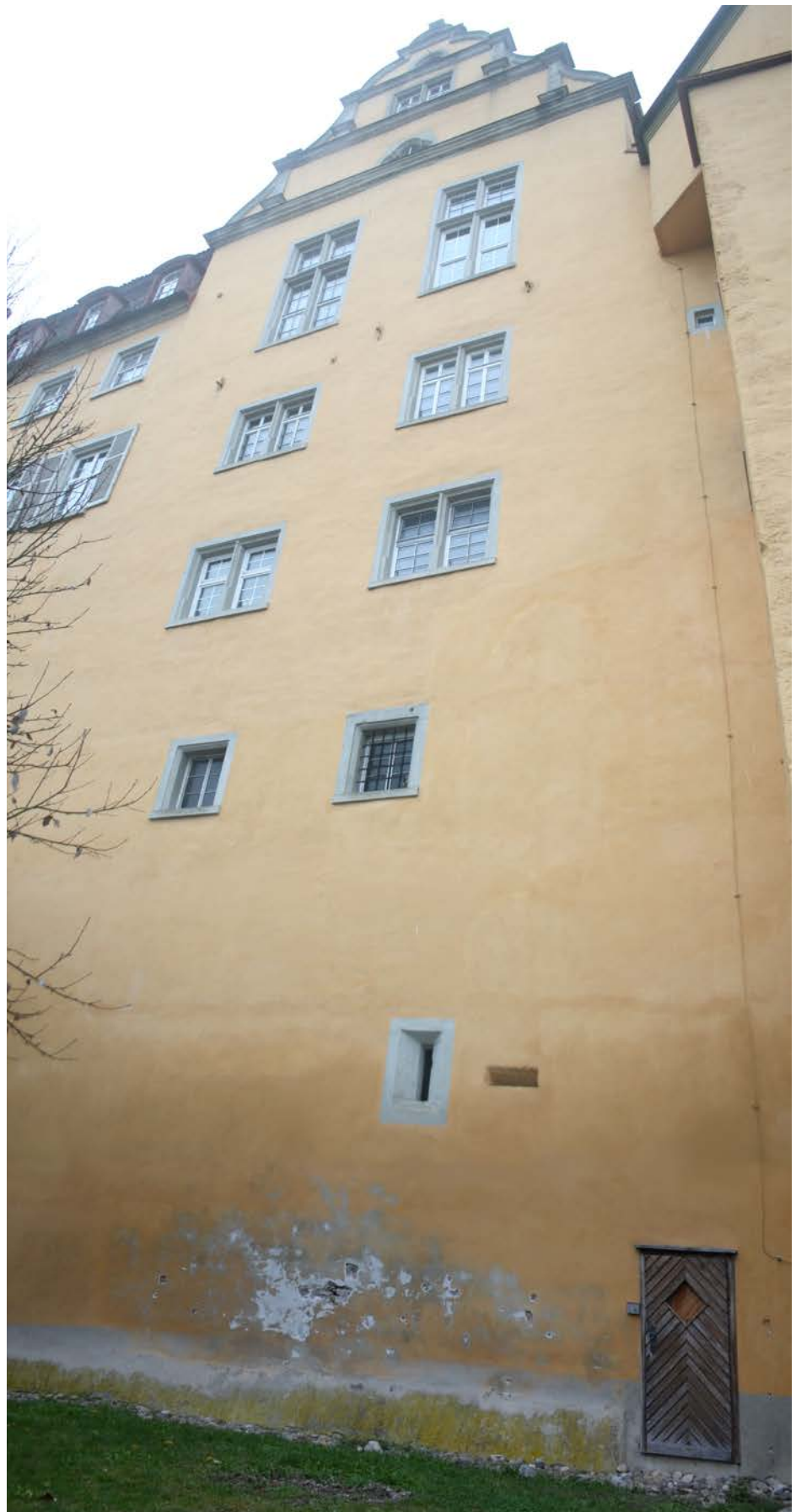
10 | Ostgiebel gegen Westen mit der Ausfalltür am Fuß der seitlichen Kellertreppe (HbN-Tr3 2UG(3UG)), unter den Saalfenstern sind die Köpfe der drei Balkenanker nebst Splint zu sehen, die man in Bauphase III.4 einsetzen ließ (Jan. 2013); Innenansicht Treppenaufgang s. VIII.25 & 26
