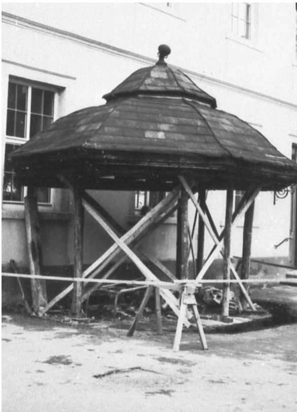
17 | Schloss Kirchberg, Ehrenhof, entkerntes Brunnenhaus vor dem Witwenbau aus Bauphase IV.2a, Fotografie, 20. Jh. | © Landesamt für Denkmalpflege im Regierungspräsidium Stuttgart
