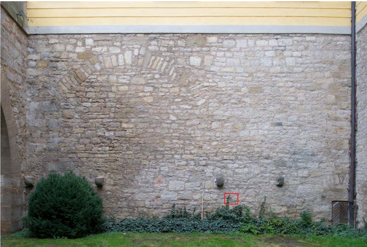
13 | Fundament östlich der Schlossbrücke mit großem Entlastungsbogen im linken oberen Viertel, rechts unten sekundär eingebaute Türöffnung am Fuß des östlichen Abortschachts (Detail s. VII.14), rot markiert: das in situ befindliche Gerüstholz aus Bauphase II (Detail s. VII.15) (Okt. 2015) | © Isabel Muehlhaus TUM
