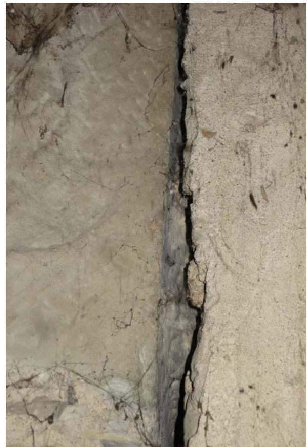
3 | Detail Baufuge im Bereich der ehem. Nordwestecke, Eckquaderung aus Bauphase I.1 mit bruchrauen, kissenartigen Buckeln auf der verdeckten Innenseite (Nov. 2015); Gesamtansicht s. VIII.2
