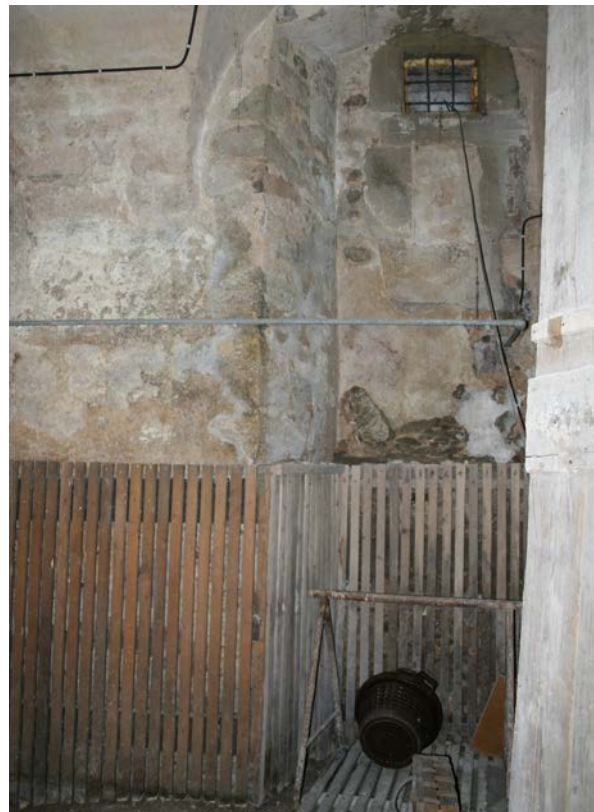
66 | Basteiturm West, 2. UG gegen Nordwesten, ehem. nördlicher Schießstand (BaW-2UG01-Wd-N1), Scharfen hinter der Lattung sekundär zugesetzt (Jan. 2013); Außenansicht s. VII.24
