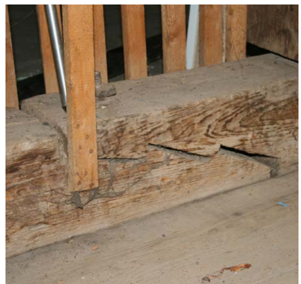
123 | 2. DG, Detail Sägeschnitt am Überzug (März 2013)
