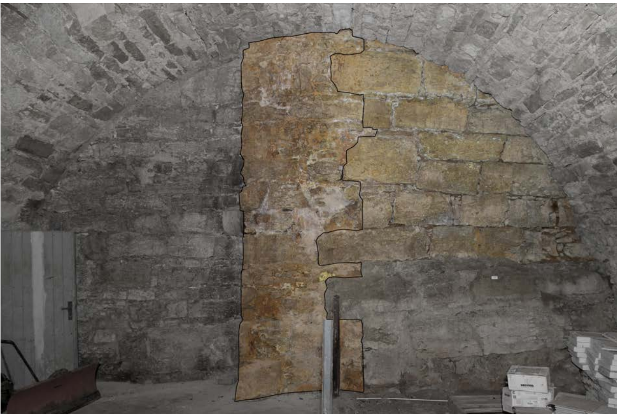
15 | Marstall, Nordwand des großen Kellergewölbes (Ma-2UG01), in Farbe: Mauerreste der spätmittelalterlichen Vorburg (in Bauphase IV.2a abgebrochen); schwarz gerahmt: die fast vollständig zurückgedrängte ehem. Turm-Ostwand (zweischaliges Mauerwerk aus mittelgroßen Kalksteinquadern mit Bruchsteinfüllung), verzahnt mit der ehem. Wallstirnmauer resp. inneren Grabenwand des äußeren Schlossgrabens (regelmäßiges Schichtenmauerwerk aus großen Kalksteinquadern), links Innenseite der ehem. Turm-Nordwand mit Eckkonsole, auf der möglicherweise ein (Decken-)Streichbalken lag (Okt. 2015); s. Taf. XII | © Isabel Muehlhaus TUM (bearb. LG)
