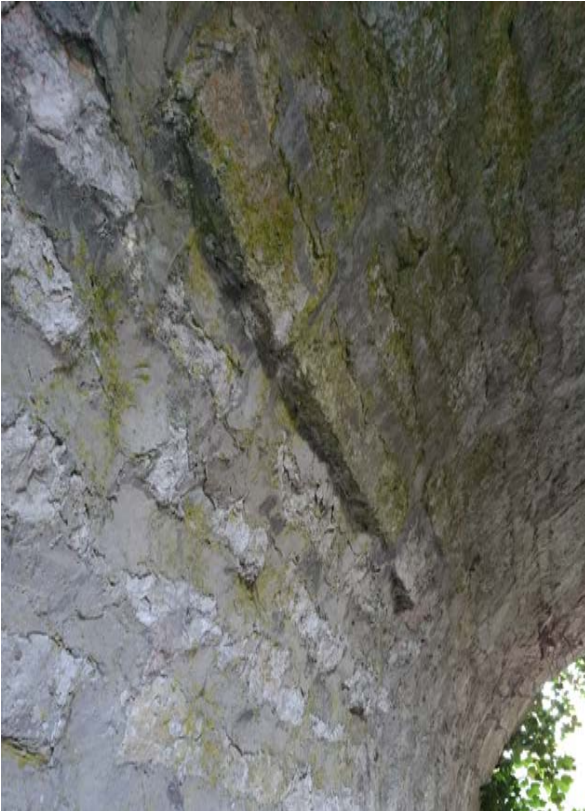
32 | Oberkante bzw. Sturz einer mutmaßlichen, sekundär zugesetzten Öffnung (Zugang ehem. Eiskeller?) (Okt. 2018); Gesamtansicht s. XII.31
