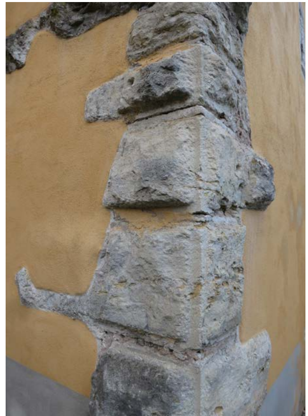
8 | Buckelquader an der Südostecke, Kalkstein mit Randschlag, Buckelform in Bosse oder als Kissen bearbeitet (Nov. 2015)
