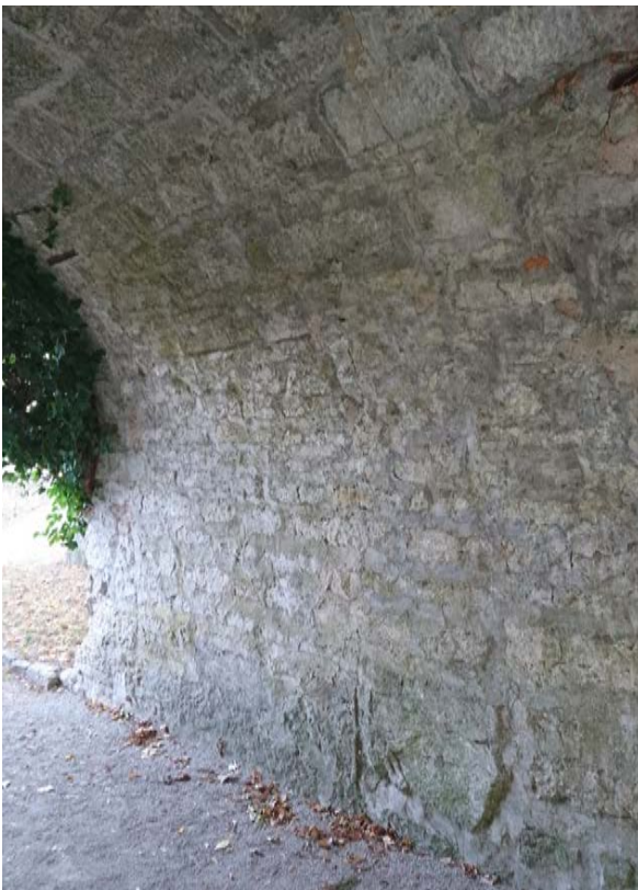
30 | Durchgang unter dem Fahrweg, Blick auf die Südseite mit einer mutmaßlichen, sekundär zugesetzten Öffnung (Zugang ehem. Eiskeller?) (Okt. 2018); s. auch XII.31
