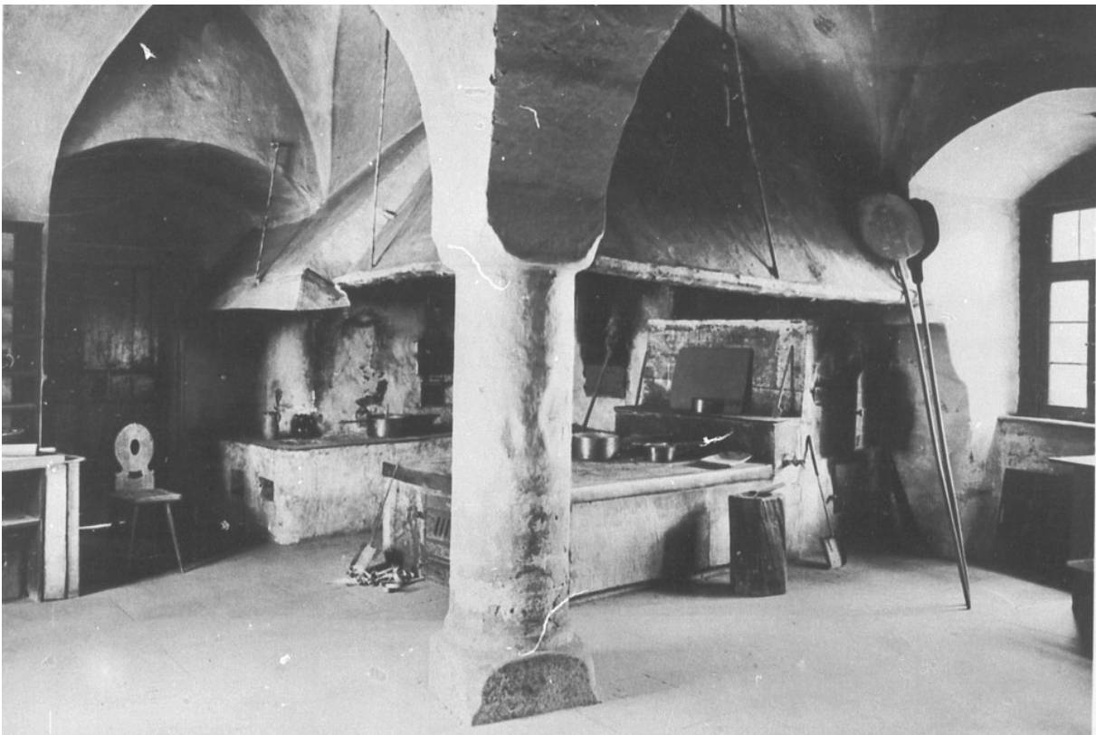
11 | Basteiturm West, Erdgeschoss, ehem. Hofküche (BaW-EG01) aus Bauphase II gegen Südwesten, links Durchgang (VeW-EG02-Wa-T01) in den Kommunikationsbau, Fotografie, frühes 20. Jahrhundert | © Landesamt für Denkmalpflege im Regierungspräsidium Stuttgart
