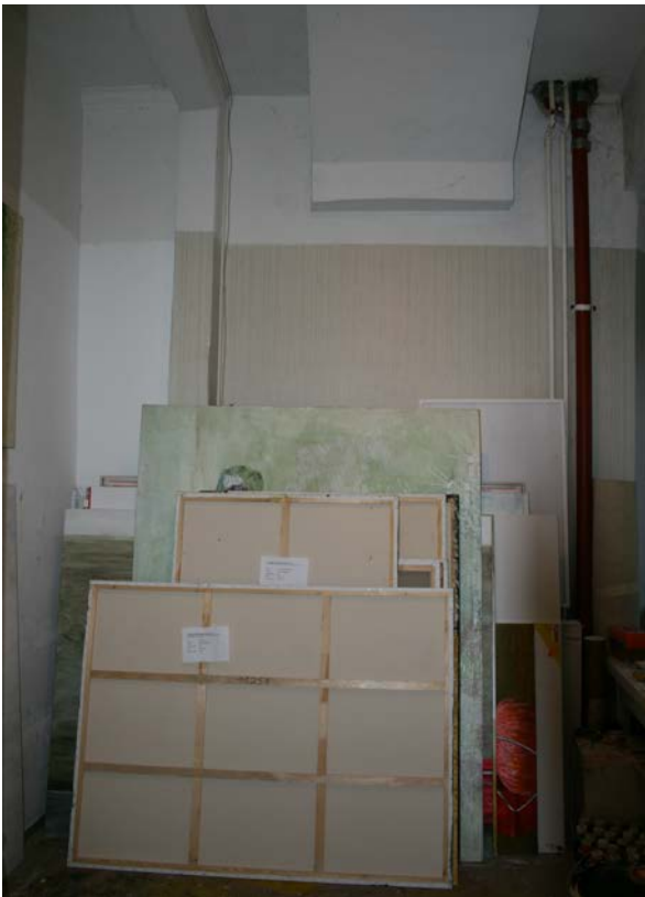
25 | EG, Südwand Raum HbW-EG05, unter der Decke Untersicht des Treppenabsatzes, der im 1. OG vom Treppenhaus in den rückseitigen Versorgungsgang führ- te, wohl beim Umbau 1954 geschlossen (Nov. 2012)
