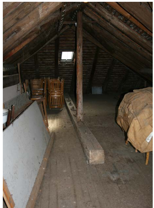
72 | 2. DG, Überzug im Bereich über dem Treppenhaus (HbW-Th1) (März 2013)
