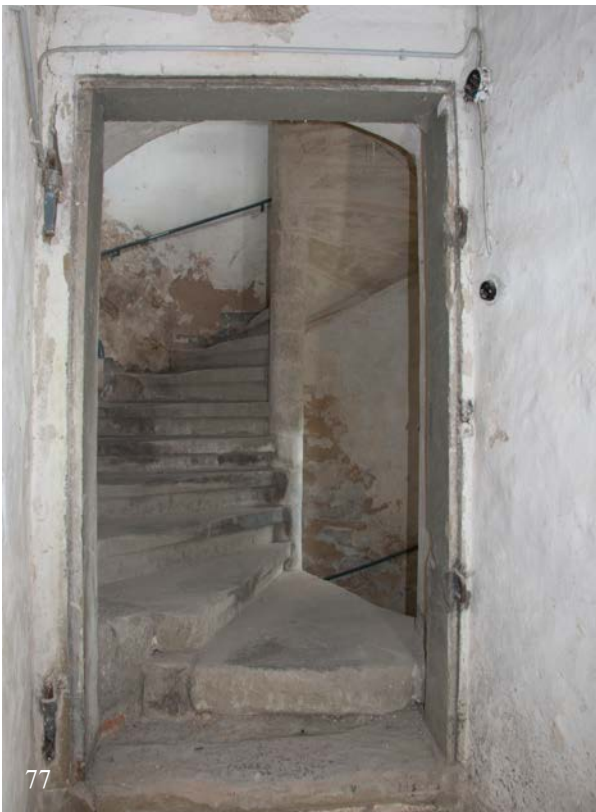
77 & 78 | 1. Untergeschoss, Zugang (HbS-1UG01-Wa-T01) zum Gang in den Basteiturm, Werksteinrahmen aus Bauphase II , links (77) mit Blick auf die Kellertreppe (HbS-Tr1-EG(2UG)), im Vordergrund Innenseite des Werk-steinrahmens vom Typ B (Taf. XIVb) aus Bauphase II mit schmiedeeisernen Kloben zur Aufhängung des Türblatts (78) (Okt. 2017)
