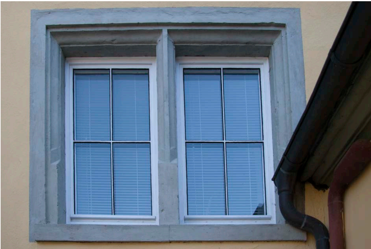
4 | Erdgeschoss, Mittelpostenfenster HbN-N-EG-F03 an der Nordfassade, Werksteinrahmen Typ A (s. Taf. XIVa) aus Bauphase II mit einseitig abgeschrägt auslaufendem Karniesprofil mit abgesetztem, einseitig abgeschrägten Auslauf, in Bauphase III.1b zweitverwendet (Juli 2017)
