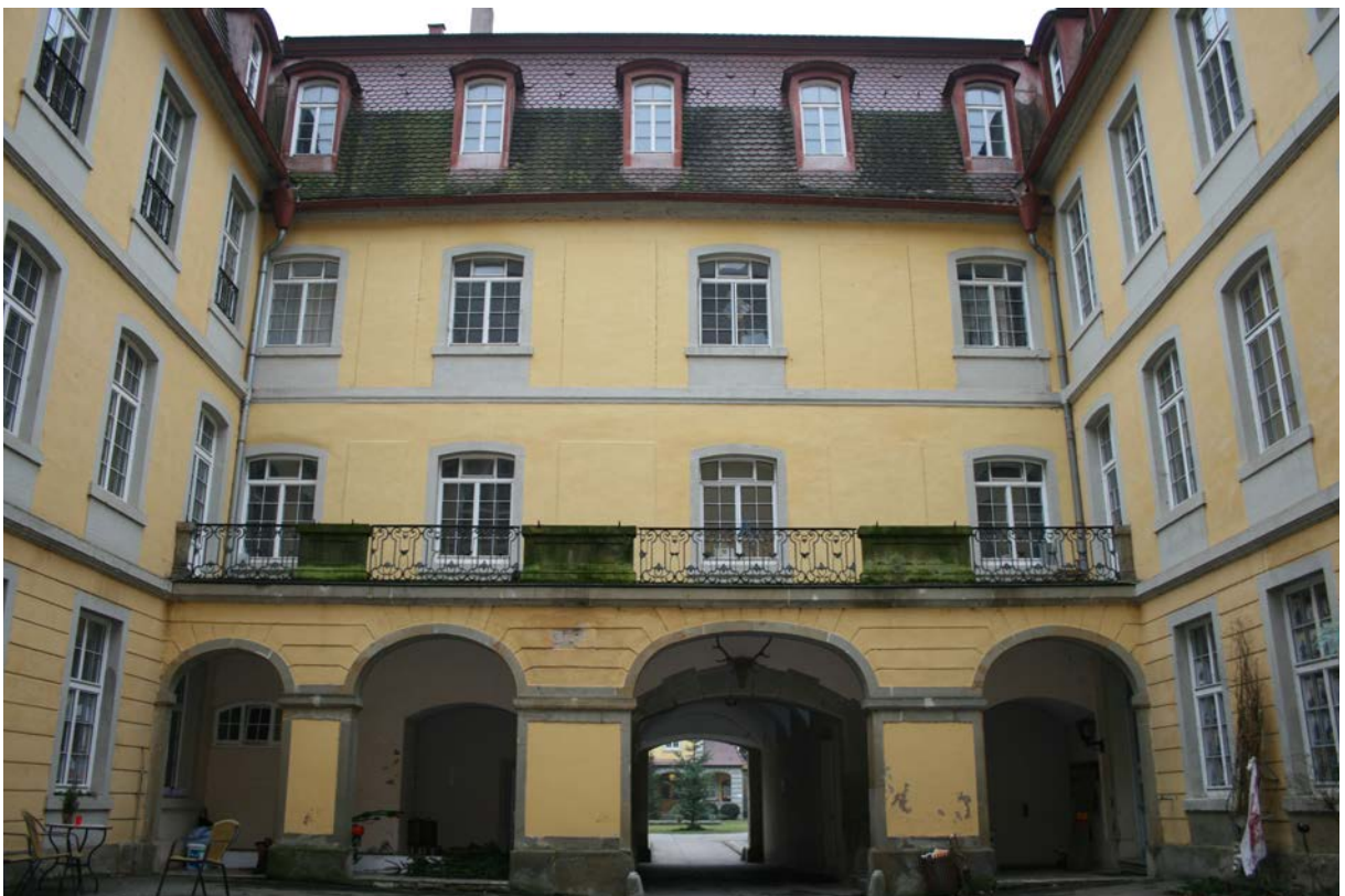
2 | Nordfassade gegen den inneren Schlosshof im Ausbausezustand nach dem Umbau in Bauphase IV.2c (Jan. 2013); zum Altan s. VII.6-8
