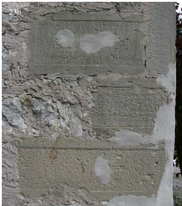
23a/b | Basteiturm West (23a) und Ost (23b), Eckquaderung der Facen, Sandstein, Spiegelfläche innerhalb des Randschlags mit dem Krönel bearbeitet, teils mit Steinmetzzeichen und Hebelöchern (Okt. 2017)
