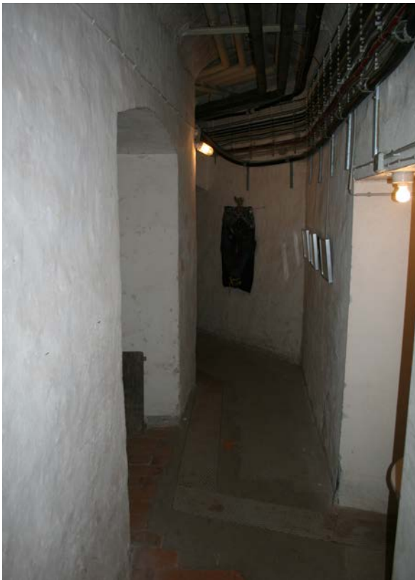
79 | 1. UG, Gang (HbS-1UG01) in den Basteiturm Ost gegen Süden, links ehem. Schießnische zur Bestreichung des östlichen Grabens (s. VII.80), rechts moderner Lastenaufzug (Jan. 2013)
