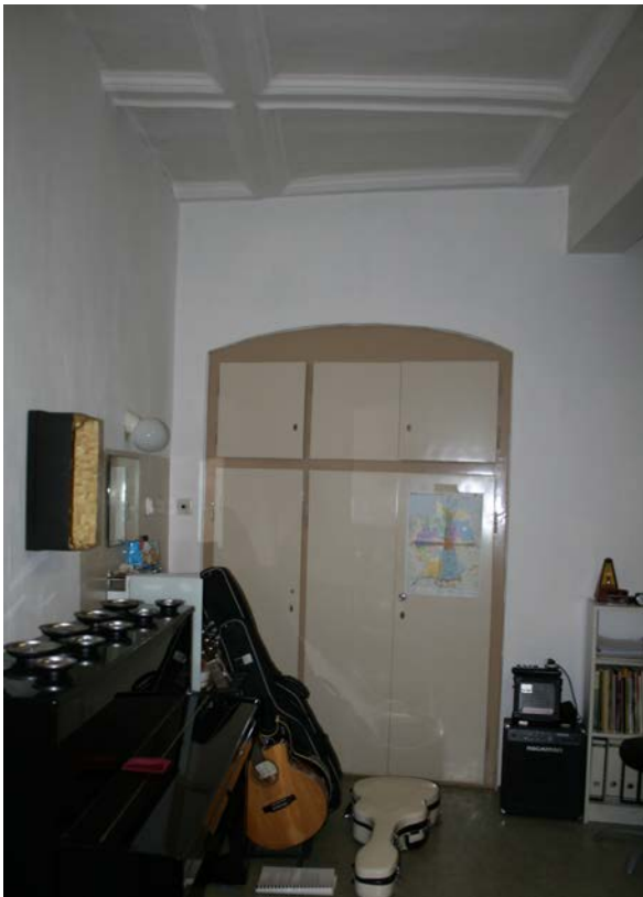
42 | EG, ehem. Sekretärsstube (HbN-EG05), Westwand mit Wandschrank im Bereich des ehem. Durchgangs in den Anbau, 1954 zugesetzt (Nov. 2012)
