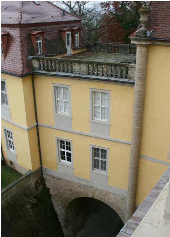
1 | Kommunikationsbau West, Hofansicht gegen Westen (Nov. 2012)
