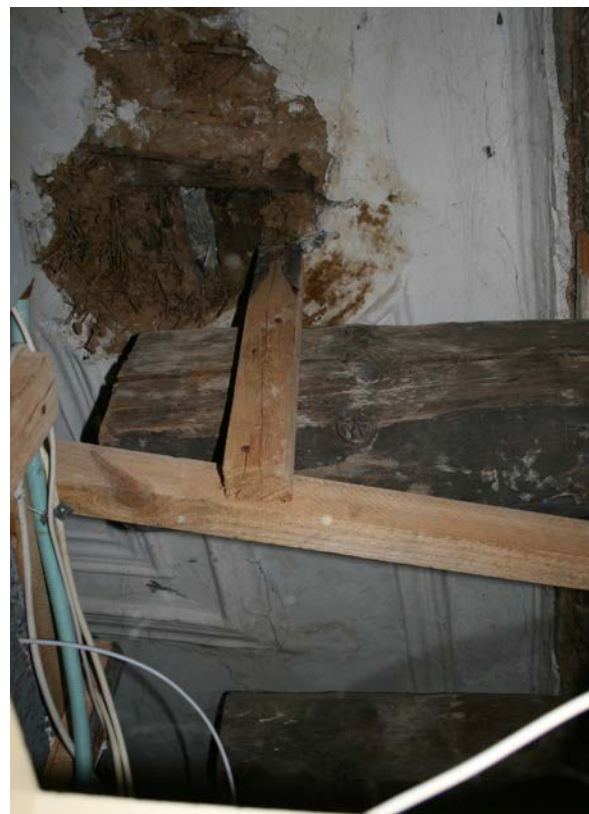
55 | 1. OG, historischer Deckenstück über der ehem. „Kammer gegen Eichenau“ (HbN-1OG03), 17./18. Jh., 1961 überformt (März 2013)
