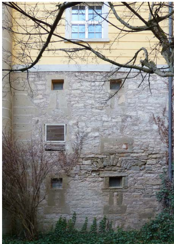
31 | Basteiturm West, Ostfassade, 1. & 2. UG, Steigbügelscharten in Kombination mit Beobachtungsfenstern und ehemals je einer Rechtescharte darunter (im 2. UG vtl. verschüttet), sekundär zugesetzt (März 2013); Details s. VII.32-34
