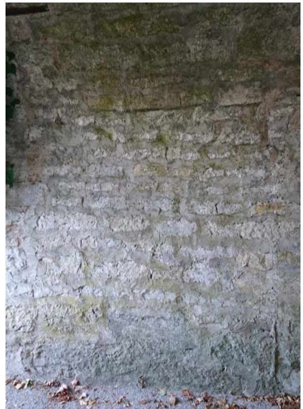
31 | Mutmaßliche, sekundär zugesetzte Öffnung (Zugang ehem. Eiskeller?) (Okt. 2018); Befunddetails s. XII.32-34; zum Eiskeller vgl. XII.40
