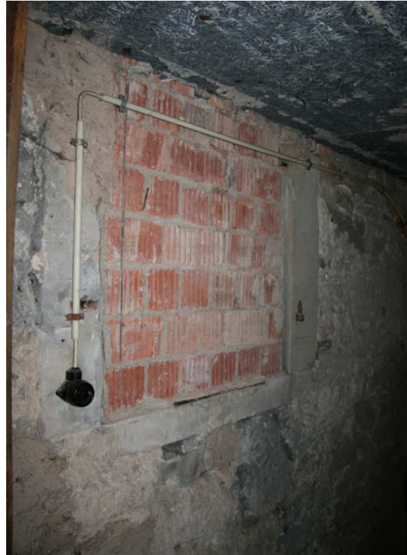
69 | Witwenbau, Nordwand Kellerhals (Wi-Tr4-1UG(2UG)), ehem. interner Zugang zum Keller, beim Umbau 1961 geschlossen (s. XVII.17) (Okt. 2015)
