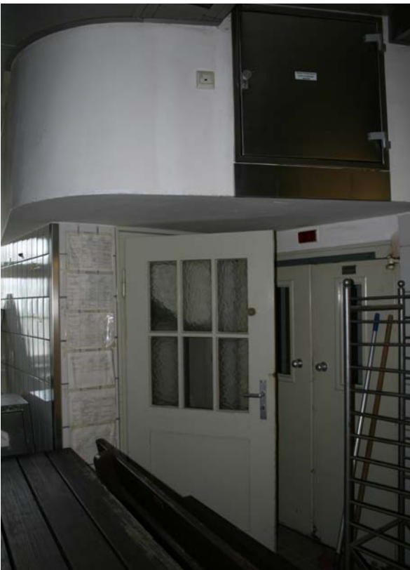
59 | Basteiturm West, EG, Zugang zur Kellertreppe (BaW-Tr1-EG(2UG)) in der Nordwestecke der ehem. Hofküche (BaW-EG01), 1954 umgebaut, dahinter Lastenaufzug von 1959 im Bereich einer ehem. Fensterische (Jan. 2013)
