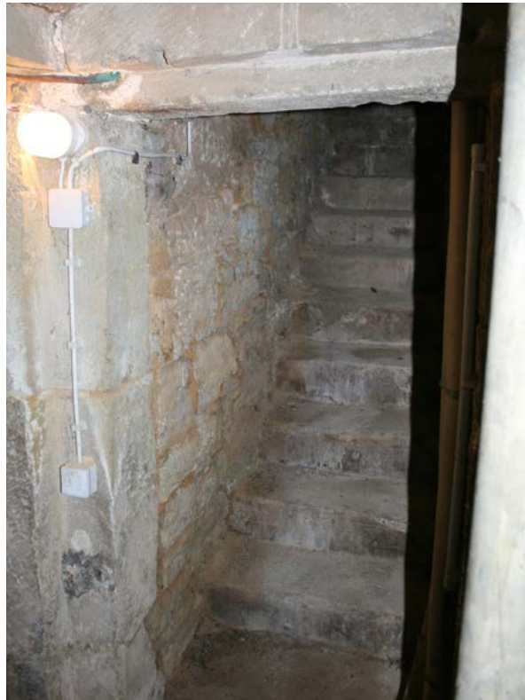
35 | 2. UG, Raum HbN-3UG01 gegen Süden, Türöffnung (HbN-3UG01-Wc-T02) am Fuß der kleinen Kellertreppe (HbN-Tr3-2UG(3UG)) mit innen liegendem Türanschlag (Jan. 2013)
