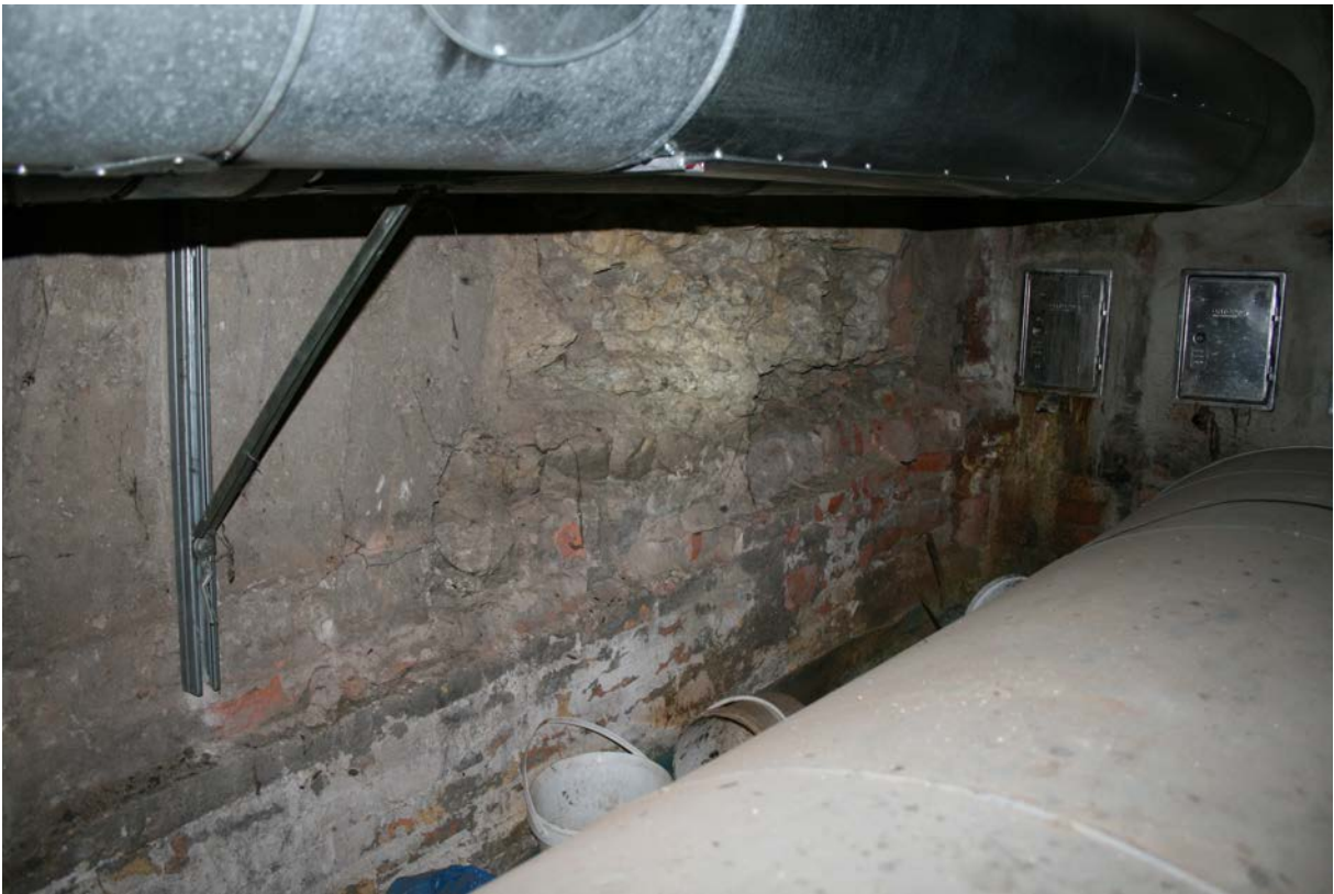
20 | 2. Untergeschoss, hinterer Teil (HbN-2UG02) des großen Gewölbekellers gegen Nordwesten, Bereich innerhalb der öldichten Aufmauerung (s. VIII.19) mit Blick auf den anstehenden Felsen, der die Westwand des Keller- raums bildet, wohl in Bauphase I.1 abgearbeitet (Nov. 2012)
