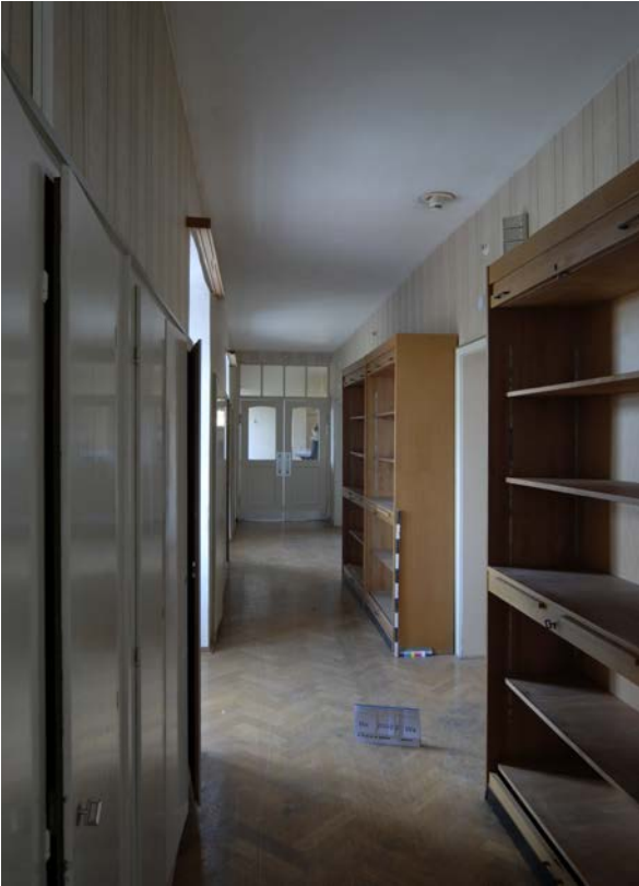
50 | Marstall, Mansarde, Flur (Ma-2OG02) gegen Norden (Jan. 2012)
