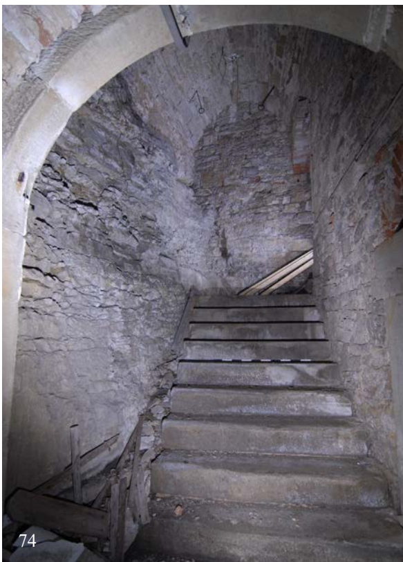
74 | Witwenbau, 2. UG, unterer Treppenlauf gegen Süden mit Blick auf die ehem. äußere Schlossgrabenwand, li. Felssockel der ehem. Stadtmauer (März 2012); s. auch XIII.73
