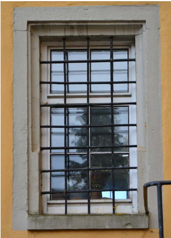
22 | EG, Westwand, Fenster (Tu-W-EG-F01) mit bauzeitlichem Werksteinrahmen Typ C (Taf. XV) aus Bauphase III.1b mit Hohlkehle und einseitig gekehltem Auslauf, Sandstein (Okt. 2012); Details s. XI.23 & 24
