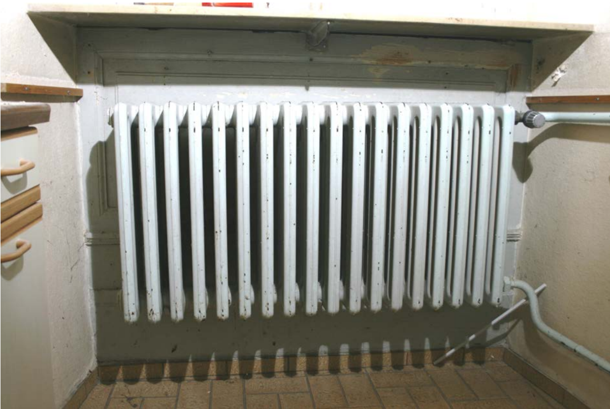
46 | Marstall, 1. Obergeschoss, Raum Ma-1OG12, Fensternische Ma-F-O-1OG06 mit historischer Lamperie, wohl frühes 19. Jahrhundert, insgesamt vier Farbfassungen nachweislich, zuoberst eine grau-blaue Lackierung der 1950/60er Jahre, zuunterst eine hellgraue Ölfarbe als Erstfassung (Nov. 2012); vgl. BÜCKNER/SCHREIBER 2012, Befundstelle 013
