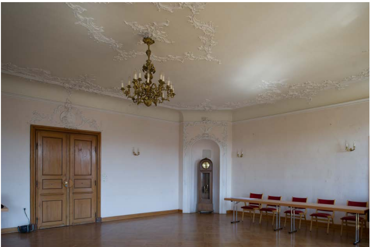
112 | Mansarde, ehem. Bibliothek (HbS-1DG20) gegen Nordosten mit bauzeitlicher Stuckdekoration aus Bauphase IV.2c, gefertigt 1757/58 von Franz Oeder, beim Umbau um 158/61 überformt, links Eingang (HbS-1DG20-Wa-T01) vom ehem. Vorzimmer (s. VII.111) (Juli 2017); Details Stuckwerk s. VII.114-116, zu den Umbauplänen s. XVII.10 & 14 | © Isabel Muehlhaus TUM
