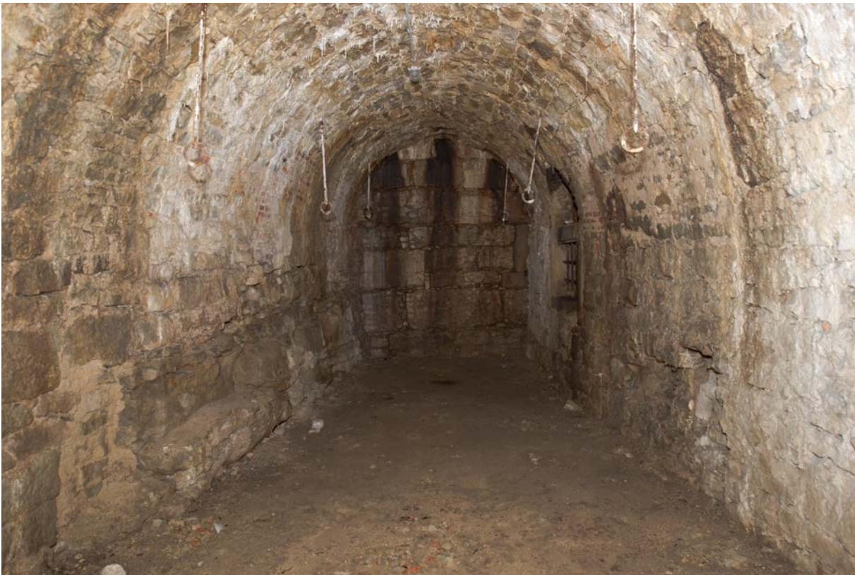
18 | Marstall, 2. Untergeschoss, kleines Gewölbe (Ma-2UG02) gegen Norden, Giebelwand entspricht der Fundamentmauer des mittelalterlichen Torturms (Okt. 2015); Details Giebelwand s. XIII.19 & 20 | © Isabel Muehlhaus TUM
