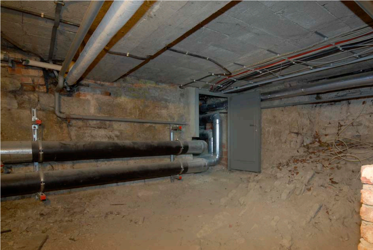
23 | Marstall, Zwischengeschoss, Keller (Ma-1UG03) über dem großen Kellergewölbe gegen Südwesten, rechts Zugang (Ma-1UG03-Wc-T01) in den modernen Technikgang (Ma-1UG03a) (Jan. 2012)
