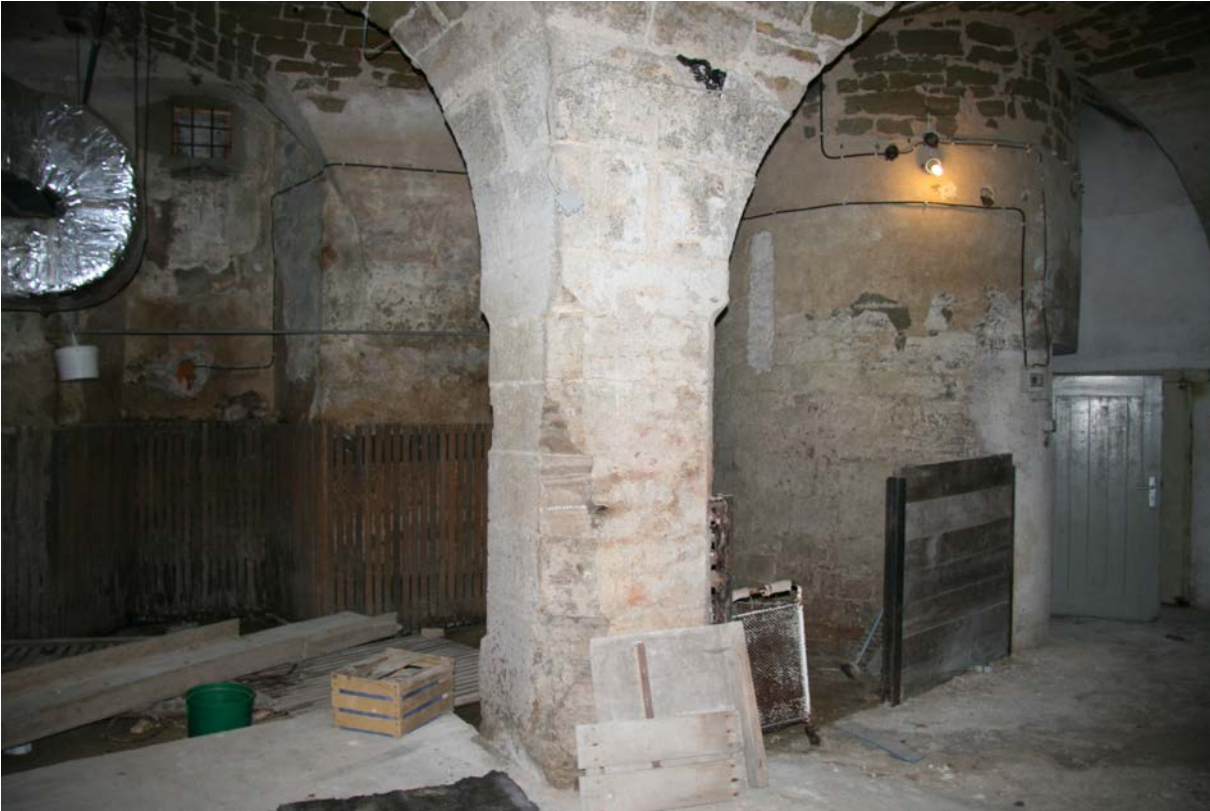
64 | Basteiturm West, 2. Untergeschoss gegen Norden, rechts der Wendeltreppenturm (BaW-Tr1-EG(2UG)), der über zwei Geschosse bis in die ehem. Hofküche (BaW-EG01) im Erdgeschoss führt, links der südliche von zwei ehem. Schießständen (s. VII.65 & 66) (Okt. 2017)
