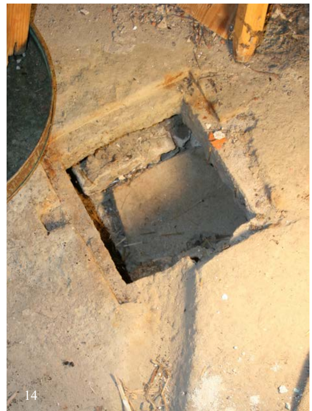
13 & 14 | 1. Untergeschoss, Ablaufrinne (13 | Okt. 2015) und -loch (14 | Nov. 2012) im kleinen Gewölbekeller (HbO-1UG01)
