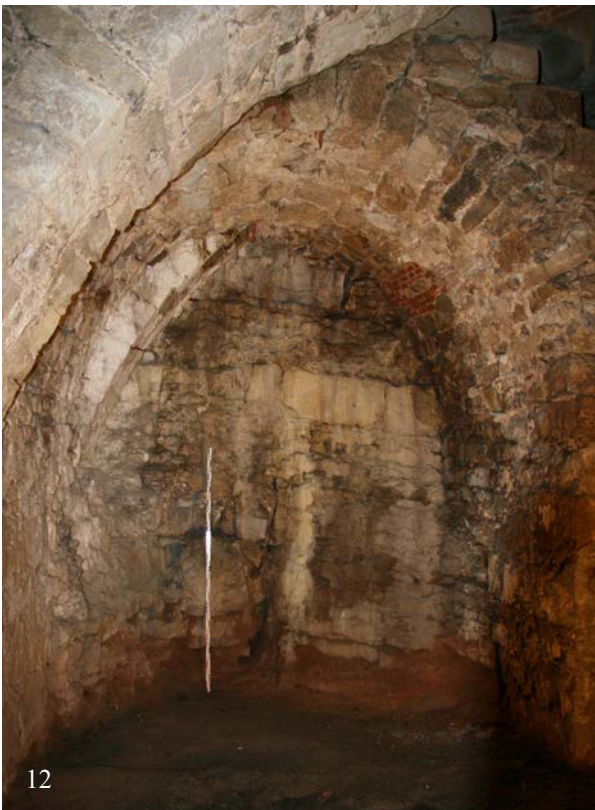
12 & 13 | Marstall, großer Gewölbekeller (Ma-2UG01), anstehender Felsen am Fuß der Südwand im Bereich unter den Treppenbögen, Fundament der ehem. äußeren Grabenwand des spätmittelalterlichen Schlossgrabens (Okt. 2015)
