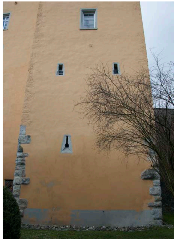
6 | Ostfassade des mittelalterlichen Unterbaus mit bauzeitlichen Schießscharten (Jan. 2018)
