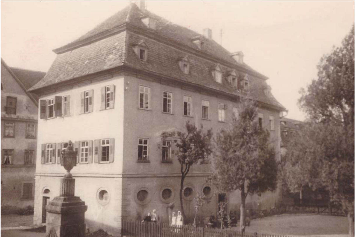
22 | Eberhardsbau aus Bauphase IV.1c gegen Norden (1968 abgerissen), Fotografie, 1. Hälfte 20. Jahrhundert | © Fam. Gonser (Kirchberg/Jagst)
