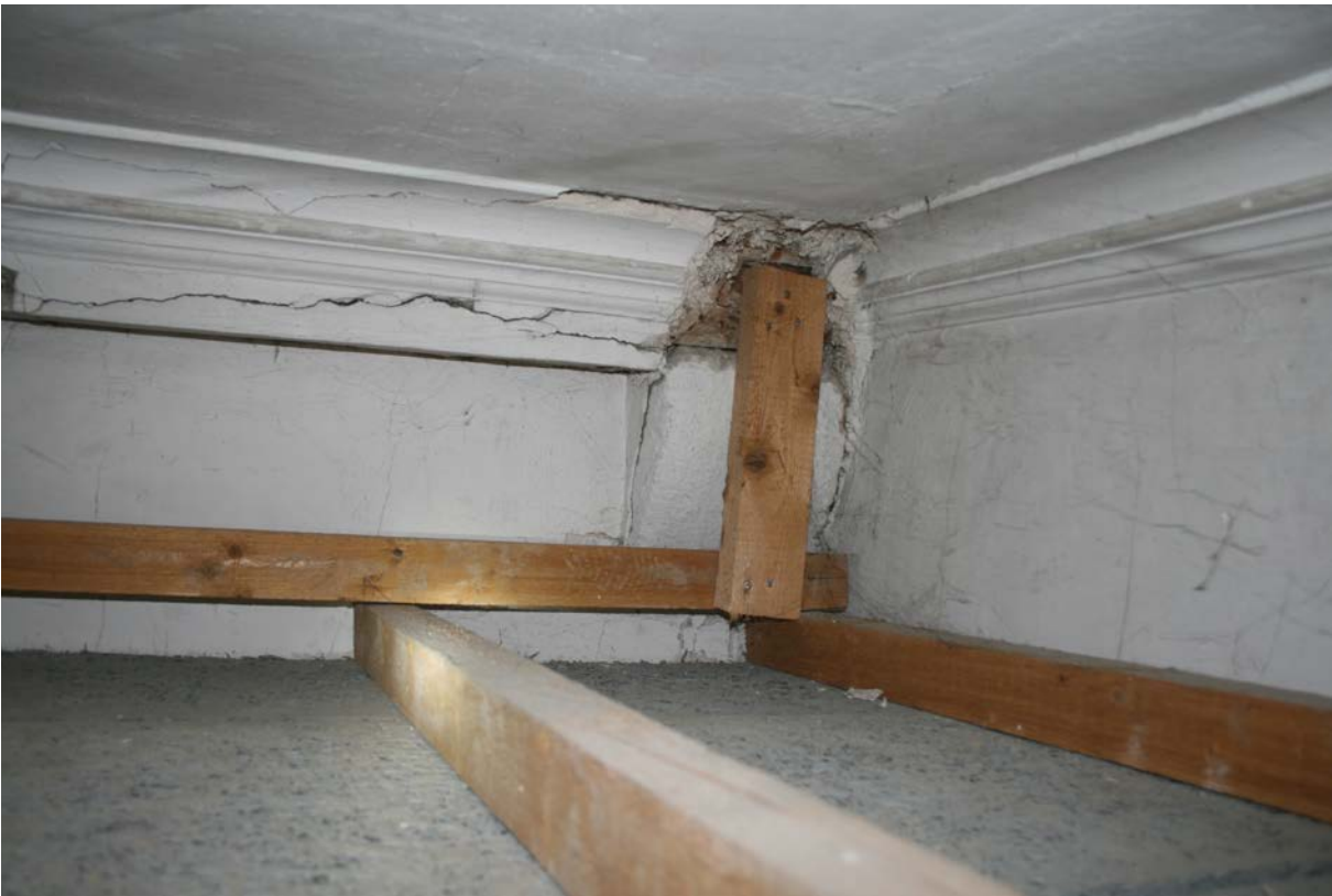
34 | 2. Obergeschoss, letzte Rudimente der bauzeitlichen Ausstattung aus Bauphase IV.2c in Form von Stuckprofilen und einer Konsole im Bereich über der Südwestecke von Raum HbO-2OG08, ehem. Gang längs der Hofseite, Decke 1961 beim Umbau des Stockwerks (s. XVII.14) abgehängt (Jan. 2013)
