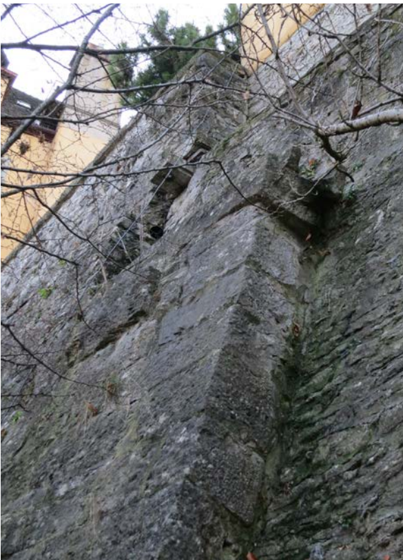
39 | Ostseite des Schlosshoffundaments, überlappende Mauerwerksverbände im Bereich unterhalb des Torbaus, unterer Verband datiert in Bauphase IV.3b verblendet (Nov. 2015)
