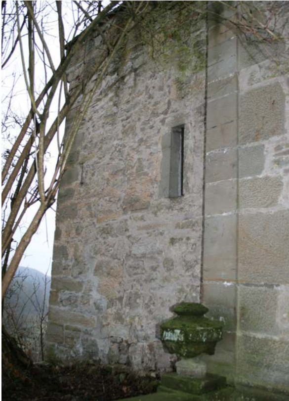
13 | Torbau, Nordfassade, Abschnitt östlich der Durchfahrt (Jan. 2013)
