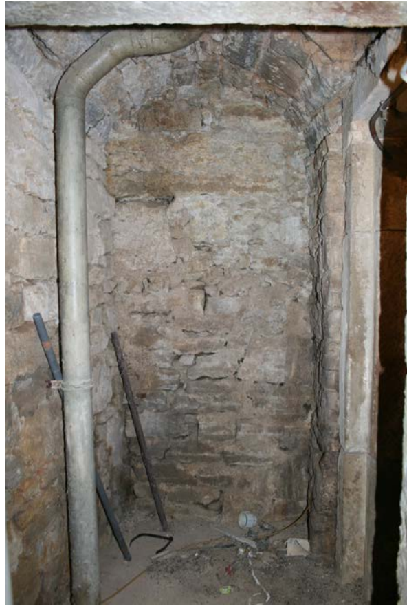
33 | 2. UG, Raum HbN-3UG01 gegen Norden mit Blick auf die Südwand des Turms (Jan. 2013)
