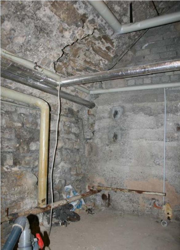
23 | 2. UG, Nebenraum HbN-2UG02b gegen Nordosten (Nov. 2012); vgl. VIII.21
