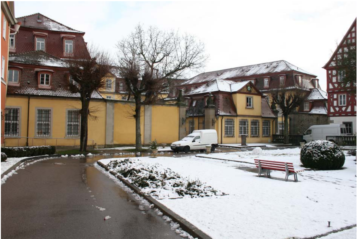
1 | Blick auf die Schlosshofmauer gegen Osten mit Marstall (li.), Wachhaus (Mitte) und Witwenbau (rechts) (Jan. 2012)
