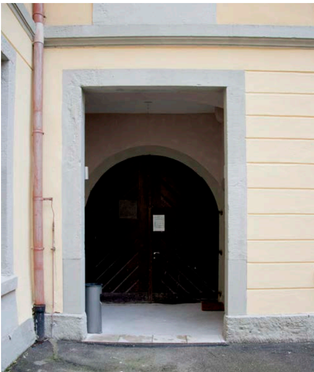
3 | EG, Vorraum zum Keller (HbO-EG00) gegen Osten, die Treppe erschließt den großen Keller unter dem Saalbau und das kleine Gewölbe (HbO-IUG01) unter dem Galeriebau Ost (Jan. 2018)
