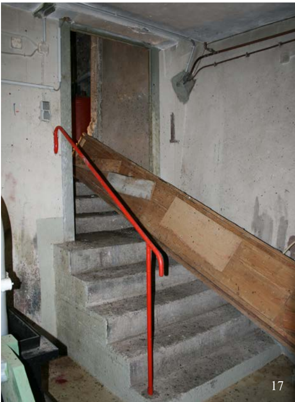
17, 18 & 18a | 2. Untergeschoss, Zugang (HbN-2UG01a-Wa-T01) vom großen Gewölbekeller unter dem Saalbau in der Südwestecke mit Werksteinrahmen (18) Typ B (Taf. XIVb) aus Bauphase II mit Karniesprofil und einseitigem Auslauf mit Karnies, in Bauphase III.1b zweitverwendet, Treppenabsatz (17) modern (Nov. 2012/15); Vergleichsbeispiel Werksteinrahmen s. VII.48
