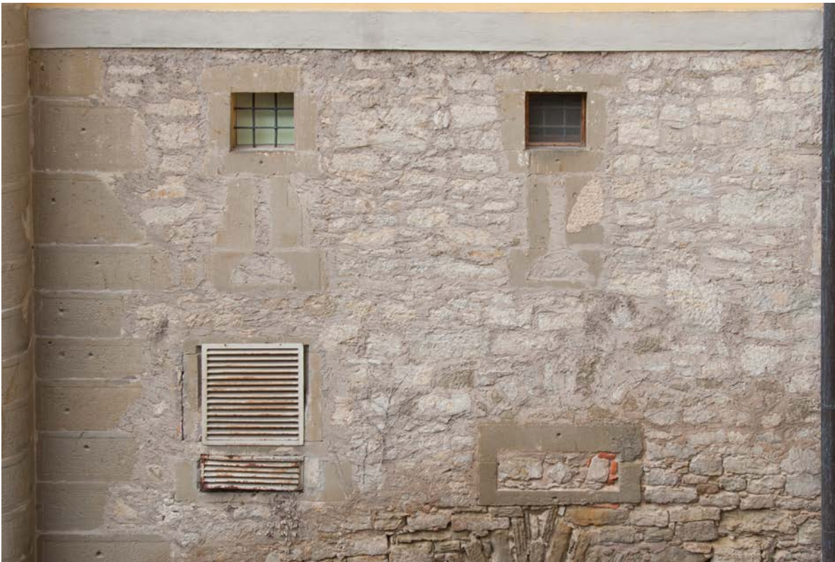
35 | Basteiturm West, Ostfassade, 1. Untergeschoss, Schießscharten, je Steigbügelscharte mit vergitterten Beobachtungsfenster und einer Rechteckscharte darunter, sekundär zugesetzt bzw. überformt (Okt. 2017)
