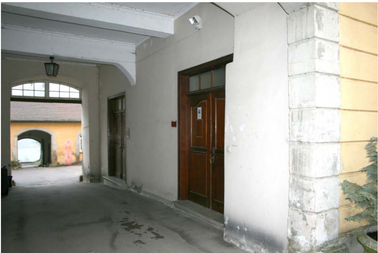
38 | Durchfahrt (HbN-EG00) gegen Nordosten mit Blick auf die Trennwand, die man um 1944 eingezogen hat (s. IV.25) (Jan. 2013)
