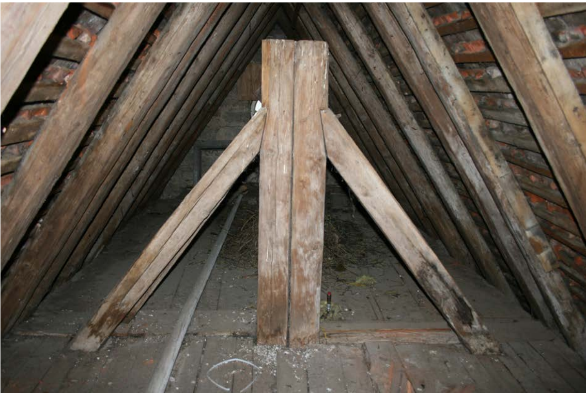
81 | Dachspitz gegen Osten, im Vordergrund oberer Teil der Hängesäule (Jan. 2013)
