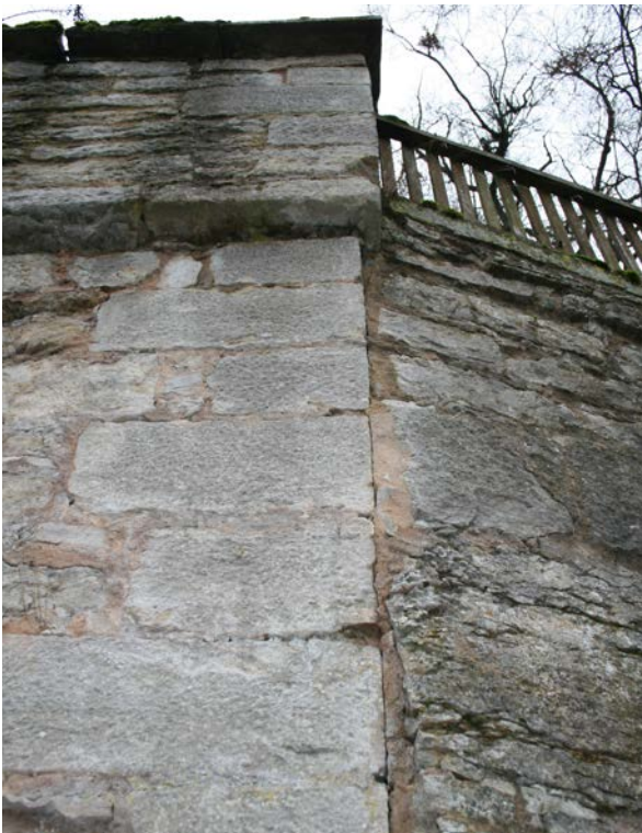
34 | Baufuge zwischen der Schlossgrabenmauer (li.) und der barocken Terrassierung (re.), Eckquaderung der Schlossgrabenmauer aus Kalksteinquadern mittleren Formats mit grob gespitzter Spiegelfläche innerhalb eines umlaufenden Randschlags (Jan. 2013); vgl. formgleiche Eckquaderung an der Südostecke XVI.48
