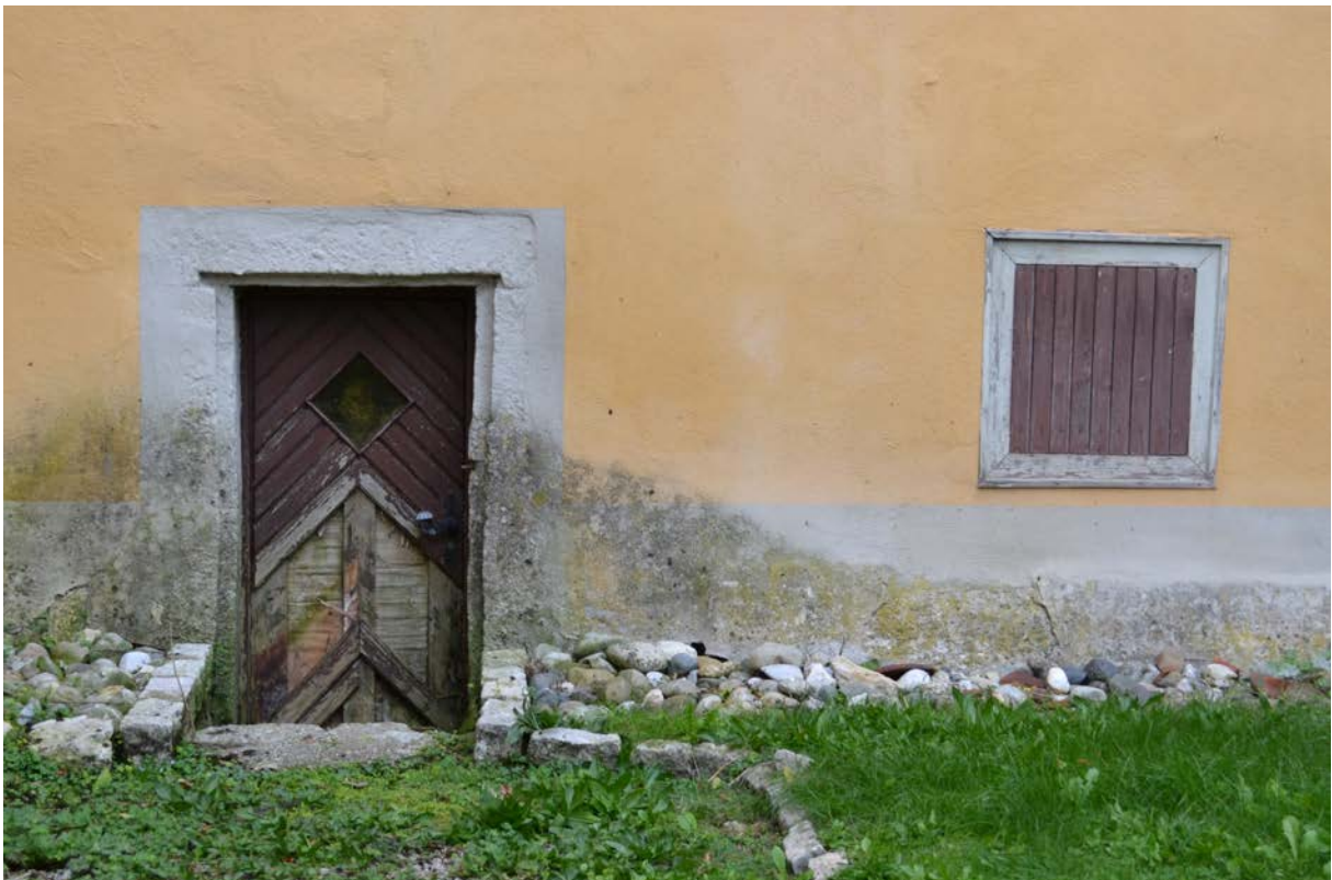
18 | 2. Untergeschoss, links Tür (HbS-2UG01-Wb-T02) in den Kellergang (HbS-2UG01), vor 1793 (vgl. IV.6) wohl im Bereich eines ehem. Schießstands eingebrochen, rechts Öffnung am Fuß eines ehem. Abortschachts (Okt. 2012); Gesamtansicht Giebelwand s. VII.19
