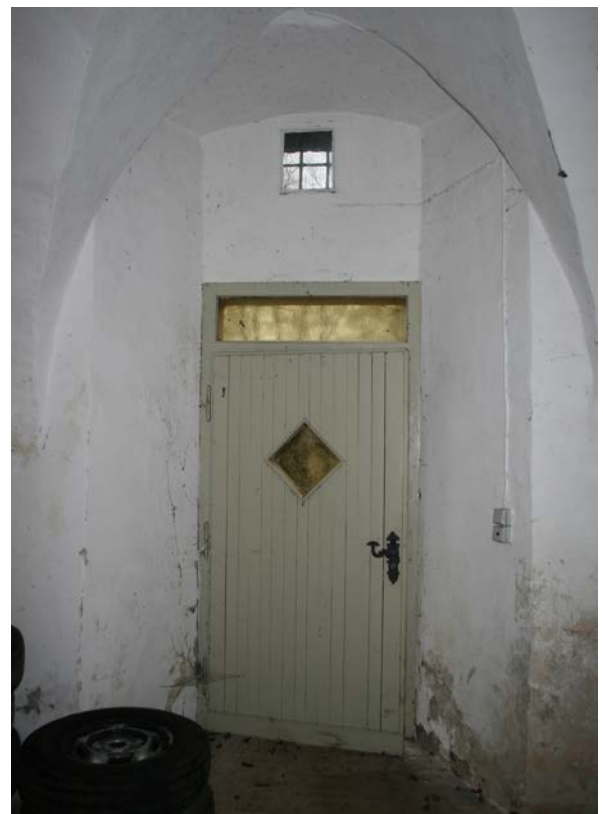
88 | Basteiturm Ost, 2. UG, ehem. Schießstand in der Ostwand des ehem. Gewölbekellers (BaO-2UG01), im 20. Jh. zum Ausgang umgeformt (Jan. 2013)
