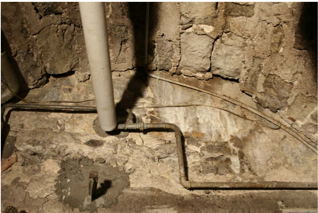
15 | 2. Untergeschoss, stumpfer Anschluss des Gewölbes aus Bauphase III.1b an der Nordwand im Stich (HbN-2UG01a) zum Turm (Nov. 2012); Gesamtansicht s. VIII.14
