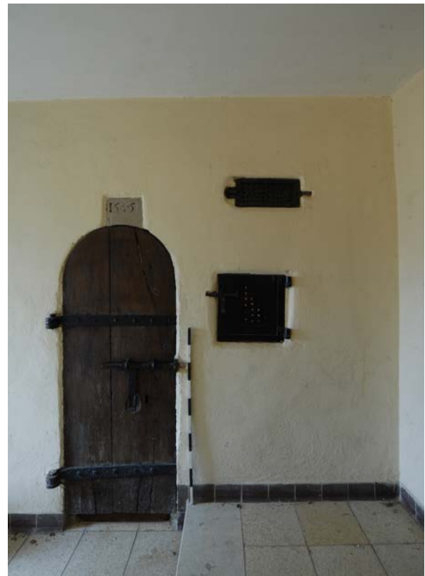
60 | Witwenbau, Eingang (Wi-T1-1UG01) in die ehem. „Metzelkammer“ an der Südwand des Kellervorplatzes (Wi-1UG01), Rundbogenportal mit historischem Türblatt und schmiedeeisernen Bändern, Sturzstein bez. „1545“ (Jan. 2012)
