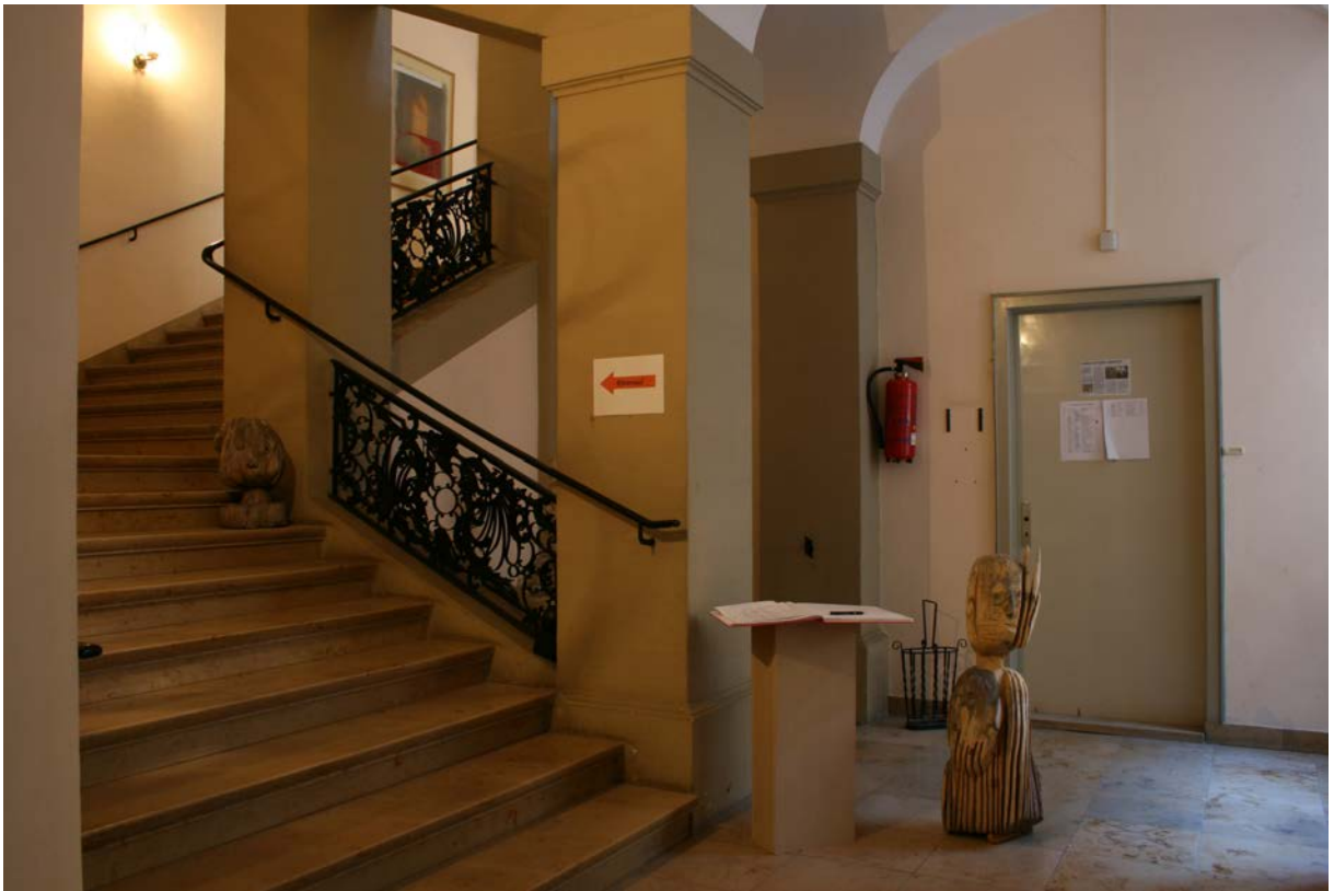
12 | Erdgeschoss, barockes Treppenhaus (HbW-Th1) aus Bauphase IV.2c gegen Norden, viergeschossige, dreiläufige Winkeltreppe mit zwei Viertelpodesten und schmiedeisernen Geländern, rechts Zugang zu Raum HbW-EG11, nach 1944 abgeteilt (Nov. 2012)
