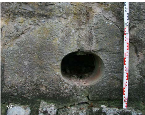
59-61 | Schlossgrabenmauer, Befundstelle 3 (59): Kugelscharte mit rückseitiger Schießnische (verschüttet), gebildet aus Spolien (chem. Schlitzlochscharte?), oben links (60) Detail der zugesetzten ehem. Schlitze, rechts (61) Innenansicht zugesetzter oberer Schlitz, darüber gewölbte Deckenplatte (Stichhöhe ca. 75 cm, Breite ca. 80 cm) (Dez. 2016)
