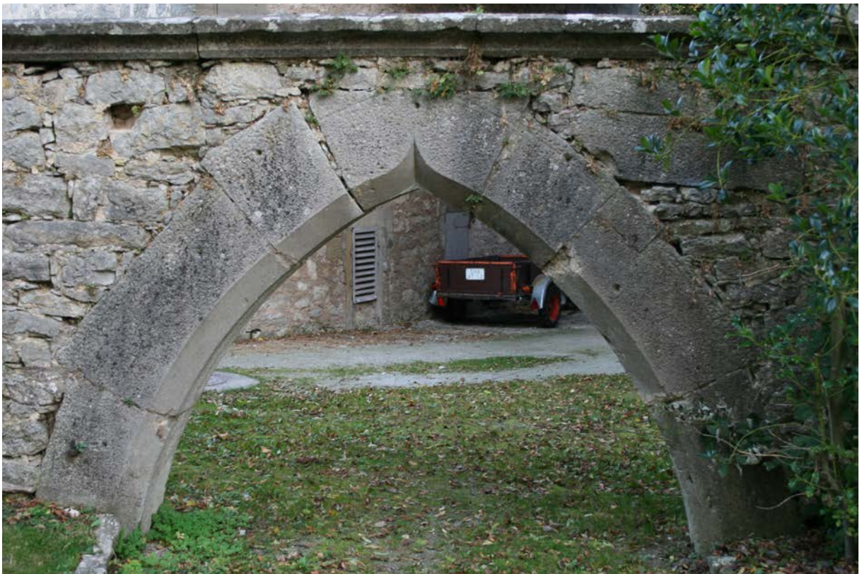
16 | Neuer Weg, ehem. Ausgangstor gegen Osten, Torrahmen mit gefastem Spitzbogen, Kalkstein mit umlaufender Reißlinie an der Außenkante der Werksteine, Innenseite fein, Außenseite grob gespitzt, was auf das Vorhaben oder eine ehemalige Verputzung der umgebenden Mauerwerkspartien schließen lässt (Okt. 2012); Gesamtansicht s. XVI.15
