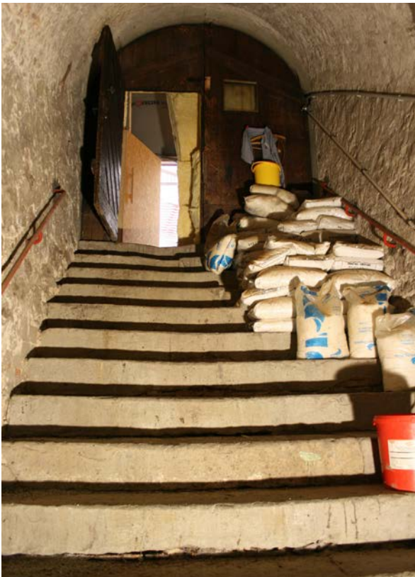
8 | 1. UG, Kellertreppe (HbO-Tr1-EG(2UG)) in den großen Gewölbekeller unter dem Saalbau, zweiläufige Winkeltreppe mit Viertelpodest, Blick zum Hoftor (s. IX.3) (Nov. 2012)
