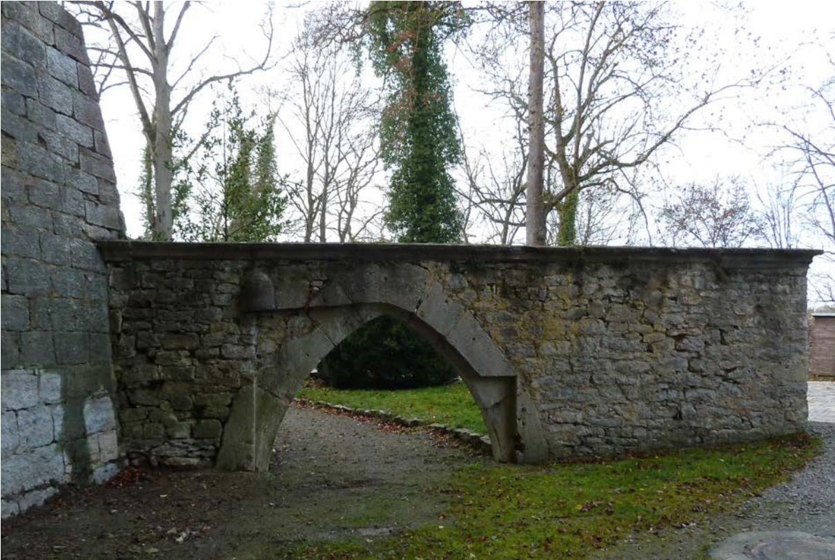
13 | Neuer Weg, ehem. Ausgangstor, das aus dem westlichen Schlossgraben auf den Hirschberg führte, Blick gegen Westen auf die Rückseite mit der Toraufhängung, laut Inschrift (s. XVI.17) 1550 gebaut und 1741 an den Ausgang des Halsgrabens versetzt (Dez. 2011); Detail Torrahmen s. XVI.14
