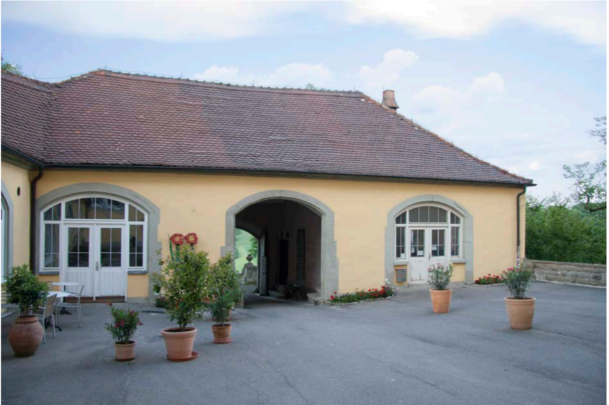
7 | Torbau, Hofansicht gegen Nordosten (Juli 2017)
