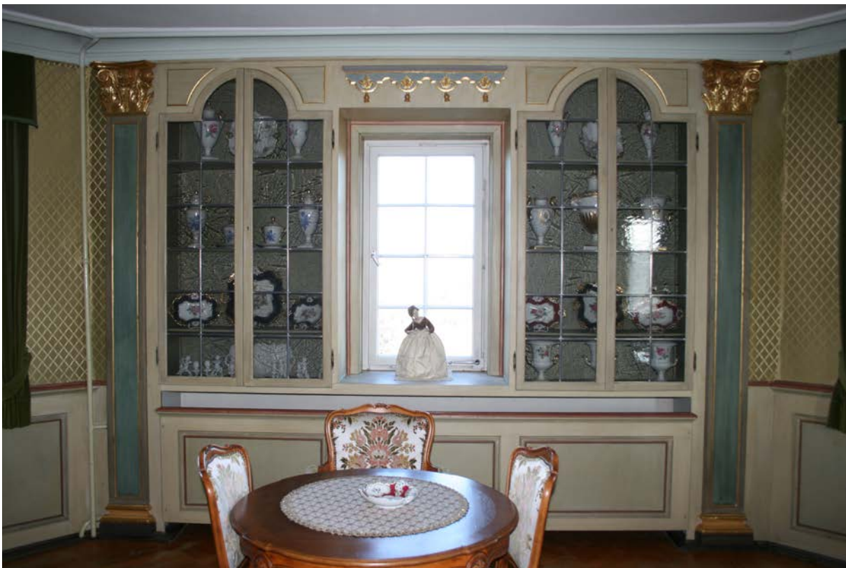
47 | 2. Obergeschoss, ehem. Kammer (Tu-2OG02) im oktagonalen Turm-Aufsatz gegen Norden, Vitrinenschränke als Teil der Wandvertäfelung aus Bauphase IV.2b, flankiert von Pilastern als Teil der Ausstattung des ehem. Kunst-kabinetts aus Bauphase IV.2b (Nov. 2012); s.auch XI.48-50
