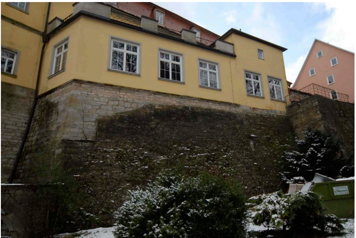
7 | Marstall, Rückansicht vom Neuen Weg gegen Süden mit Blick auf den 1960 errichteten, eingeschossigen Anbau mit Dachterrasse im Bereich des ehem. Küchenhofs, rechts die zweigeschossige, ehem. Stroh- und Sattelkammer, Fachwerkbau mit Walmdach, aus Bauphase IV.2a, zwischen 1952 und 1972 stark überformt (Jan. 2012); zum Umbaugesuch s. XVII.21 & 22
