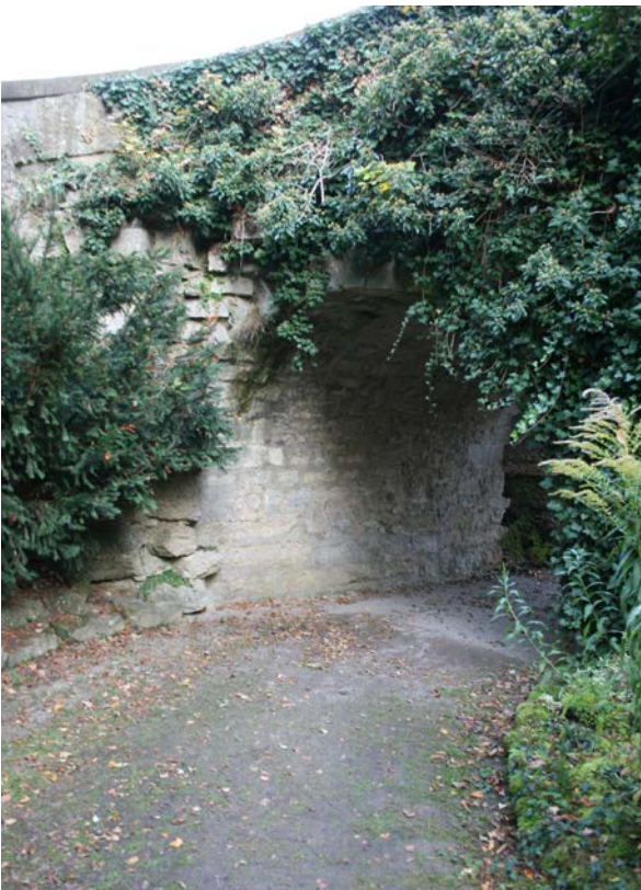
8 | Überwölbter Durchgang unter dem Fahrweg gegen Osten (Okt. 2012); weiterf. s. Kat. XII
