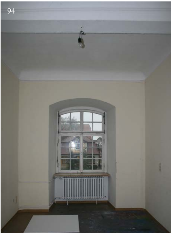
94 & 95 | 1. Obergeschoss, ehem. Grüne Stube (HbS-1OG06) mit Deckenvoute und historischem Stuck am Unterzug, 18./19. Jh., gegen Süden (94) mit Fenster zum Ehrenhof, gegen Norden (95) Zugang (HbS-1OG06-Wa-T01) vom Flur, 1956 umgebaut und purifiziert (s. XVII.8) (Jan. 2013)
