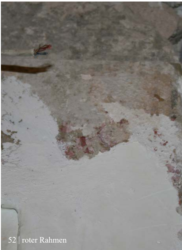
52 & 53 | 1. Obergeschoss, ehem. Abort (HbW-1OG06), Durchgang in den vorderen Schlossbau (HbS-1OG18-Wa-T01) mit rot modulierten Farbresten am Werksteinrahmen als oberste Fassung unter der modernen Tünche (Jan. 2013); Gesamtansicht mit Befundmarkierung s. X.51, vgl. entsprechende Befunde im 2. Obergeschoss s. X.62-64
