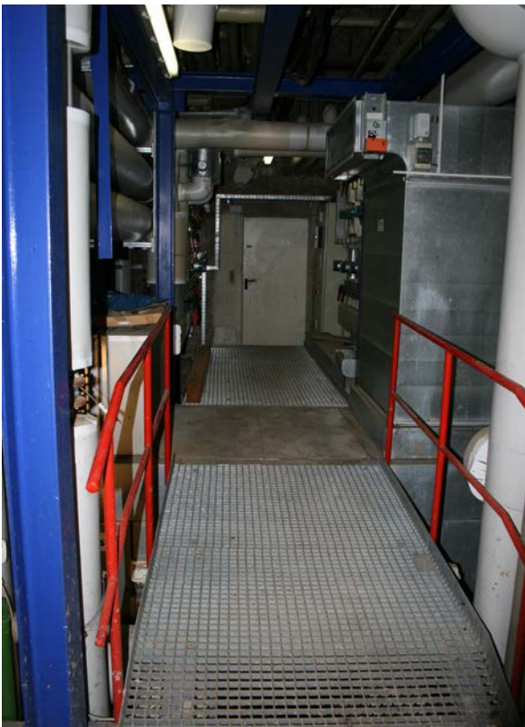
18 | 2. UG, großer Gewölbekeller (HbN-2UG01) gegen Westen, 1954 Zweiteilung des Raumes und Absenkung nebst Einbau der Stahlgitterbrücke (Nov. 2012)
