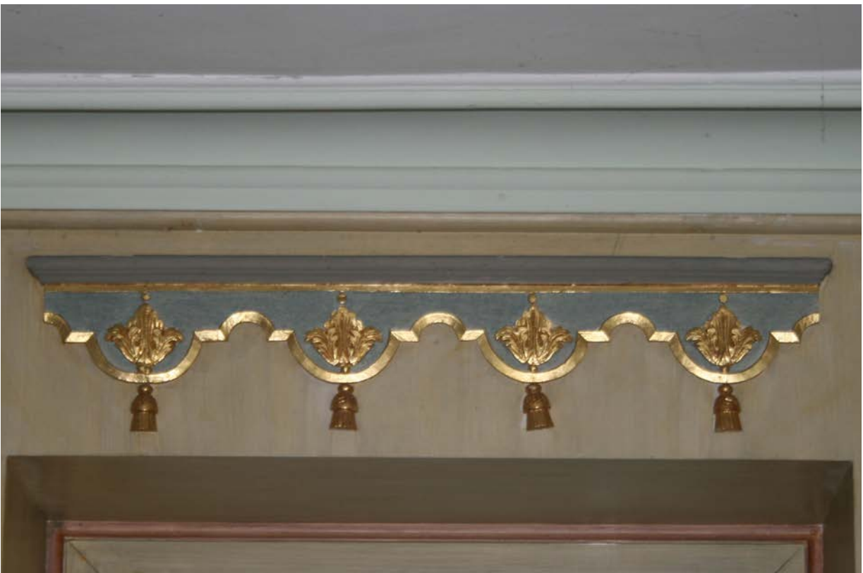
50 | 2. Obergeschoss, ehem. Kammer (Tu-2OG02) im oktogonalen Turm-Aufsatz, polychrom gefasste, teilvergoldete Blenschabracke mit leicht verwehten Quasten über dem Fenster (Tu-N-2OG-F01) der Nordwand, Detail der wandfesten Ausstattung aus Bauphase IV.2b (Nov. 2012); Gesamtansicht s. XI.47
