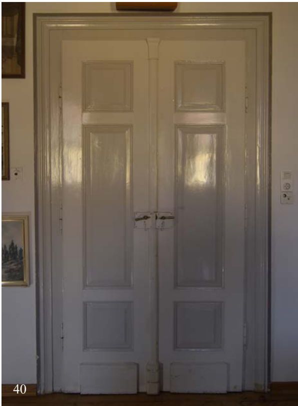
40 & 41 | Marstall, ehem. Stube (Ma-1OG11), Zugangstür (Ma-T-1OG11) mit gefelderten Türblättern (40) und Kastenschloss (41) mit Eichelzierrat, frühes 19. Jahrhundert (März 2012)
