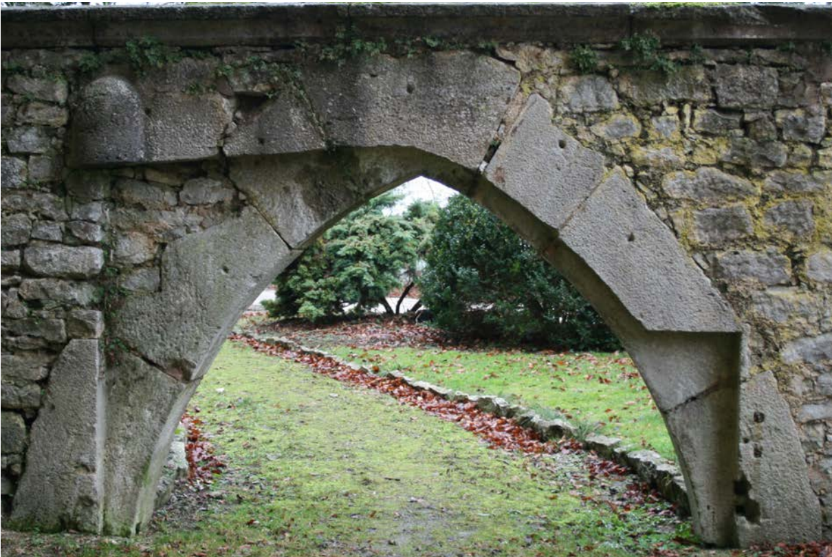
14 | Neuer Weg, ehem. Ausgangstor gegen Westen, Innenseite des Torrahmens mit Angelpfanne und eckiger Aussparungen des rechten Torflügels (Juli 2013)
