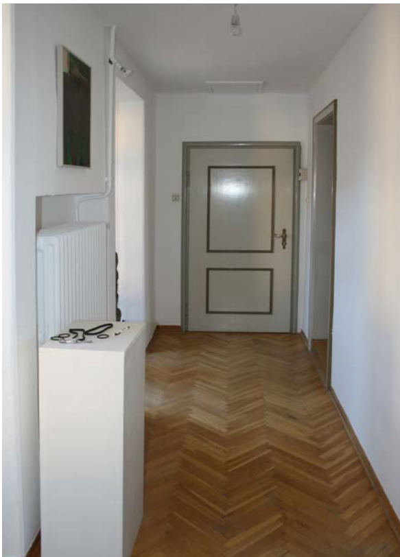
66 | Mansarde, Flur (HbW-1DG02) im Bereich der ehem. Kammer gegen Süden, 1954 abgeteilt und Decke abgehängt (Nov. 2012)
