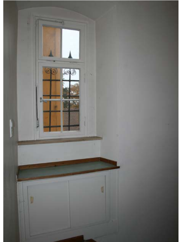
38 | 1. OG, Flur (Tu-1OG01), bauzeitliche Fensteröffnung (Tu-W-1OG-F02) aus Bauphase III.1b in der Westwand, überhängende Nische bedingt durch den Einbau der Treppe in Bauphase III.3 (Nov. 2012)
