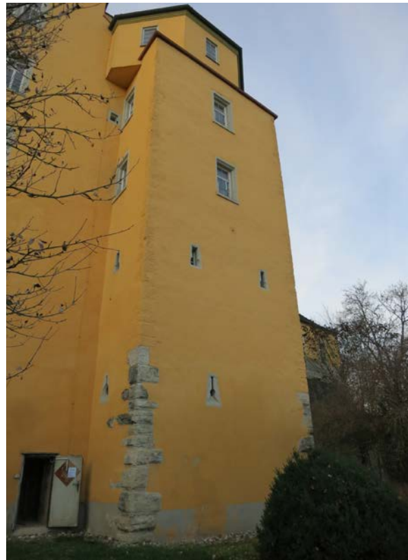
4 | Turm gegen Norden, links der Zugang (HbN-O-3UG-T01) in den großen Saalbaukeller (Nov. 2015)
