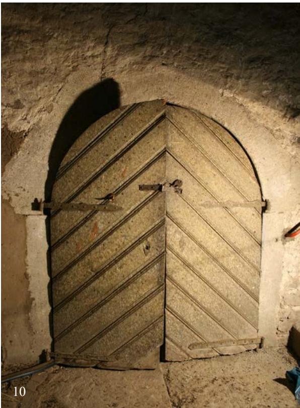
10 & 11 | 1. Untergeschoss, links (10) zweiflügeliges Rundbogenportal aus Bauphase IV.2c am Eingang ins kleine Kellergewölbe (HbO-1UG01), rechts Detailansicht (11) des scharrierten Werksteins sowie des barocken Türbands (Nov. 2012)
