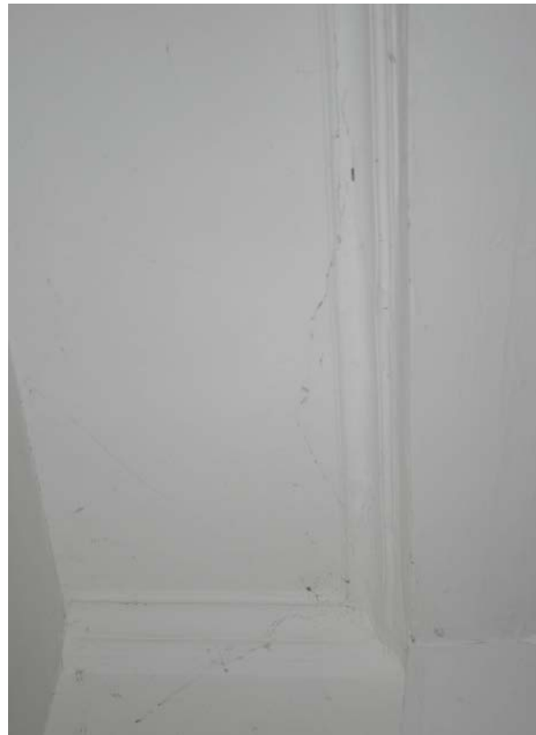
26 | EG, Raum HbW-EG05, Stuckreste über der Süd- ostecke der ehem. Stube (1954 abgebrochen) (Nov. 2012)
