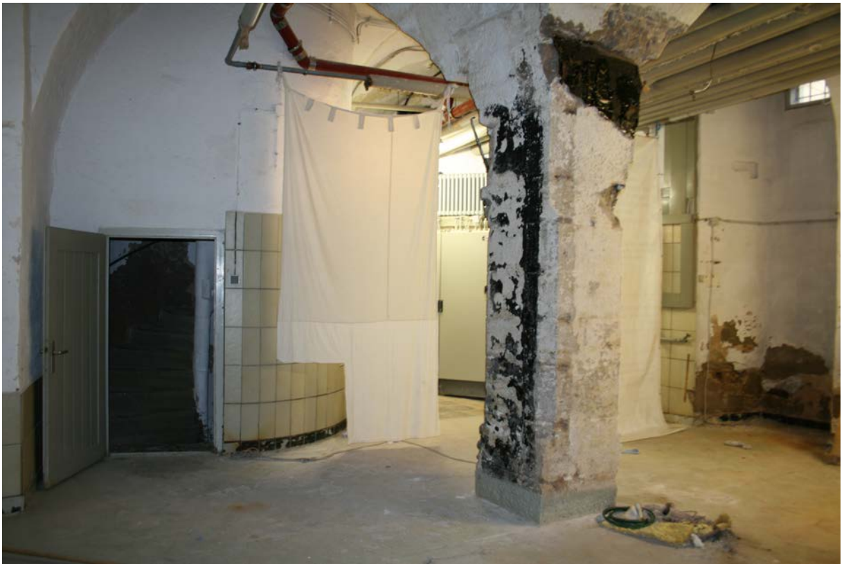
61 | Basteiturm West, 1. Untergeschoss gegen Nordosten, links der Eingang (BaW-1UG01-T01) am Wendeltrepenturm (BaW-Tr1-EG(2UG)), der von der chem. Hofküche (BaW-EG01) im Erdgeschoss bis ins 2. Untergeschoss führt (Jan. 2013)
