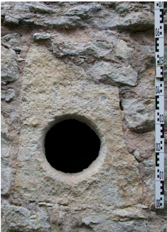
72 | Schlossgrabenmauer, Befundstelle 14: Kugelscharte mit rückseitiger Schießnische (zugesetzt) (Okt. 2017)
