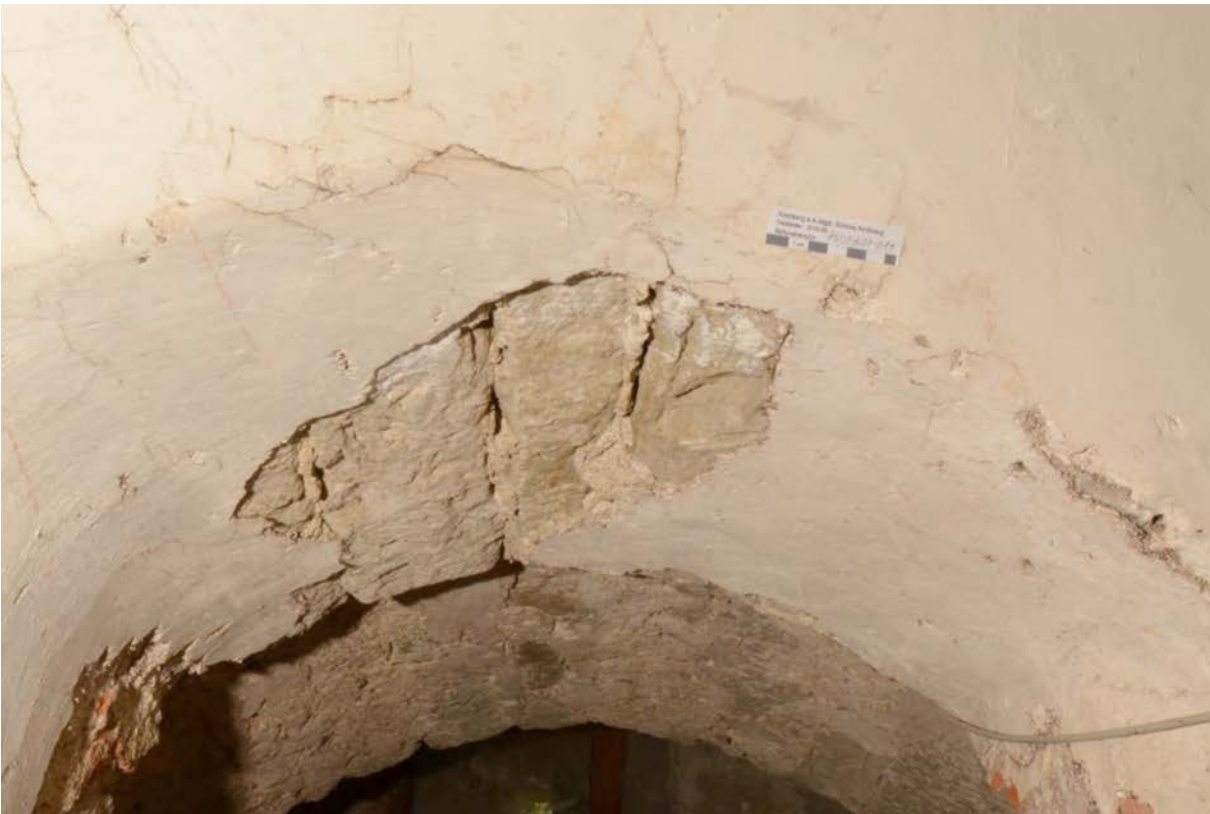
32 | Erdgeschoss, Raum unter der Treppe (HbW-EG07), gemauerter, verputzter Bogen über dem Durchgang (HbW-EG08-Wb-T01) zum Schießstand (HbW-EG08) gegen Westen, Schichtenfolge Befundstelle 011: Stein, Putz, helle Tünche (Sept. 2016); Gesamtansicht s. X.30 | abgeb. in FELDTKELLER 2016
