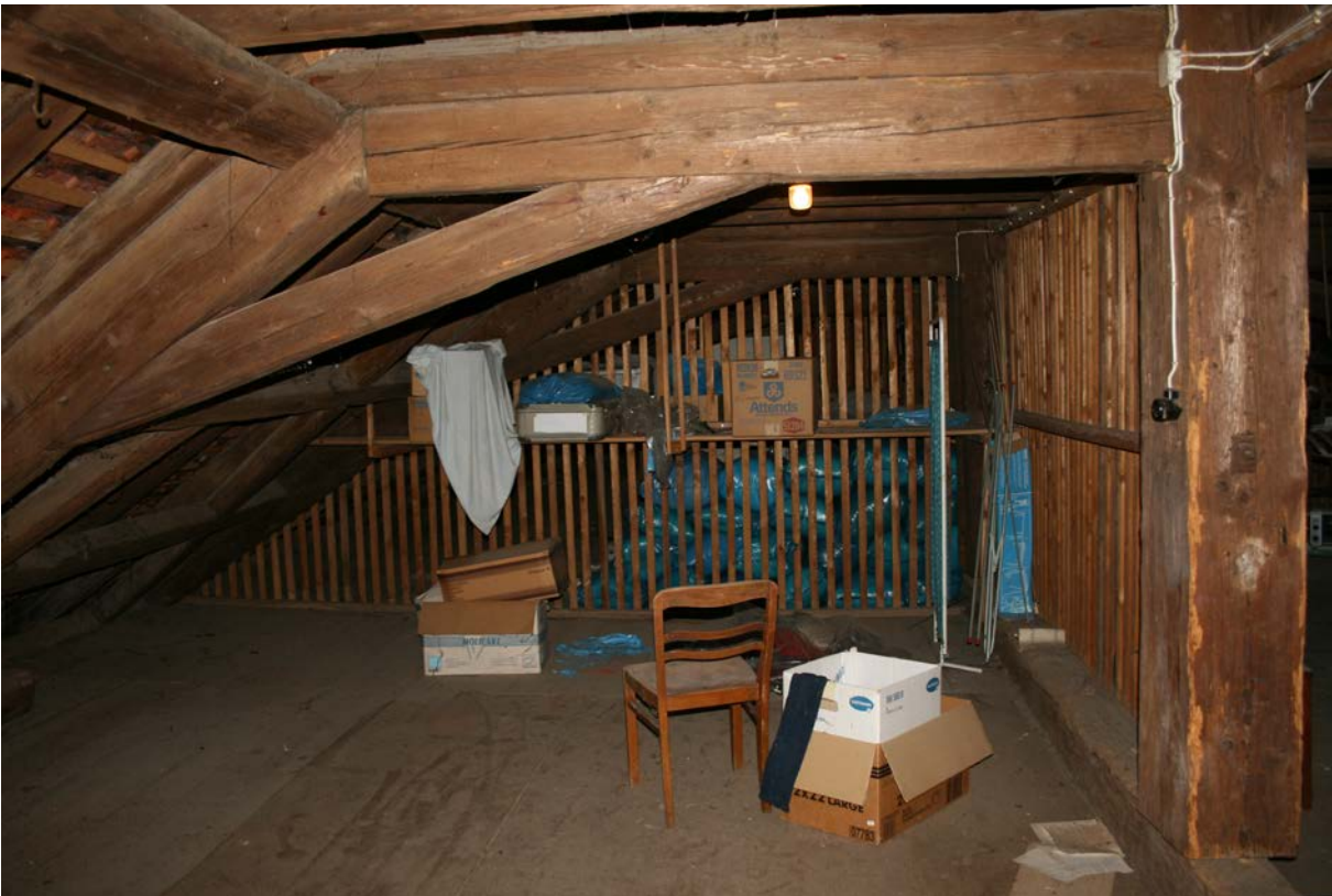
118 | 2. Dachgeschoss des Mansarddachs aus Bauphase IV.2c, Sparrendach mit liegendem Stuhl und Hängewerk (Jan. 2013)
