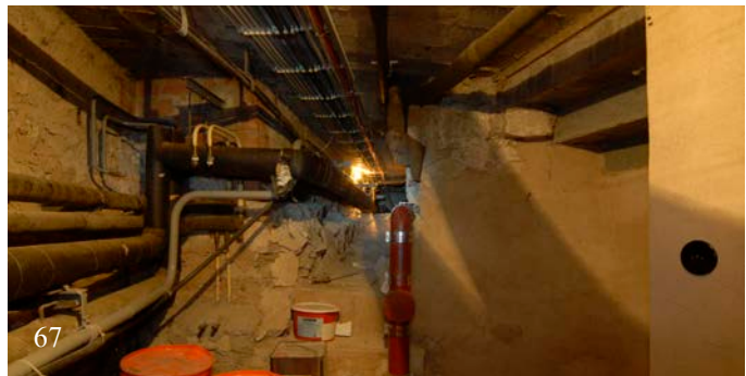
64 | Witwenbau, Fensterschacht (Wi-F-O-1UG10) der ehem. „Metzlerkammer“ in der östlicher Fundamentmauer (ehem. Stadtmauer), wohl nachträglich eingebrochen, Rahmen aus zweitverwendeten Steinen (Jan. 2012); Innenansicht s. XIII.62
