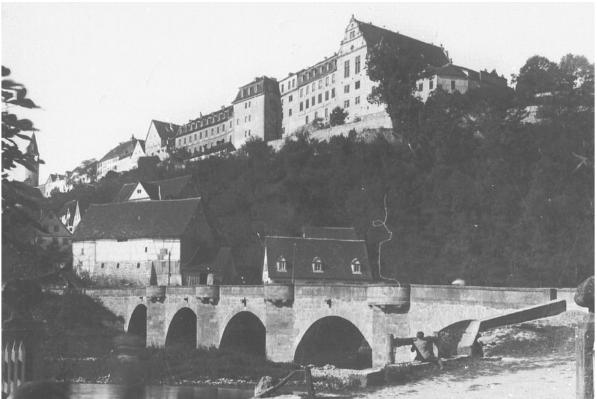
26 | Kirchberg, Blick vom rechten Jagstufer über die Jagstbrücke auf die Ostflanke der Stadt, das Schloss vor der Spornspitze und den hinteren Schlosshof mit der später abgebrochenen Holzremise aus Bauphase IV.3b, Fotografie, 1907 | © Landesamt für Denkmalpflege im Regierungspräsidium Stuttgart
