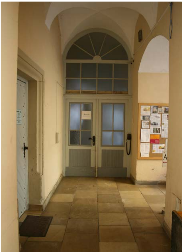
48 | EG, Blick aus der Durchfahrt gegen Westen in den vorderen Teil des Gangs (HbS-EG01a), Flügeltür nach 1954 eingebaut, links Zugang (HbS-EG05-Wa-T01) in die ehem. Hofstube (s. VII.52 & 53) mit Werksteinrahmen vom Typ B (Taf. XIVb) aus Bauphase II (Nov. 2012)
