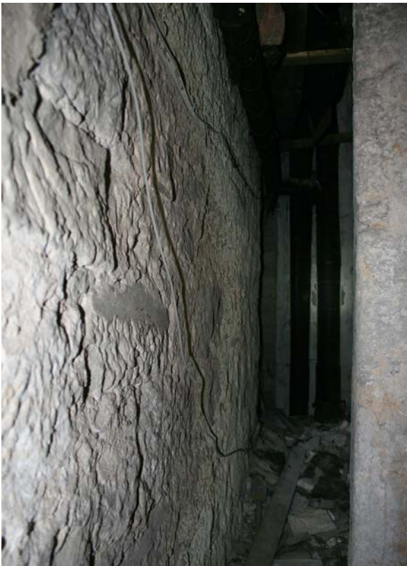
39 | EG, Fortsatz zum ehem. Abort (HbW-EG08) gegen Süden, links die Rückwand des Treppenhauses aus Bauphase IV.2c, rechts südliche Laibung des Schießstands (HbW-W-EG-F07) (Nov. 2012)
