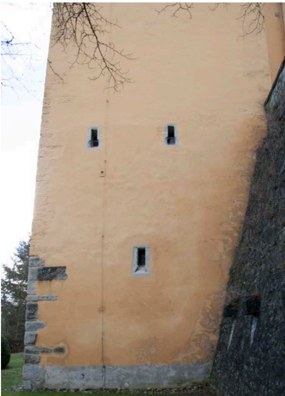
5 | Nordfassade des mittelalterlichen Unterbaus mit bauzeitlichen Schießscharten (Jan. 2018)
