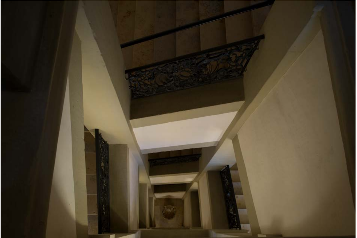
17 | Barockes Treppenhaus (HbW-Th1) aus Bauphase IV.2c, Treppenaue von der Mansarde bis ins Erdgeschoss (Juli 2017) | © Isabel Muehlhaus TUM
