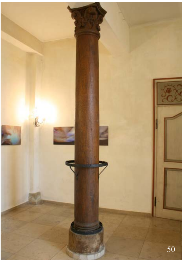
50 & 51 | Erdgeschoss, „Stube“ (HbN-EG09), Säule zur Stabilisierung des nördlichen Unterzugs, Eichenholz, 16./17. Jh., wohl 1954 bei der Unterteilung der ehem. Durchgangshalle anstelle des bauzeitlichen Pfeilerpaares eingestellt (Provenienz nicht bekannt) (Nov. 2012)
