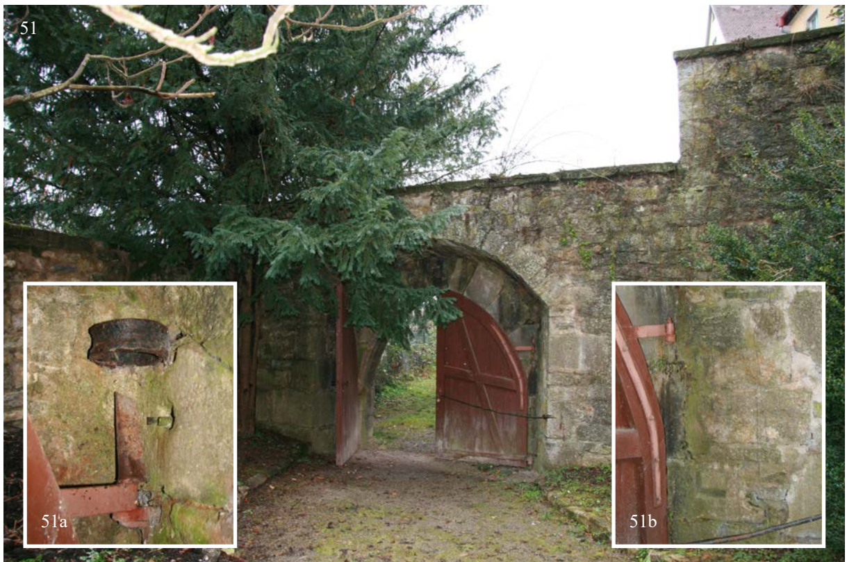
51 & 51a/b | Südostecke des Schlossgrabens, frühneuzeitliches Ausgangstor auf den Badberg, Rückansicht, Torblätter modern, im Detail links (51a) die historische, schmiedeeiserne Türblattaufhängung an der östlichen Laibung, rechts (51b) die quadratische Aussparung für einen Sperriegel (Dez. 2016); Außenansicht s. XVI.50
