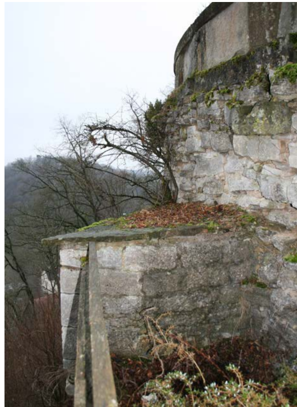
35 | Nordecke der ehemals spitzwinklig zusammengeführten Mauerzüge der Schlossgrabenmauern, in Bauphase IV.3a vom Fundament des Fahrwegs (re.) überformt, später teilgeschleift (Jan. 2013)
