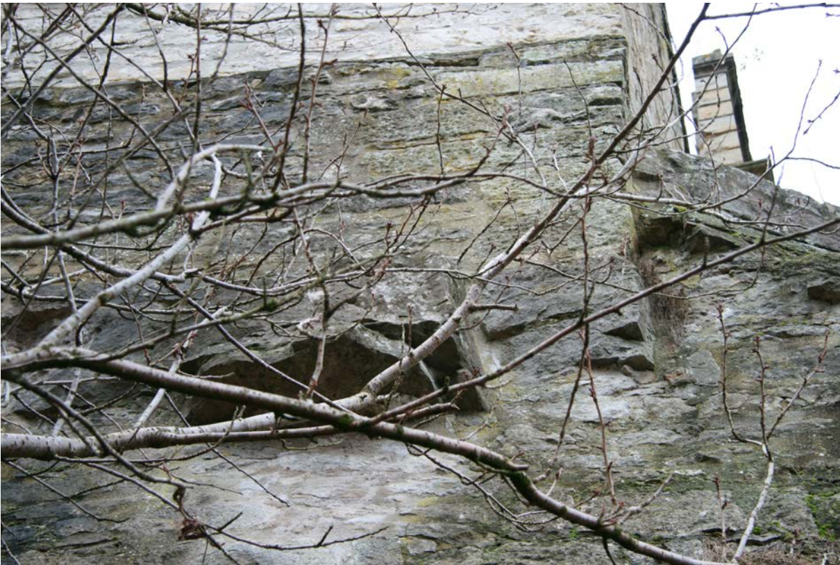
38 | Mantelmauer des Schlosshoffundaments im Bereich unterhalb des Torbaus, rechts Eckquaderung aus großformatigen, grob gepickten Kalksteinquadern, Terminus ante quem 1758, mögliche ältere Einfassung des ehem. Schlossgärtleins (Dez. 2016)
