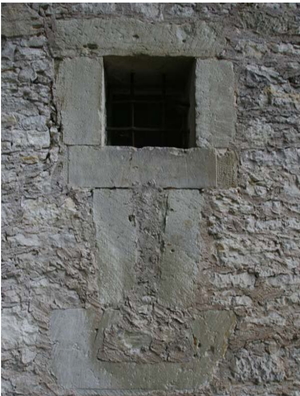
30 | Basteiturm West, 2. UG, Südfassade, östliche Steigbügelscharte mit schmiedeeisernem Gitter, Sandstein, sekundär zugesetzt (Okt. 2017)
