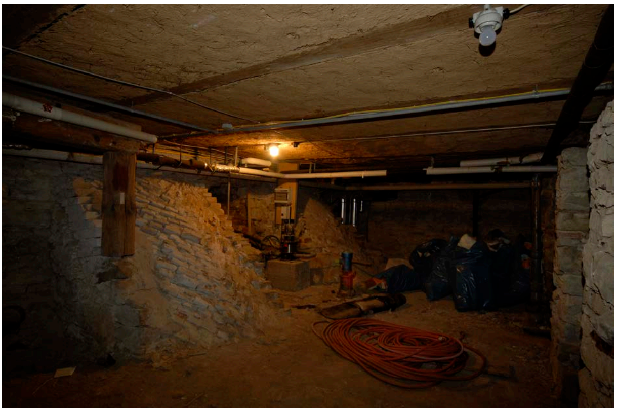
22 | Marstall, Zwischengeschoss, Keller (Ma-1UG01a) über dem großen Gewölbekeller, Blick gegen Süden, links die Gewölbebusen der hofseitigen Fensterschächte (Ma-2UG02-Wb-F01, -F02 & -F03) (Jan. 2012)
