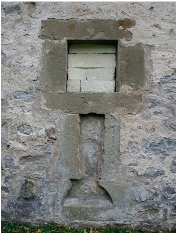
26 | Basteiturm West, Westfassade, 2. UG, südliche Steigbügelscharte mit Beobachtungsfenster, Sandstein, sekundär zugesetzt (Okt. 2017)
