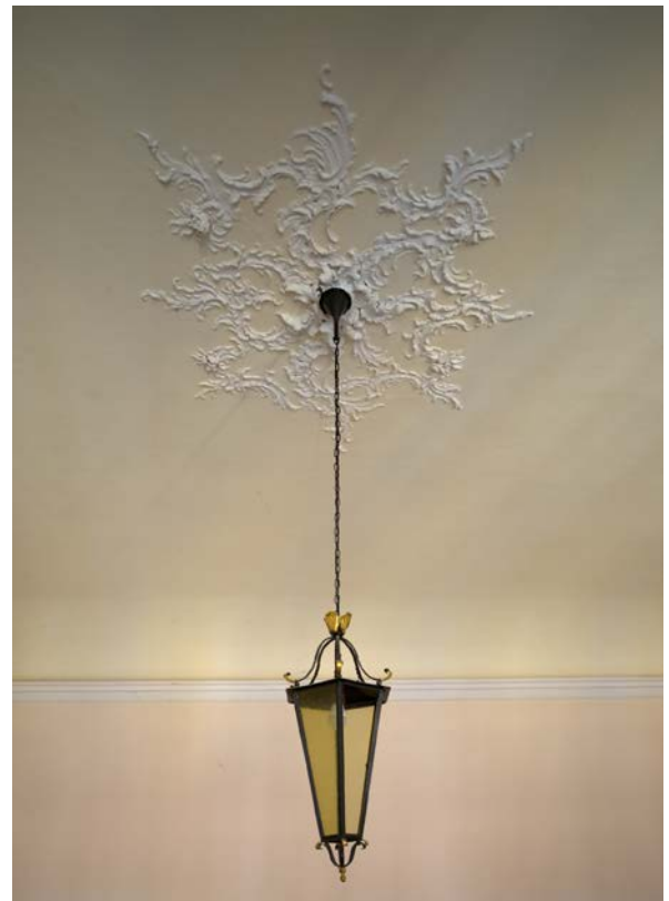
24 | Mansarde, bauzeitliche Stuckrosette im Zentrum des Deckenplafonds über dem Treppenhaus (HbW-Th1), 1757 vom Würzburger Stuckateur Franz Oeder gefertigt (Juli 2017) | © Isabel Muehlhaus TUM
