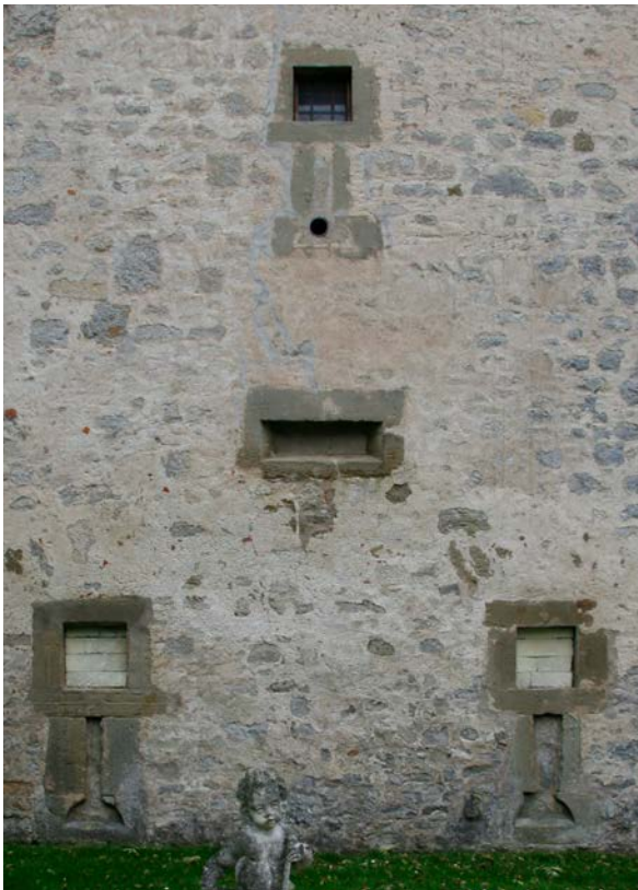
24 | Basteiturm West, Westfassade, 1. & 2. UG, Steigbügelscharten in Kombination mit Beobachtungsfenstern und einer Rechthckscharte darunter (im 2. UG vtl. verschüttet), sekundär zugesetzt (Okt. 2017); Details s. VII.25-27, Innenansichten der Schießstände s. VII.65 & 66
