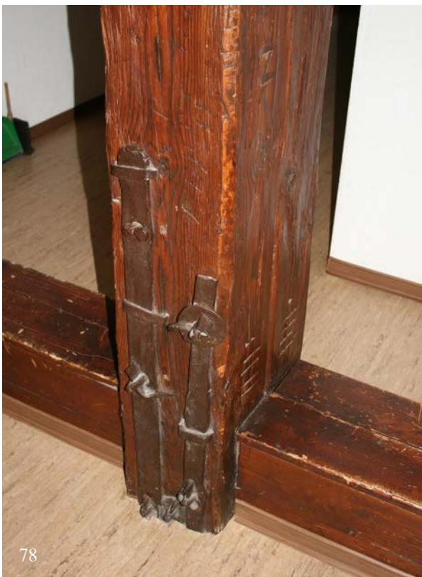
78 & 79 | 1. Dachgeschoss, Flur (HbN-1DG05), Vollgespärre IIII mit Blick auf den Fuß der Hängesäule und die schmiedeeiserne Klammer, die um den Überzug greift, im Detail (79) Abbundzeichen X III (Jan. 2013)
