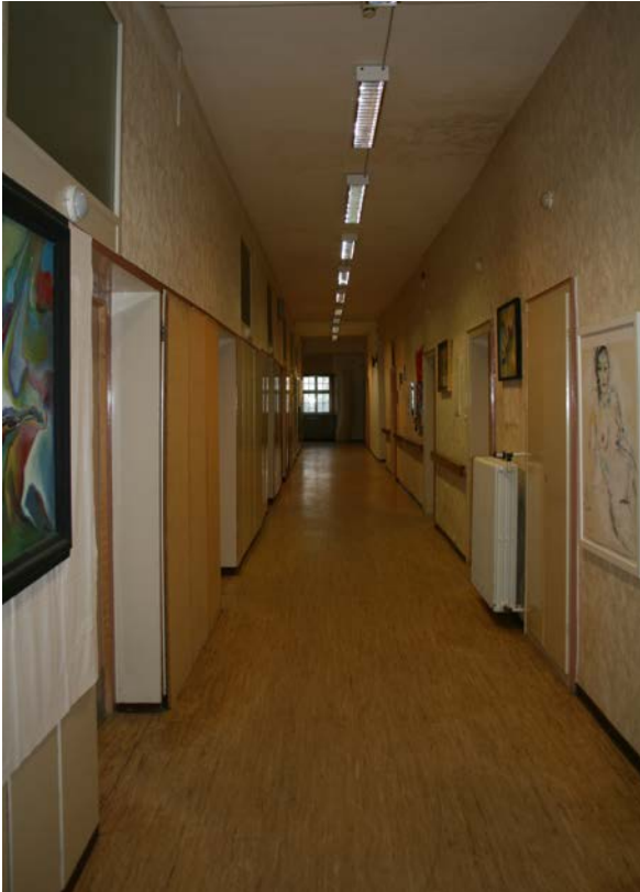
99 | 2. OG, Flur (HbS-2OG01a) gegen Westen im Ausbauzustand nach dem Umbau 1956 (s. XVII.9) (Jan. 2013)
