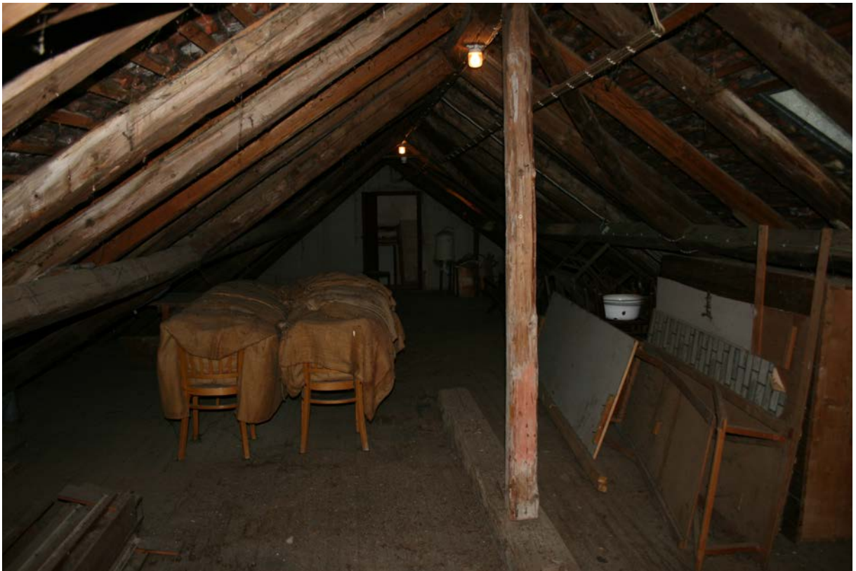
71 | 2. Dachgeschoss, Sparrendach aus Bauphase IV.2c gegen Süden (März 2013); Detail Hängesäule s. X.73
