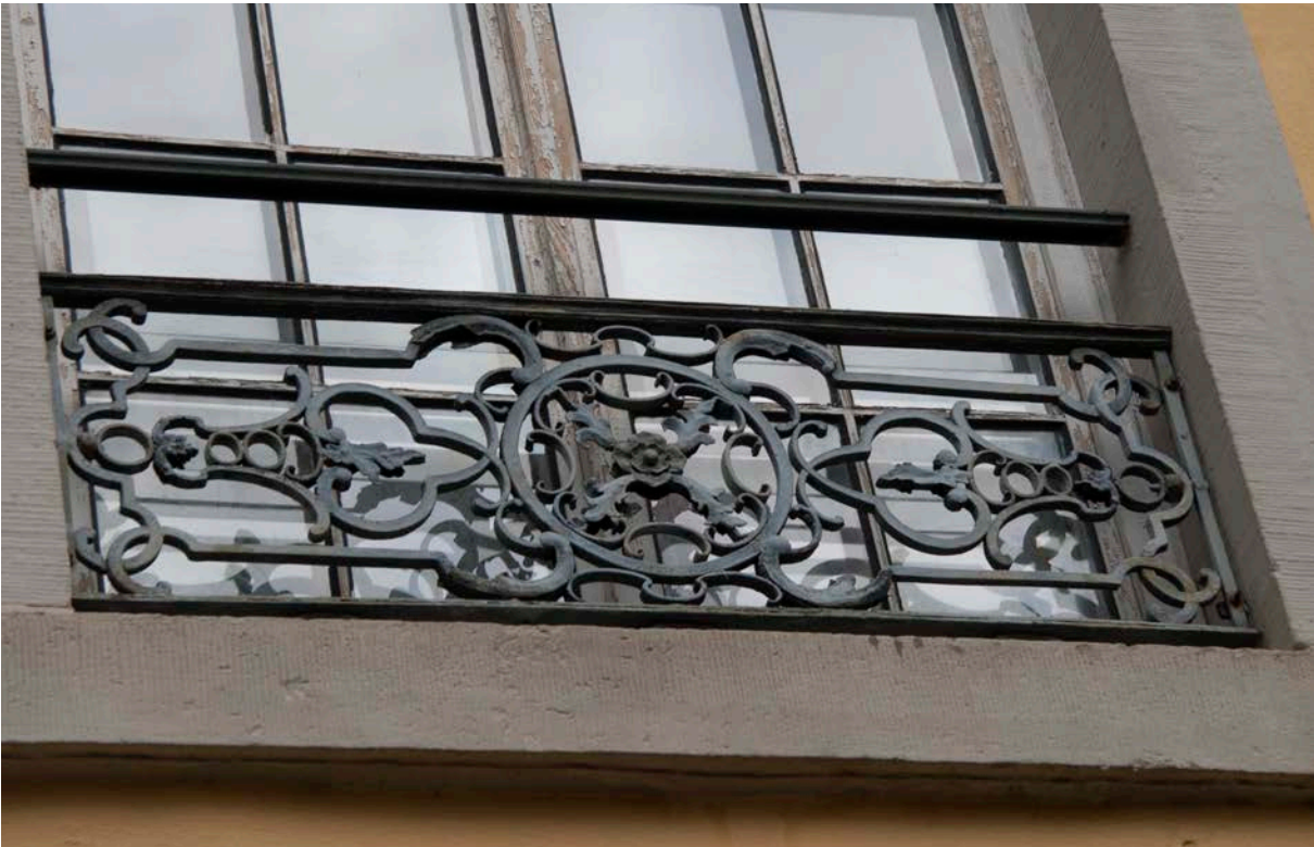
5 | 1. Obergeschoss, Südfassade, schmiedeeisernes Fenstergeländer aus Bauphase IV.2c (Okt. 2017); zu den Entwürfen s. V.66 & 67
