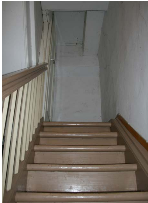
29 | EG, Flur (Tu-EG01) gegen Norden, unterer Lauf der zweiläufigen Winkeltreppe (Tu-Tr1-EG(1OG)) mit Halbpodest, Treppenloch in Bauphase III.3 eingebrochen (Nov. 2012); oberer Lauf s. XI.37
