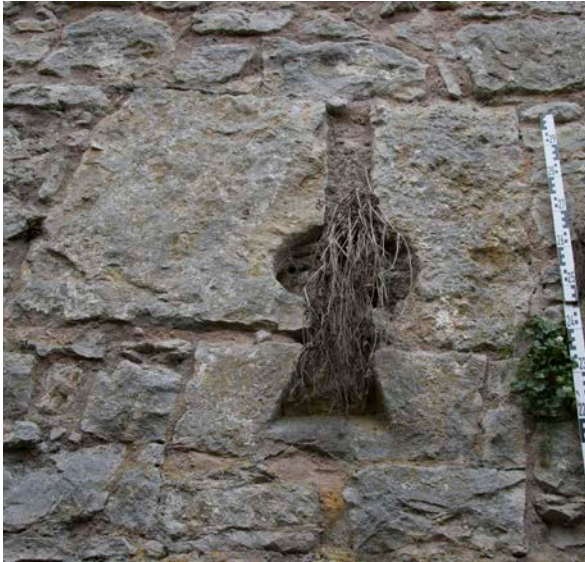
70 | Schlossgrabenmauer, Befundstelle 12: Blinde Schlitzlochscharte (Okt. 2017)
