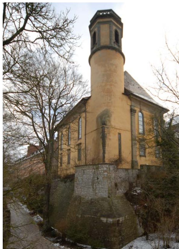
7 | Kirchberg, ev. Pfarrkirche gegen Nordosten, Emporenkirche, verputzter Massivbau mit Pilastergliederung, 1728-34 unter Einbeziehung des mittelalterlichen Stadtturms nach Plänen von Matthäus Krug (Jan. 2012)
