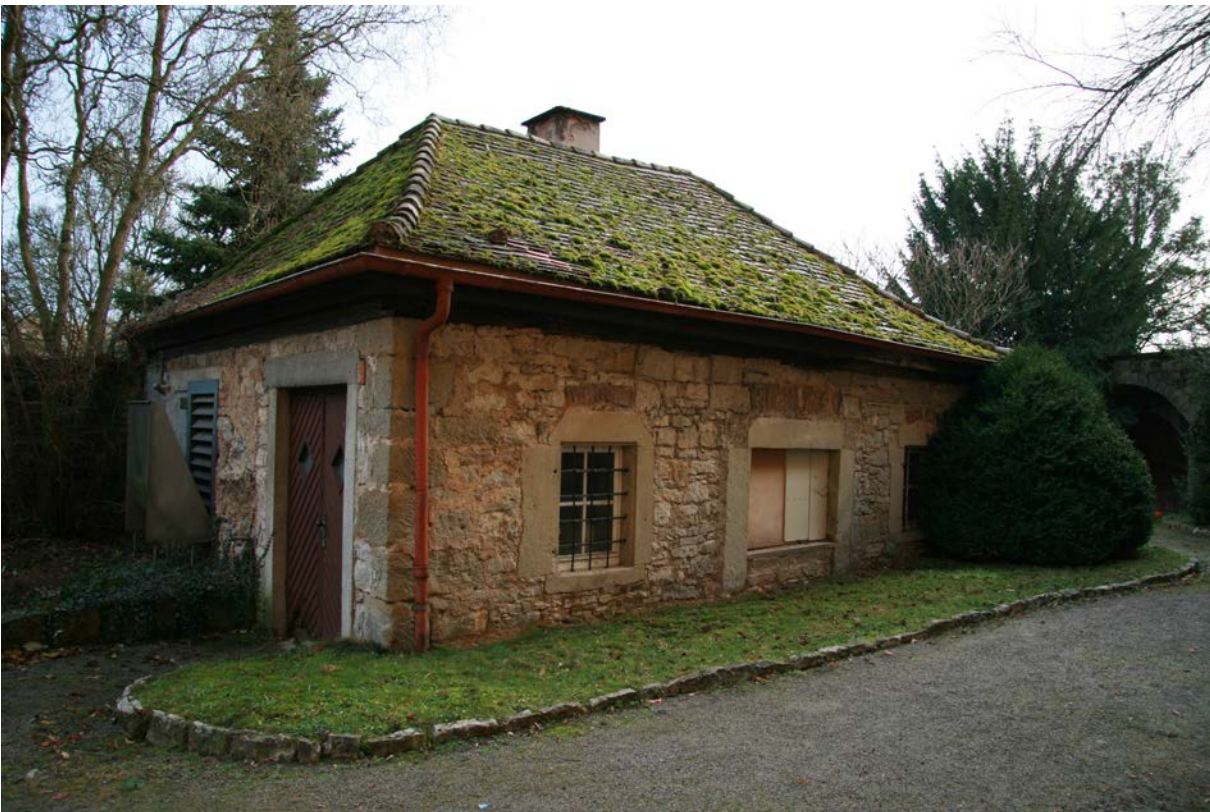
75 | Ehem. Waschhaus gegen Süden, eingeschossiger Walmdachbau, der mit der östlichen Traufe auf der Grabenmauer lehnt, wohl in Bauphase IV.2a errichtet, 1953 entkernt und in ursprünglicher Funktion ertüchtigt (Dez. 2016)
