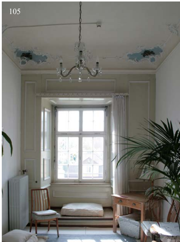
104 & 105 | 2. Obergeschoss, ehem. Graues Kabinett (HbS-2OG06) mit Vertäfelung und Stuck aus Bauphase IV.2c, gegen Norden (104) der Zugang (HbS-1OG06-Wa-T01) zum Flur, gegen Süden (105) das Fenster zum Hof, 1956 umgestaltet (Okt. 2012); Details der wandfesten Ausstattung s. VII.106 & 107, zum Umbauplan s. XVII.9
