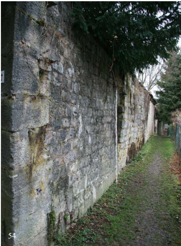
54 & 55 | Befundstelle 1 am südlichen Ende der Schlossgrabenmauer: Über niedrigem Betonsockel wieder aufgemauerter Abschnitt der Schlossgrabenmauer im Bereich vor der Südostecke (Dez. 2016); Rückansicht s. XVI.56
