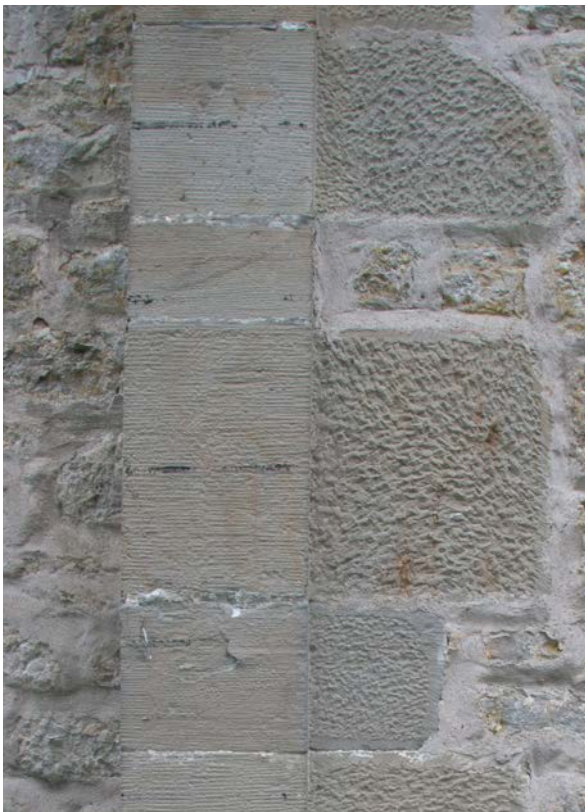
15 | Torbau, Nordfassade, östlicher Eckpilaster am Mittelrisalit, Detail Werkstein mit scharrierter Oberfläche und Bossierung im zurücktretenden, ehemals wohl verputzten Bereich (Juli 2017)
