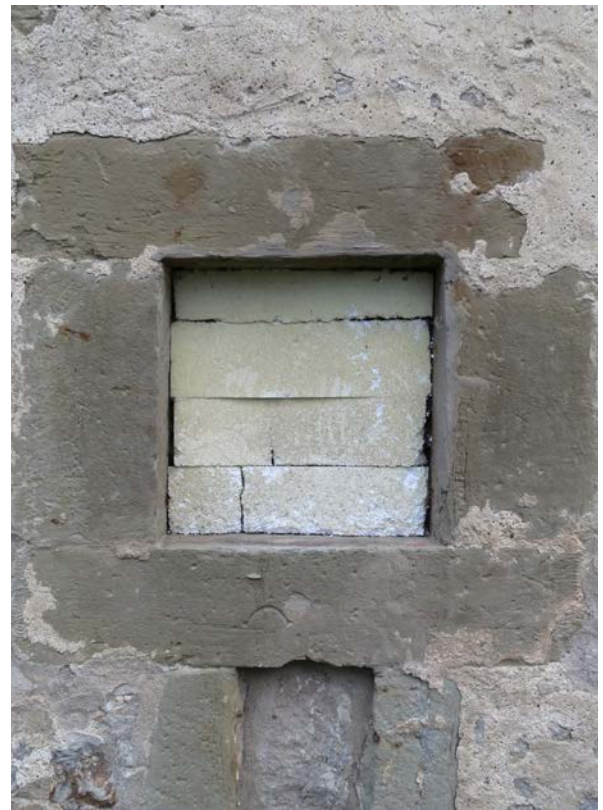
27 | Basteiturm West, Westfassade, 2. UG, Beobachtungsfenster südliche Scharte mit Steinmetzzeichen, Sandstein, Rostrückstände links verweisen auf Splintreste, an denen ehemals wohl ein Klappladen armiert war (Okt. 2017)
