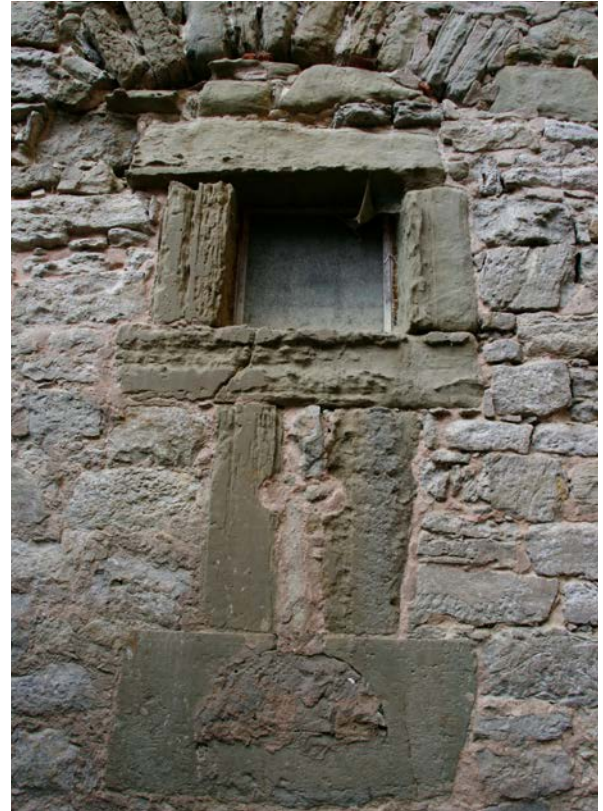
33 | Basteiturm West, Ostfassade, 2. UG, nördliche Steigbügelscharte mit Kreuzschlitz und Beobachtungsfenster, Sandstein, sekundär zugesetzt; Kreuzschlitzscharte vtl. aus Bauphase I zweitverwendet (Okt. 2017); Detail s. VII.34
