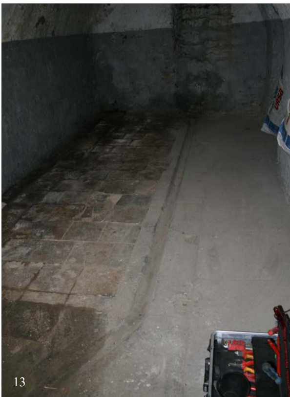
13 & 14 | 1. Untergeschoss, Ablaufrinne (13 | Okt. 2015) und -loch (14 | Nov. 2012) im kleinen Gewölbekeller (HbO-1UG01)
