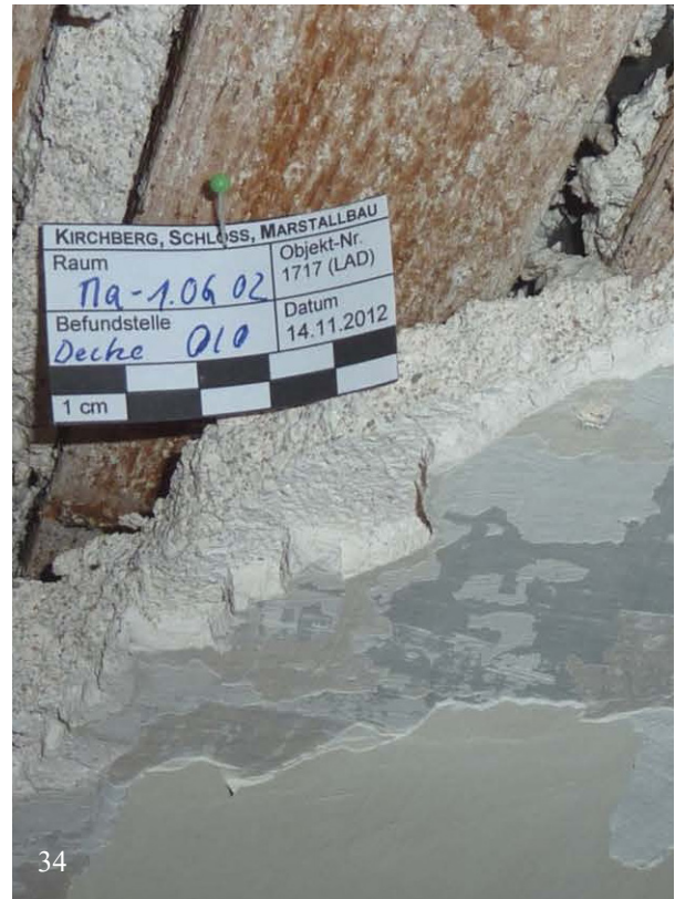
33 & 34 | Marstall, 1. Obergeschoss, stuckierte Decke wohl aus Bauphase IV.2 über dem Flur (Ma-1OG02), Fehlstelle im Mittelteil gibt die sog. Lattenquadratur und den Stuckaufbau zu erkennen (Jan. 2012); im Detail (34 | Nov. 2012 | © BÜCKNER/SCHREIBER 2013) Befundstelle 010
