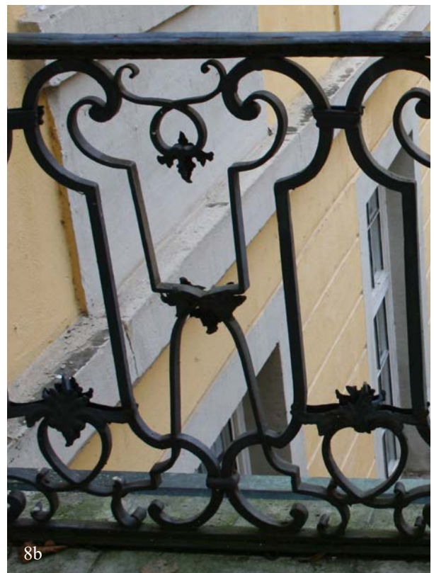
8a/b | Schmiedeeisernes „Baluster“-Geländer am Altan, gefertigt in Bauphase IV.2c wohl von Georg Sigmund Schlecht nach einem Entwurf von Carl August von H.-Kirchberg (s. VII.143-147), Vorderansicht (8a; Juli 2017 | © Isabel Muehlhaus TUM) und Rückansicht (8b; Nov. 2012)
