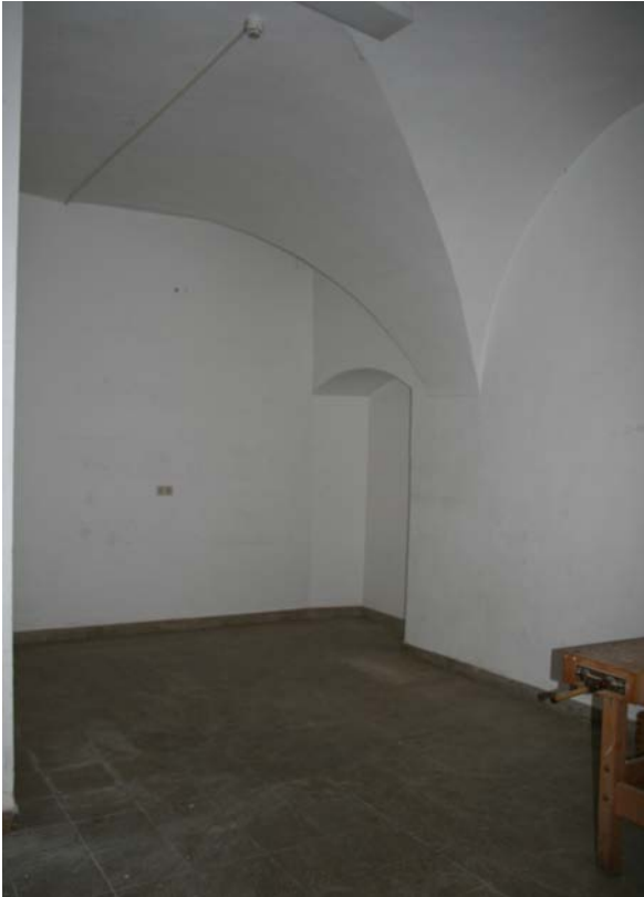
55 | EG, südlicher Teil der ehem. Gesindekammer (HbS-EG04) gegen Nordosten, in der Ostwand ehem. Durchgang in die Hofstube (HbS-EG05), zw. 1948-1954 geschlossen (Nov. 2015)
