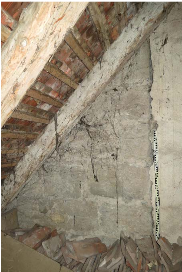
2 | Nordfassade, Baufuge im Bereich des Remisendachs, li. regelmäßiges Schichtenmauerwerk aus großformatigen, grob gespitzten Kalksteinquadern aus Bauphase I.1, re. stumpf anstoßender, verputzter Anbau aus Bauphase III.1b (Nov. 2015); Detail Baufuge s. VIII.3
