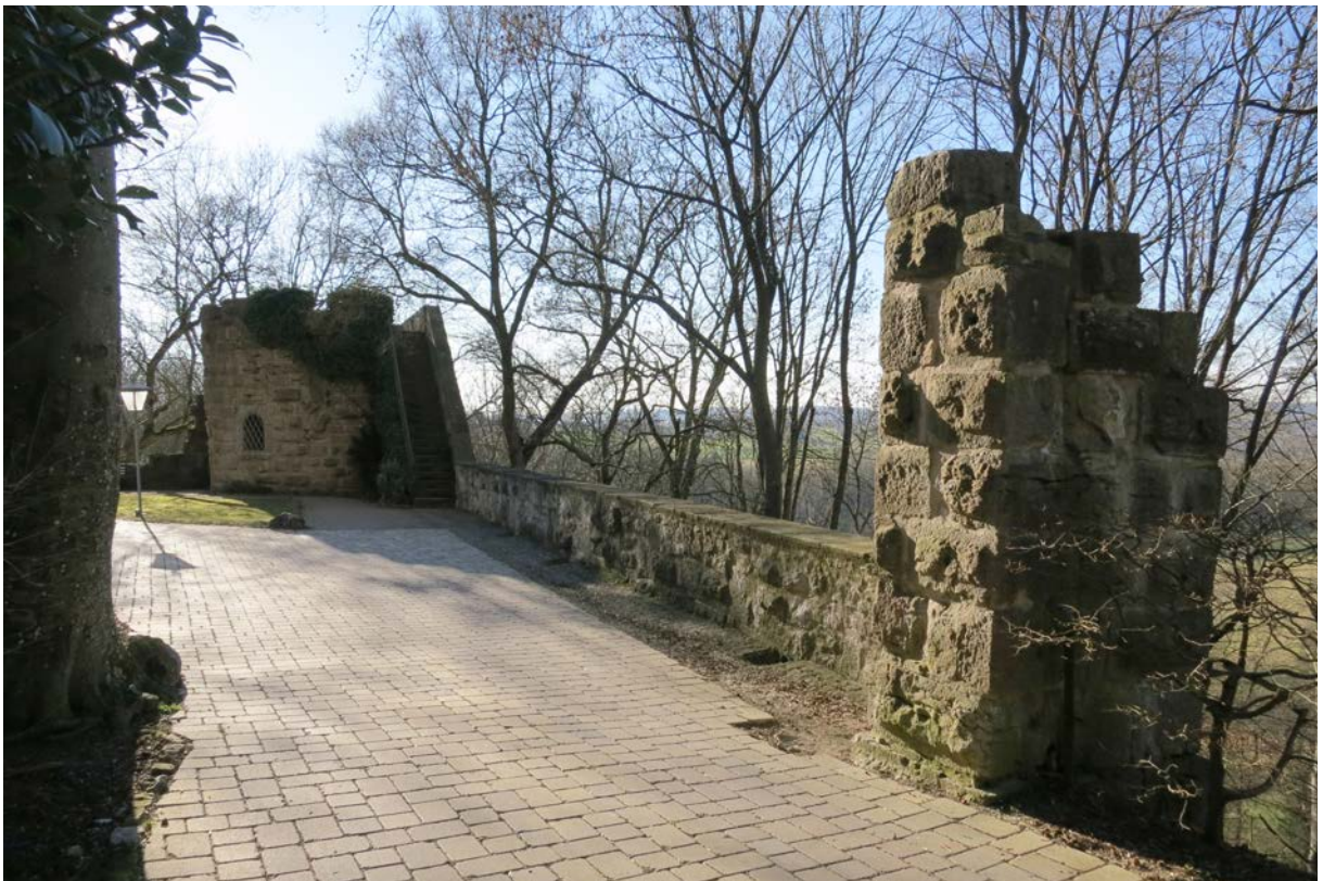
20 | Künstliche Turmruine mit Aussichtsplattform und Torbogen als Point de Vue am Süden des Neuen Wegs, Blick gegen Westen, 1795 aus Werksteinen der Burg Leofels errichtet, seit 1840 Katharinenruhe genannt, im Zweiten Weltkrieg beschädigt und wiederaufgebaut (Feb. 2014)
