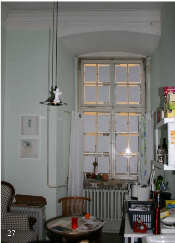
27 & 28 | Erdgeschoss, Südwand der ehem. Stube mit historischen Stuckprofilen am Deckenanschluss, 1954 in die Räume HbW-EG09 (X.27) & HbW-EG10 (X.28) unterteilt (Jan. 2013)
