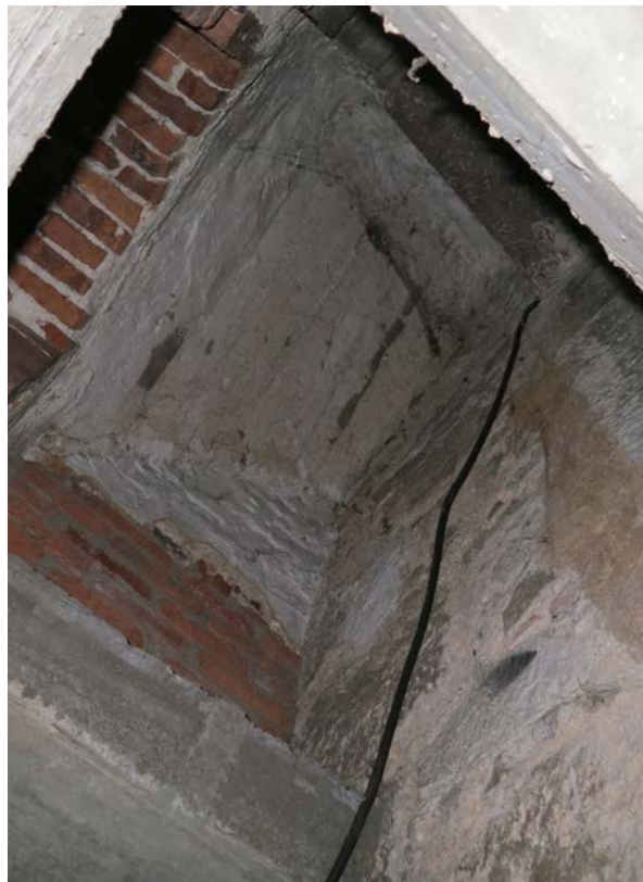
11 | 1. UG, Technikgang (HbW-1UG01), Untersicht Treppe HbW-Tr1-EG(1UG) über dem nördlichen Ende, rechts Fundamentmauer der Westfassade aus Bauphase IV.2c, links überwölbter Hohlraum (Funktion unklar?) (Nov. 2015)
