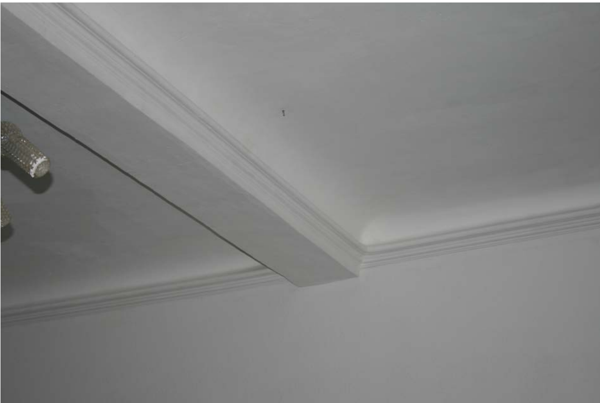
57 | 1. Obergeschoss, ehem. Nebenkammer (HbN-1OG07) zum Hinteren Stubenappartement, historischer Deckenstuck im Bereich der Westwand, Deckenkonstruktion mit Unterzug vermutlich aus Bauphase III.1b, Stuck wohl später (Jan. 2013)
