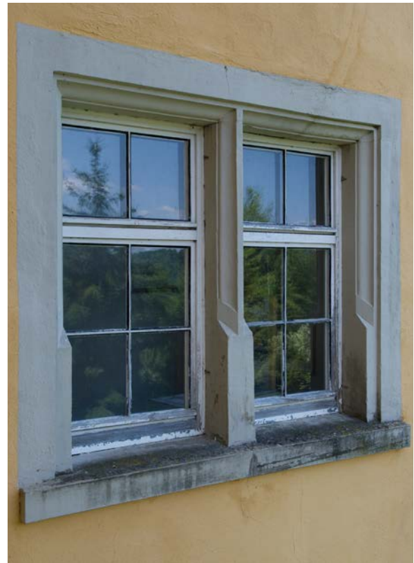
17 | EG, Mittelpfostenfenster (HbS-O-EG-F01) aus Bauphase II, Werksteinrahmen Typ A (Taf. XIVa) mit einseitig abgeschrägt auslaufendem Karniesprofil mit abgesetztem, einseitig abgeschrägten Auslauf (Juli 2017) | © Isabel Muehlhaus TUM
