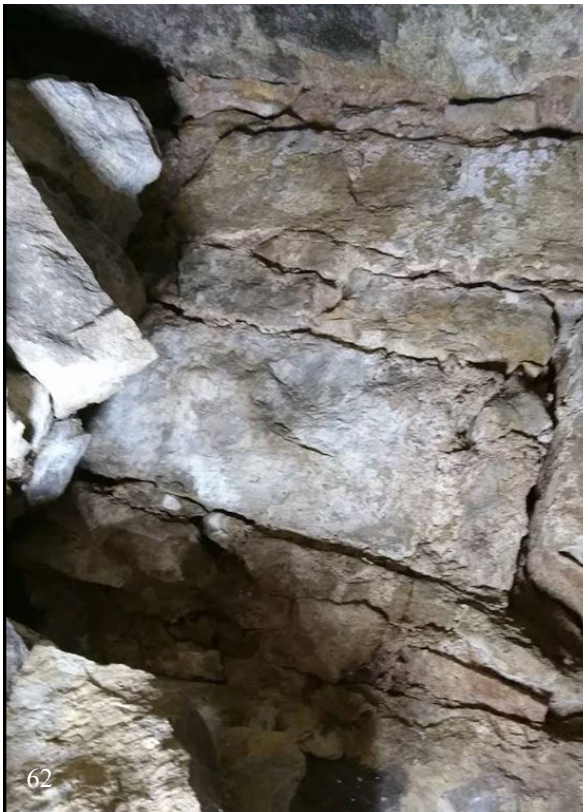
62 & 63 | Schlossgrabenmauer, Befundstelle 3: links (62) nördliche Wand der Schießnische, weitgehend regelmäßig geschichtetes Bruchsteinmauerwerk aus bruchrauen Kalksteinquadern kleinen und mittleren Formats, nach oben durch Deckenplatte begrenzt, rechts (63) stumpfer Anstoß der Deckenplatte gegen die Außenwand (Dez. 2016)
