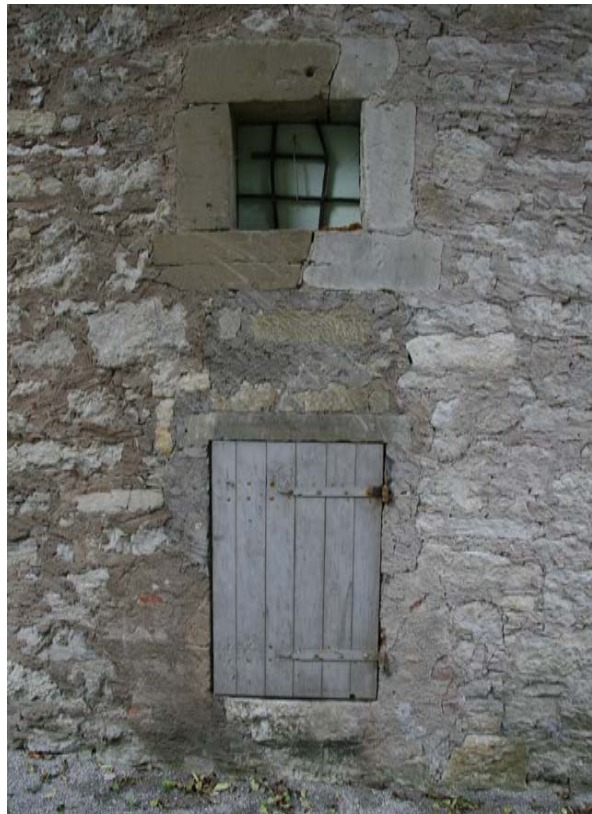
29 | Basteiturm West, 2. UG, Südfassade, Beobachtungsfenster mit schmiedeeisernem Gitter, Sandstein, zugehörige Steigbügelscharte durch Luke überformt (Okt. 2017)
