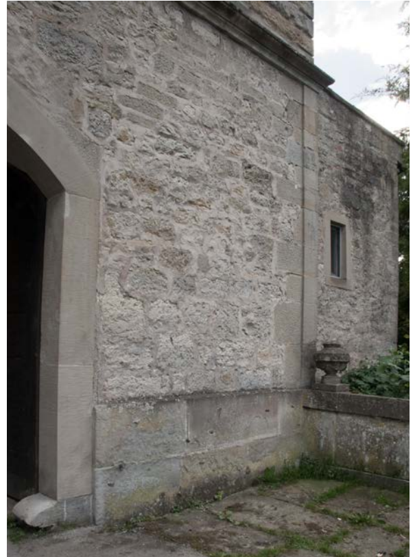
14 | Torbau, Nordfassade, Abschnitt westlich der Durchfahrt (Juli 2017)
