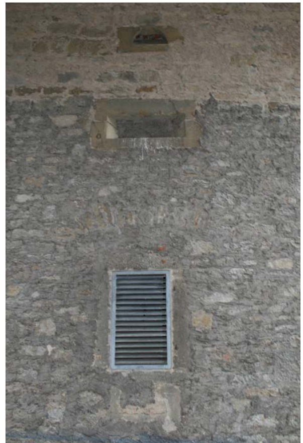
40 | Basteiturm Ost, Südfassade, ehem. Steigbügel- und Rechteckscharten im 1. & 2. UG (Okt. 2017)
