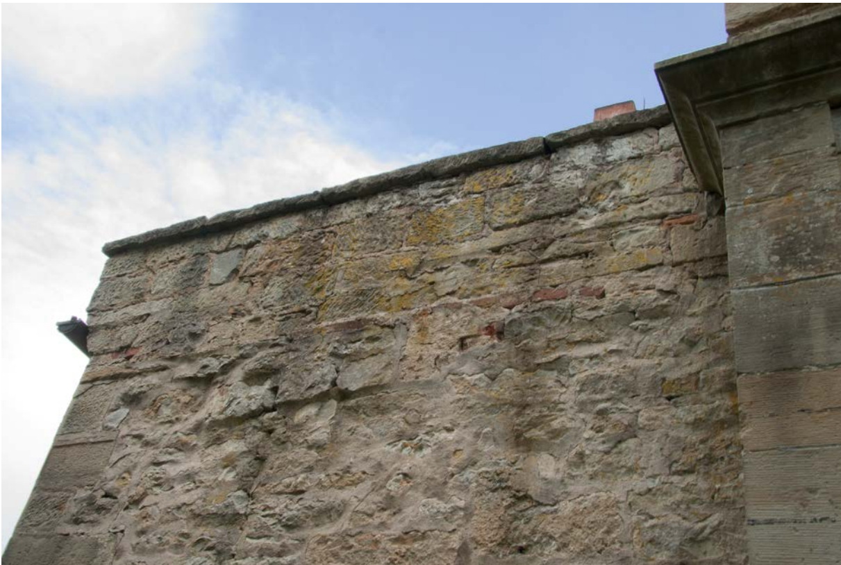
17 | Torbau, Nordfassade, nachträgliche Brüstungsaufmauerung über der östlichen Schmalseite, regelmäßiges Schichtenmauerwerk aus grob gespitzten Kalksteinquadern, ehemals mit figuriertem Blech verkleidet (a) (Juli 2017)
