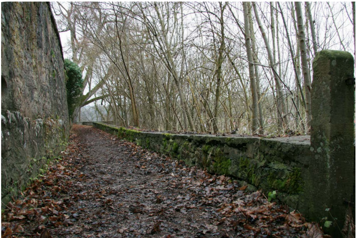
45 | Jetziges südliches Ende des Zwingers gegen Nordosten, Mauer begrenzt durch einen nachträglich aufgestellten Torpfosten (rechts), vermutlich im Rahmen von Terrassierungsarbeiten im 18./19. Jahrhundert geschleift (Dez. 2016)
