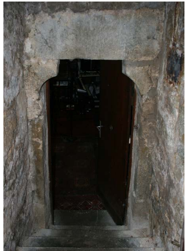
10 | Kellerhals unter dem Treppenpodest (Tu-W-Tr1) ins 1. UG, bauzeitlicher Werksteinrahmen (Tu-1UG01-Wd-T01) mit Schulterbogen aus Bauphase I.3 (Nov. 2012); Detail Sturzstein s. XI.11
