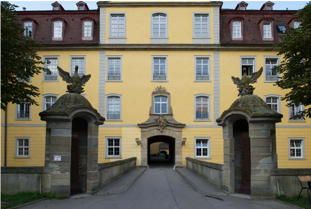
9 | Schlossbrücke gegen Norden mit Blick auf das barocke Schlossportal aus den Bauphasen IV.2a und IV.2c, im Vordergrund die beiden Schilderhäuser aus Bauphase IV.2a mit den bekrönenden Phönixfiguren des Bildhauers Nikolaus Ritter (Juli 2017); Detail der Phönixfiguren s. X.18 | © Isabel Mühlhaus TUM
