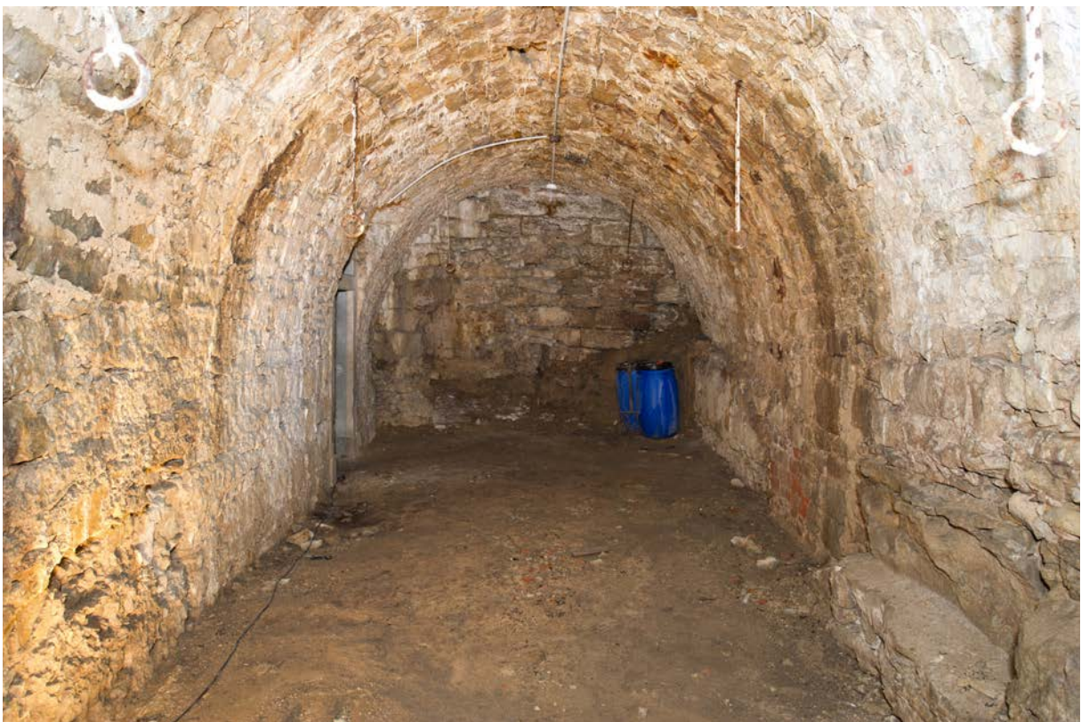
17 | Marstall, 2. Untergeschoss, kleines Kellergewölbe (Ma-2UG02) gegen Süden, Giebelwand entspricht wohl der ehem. äußeren Grabenwand des spätmittelalterlichen Schlossgrabens, Bruchsteinverband aus mittelgroßem, bruchrauen Kalkstein, hinten li. Zugang (Ma-2UG01-Wd-T02) vom großen Gewölbe (Okt. 2015) | © Isabel Muehlhaus TUM
