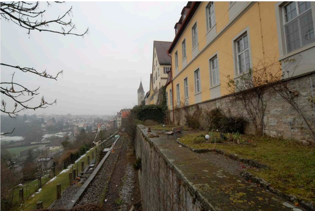
56 | Terrassengeräten hinter dem Witwenbau gegen Südwesten mit Blick auf den vorderen Stadtturm, als Grundmauer dient die mittelalterliche Stadtmauer (unregelmäßiger Schichtenverband aus unterschiedlich großen Kalkbruchsteinen mit Pietra-rasa-Verputz) (Jan. 2012)
