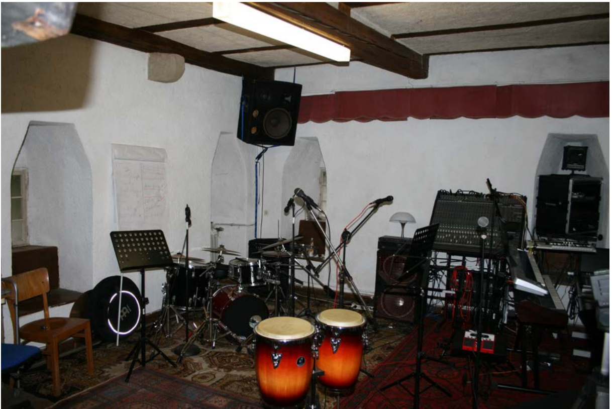
14 | 1. Untergeschoss (Tu-1UG01) gegen Nordosten mit je zwei Schießnischen in Nord- und Ostwand, das eiche-ne Deckengebälk wurde laut dendrochronologischer Datierung des nördlichen Streichbalkens nach 1634 eingezogen (Nov. 2012); Außenansicht s. XI.5 & 6
