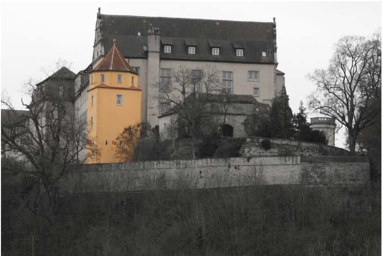
1 | Blick vom Tal gegen Südwesten auf den hinteren Schlosshof mit dem Turm auf der Ostseite (Nov. 2015)
