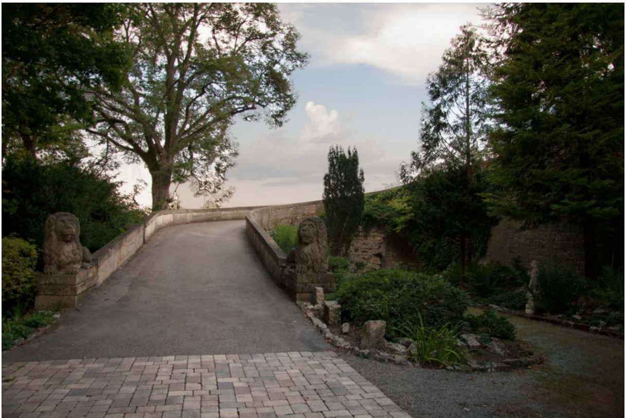
20 | Fahrweg, Ausgang am Ende des Neuen Wegs gegen Nordosten (Juli 2017); Detailansichten der flankierenden Löwen s. XII.21 & 22
