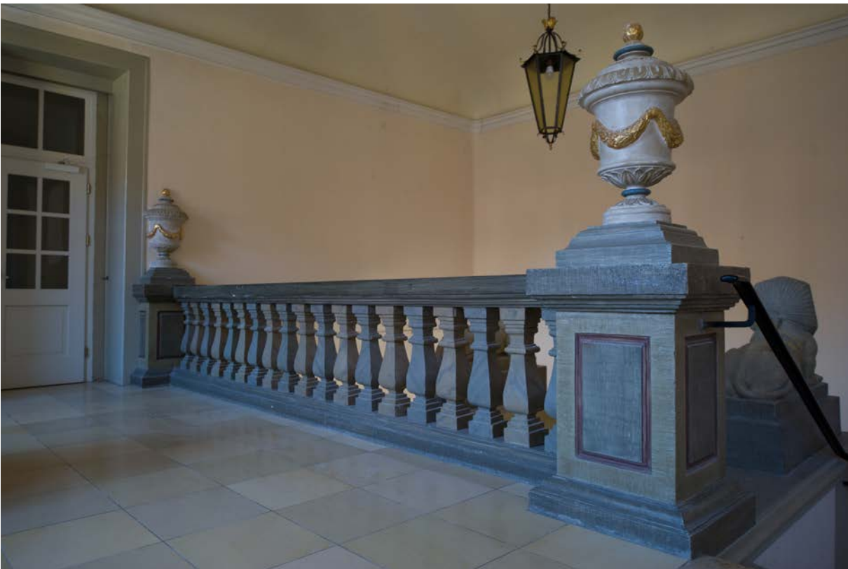
20 | Mansarde, Balustergeländer aus Bauphase IV.1b (ehem. Geländer des Galeriebaus Ost) als Absturzsicherung gegen das Treppenhaus, zweitverwendet beim Bau des Treppenhauses (HbW-Th1) in Bauphase IV.2c, Holz, polychrom gefasst (Juli 2017); Detail Baluster s. X.21, Detail Vase s. X.22 | © Isabel Muehlhaus TUM
