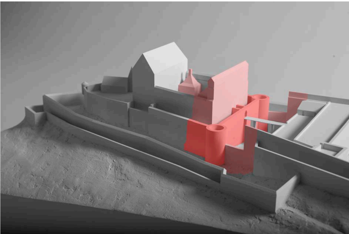
3 | Modell Burg Kirchberg mit Markierung der in Bauphase II abgerissenen Baukörper, darunter Teile der Burgzwingermauer und inneren Seitenmauern, die Schildmauer und das „vordere Haus“, das rückseitig an die Schildmauer lehnte, der Küchenturm nebst Kellerhals sowie der Großteil der äußeren Zwingieranlage; zum Modell s. XVIII.1a-e | © Isabel Muehlhaus TUM (bearb. LG)
