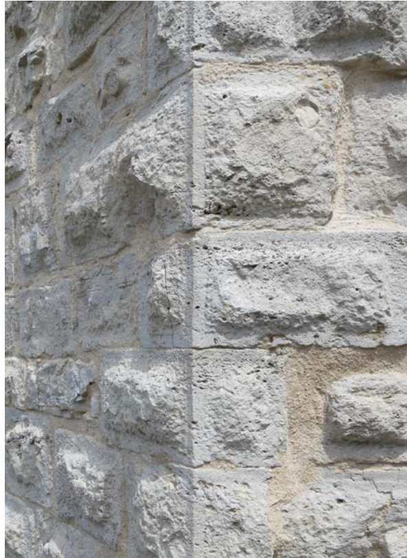
14 | Burg Leofels, Eckquaderung (NO-Ecke) mit bossierten Buckelquadern, um 1240/50 (Mai 2016)
