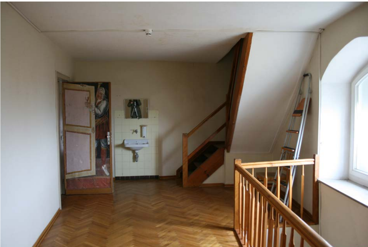
76 | Zwischengeschoss, Raum HbN-ZG04 hinter der Westempore gegen Süden, links Zugang (HbN-ZG04-Wb-T01) auf die Empore, hinten rechts Treppenaufgang (HbN-Tr4-ZG(1DG)) ins 1. Dachgeschoss (März 2013)
