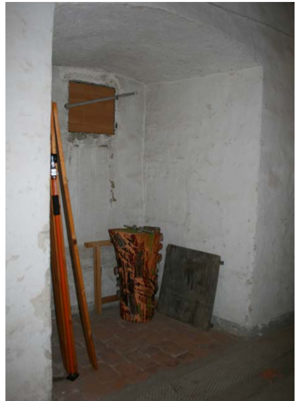
80 | 1. UG, Ostwand des Gangs (HbS-1UG01) in den Basteiturm Ost, ehem. Schießnische, Scharte zugesetzt (Jan. 2013); Außenansicht s. VII.19
