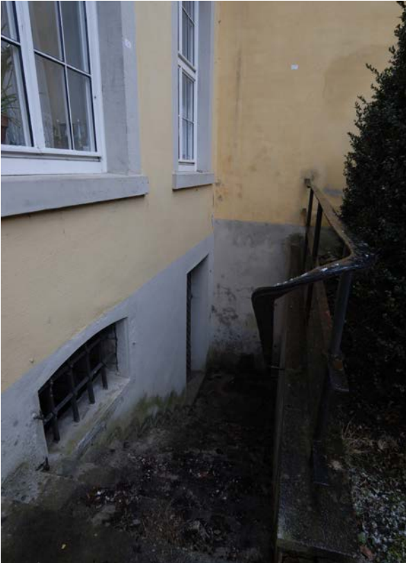
68 | Witwenbau, Außentreppe (Wi-Tr3-EG(1UG)) am Anbau gegen Südosten, erschließt die Kellergewölbe im 1. und 2. UG, 1961 anstelle des ursprünglich ebenerdigen Zugangs errichtet (s. XVII.17) (März 2012)
