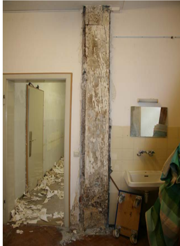
16 | EG, Holzsäule an der Südwand des Eckraums HbO-EG06 vtl. aus Bauphase IV.1b als Teil der ehem. Säulenhalle (Okt. 2017)
