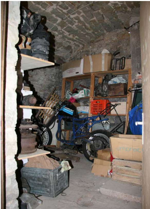
72 | Witwenbau, 1. UG, oberes Kellergewölbe (Wi-1UG04) gegen Norden (Okt. 2015)
