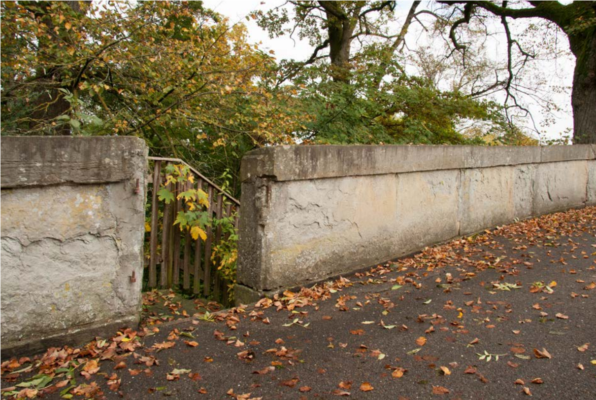
27 | Fahrweg, Zugangstür zur ehem. Aussichtsterrasse auf der barocken Terrassierung (Okt. 2017)
