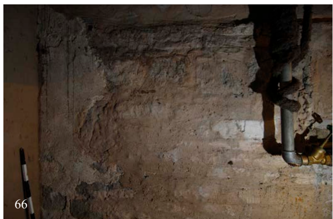
65-67 | Witwenbau, 1. Untergeschoss, rechts (65 & 66) Südwand des Technikraums (Wi-1UG03), historischer Mauerwerksverband, regelmäßiges Schichtenmauerwerk aus mittelgroßen, grob gespitzten Kalksteinquadern, verlängert die Nordwand der östlich angrenzenden, ehem. „Metzlerkammer“, bei der Einrichtung der technischen Versorgung nach 1954 überformt, links (67) Nordwand mit Blick auf den Technikgang (Wi-1UG03a) durch die südliche Halsgrabenwand (März 2012)
