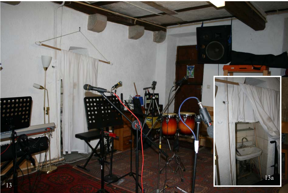
13 & 13a | 1. Untergeschoss (Tu-1UG01) gegen Südwesten, im Hintergrund der Eingang (Tu-1UG01-Wd-T01) vom hinteren Schlosshof, im Detail (13a) die westliche Schießnische der Südwand, durch die Errichtung der Seitenmauer in Bauphase III.1b von außen geschlossen, im 20. Jahrhundert überformt (Nov. 2012); Außenansicht s. XI.7
