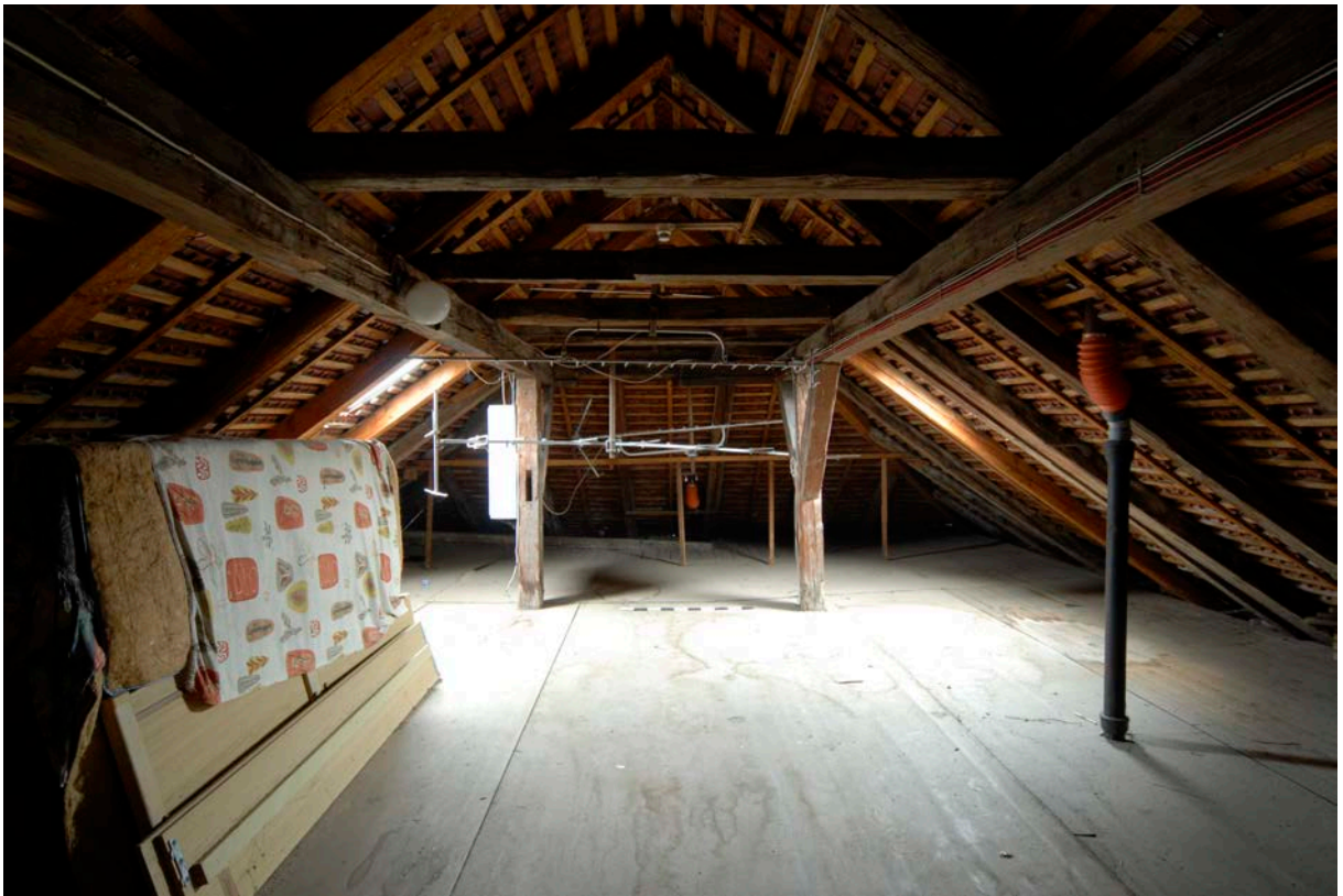
97 | Witwenbau, 2. Dachgeschoss gegen Norden, Kehlbalkendach mit stehendem Stuhl (Jan. 2012)
