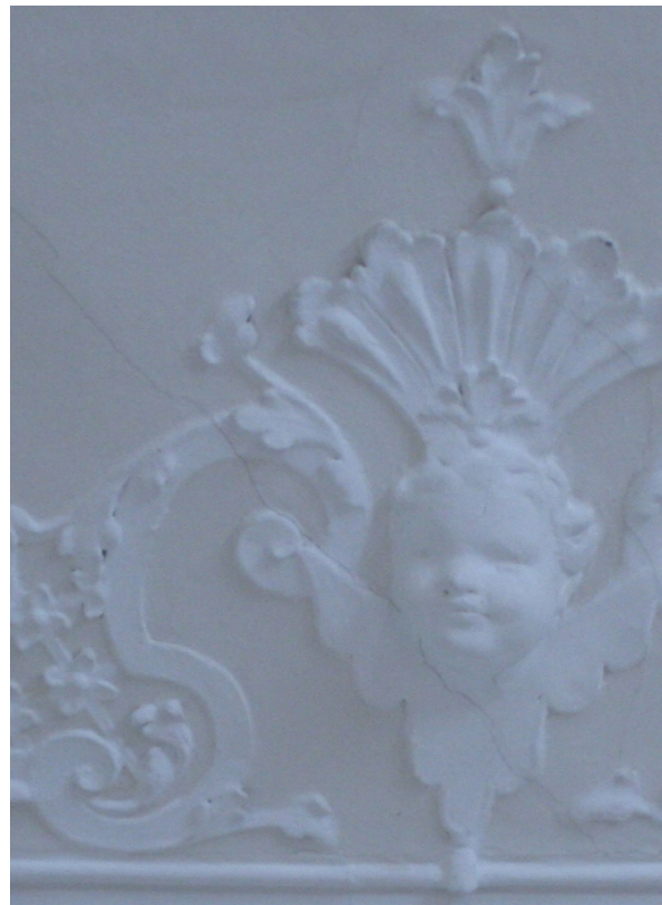
89 | Witwenbau, 1. OG, bauzeitliches Stuckwerk über der Ofennische im ehem. herrschaftlichen Tafelzimmer (Wi-1OG10) (Apr. 2012)
