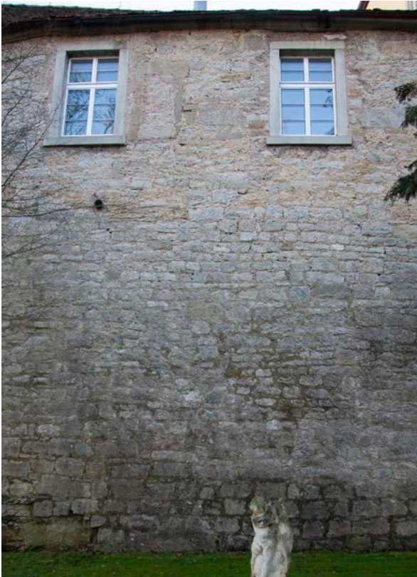
3 | Remise, Rückansicht, leicht geböschtes, unregelmäßiges Schichtenmauerwerk aus grob gespitzten Kalksteinquadern kleineren und mittleren Formats (Jan. 2018)
