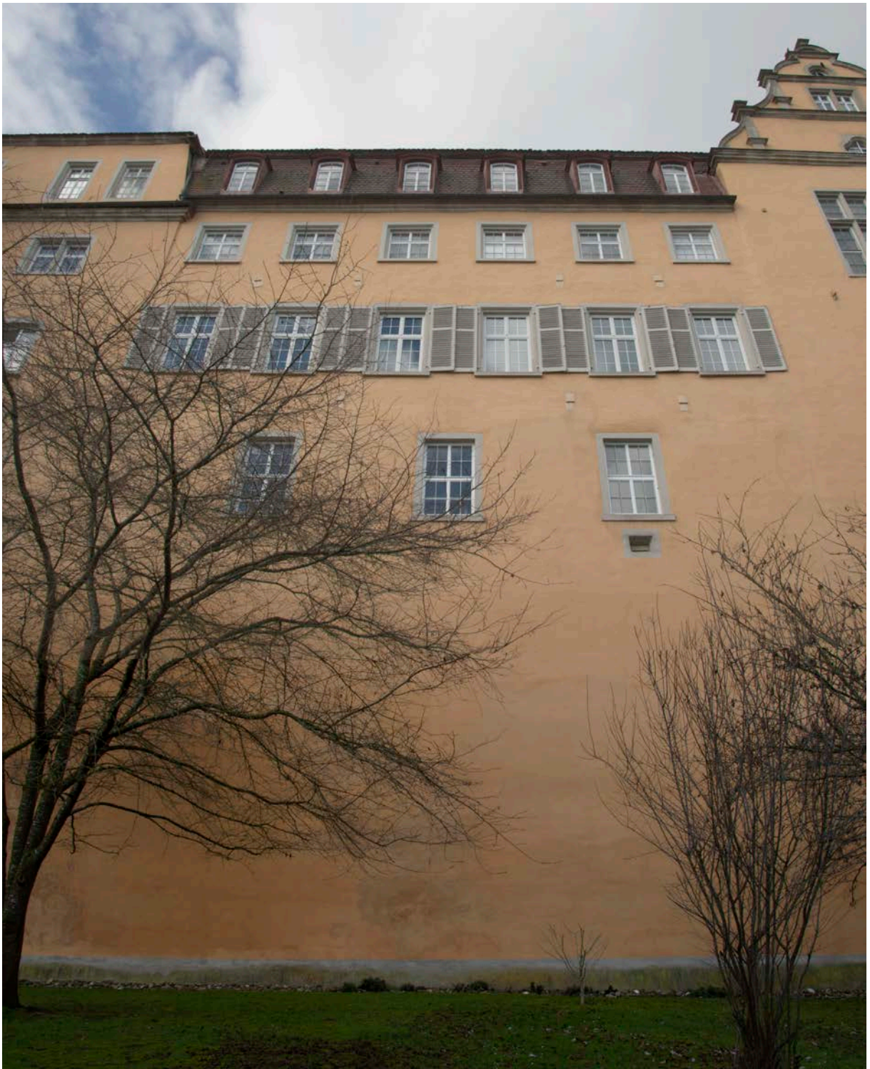
1 | Ostfassade gegen Nordwesten mit Blick auf die Seitenmauer aus Bauphase III.1b, Ende 18. Jahrhundert verputzt und gestrichen (s. IV.6) (Jan. 2018)
