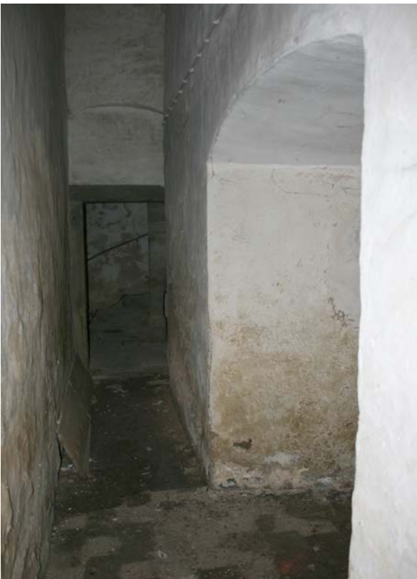
84 | 2. UG, Gang (HbS-2UG01) in den Basteiturm Ost gegen Norden, rechts Ausgang (HbS-2UG01-Wb-T02) in den östlichen Schlossgraben (Außenansicht s. VII.18), vor Kopf Kellertreppe (s. VII.85) ins Erdgeschoss (Jan. 2013)
