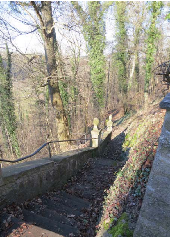
22 | Neuer Weg, südlicher Ausgang auf den Hirschberg gegen Norden, zweiläufige, gerade Treppe mit Zwischenpodesten (Feb. 2014)
