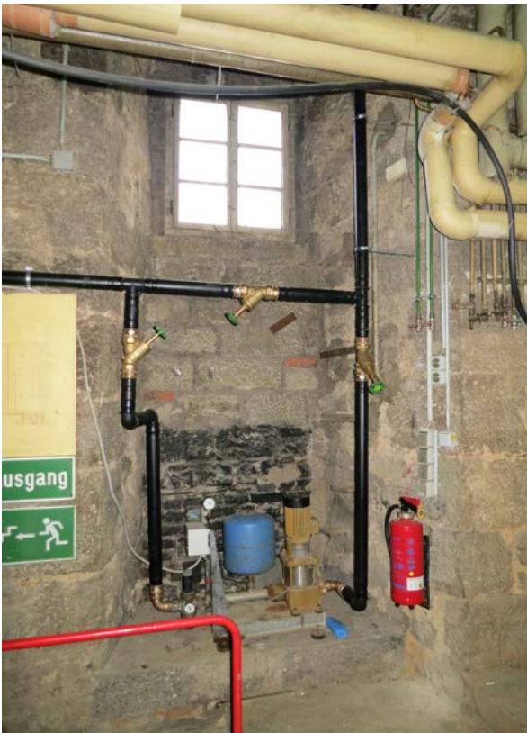
16 | 2. UG, südliche Schießnische (HbN-O-2UG-F04) in der Ostwand des großen Gewölbekellers (HbN-2UG01), mit der Seitenmauer in Bauphase III.1b angelegt, im 20. Jh. überformt (Nov. 2015)
