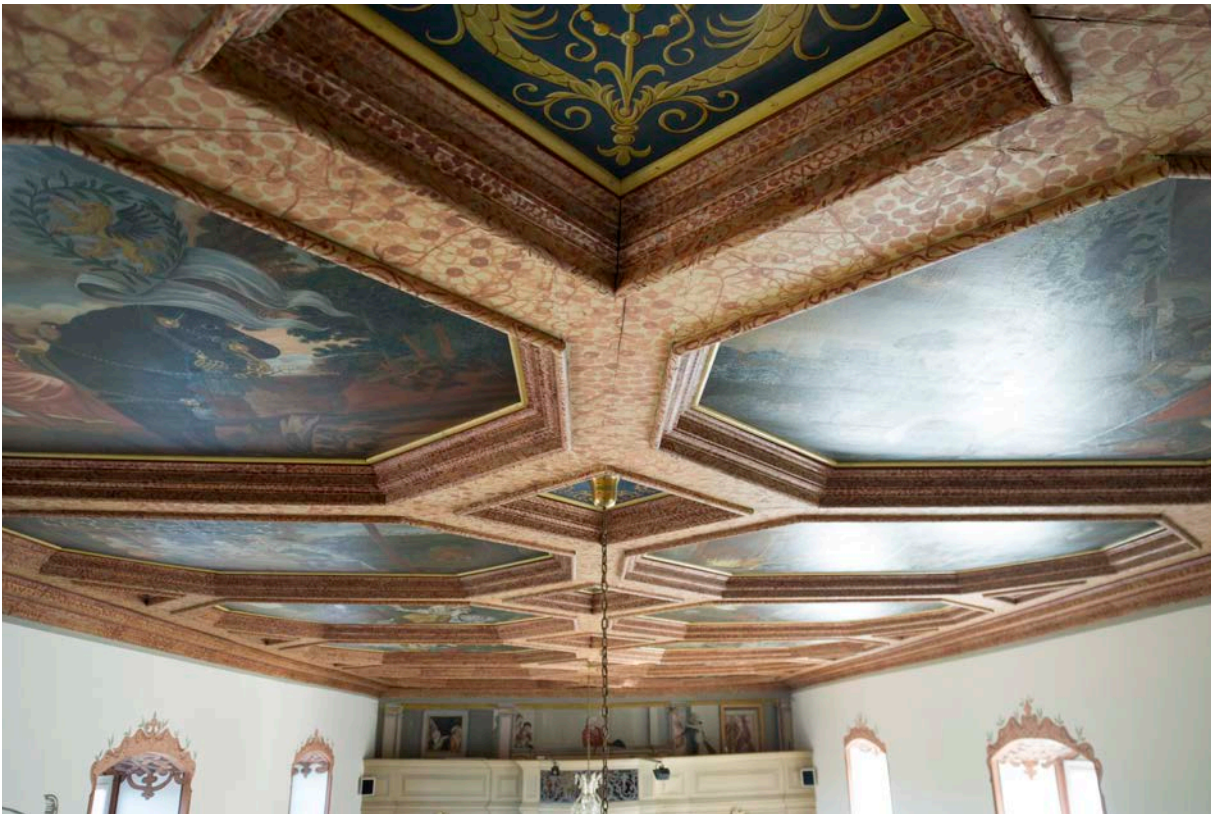
71 | Kassettendecke (ca. 9 x 21,50 m) aus Bauphase III.4 über dem Saal (HbN-2OG01), Holz, um 1682 marmoriert durch den Rothenburger Maler Leonhard Wilhelm Kreß, beim Einbau der Emporen in Bauphase IV.2b auf der Ostseite um zwei Reihen gekürzt, Gemälde nach dem Zweiten Weltkrieg abgenommen und 1978/79 durch Kopien ersetzt (Juli 2017); Detail Gemälde und Holz marmorierung s. VIII.72 | © Isabel Muehlhaus TUM
