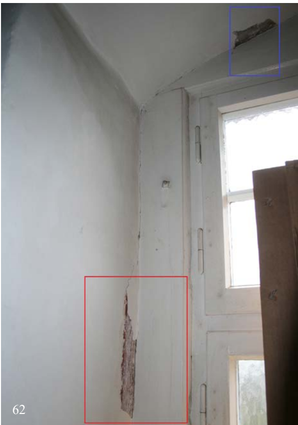
62-64 | 2. Obergeschoss, ehem. Abort (HbW-2OG05), südliche Fensterlaibung (HbW-W-2OG-F06) mit Resten einer rot modulierten Farbfassung als oberste Fassung unter der modernen Tünche (63 & 64) (Jan. 2013); vgl. entsprechende Befunde am Türrahmen des ehem. Aborts im 1. OG s. X.51-53
