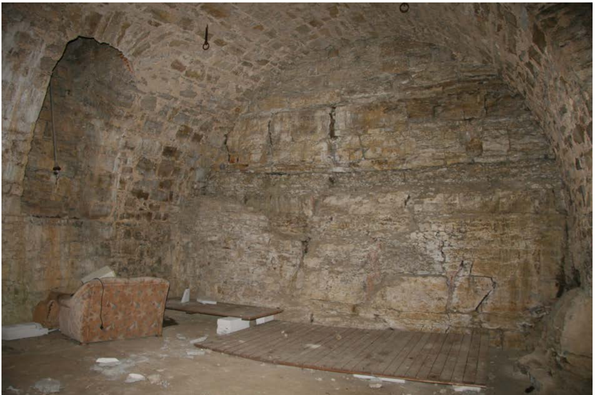
79 | Witwenbau, 2. Untergeschoss, großes Kellergewölbe (Wi-2UG01) gegen Nordwesten, die Giebelwand entspricht der Grabenwand des ehem. äußeren Schlossgrabens, zugleich Stirnmauer des ehem. Walls, regelmäßiges Schichtenmauerwerk aus großformatigen Kalksteinquader auf hohem Felssockel (Okt. 2015)
