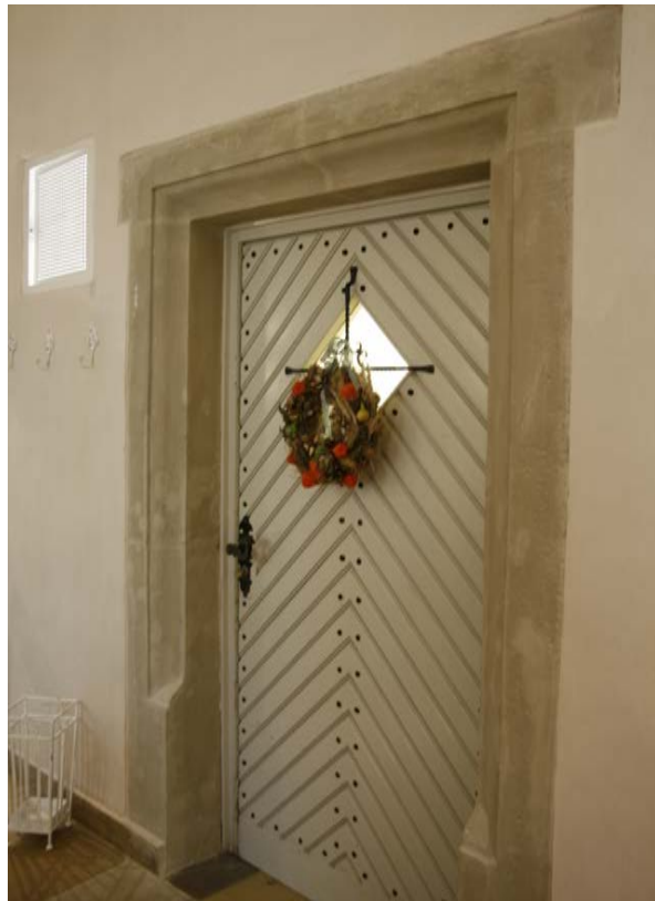
47 | EG, Zugangstür in die ehem. Speisekammer (HbS-EG08-Wa-T01) mit Werksteinrahmen vom Typ B (Taf. XIVb) aus Bauphase II (Okt. 2017)
