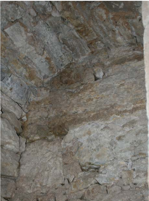
34 | 2. UG, Nordwestecke Raum HbN-3UG01, Detail stumpfer Gewölbeanschluss an die Südwand des Turms (Nov. 2012)
