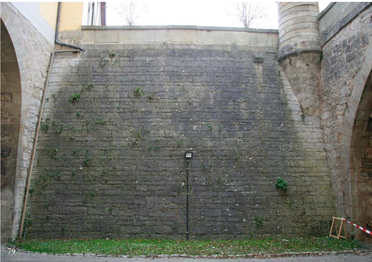
78 & 79 | Mantelmauern an der südlichen Halsgrabenwand, ursprünglich errichtet in Bauphase II durch den Mauermeister Jakob Kaufmann, später mehrfach verändert zuletzt beim Bau der Schlossbrücke 1788 überformt (Okt. 2017)
