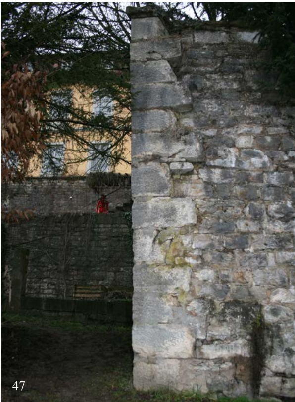
47 & 48 | Südostecke der Schlossgrabenmauer mit Detail (48 | Okt. 2017) der Eckquaderung aus Kalksteinquadern mittleren Formats mit grob gespitzter Spiegelfläche innerhalb eines umlaufenden Randschlags (Jan. 2013); vgl. formgleiche Eckquaderung an der Nordwestecke XVI.34
