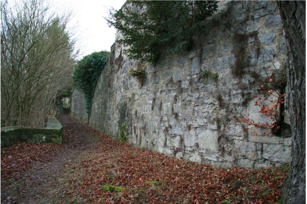
37 | Schlossgrabenmauer auf Höhe der kleinen Bastion oberhalb des Jagstübergangs gegen Südwesten (Dez. 2016)
