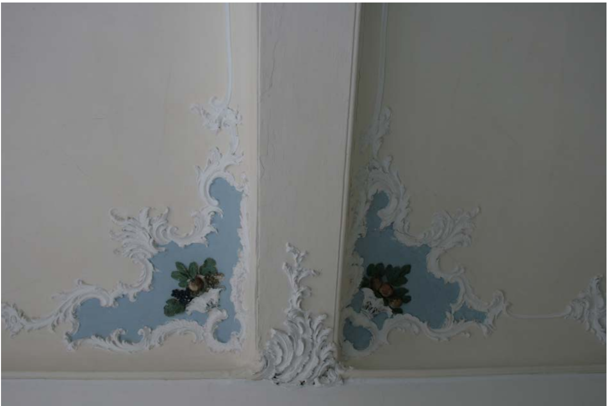
107 | 2. Obergeschoss, ehem. Graues Kabinett (HbS-2OG06), Detail Deckenstück im Bereich des Unterzugs mit „Schilden“ (Eckkartuschen) und „Konsolen“ (Rocailles am Unterzug), gefertigt 1757 von Franz Oeder, 1760 „auf Porzellan-Art“ gefasst von Johann Friedrich Flühmann, später wohl überarbeitet (Okt. 2012)
