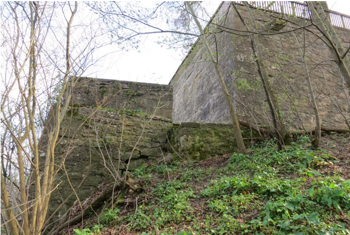
28 | Zugang in den Zwinger an der Spornspitze im Bereich der ehem. Eckbastion mit vorgelagerter Fundamentierung (s. XVI.27), die den Anschluss an den Neuen Weg gewährleistet, rechts barocke Terrassierung zur Planierung des Neuen Wegs, die auf der Außenmauer der ehem. Eckbastion gründet und als Aussichtsplattform diente, Blick gegen Südosten (Dez. 2016)
