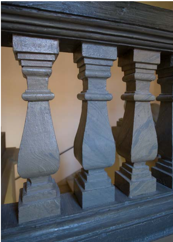
21 | Mansarde, Baluster aus Bauphase IV.1b, Holz, bunt marmoriert (Juli 2017); Gesamtansicht Geländer s. X.20 | © Isabel Muehlhaus TUM
