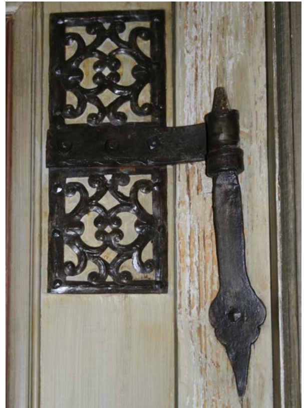
49 | 2. OG, ehem. Kammer (Tu-2OG02), schmiedeeisernes Türscharnier mit Langband am rechten Holm der Eingangstür (Tu-2OG02-We-T01), Detail der wandfesten Ausstattung aus Bauphase IV.2b (Nov. 2012)
