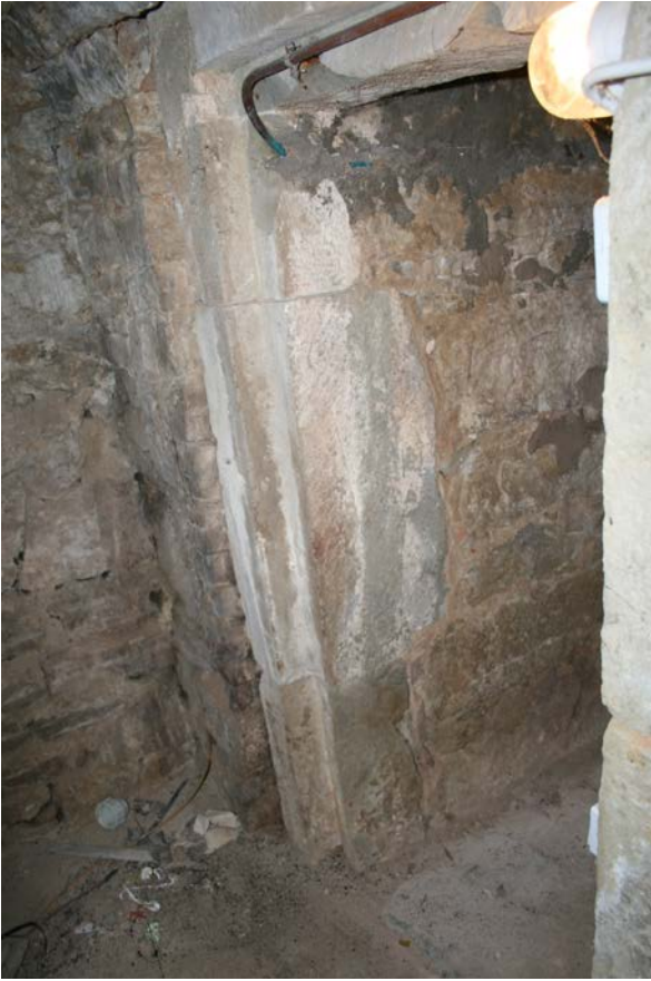
32 | 2. UG, Raum HbN-3UG01 gegen Nordosten, Durchgang (HbN-3UG01-Wb-T01) zu HbN-3UG01a mit innen liegendem Türanschlag (Nov. 2012)
