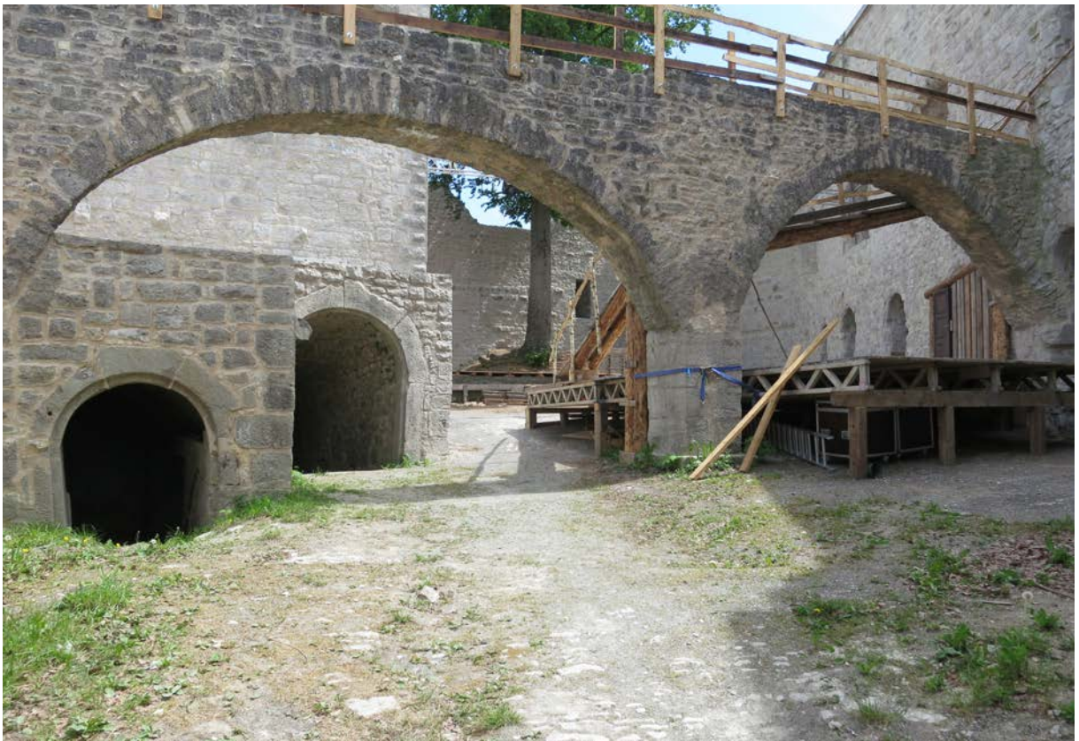
12 | Burg Leofels, Innenhof gegen Südosten mit Blick auf die Kellerhalse, die zwei große Gewölbekeller unter dem ehem. Palas erschließen (Mai 2016)
