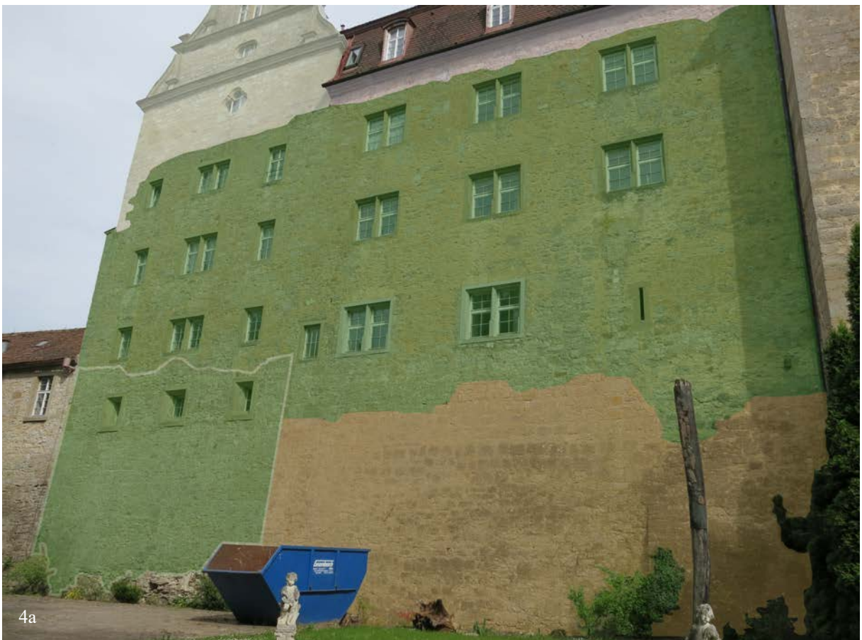
4 & 4a | Kernbau im Bereich von Saalbau und Galeriebau West gegen Osten mit Blick auf die östliche Seitenmauer aus Bauphase III.1b, unten (4a) mit Bauphasenkartierung gemäß Farblegende der Baualterspläne (Taf. II-VIII) (Mai 2016)
