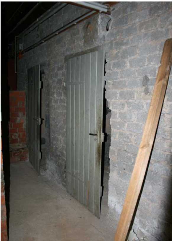
21 | 2. UG, zwei Kammern (HbN-2UG02a & 2b) im hinteren Teil des großen Gewölbekellers (HbN-2UG02) gegen Nordwesten, zw. 1954 und 1962 abgeteilt (Nov. 2012)
