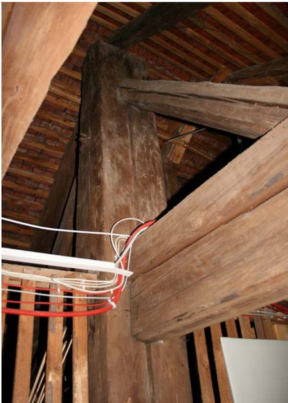
120 | 2. DG, Detail Hängewerk (Jan. 2013)
