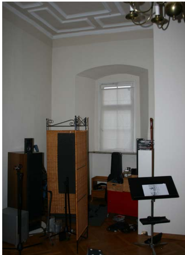
43 | 1. OG, Stube des ehem. Stubenappartement (Tu-1OG02) gegen Süden mit Blick auf das Fenster (Tu-S-1OG-F03) in der Südwand (Nov. 2012)
