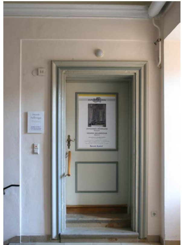
65 | Mansarde, Nordwand Treppenhaus (HbW-1EG01), Zugang zu den Wohnräumen im nördlichen Teil des Galeriebaus West, Durchgang später verkleinert (Nov. 2012)
