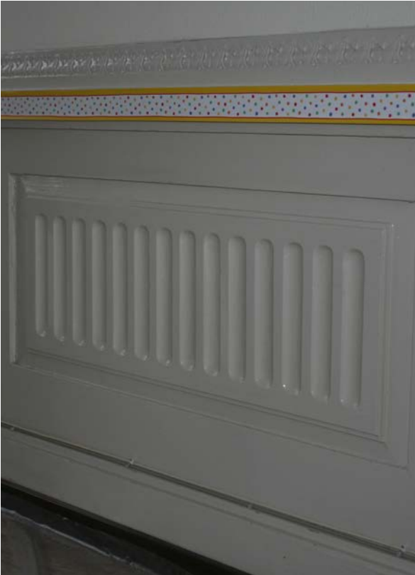
102 | 2. OG, ehem. Gelbe Stube (HbS-2OG04), Detail der klassizistischen Sockellamperie von 1806 an der Westwand (Jan. 2013); Detail Blattfries s. VII.103
