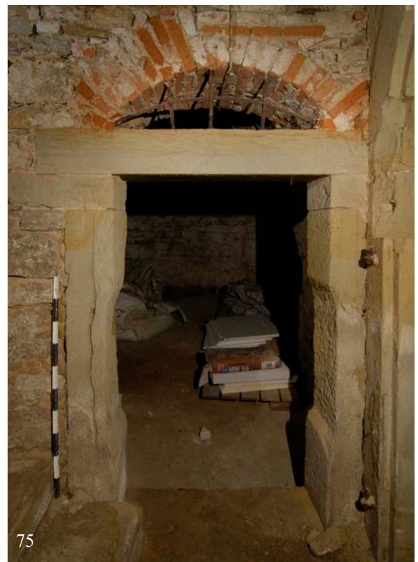
75 | Witwenbau, 2. UG, Zugang in den ehem. Weinkeller (Wi-2UG02-Wb-T01), Sandsteinrahmen mit geradem Sturz, vergittertem Oberlicht und seitlichen Fassausbuchtungen (März 2012)
