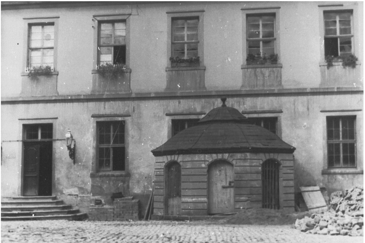
16 | Schloss Kirchberg, Ehrenhof, Brunnenhaus vor dem Witwenbau im bauzeitlichen Zustand von 1751, Fotografie, 1. Hälfte 20. Jahrhundert | © Landesamt für Denkmalpflege im Regierungspräsidium Stuttgart
