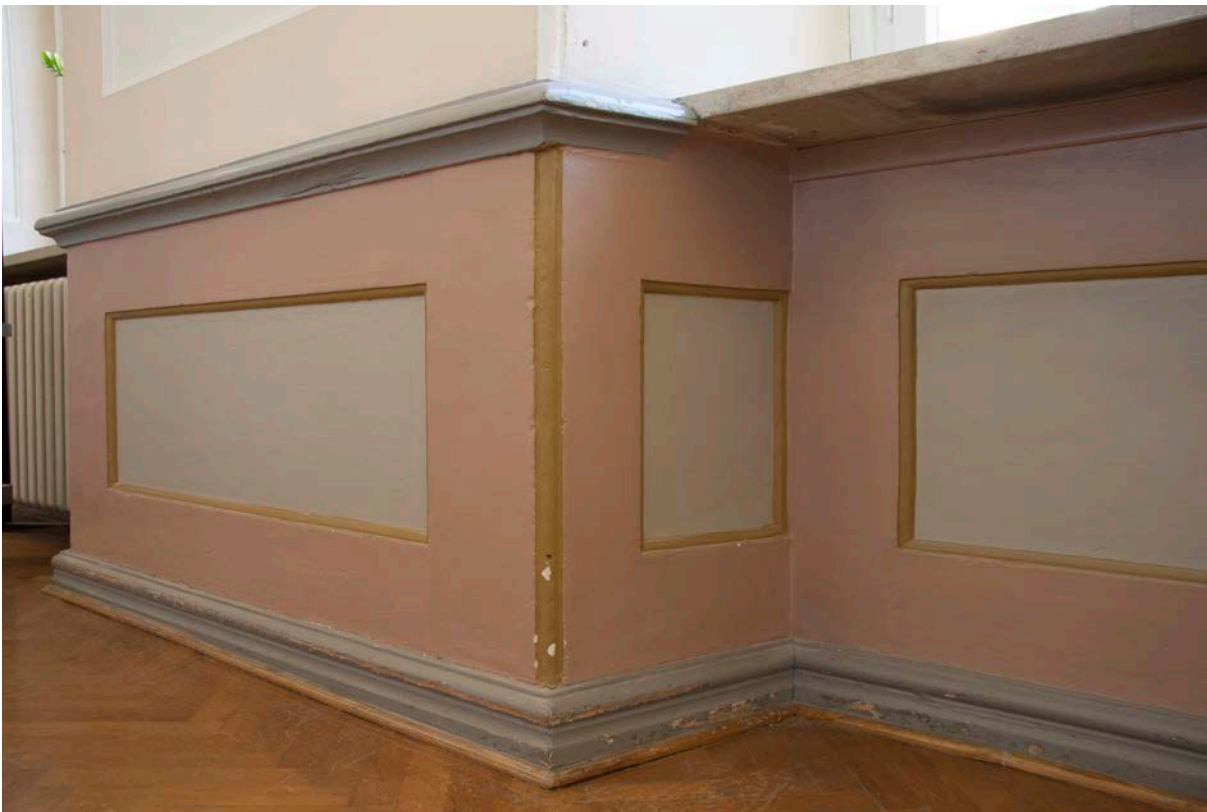
56 | 2. Obergeschoss, gefelderte Lamperie mit profilierten Leisten und Viertelstäben an der Ostwand des Gangs (HbW-2OG02) im Bereich des ehem. Saalvorzimmers, Holz, polychrom gefasst, wohl aus Bauphase IV.2c (Juli 2017)
