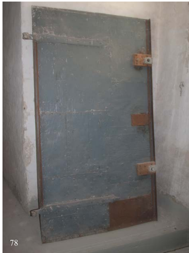
77 & 78 | 1. Untergeschoss, Zugang (HbS-1UG01-Wa-T01) zum Gang in den Basteiturm, Werksteinrahmen aus Bauphase II , links (77) mit Blick auf die Kellertreppe (HbS-Tr1-EG(2UG)), im Vordergrund Innenseite des Werk-steinrahmens vom Typ B (Taf. XIVb) aus Bauphase II mit schmiedeeisernen Kloben zur Aufhängung des Türblatts (78) (Okt. 2017)
