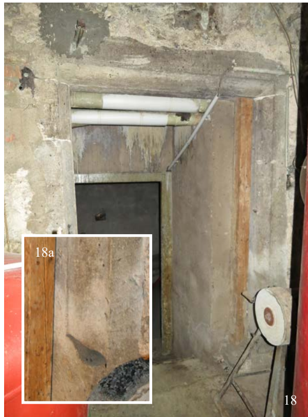
17, 18 & 18a | 2. Untergeschoss, Zugang (HbN-2UG01a-Wa-T01) vom großen Gewölbekeller unter dem Saalbau in der Südwestecke mit Werksteinrahmen (18) Typ B (Taf. XIVb) aus Bauphase II mit Karniesprofil und einseitigem Auslauf mit Karnies, in Bauphase III.1b zweitverwendet, Treppenabsatz (17) modern (Nov. 2012/15); Vergleichsbeispiel Werksteinrahmen s. VII.48
