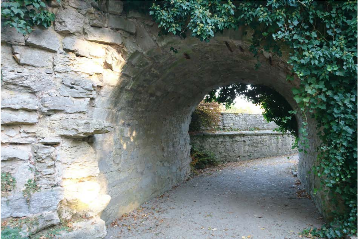
29 | Durchgang im Fundament des Fahrwegs, Blick gegen Osten in den östlichen Grabenabschnitt (Okt. 2018); Gesamtansicht Fundament s. XIV.28
