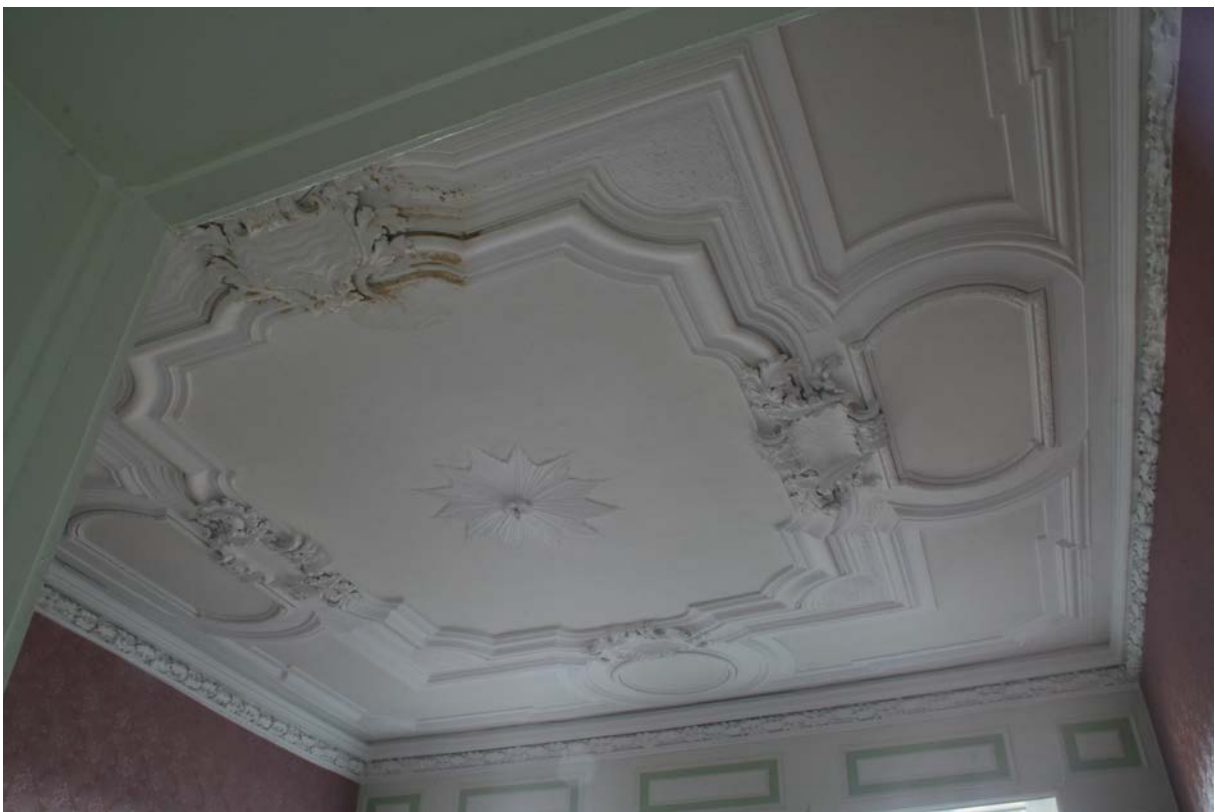
25 | 1. Obergeschoss, bauzeitliche Stuckdecke aus Bauhase IV.1b über dem ehem. Vorgemach (HbO-1OG05), um 1709 gefertigt von zwei italienischen Stuckateuren (Nov. 2012)
