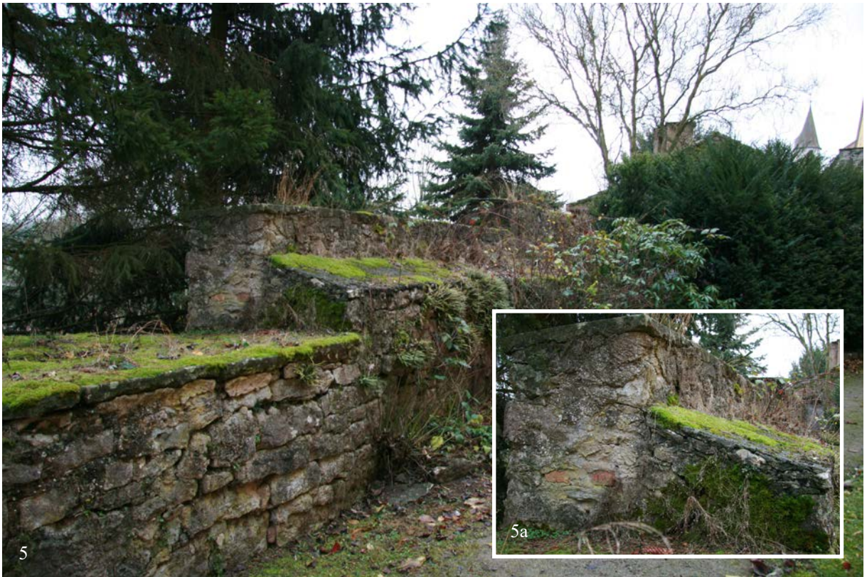
5 & 5a | Östlicher Schlossgraben, südlicher Abschnitt der Schlossgrabenmauer auf Höhe des ehem. Waschhauses, im Detail (5a) die teilgeschleifte Brustmauer, die die Außenseite der Grabenmauer einst umlaufend bekrönte (s. auch XVI.6) (Dez. 2016)
