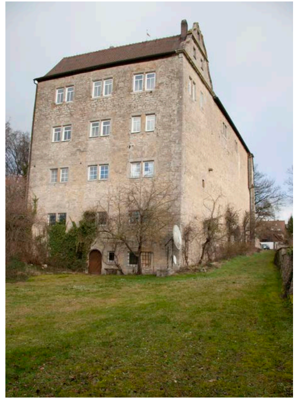
27 | Schloss Hornberg gegen Nordosten mit Blick auf den ehem. Palas (bez. 1599) (Jan. 2018)
