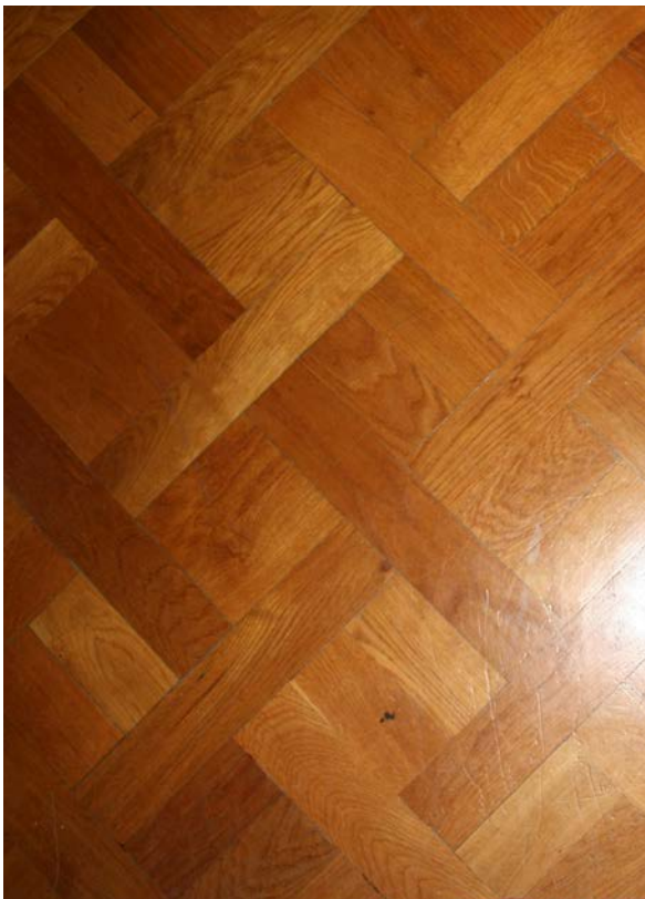
19 | EG, ehem. Nachtischstube (HbO-EG09), historisches Tafelparkett mit Flechtmuster anstelle des bauzeitlichen Plattenbodens (Nov. 2012)
