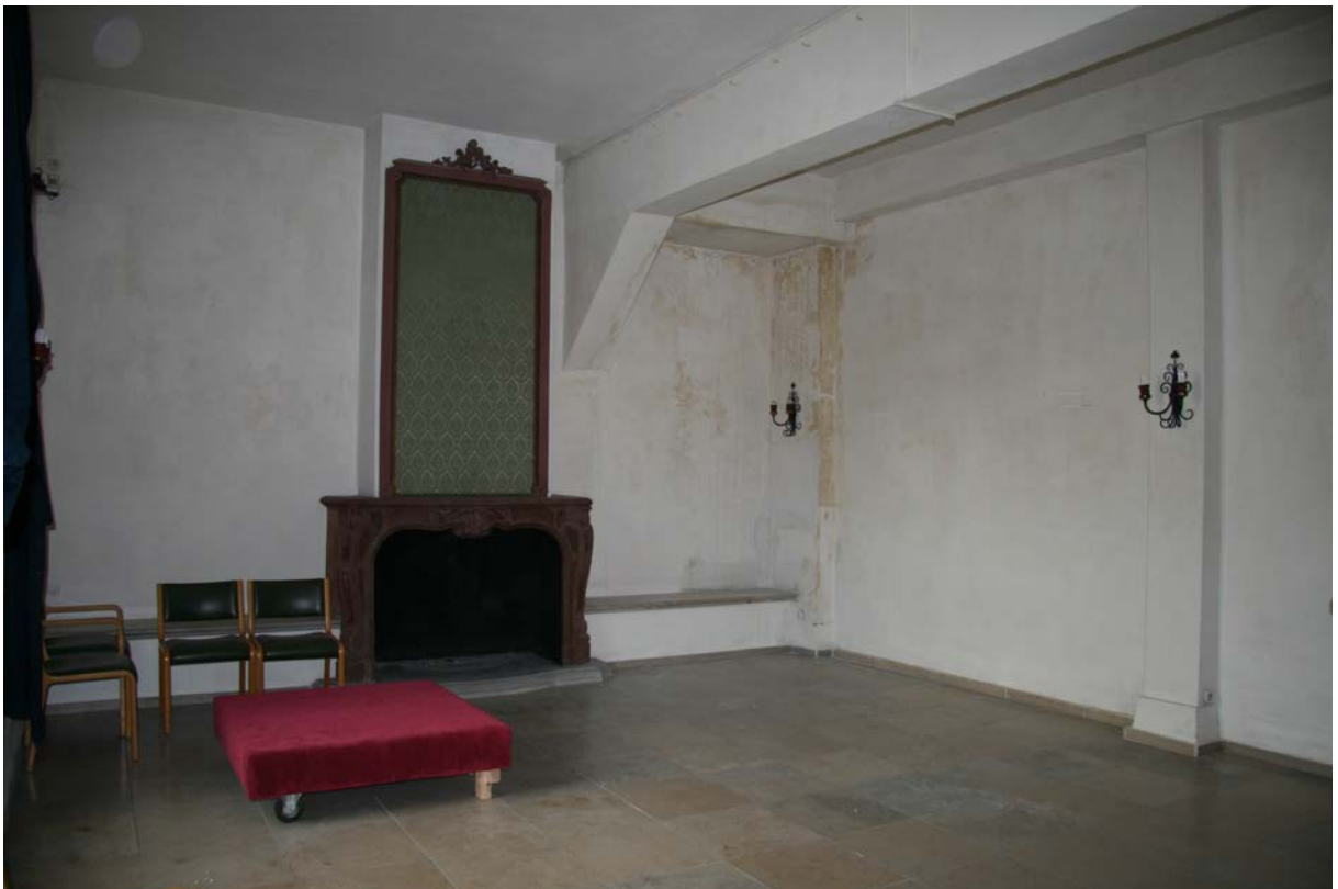
48 | Erdgeschoss, „Stube“ (HbN-EG09) gegen Südosten, beim Umbau 1954 gegen Süden und Westen von der ehem. Halle abgeteilt, dabei das Pfeilerpaar unter dem nördlichen Unterzug entfernt und der Kamin an der Ostwand nachgerüstet (Provenienz des barocken Kaminmantels nicht bekannt) (Okt. 2017)
