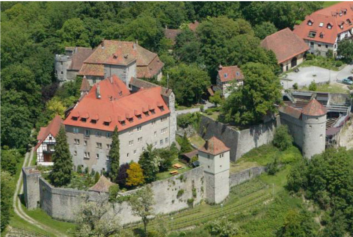
18 | Schloss Stetten, Schildmauerburg, um 1200, äußerer Halsgraben und Zwingieranlage mit halbrunden Flankierungstürmen, um 1400 ergänzt, rechteckige Türme im mittleren 15. Jh. angefügt, Luftbild gegen Nordosten (Juni 2007) | © OfficevonStetten / https://creativecommons.org/licenses/by/3.0/de/deed.de (Originaldatei nicht bearbeitet, s. https://commons.wikimedia.org/wiki/File:Luftbild_Schloss_Stettenklein.jpg?uselang=de [6.10.2022])
