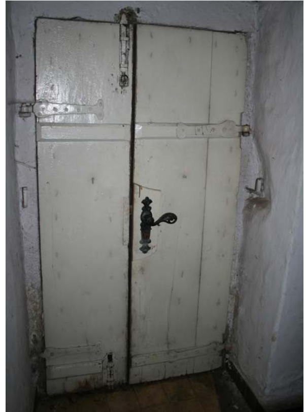
26 | EG, Flur (Tu-EG01), Eingangstür (Tu-EG01-Wd-T01) mit barocken Türblatt und -bändern und seitlicher Aussparung wohl zur Armierung eines Holzriegels (Nov. 2012)
