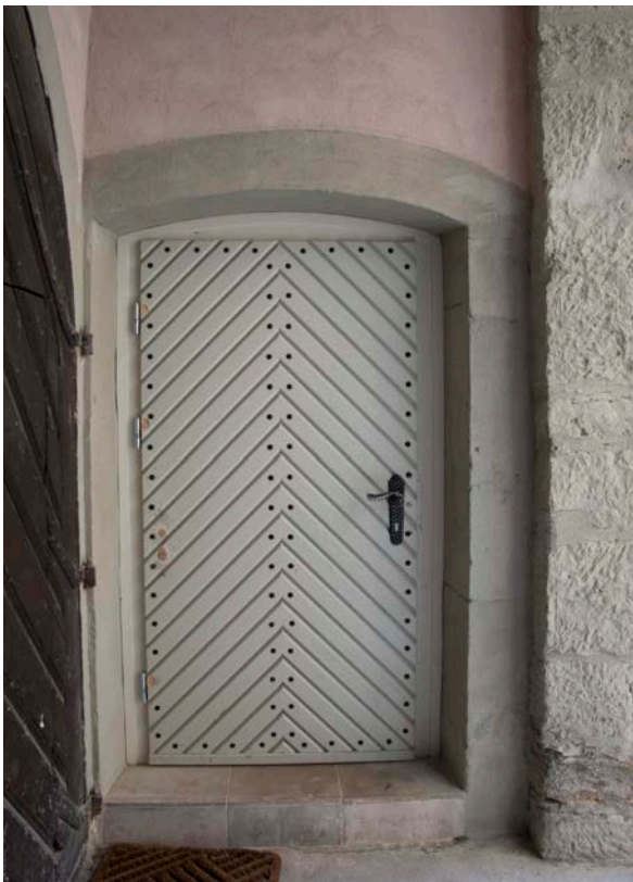
6 | EG, Vorraum (HbO-EG00) gegen Süden, Eingang (HbO-EG00-Wc-T02) in die ehem. Gesinderäume, Werksteinrahmen aus Bauphase IV.2c, 1961 zugesetzt, 2017 reaktiviert (Jan. 2018)
