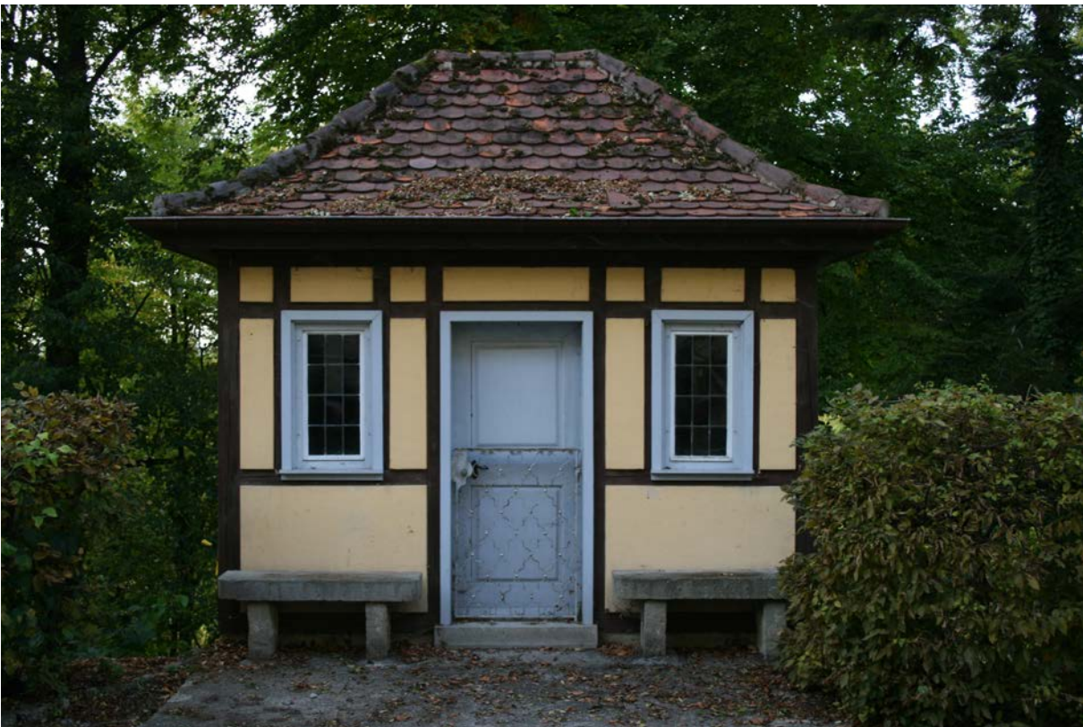
18 | Neuer Weg, barockes Gartenhaus aus dem mittleren 18. Jahrhundert, das für den Garten des Hofrats Hochheimer an der Lendsiedler Straße geschaffen wurde, Fachwerkbau mit Walmdach, im Innern von Johann Valentin Tischbein mit Ideallandschaften ausgemalt (s. XVI.19), Mitte 20. Jh. an den Neuen Weg versetzt (Okt. 2012)
