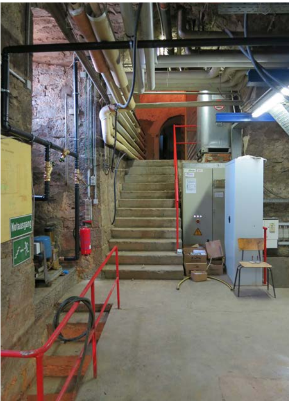
12 | 2. UG, großer Gewölbekeller (HbN-2UG01) unter dem Saalbau, Blick zur Kellertreppe gegen Süden, unterer Treppenlauf 1954 anstelle der bauzeitlichen Treppe aus Bauphase III.1b errichtet (Nov. 2015)
