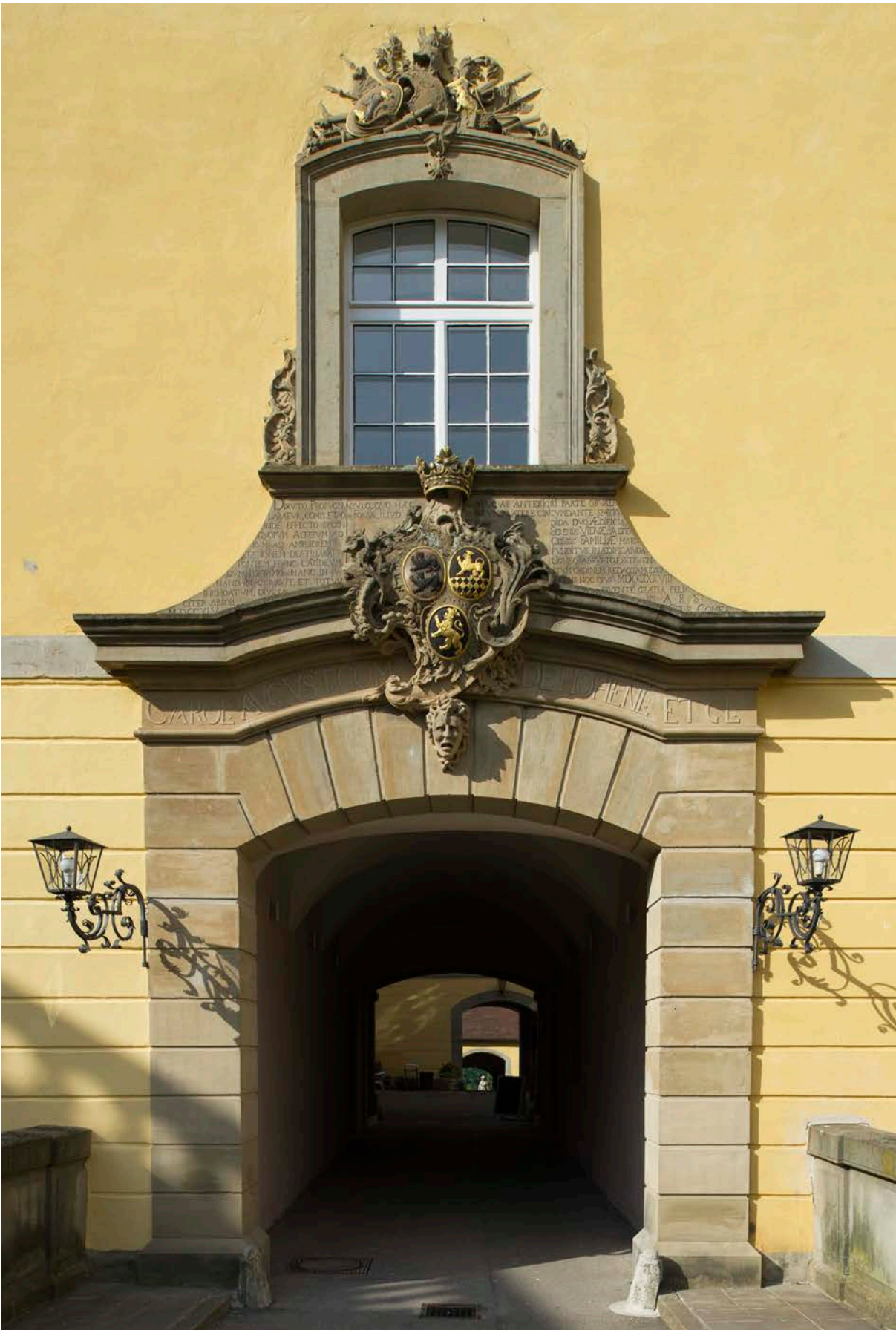
41 | Hofdurchfahrt gegen Norden mit barocken Schmuckportal, Sandstein, partiell gefasst und vergoldet, gefertigt in den Bauphasen IV.2a & 2c von Nikolaus Ritter nach einem Entwurf von Johann Valentin Tischbein (Juli 2017); Details s. VII.42-44, zu den Entwürfen s. VII.124 & 125 | © Isabel Muehlhaus TUM
