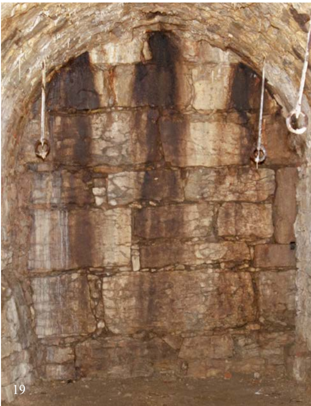
19 & 20 | Marstall, nördliche Giebelwand des kleinen Kellergewölbes (Ma-2UG02), entsprach Südwand des spätmittelalterlichen Torturms aus Bauphase I.3, in Bauphase IV.2a abgebrochen, links (19) Gesamtansicht, regelmäßiges Schichtenmauerwerk aus großformatigen, bruchrauen Kalksteinquadern (Okt. 2015 | © Isabel Muehlhaus TUM), rechts (20) zwei T-förmige kombinierte Quader mit rechteckiger Aussparung (dahinter Hohlraum), verbaut durch die barocke Kellerwand (Ma-2UG02-Wb), möglicherweise Teil der ehem. Zugbrückenkonstruktion (Okt. 2015)
