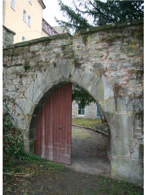
50 | Tor auf den Badberg, Rahmen mit gefastem Kielbogen aus großformatigen, gespitzten Kalksteinquadern, errichtet in Bauphase II (Dez. 2016); Rückansicht s. XVI.51
