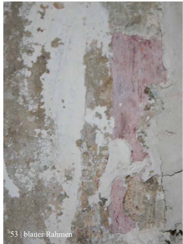
52 & 53 | 1. Obergeschoss, ehem. Abort (HbW-1OG06), Durchgang in den vorderen Schlossbau (HbS-1OG18-Wa-T01) mit rot modulierten Farbresten am Werksteinrahmen als oberste Fassung unter der modernen Tünche (Jan. 2013); Gesamtansicht mit Befundmarkierung s. X.51, vgl. entsprechende Befunde im 2. Obergeschoss s. X.62-64
