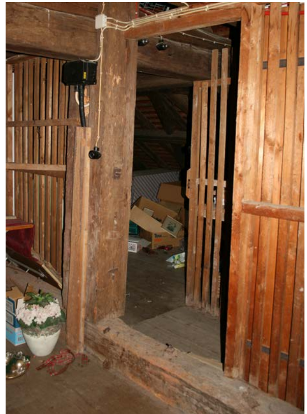
121 | 2. DG, Detail Hängesäule (s. auch VII.122) (Jan. 2013)
