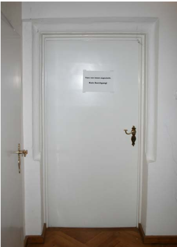
39 | 1. OG, Südwand Treppenvorplatz (Tu-1OG01), Durchgang (HbN-1O11-Wa-T01) in den Saalbau, Werksteinrahmen Typ B (Taf. XIVb) aus Bauphase II, in Bauphase III.1b zweitverwendet (Nov. 2012)
