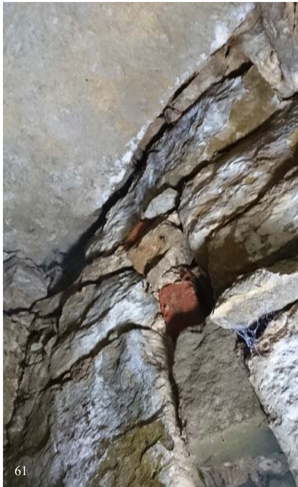
59-61 | Schlossgrabenmauer, Befundstelle 3 (59): Kugelscharte mit rückseitiger Schießnische (verschüttet), gebildet aus Spolien (chem. Schlitzlochscharte?), oben links (60) Detail der zugesetzten ehem. Schlitze, rechts (61) Innenansicht zugesetzter oberer Schlitz, darüber gewölbte Deckenplatte (Stichhöhe ca. 75 cm, Breite ca. 80 cm) (Dez. 2016)
