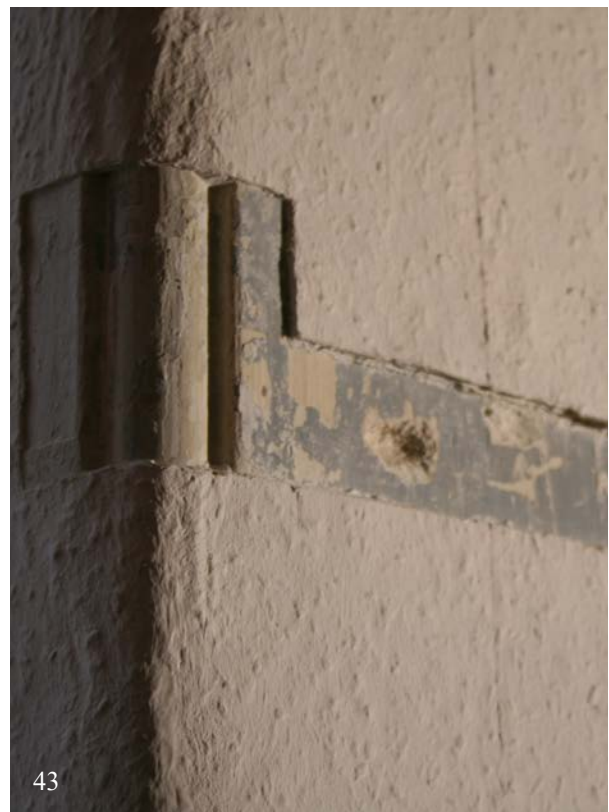
42 & 43 | Marstall, ehem. Stube (Ma-1OG11), restauratorische Öffnungen an der Ostwand, links (42) Befundstelle 010 in der Nordostecke des Raumes, rechts (43) Befundstelle 011 am nördlichen Fenster (Ma-F-O-1OG08); die grau-blaue Tünche entspricht der ältesten Fassung, sie verläuft oberhalb 1,17 m, den unteren Wandabschnitt verkleidete vtl. eine Lamperie, es folgt eine weiß getünchte Glätteputzschicht, dann eine moderne Gipsputzglätte unter der jetzigen Tapete, die zweite Fassung fehlt mithin (Tapeten od. textile Wandbespannungen?) (Nov. 2012)
