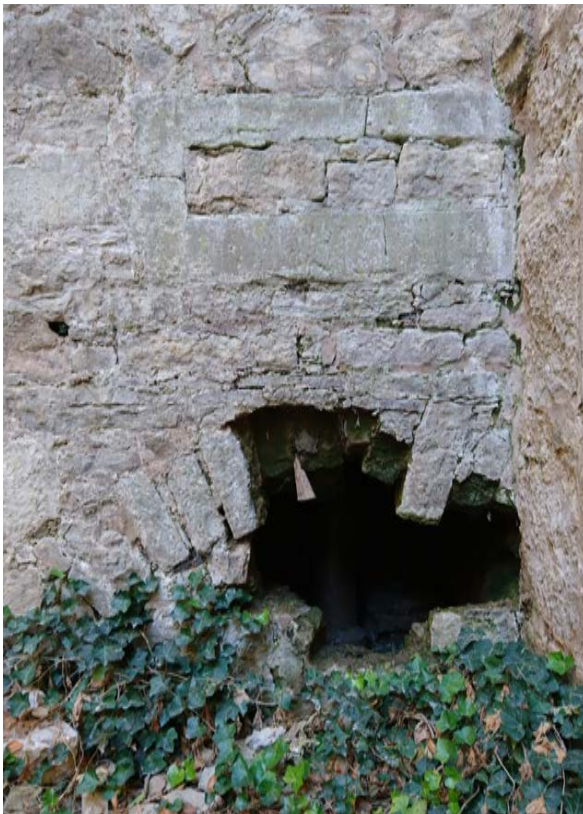
16 | Fundament westlich der Schlossbrücke, Pseudo-Maulscharte als Verblendung des Abortschachts, 1788 beim Bau der Brücke überformt (Okt. 2018)
