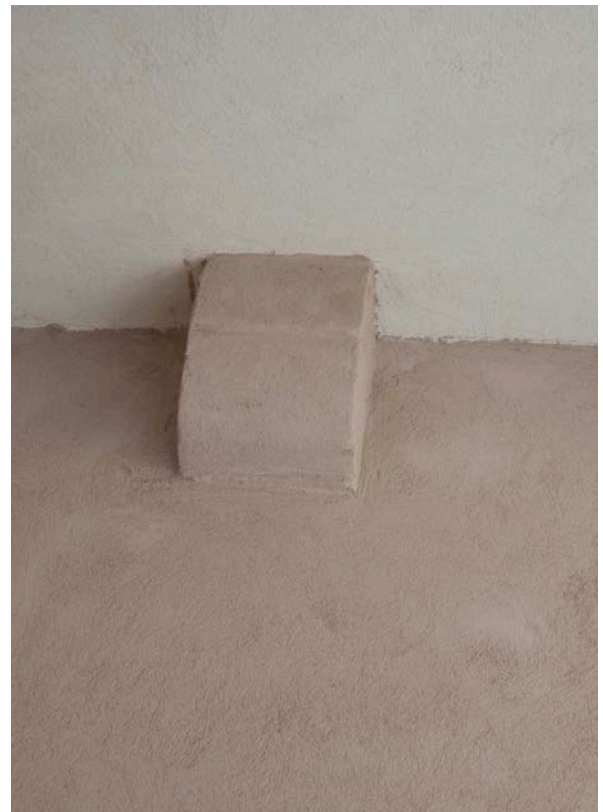
7 | EG, Vorraum (HbO-EG00), Konsole aus Bauphase IV.2c an der Südwand über dem Durchgang (HbO-EG00-Wc-T02) in die ehem. Gesinderäume (Jan. 2018)
