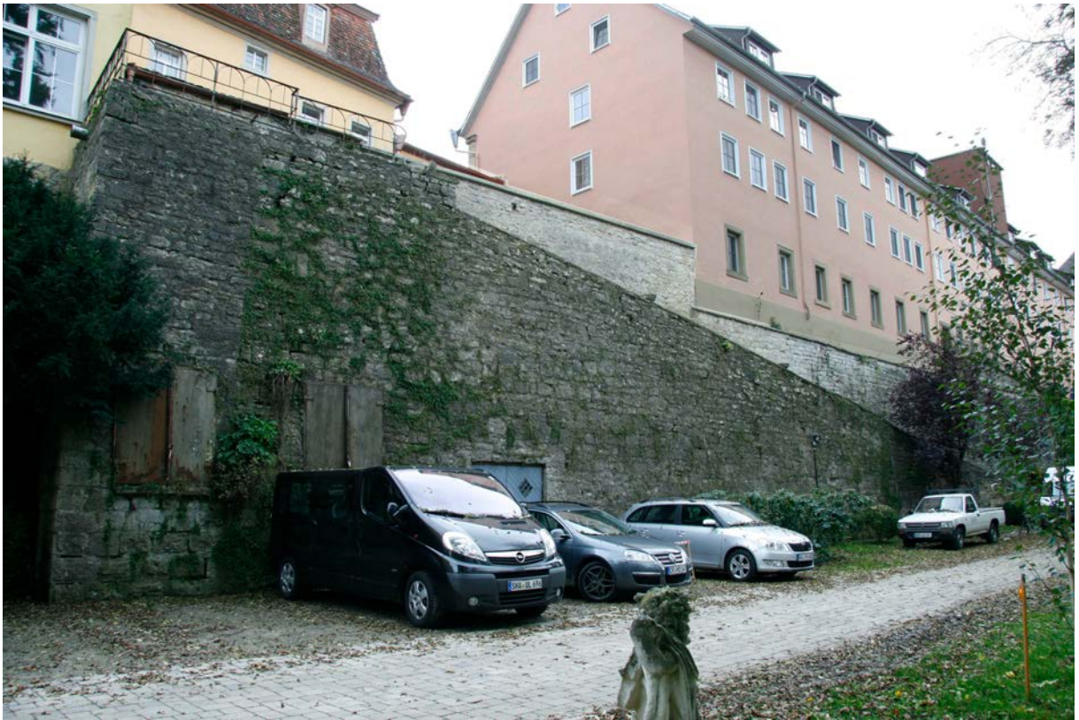
6 | Rampe, die vom Marstall-Hof auf den Neuen Weg führt, 1744/45 errichtet, 1957 gen Norden um einen Müllschacht erweitert, der Bewuchs am alten Baubestand zieht die leicht schräg verlaufende Bauzuge am leicht geböschten, bauzeitlichen Nordende der Rampe nach (Okt. 2017); Ansicht Fahrbahn s. XIII.5
