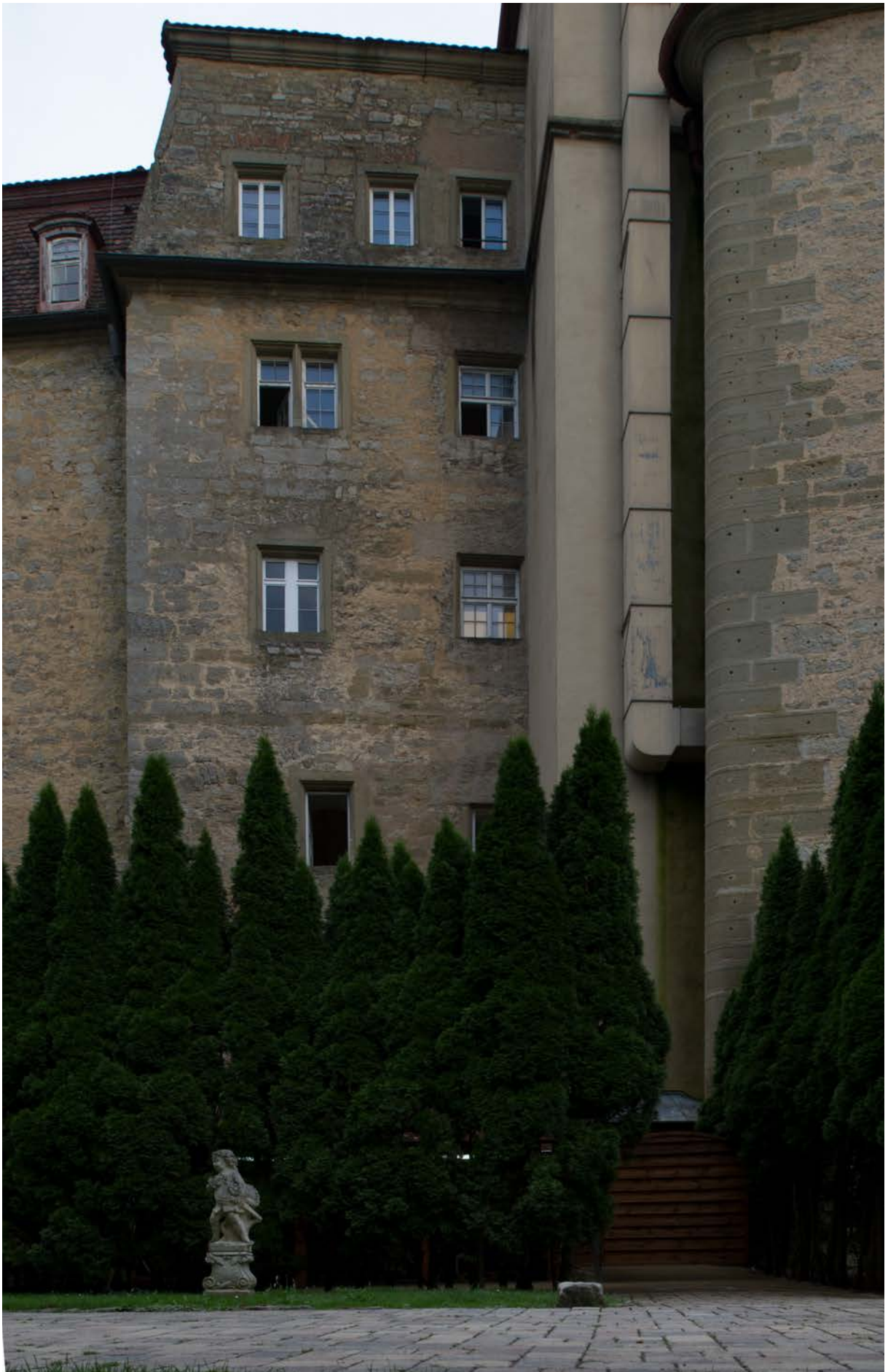
20 | Westliche Giebelwand gegen Osten mit bauzeitlichen Fensteröffnungen aus Bauphase II im 1. und 2. Obergeschoss sowie auf Höhe der Mansarde, Fahrstuhl im Eck zum Basteiturm West 1956 errichtet (Juli 2017) | © Isabel Muehlhaus TUM (bearb. LG)
