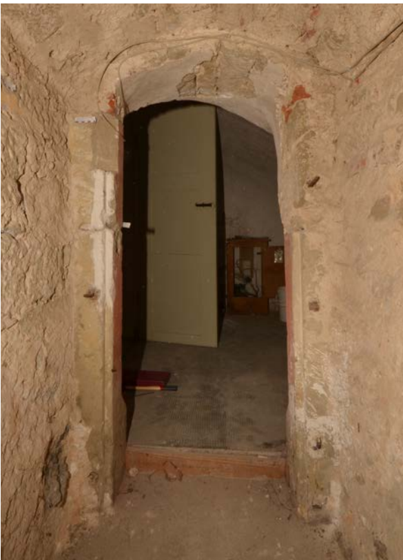
33 | EG, Durchgang HbW-EG08-Wb-T01 gegen Osten, Blick auf die Rückseite des Werksteinrahmens aus Bauphase II mit schmiedeeisernem Kloben (re.) und Schlaufe (li.) (Sept. 2016); zur Fassung s. X.34 | abgeb. in FELDTKELLER 2016
