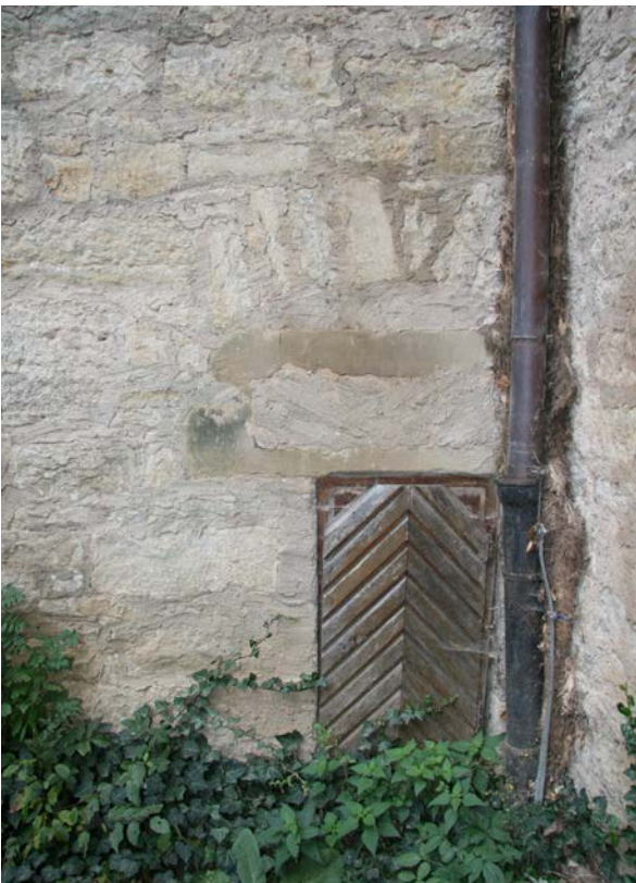
14 | Fundament östlich der Schlossbrücke, Pseudo-Maulscharte am östlichen Abortschacht, sekundär zugesetzt, Türöffnung modern (Okt. 2015)
