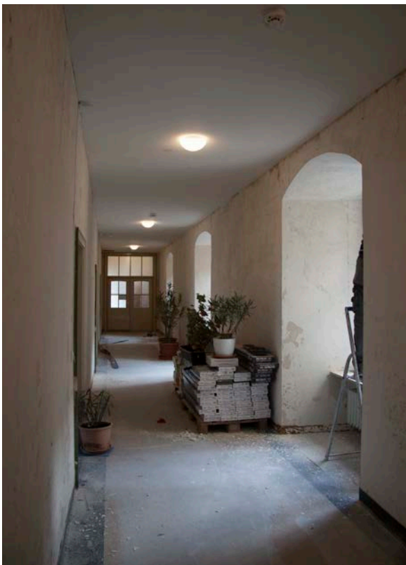
52 | 1. OG, Flur (HbN-1OG01) längs der Südseite gegen Osten, 1954/61 einschließlich des Treppenhauses in der Südostecke überformt und Decke abgehängt (Jan. 2018); Detail historische Decke s. VIII.54
