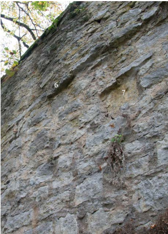
66 | Schlossgrabenmauer, Befundstellen 6: Beginn der Vorkragung am Fußpunkt der Brustmauer und 7: im Verbund vermauerter, quadratischer Rücksprung (Okt. 2017)
