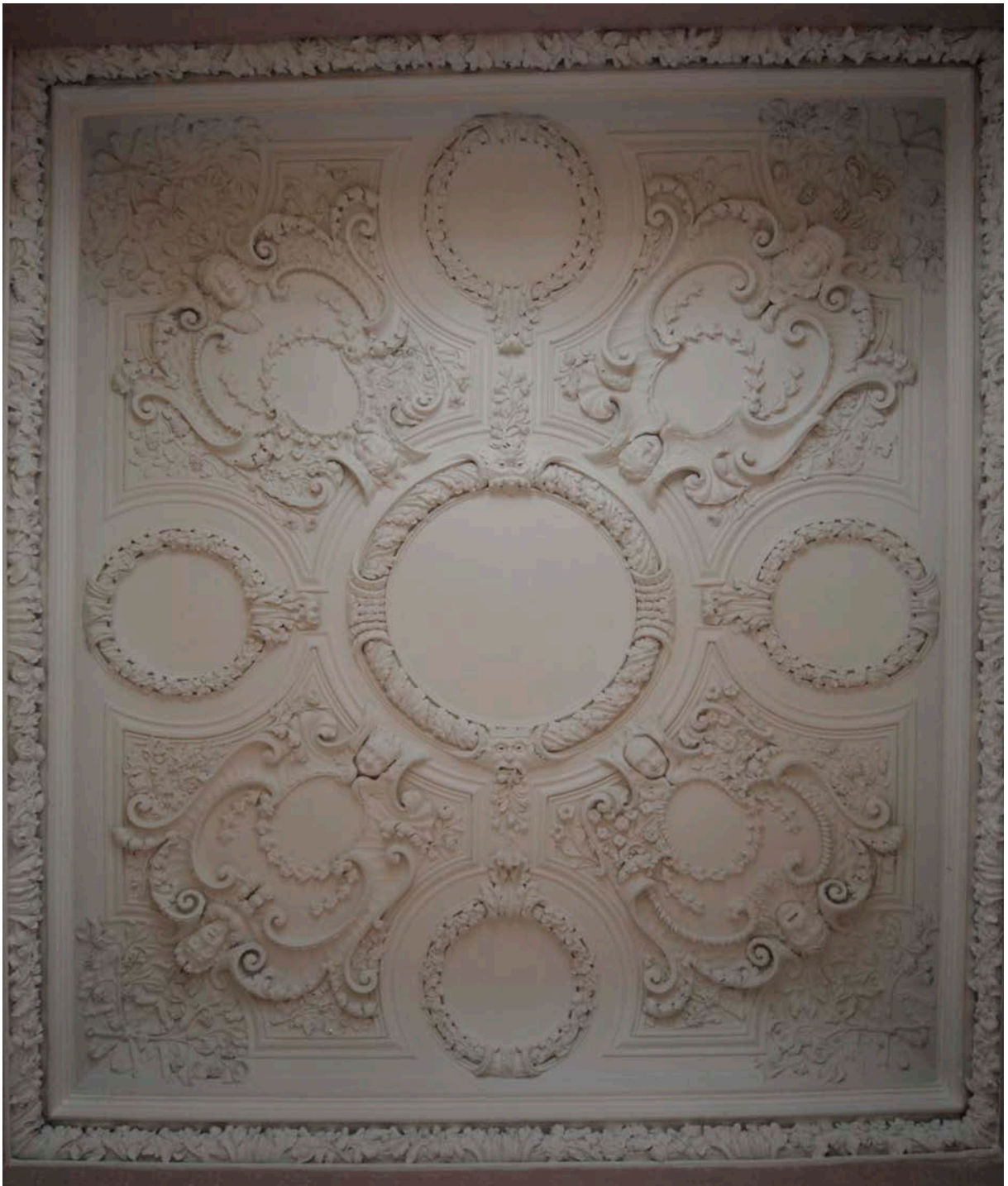
33 | 1. Obergeschoss, bauzeitliche Stuckdecke aus Bauphase IV.1b über dem ehem. Kabinett (HbO-1OG03), um 1709 gefertigt von zwei italienischen Stuckateuren (Jan. 2012)
