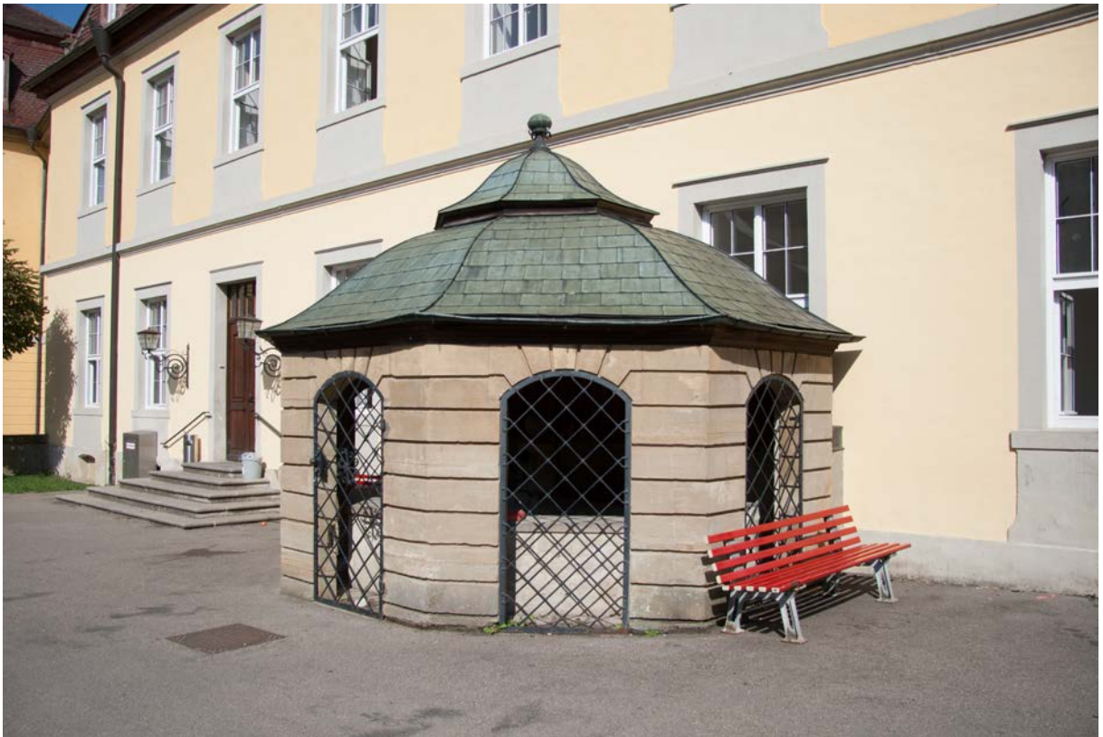
7 | Brunnenhaus vor dem Witwenbau gegen Osten, 1751 errichtet, später verändert (Juli 2017); zum Entwurf s. XV.23, historische Ansicht s. III.16
