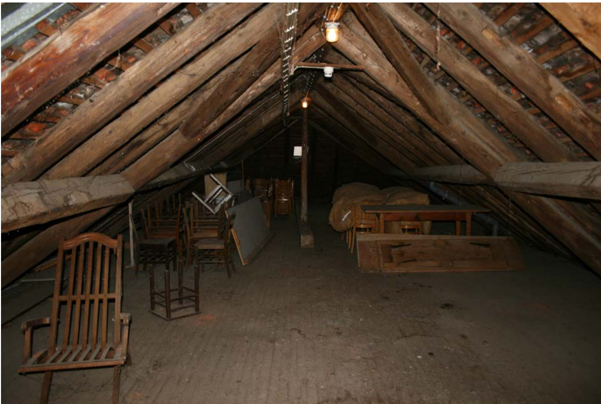
70 | 2. Dachgeschoss, Sparrendach aus Bauphase IV.2c gegen Süden (s. X.72) (März 2013)
