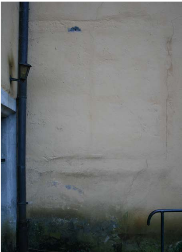
5 | EG, Nordfassade, ehem. Mittelpostenfenster HbN-N-EG-F01, 1. Hälfte 20. Jh. zugesetzt (Nov. 2012); zur restauratorischen Öffnung s. VIII.6
