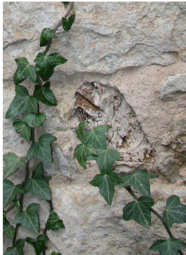
15 | Fundament östlich der Schlossbrücke, Gerüstholz aus Bauphase II in situ vor der Entnahme zur dendro. Dat. im Nov. 2015 (Okt. 2015); zur Lage vgl. VII.13
