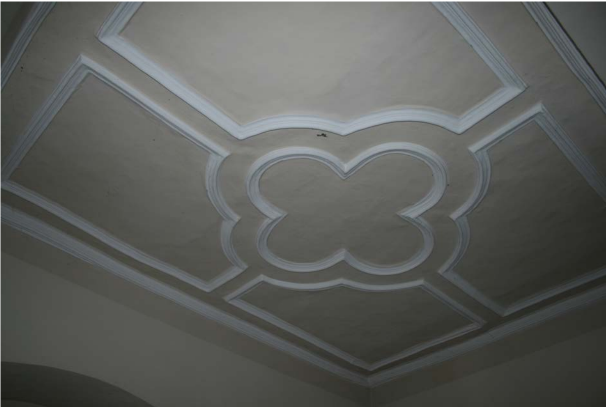
41 | 1. Obergeschoss, geometrisch gegliederte Stuckdecke mit Vierpass aus Bauphase III.3 über der Kammer des ehem. Stubenappartements (Tu-1OG02) gegen Südwesten (Nov. 2012)
