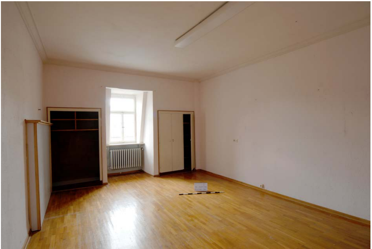
53 | Marstall, Mansarde, ehem. Bedienten-Kammer (Ma-1DG08) gegen Osten mit umlaufender Stuckprofilleiste aus dem 18. Jahrhundert, 1959 unterteilt und neu gestaltet, später weiter verändert (Jan. 2012)
