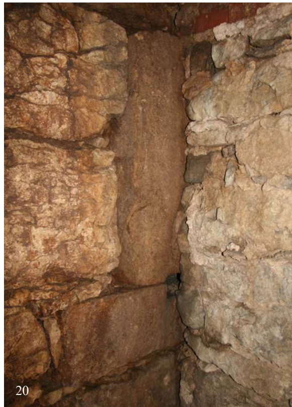
19 & 20 | Marstall, nördliche Giebelwand des kleinen Kellergewölbes (Ma-2UG02), entsprach Südwand des spätmittelalterlichen Torturms aus Bauphase I.3, in Bauphase IV.2a abgebrochen, links (19) Gesamtansicht, regelmäßiges Schichtenmauerwerk aus großformatigen, bruchrauen Kalksteinquadern (Okt. 2015 | © Isabel Muehlhaus TUM), rechts (20) zwei T-förmige kombinierte Quader mit rechteckiger Aussparung (dahinter Hohlraum), verbaut durch die barocke Kellerwand (Ma-2UG02-Wb), möglicherweise Teil der ehem. Zugbrückenkonstruktion (Okt. 2015)
