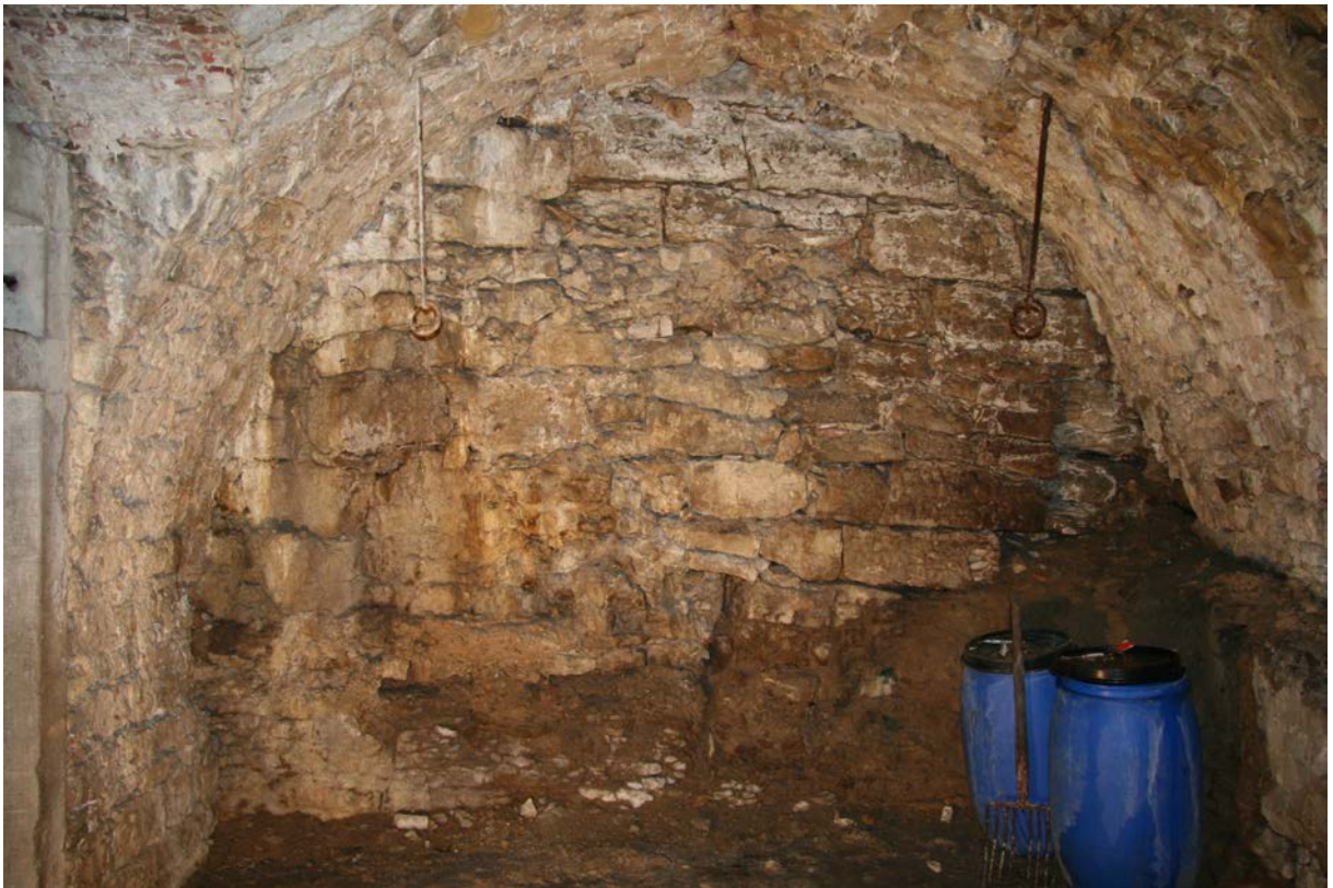
21 | Marstall, 2. Untergeschoss, Südwand des kleinen Gewölbekellers (Ma-2UG02-Wc) entspricht der Grabenwand des ehemaligen äußeren Schlossgrabens (Nov. 2015)
