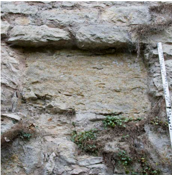
68 | Schlossgrabenmauer, Befundstelle 10: Im Verbund gemauerter, rechteckiger Rücksprung mit monolithischer Platte gefüllt (ehem. Öffnung?) (Okt. 2017)
