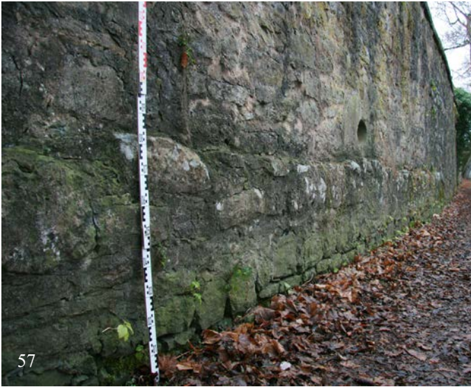
57 & 58 | Schlossgrabenmauer, Befundstelle 2: circa 11 m langer, im Verbund gemauerter Sockel im südlichen Abschnitt gegen Nordosten (57) und gegen Südwesten (58) (Okt. 2017)
