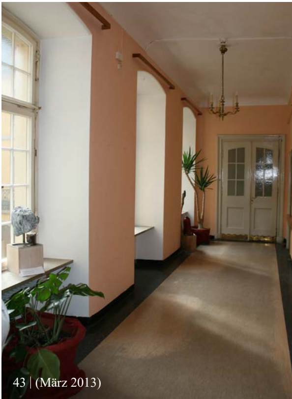
43 & 44 | 1. Obergeschoss, Gang (HbW-1OG02) zwischen dem Treppenhaus (HbW-Th1) und dem Saalbau gegen Süden (43) bzw. Norden (44), 1954 von der ehem. Tafelstube abgeteilt, historische Fassungen wohl aus Bauphase IV.3 im Rahmen der Renovierung 2018 freigelegt (s. auch X.45 & 46)
