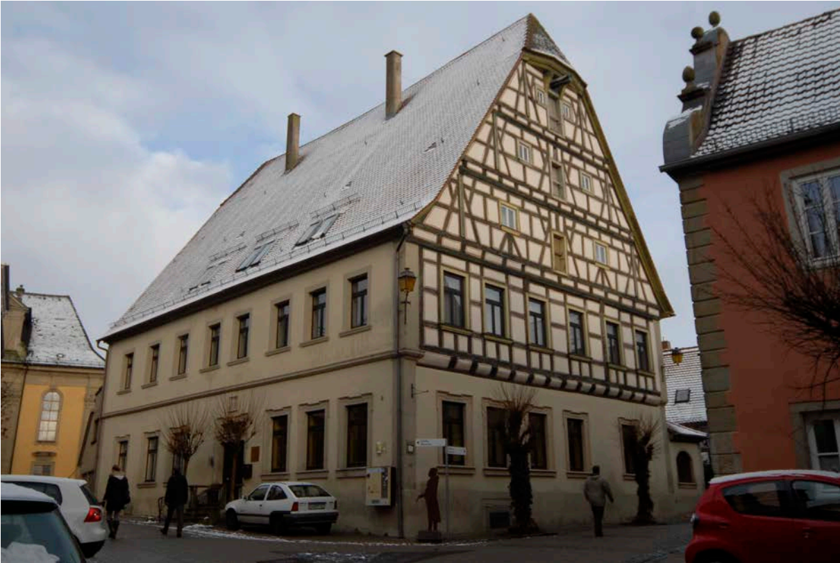
5 | Kirchberg, Kirchstraße 6 (Ecke Schloßstraße), ehem. Ratsherberge der Reichsstädte und Kornhaus gegen Norden, in den mittelalterlichen Schriftquellen als „inneres Wirtshaus“ bezeichnet, zweigeschossiger, teils verputzter Fachwerkbau auf steinernem Erdgeschosssockel mit Krüppelwalmdach und geohrten Fensterrahmen, 1494-96, Veränderungen 1. Hälfte 17. Jh. und ab 1743, im 20. Jh. mehrfach umgebaut (Jan. 2012)
