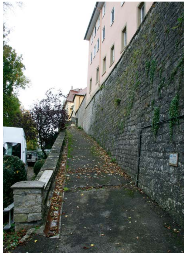
5 | Rampe, die vom Marstall-Hof auf den Neuen Weg führt, 1744/45 errichtet (Okt. 2017); Seitenansicht s. XIII.6
