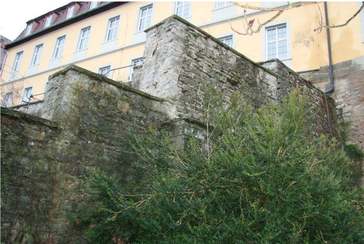
53 | Südliche Grabenmauern wohl aus Bauphase II, die die Mantelmauer des Halsgrabens bis an die Schlossgrabenmauer verlängern und den anstehenden Felsen unterhalb des Witwenbaus stabilisieren, Schrägansicht gegen Westen (Dez. 2016); Gesamtansicht s. XVI.52
