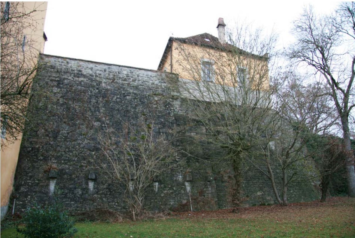
35 | Ostseite des leicht geböschten, mit Kalk-Bruchsteinmauerwerk verkleideten Schlosshoffundaments, Blick gegen Norden, rechts Durchgang unter dem Fahrweg in den ehemaligen westlichen Grabenabschnitt (Dez. 2016)
