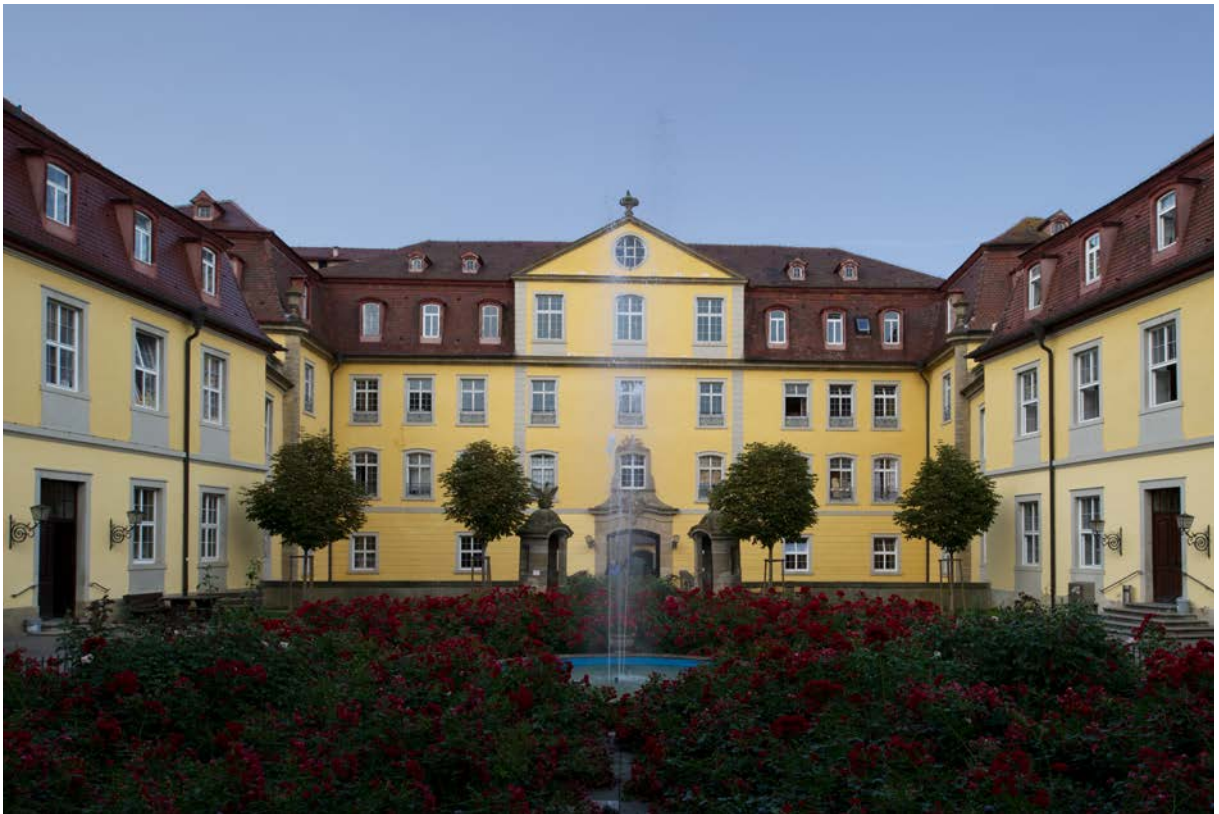
1 | Südfassade gegen den Ehrenhof im Ausbausezustand nach dem Umbau in Bauphase IV.2c nebst den zwei zusätzlichen Fensterachsen aus den 1950/60er Jahren (Juli 2017); historische Ansichten s. III.10-13 | © Isabel Muehlhaus TUM
