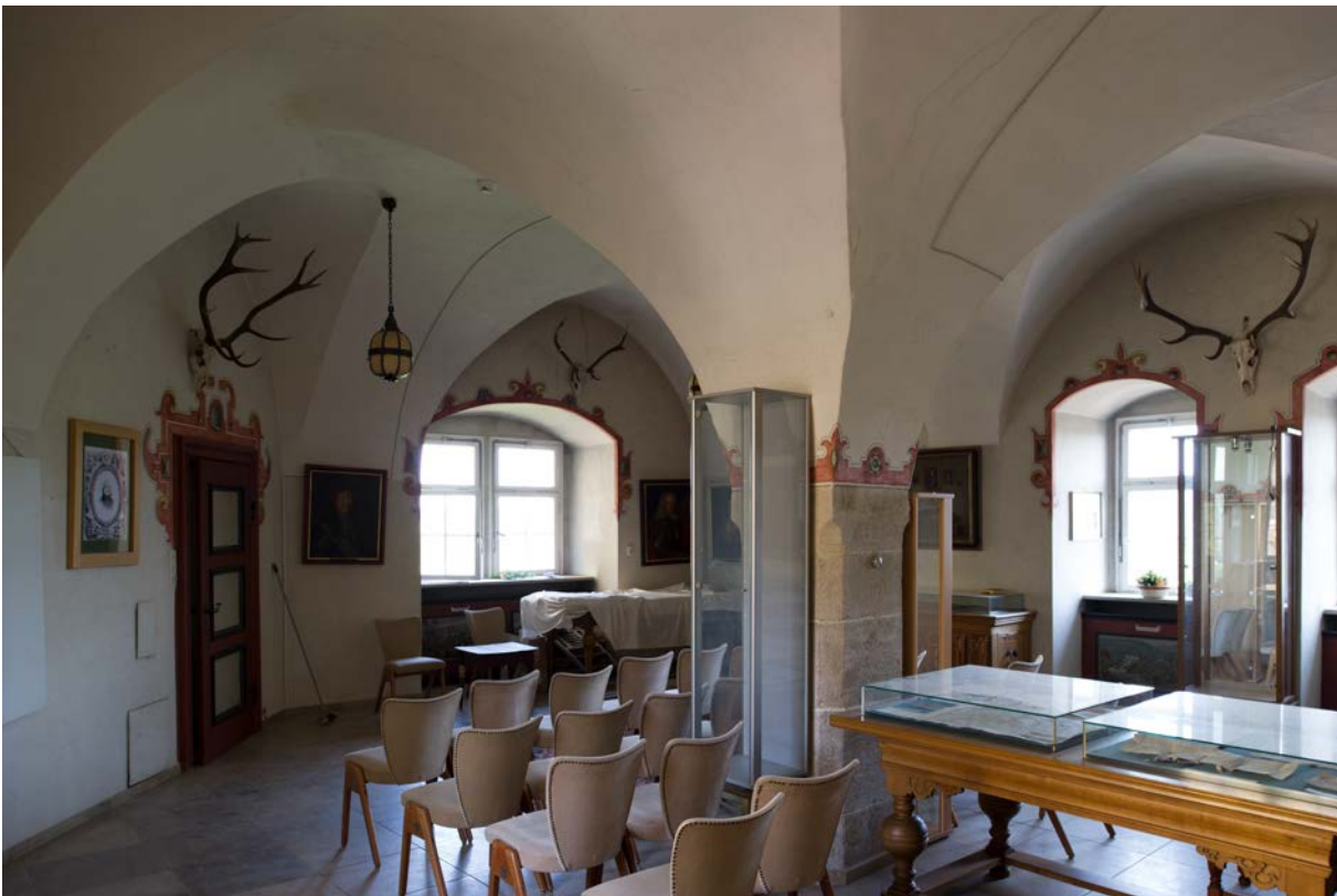
73 | Basteiturm Ost, Erdgeschoss, ehem. Badestube gegen Nordosten mit historisierenden Beschlagwerk-Malereien an Mittelpfeiler, Tür- und Fensterrahmen, im 18. Jh. entkernt und zur Kanzlei umgenutzt, links Eingangstür (BaO-EG01-Wa-T01), daneben die geschlossenen Ofenlöcher (s. VII.72) (Juli 2017) | © Isabel Muehlhaus TUM
