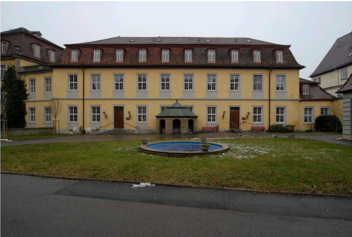
55 | Witwenbau, Hofansicht gegen Südosten (Jan. 2012)
