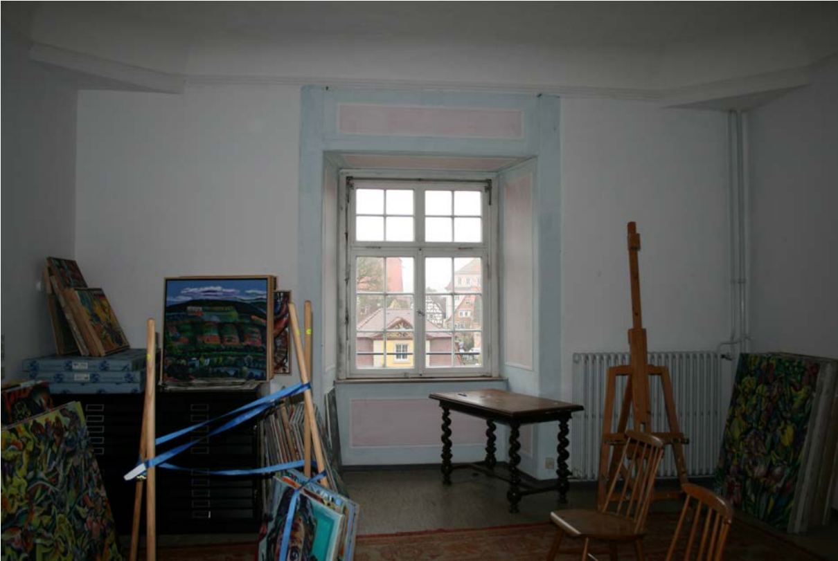
108 | 2. Obergeschoss, ehem. Kammer (HbS-2OG07) mit rudimentären Resten der historischen Vertäfelung im Bereich der Fensternische, Blick gegen Südwesten, 1956 umgestaltet und überformt, später weiter verändert (Jan. 2013); zum Umbauplan s. XVII.9
