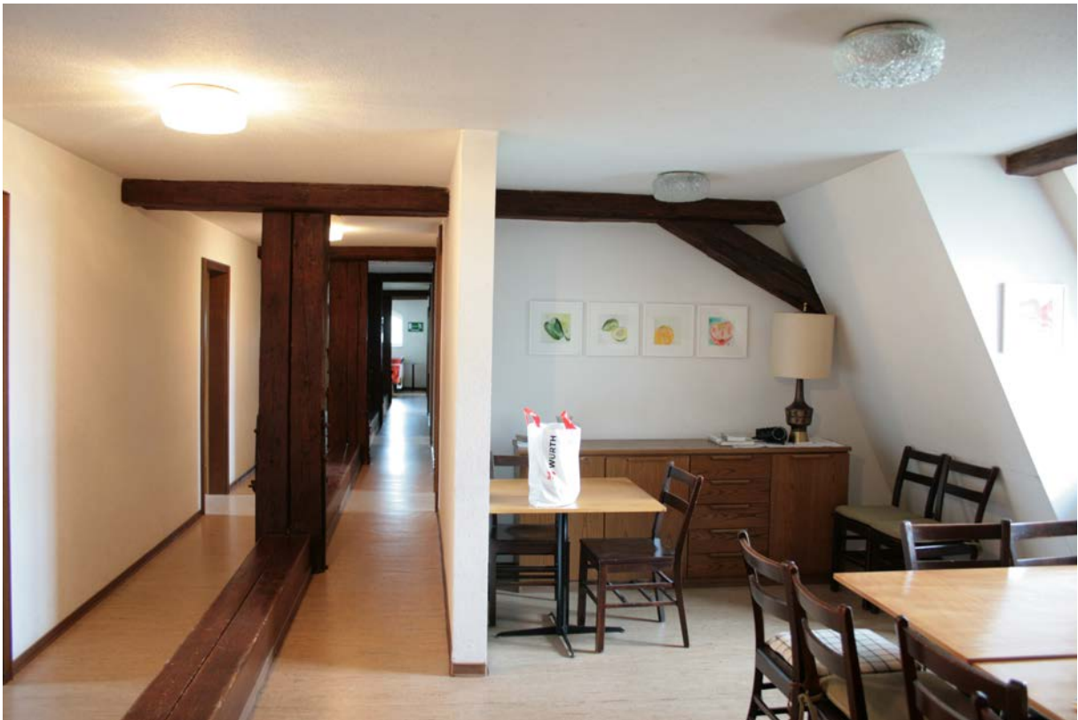
77 | 1. Dachgeschoss, Flur (HbN-1DG05) gegen Westen im Bereich des Überzugs, an dem die Kassettendecke des Saals befestigt ist (VIII.61 & 62), Dachwerk in Bauphase III.4 aufgeschlagen, 1953 ausgebaut, 1980 um zwei Gauben auf der Nordseite erweitert (Okt. 2012); Konstruktionsdetails s. VIII.78-81
