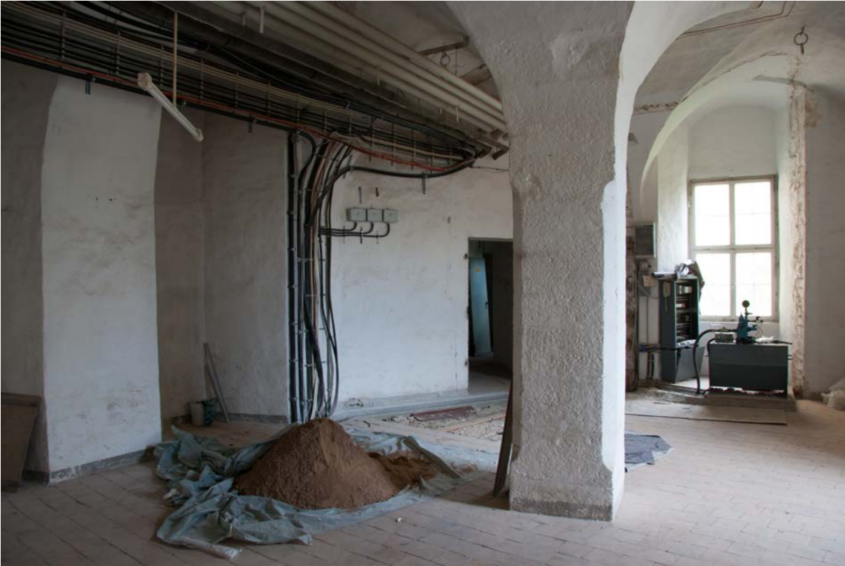
83 | Basteiturm Ost, 1. Untergeschoss gegen Norden, in der Westwand links zwei ehem. Schießstände zum Bestreichen des Halsgrabens (Okt. 2017)
