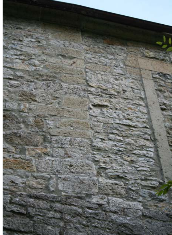
11 | Baufuge zwischen dem Torbau (li.) und der später angebauten Remise (re.) (Okt. 2012)
