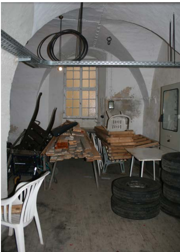
87 | Basteiturm Ost, 2. UG, ehem. Gewölbekeller (BaO-2UG01) gegen Nordosten (Jan. 2013)
