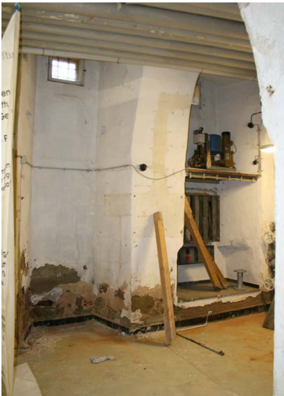
62 | Basteiturm West, 1. UG, Ostwand mit zwei Schießnischen (BaW-1UG01-Wb-N1 & N2), Öffnungen mit Ausnahme der Beobachtungsfenster sekundär zugesetzt (Jan. 2013); Außenansicht s. VII.25, Detail nördlicher Schießstand s. VII.63
