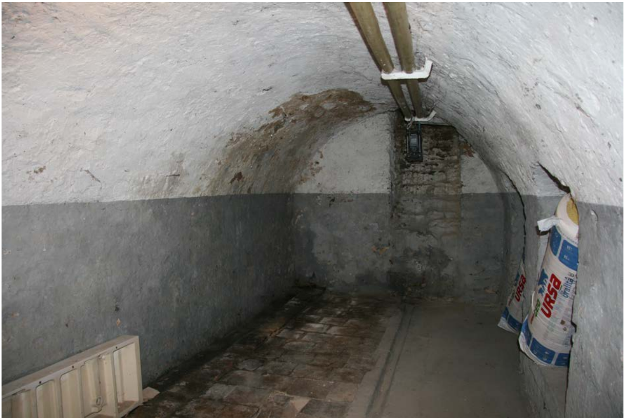
12 | 1. Untergeschoss, kleines Kellergewölbe (HbO-1UG01) gegen Nordwesten, an der Westwand Fensterschacht zum Hof, den Boden quert in Längsrichtung eine Ablaufrinne (s. IX.13 & 14) (Nov. 2015)
