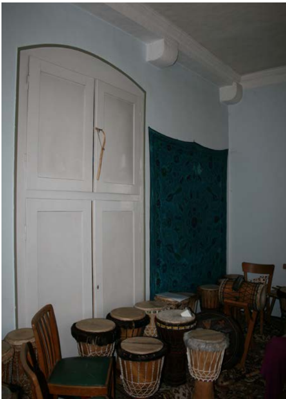
33 | EG, ehem. Kammer (Tu-EG02) gegen Nordosten mit Wandschrank (2017 ausgebaut) im Bereich einer bauzeitlichen Fensternische (s. XI.34) (Nov. 2015)
