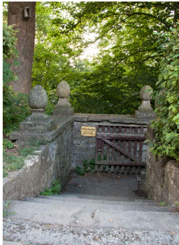
23 | Neuer Weg, nördlicher Ausgang auf den Hirschberg, Überleitung zum Zwinger, Winkeltreppe mit Viertelpodest und klassizistischer Brüstungsmauer mit Zieraufsätzen, Blick gegen Westen (Juli 2017)
