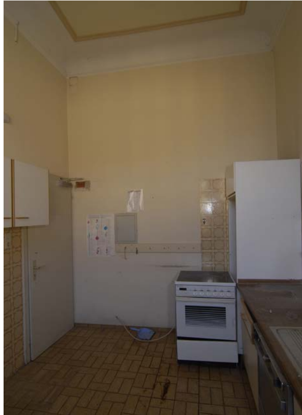
45 | Marstall, 1. OG, Raum Ma-1OG12 gegen Westen, Deckenanschluss mit historischen Stuckprofilen längs der Voute, 18./19. Jh. (März 2012)
