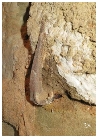
28 & 29 | 2. UG, schmiedeeiserne Eisenkloben seitlich der zugesetzten Öffnung des ehemals wohl abgewinkelten, oberen Treppenlaufs (s. VIII.27) der kleinen Kellertreppe (HbN-Tr3-2UG(3UG)), s. VIII.25 & 26) (Nov. 2015)
