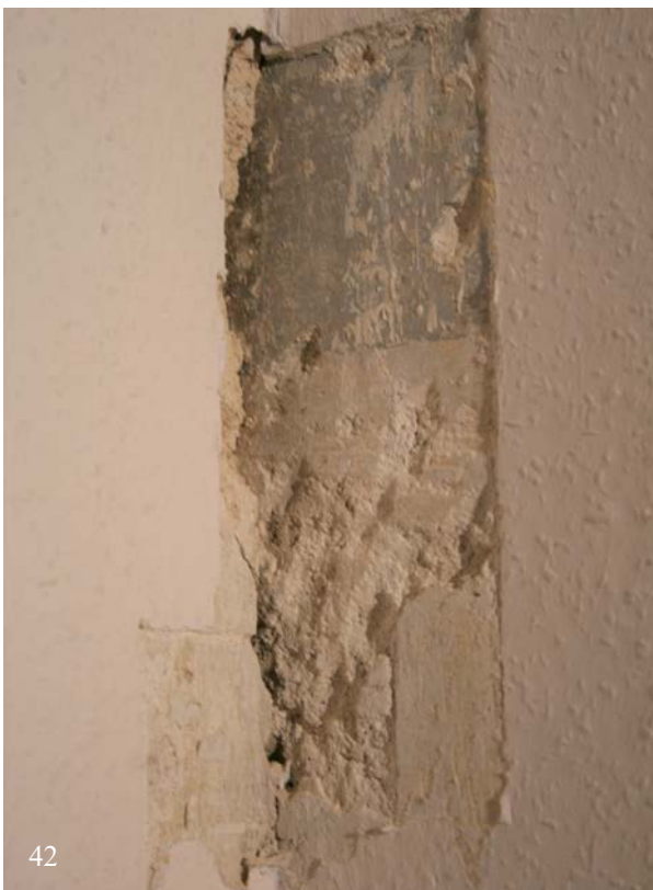
42 & 43 | Marstall, ehem. Stube (Ma-1OG11), restauratorische Öffnungen an der Ostwand, links (42) Befundstelle 010 in der Nordostecke des Raumes, rechts (43) Befundstelle 011 am nördlichen Fenster (Ma-F-O-1OG08); die grau-blaue Tünche entspricht der ältesten Fassung, sie verläuft oberhalb 1,17 m, den unteren Wandabschnitt verkleidete vtl. eine Lamperie, es folgt eine weiß getünchte Glätteputzschicht, dann eine moderne Gipsputzglätte unter der jetzigen Tapete, die zweite Fassung fehlt mithin (Tapeten od. textile Wandbespannungen?) (Nov. 2012)
