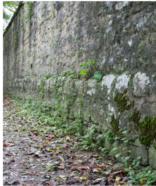
57 & 58 | Schlossgrabenmauer, Befundstelle 2: circa 11 m langer, im Verbund gemauerter Sockel im südlichen Abschnitt gegen Nordosten (57) und gegen Südwesten (58) (Okt. 2017)
