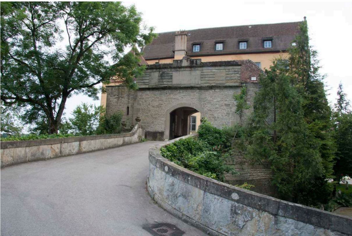
23 | Fahrweg auf halber Höhe zum Torbau, Blick gegen Südosten (Juli 2017)
