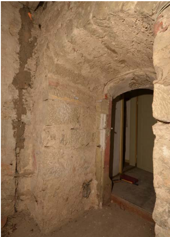
35 | EG, Nordostecke am Schießstand (HbW-EG08), Blick in den Durchgang (HbW-EG08-Wb-T01), links Baufuge zwischen der Seitenmauer (li.) aus Bauphase III.1b und der Treppenhaus-Rückwand (re.) aus Bauphase IV.2c (Sept. 2016); zur Fassung der nördlichen Laibung s. X.36-38 | abgeb. in FELDTKELLER 2016
