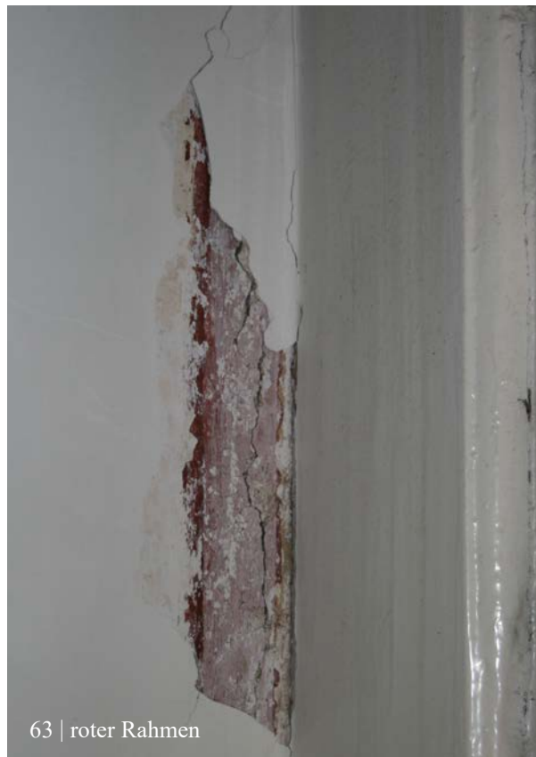
62-64 | 2. Obergeschoss, ehem. Abort (HbW-2OG05), südliche Fensterlaibung (HbW-W-2OG-F06) mit Resten einer rot modulierten Farbfassung als oberste Fassung unter der modernen Tünche (63 & 64) (Jan. 2013); vgl. entsprechende Befunde am Türrahmen des ehem. Aborts im 1. OG s. X.51-53
