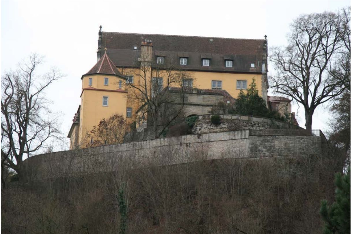
31 | Blick vom Tal gegen Westen auf die Schlossgrabenmauer und den Zwinger im Bereich vor der Spornspitze, die in Verlängerung der Schlossgrabenmauer errichtete, barocke Terrassierung (s. XVI.33) setzt sich durch das Fehlen der Brustmauer und den dunkleren Kalkstein augenfällig ab (s. XVI.33) (Nov. 2015)
