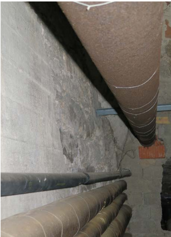
10 | 1. UG, Technikgang (HbW-1UG01) gegen Norden, Südwand, regelmäßiges Schichtenmauerwerk aus großformatigen, bruchrauen Kalksteinquadern, gen Süden mit Beton verschalt, wohl Fundament der ehem. inneren Burgringmauer aus Bauphase I.1 (Nov. 2015)
