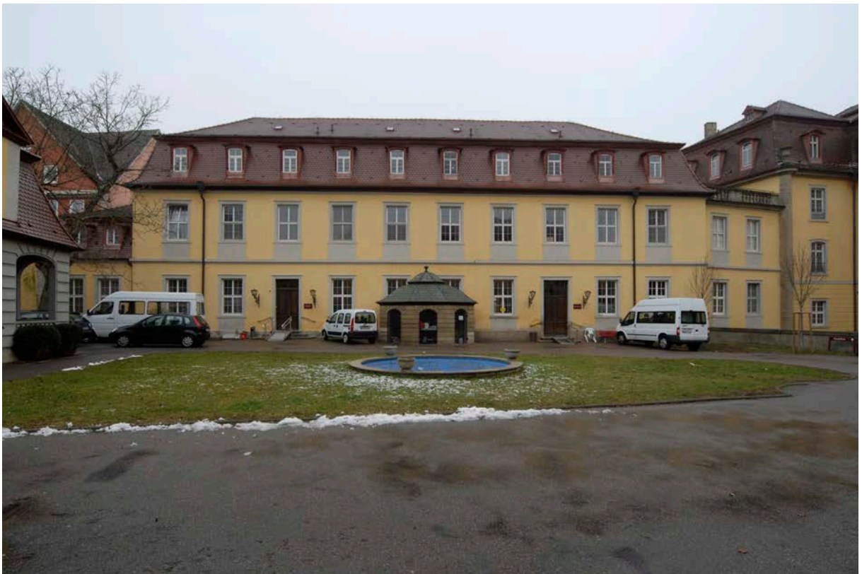
2 | Marstall gegen Nordwesten, links das eingeschossige Anbäulein, das die Kellerräume im 2. Untergeschoss erschließt, rechts der Kommunikationsbau West aus Bauphase IV.2c, der den Flügel über den Halsgraben mit dem Kernbau verbindet (Jan. 2012)
