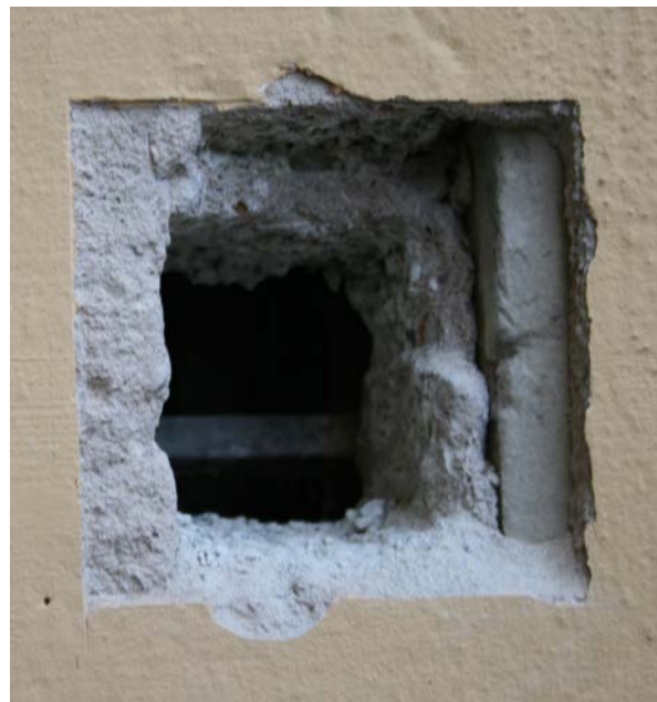
6 | EG, Nordfassade, restauratorische Öffnung am zugesetzten Fenster HbN-N-EG-F01 im Bereich des Mittelpostens, Fensteröffnung aus Bauphase III.1b, Rahmen möglicherweise älter (Nov. 2012); Gesamtansicht s. VIII.5
