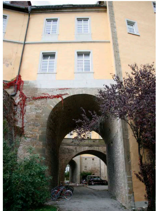
8 | Kommunikationsbau Ost, Talansicht gegen Nordwesten mit Blick in den Halsgraben und auf die Schlossbrücke (Okt. 2017)
