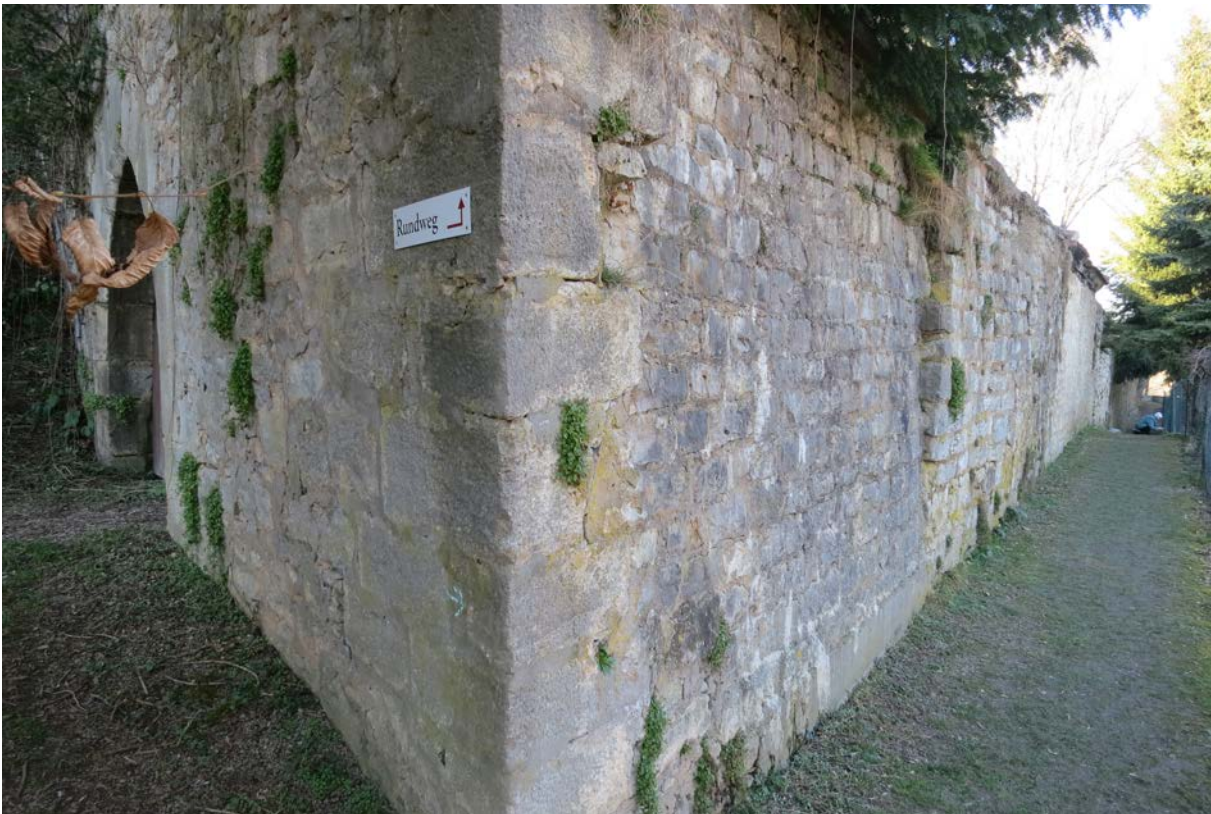
46 | Südostecke der Schlossgrabenmauer gegen Norden, links das frühneuzeitliche Tor auf den Badberg (s. XVI.49) (Feb. 2014)
