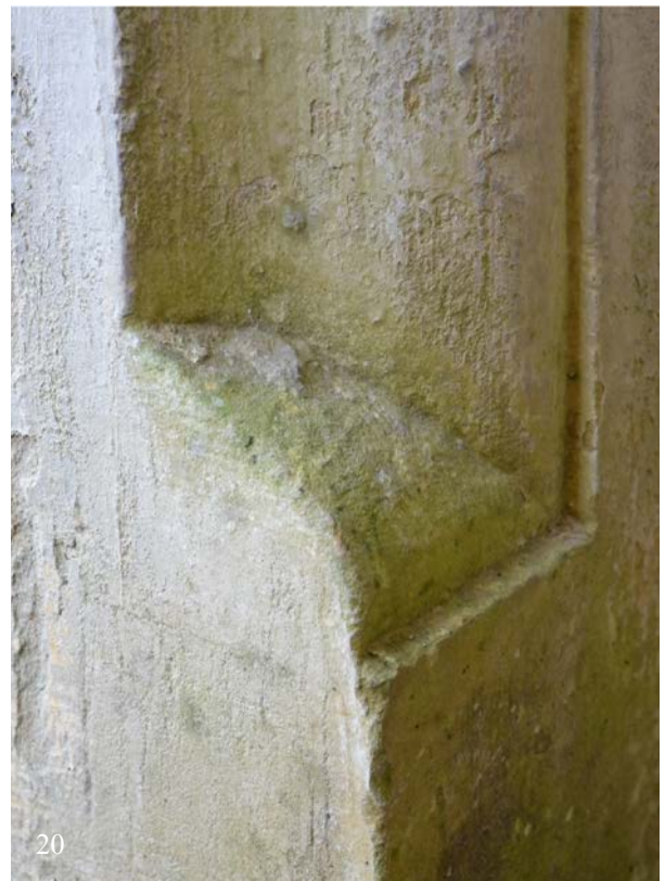
19 & 20 | Erdgeschoss, Eingangstür (Tu-EG01-Wd-T01) mit Werksteinrahmen vom Typ D (Taf. XVI) mit Karniesprofil und einseitig abgeschrägtem Auslauf (20) wohl aus Bauphase III.1b, in Bauphase III.3 zweitverwendet (Okt. 2012); Detail Karniesprofil s. XI.2
