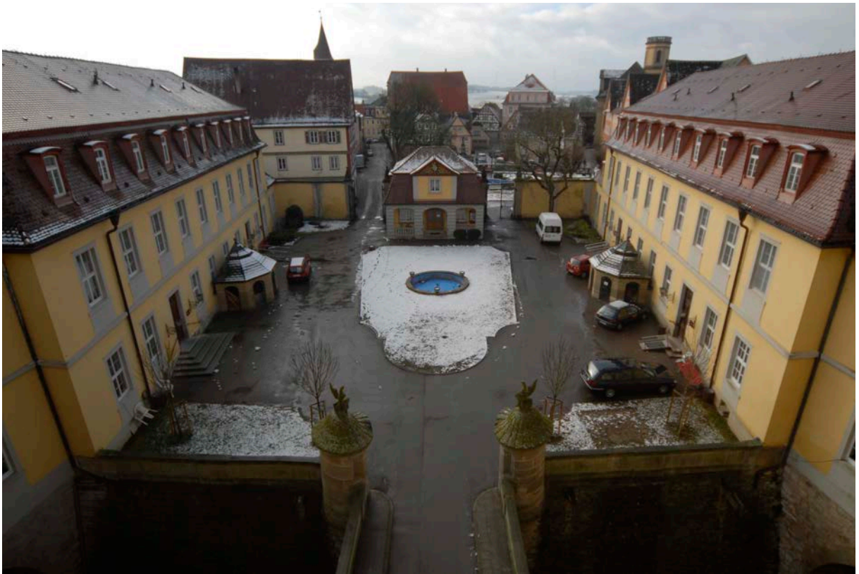
1 | Ehrenhof gegen Süden flankiert von den barocken Flügelbauten, links der Witwenbau, rechts der Marstall, vor Kopf das Wachhaus (Neubau von 1962, s. III.21) (Jan. 2012); historische Ansichten s. III.6, 10 & 16
