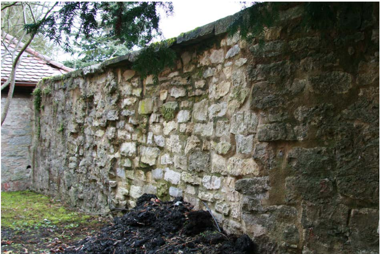
56 | Befundstelle 1: Rückansicht des wieder aufgemauerten Abschnitts der Schlossgrabenmauer im Bereich vor der Südostecke (Dez. 2016); Außenansicht s. XVI.54 & 55
