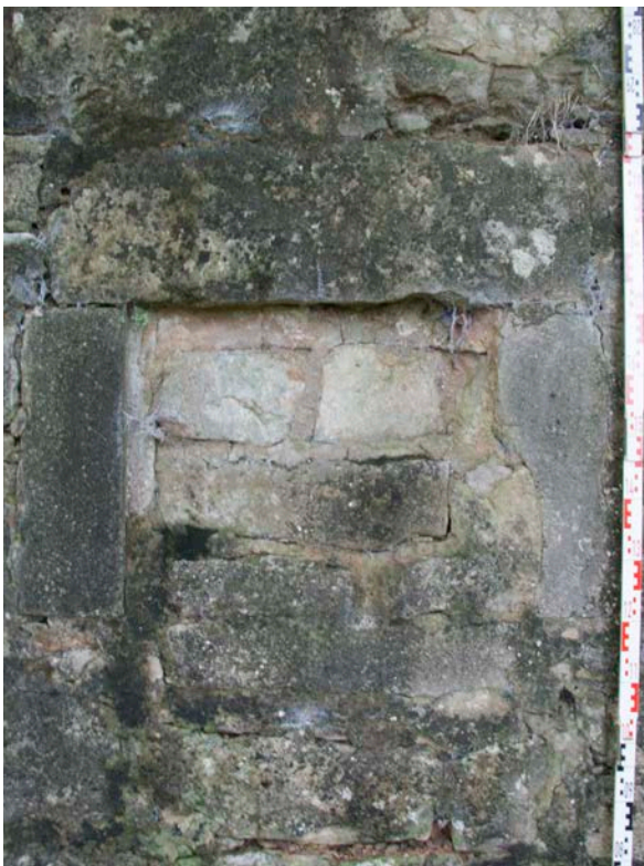
64 | Schlossgrabenmauer, Befundstelle 4: zugesetzte, rechteckige Öffnung (Funktion unklar) (Okt. 2017)
