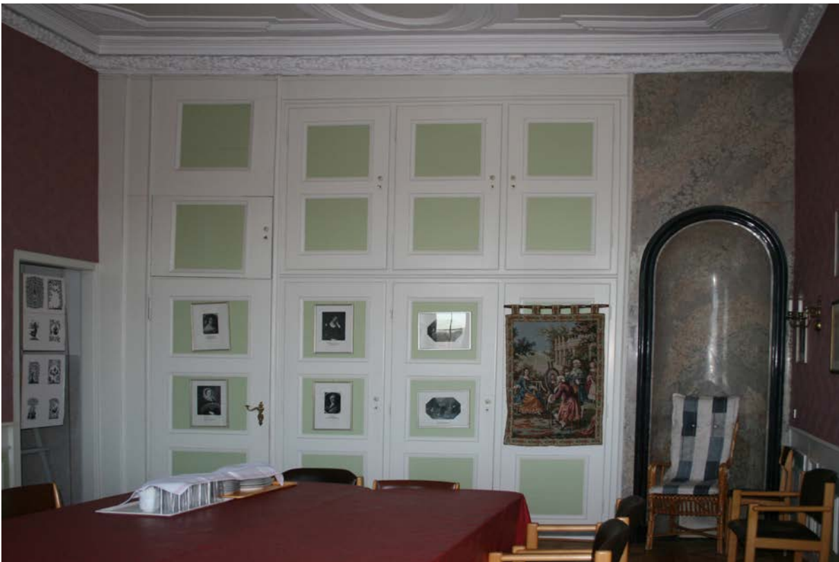
23 | 1. Obergeschoss, ehem. Vorgemach (HbO-1OG05) gegen Westen, rechts die Ofennische von 1745, links der ehem. Durchgang in das erste Vorgemach im Bereich des vorderen Schlossbaus, eingebrochen in Bauphase IV.2c, 1961 geschlossen, Raumgefüge in der 2. Hälfte des 20. Jahrhunderts mehrfach überformt (Nov. 2012); historische Ansicht s. VI.4
