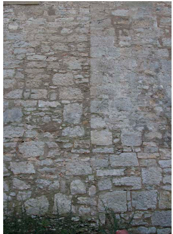
3 | Westfassade, Baufuge zwischen dem Fundament des Saalbaugiebels aus Bauphase III.1b (li.) und der ehem. Burgzwingermauer aus Bauphase I.2 (re.) (Jan. 2018)
