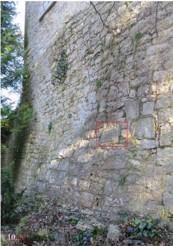
9 & 10 | Neuer Weg, Fundament unterhalb des Torbaus gegen Süden, Mantelmauer: unregelmäßiges Schichtenmauerwerk aus bruchrauen und grob gespitzten Kalksteinquadern kleineren und mittleren Formats (darunter ein Buckelquader, s. rote Markierung), getrennt vom Bruchsteinmauerwerk der Gebäuderückwand durch horizontale Baufuge (Jan. 2018)
