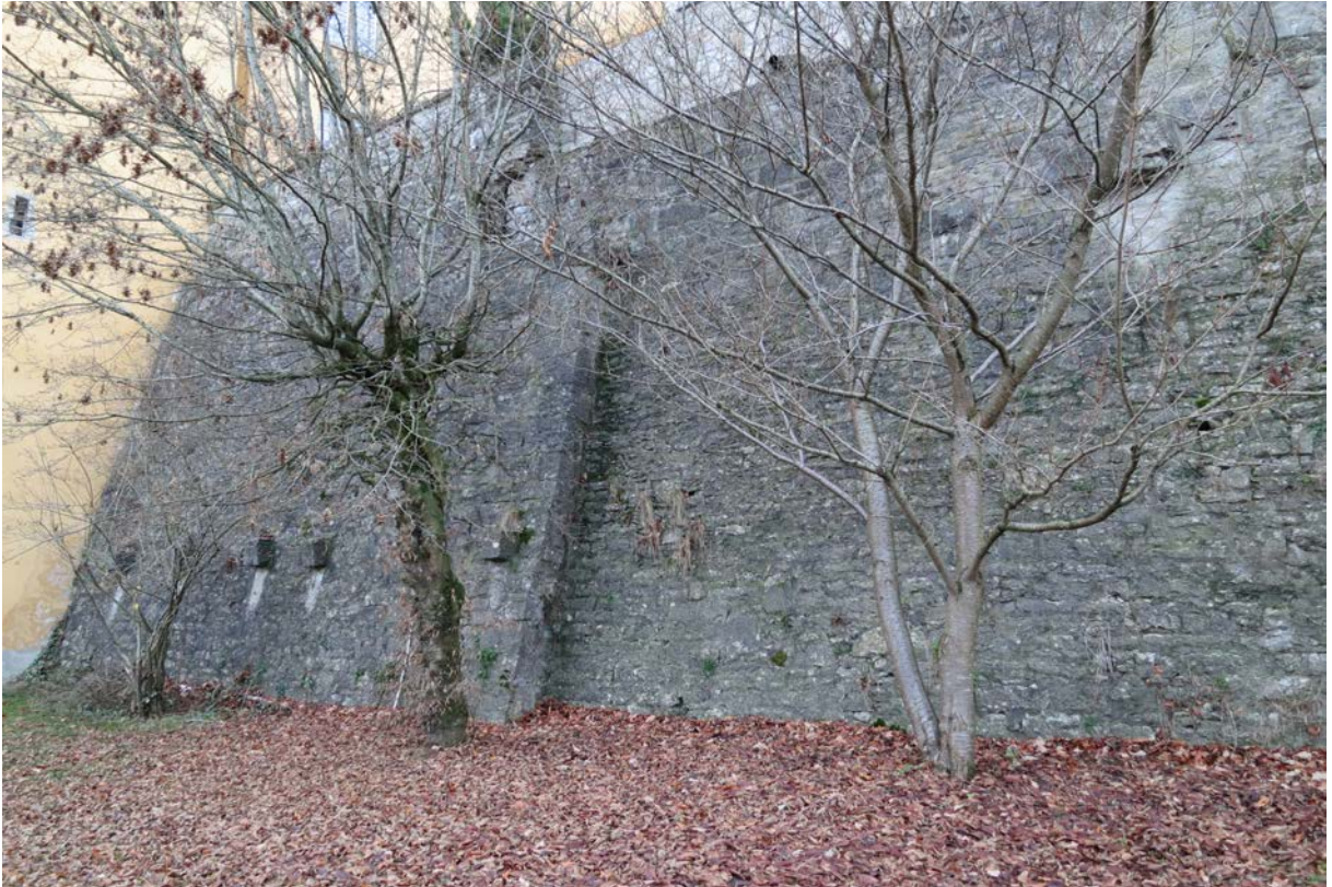
36 | Mantelmauern am östlichen Schlosshoffundament, Blick gegen Westen (Dez. 2016) (Nov. 2015)
