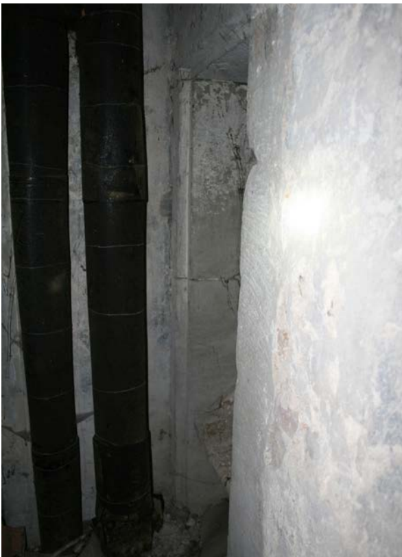
41 | EG, ehem. Abort aus Bauphase III.1b in der Südwestecke von Raum HbW-EG08 (Nov. 2012); zu den historischen Fassungen s. X.42
