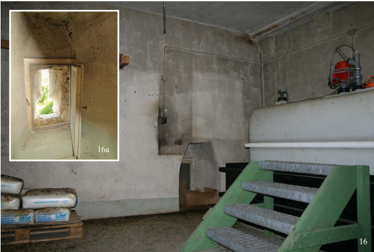
16 & 16a | 2. Untergeschoss gegen Südosten mit Fußschartennische (16a) (Tu-O-2UG-F01) in der Ostwand (Nov. 2015); Außenansicht s. XI.6
