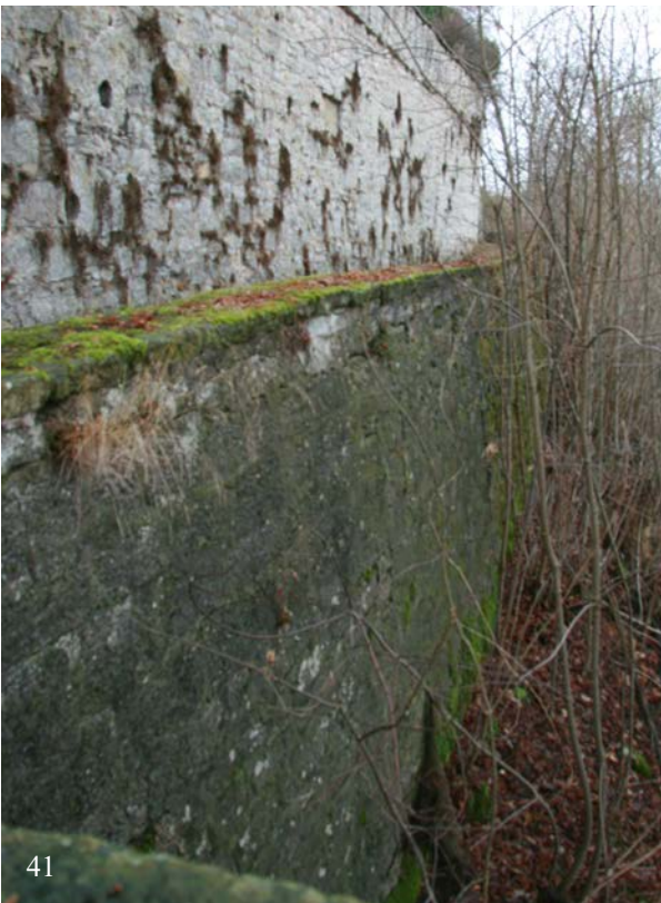
41 & 42 | Zwingermauer nördlich der kleinen Bastion gegen Nordwesten, regelmäßiges Schichtenmauerwerk aus gespitzten Kalksteinquadern mittleren Formats, Abschnitt während Bauphase III.1b um 1624 erneuert, ursprüngliche Höhe wohl im 18. Jahrhundert auf Brüstungsniveau reduziert (Dez. 2016)
