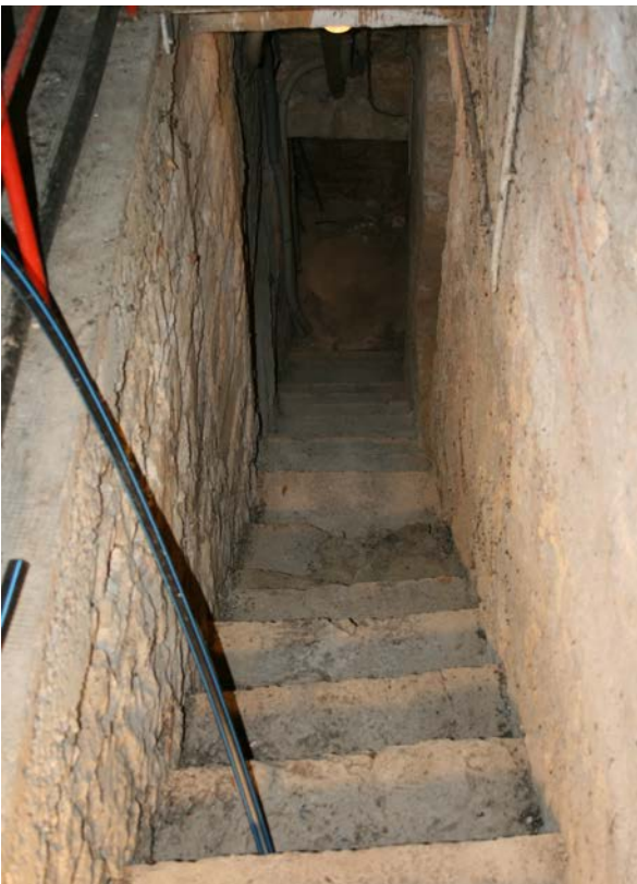
25 | 2. UG, kleine Kellertreppe (HbN-Tr3-2UG(3UG)), die vom großen Gewölbekeller in den Graben führt, gegen Norden, in Bauphase III.1b vtl. als Winkeltreppe angelegt, später begradigt (Nov. 2012); s. auch VIII.26-29
