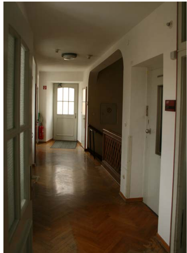
92 | Witwenbau, Mansarde, Vorplatz (Wi-1DG01) am Haupttreppenhaus gegen Norden, im Hintergrund Zugang (Wi-1DG01-Wa-T01) auf die Dachterrasse über dem Kommunikationsbau Ost (Jan. 2012)
