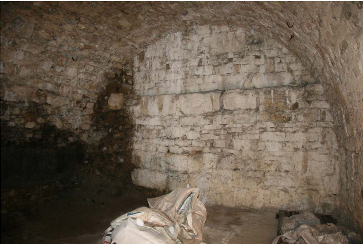
76 | Witwenbau, 2. Untergeschoss, ehem. Weinkeller (Wi-2UG02), Westwand, regelmäßiges, gekalktes Schichtenmauerwerk aus Kalksteinquadern unterschiedlichen Formats mit Absatz, möglicher älterer Baubestand (ehem. Trennwand im Graben?) (Okt. 2015)
