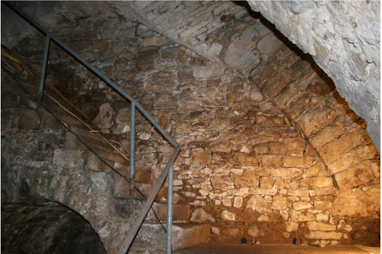
11 | Marstall, Südwand des großen Kellergewölbes (Ma-2UG01-Wc), Bruchsteinverband aus bruchrauem Kalkstein, entspricht wohl der ehem. äußeren Grabenwand des spätmittelalterlichen Schlossgrabens (Okt. 2015)
