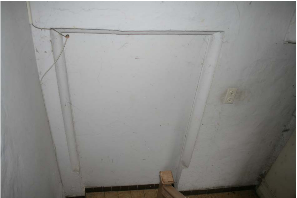
27 | Erdgeschoss, Südwand des Flurs (Tu-EG01), ehem. Durchgang (Tu-EG01-Wc-T01) in den Saalbau, Werksteinrahmen Typ B (Taf. XIVb) aus Bauphase II mit Karniesprofil und einseitigem Auslauf mit Karnies, in Bauphase III.1b zweitverwendet, in Bauphase III.3 geschlossen (Nov. 2012)
