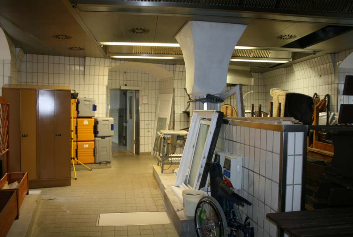
58 | Basteiturm West, Erdgeschoss, ehem. Hofküche (BaW-EG01) gegen Süden, im 20. Jahrhundert stark überformt, im Hintergrund Durchgang (VeW-EG02-Wa-T02) in den Kommunikationsbau West (Jan. 2013); historische Ansicht s. VI.14
