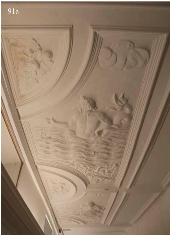
91a-c | 1. Obergeschoss, Flur (HbS-1OG01a) im Bereich der ehem. Tafelstube, Rudiment der Stuckdecke aus dem 2. Viertel des 17. Jahrhundert (a), beim Umbau 1956 letztmals überformt, in den großen Feldern verkörpern ein Triton im Meer (91a/b) und ein Jüngling mit Horn, Brustpanzer und flatterndem Gewand (91c) die Elemente Wasser und Wind, die Zwickel füllen Waffen- und Fruchtgebilde Jan. 2018)
