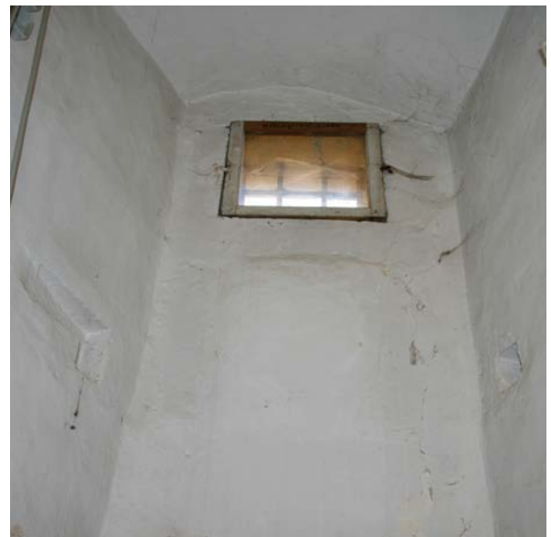
63 | Basteiturm West, 1. UG, Ostwand, nördlicher Schießstand (BaW-1UG01-Wb-N1), Beobachtungsfenster und seitlichen Aussparungen für das Prellholz auf Höhe der zugesetzten Steigbügelscharte (Okt. 2017); Gesamtansicht s. VII.62
