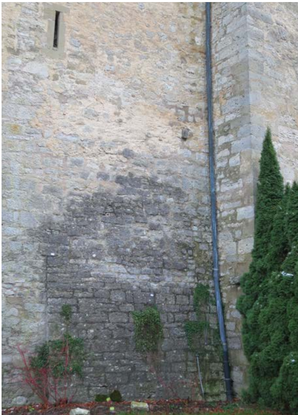
2 | Westfassade, Fundamentmauer am Eck zum vorderen Schlossbau, Teil der ehem. Burgzwingermauer aus Bauphase I.2 (s. X.1a) (Nov. 2015)
