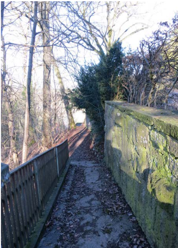
24 | Pfad unterhalb des Fahrwegs, der vom Neuem Weg über den Zugang zum Zwinger auf den Hirschberg führt, Blick gegen Nordosten, rechts Stützmauer aus mittelalterlichen Buckelquadern (vtl. von der Burgruine Leofels) (Dez. 2016)
