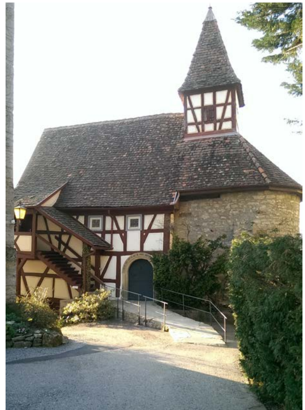
23 | Schloss Stetten, Burgkapelle gegen Norden, Fachwerkbau mit steinerne Chor im Obergeschoss eines romanischen Rundturms, steht nördlich außerhalb der Kernburg und gründet mit der Außenseite auf der spätmittelalterlichen Zwingermauer (März 2014)
