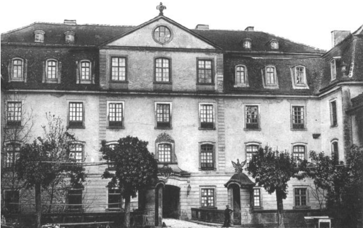
11 | Schloss Kirchberg, Südseite des vorderen Schlossbaus im Ausbaurzustand nach Abschluss des Umbaus in Bauphase IV.2c, Fotografie, frühes 20. Jahrhundert | abgeb. in DIENEL 2009 (Image8US)
