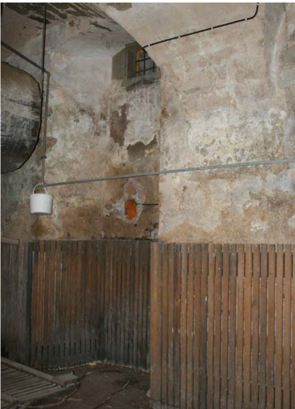
65 | Basteiturm West, 2. UG gegen Westen, ehem. südlicher Schießstand (BaW-2UG01-Wd-N2), Scharfen hinter der Lattung sekundär zugesetzt (Jan. 2013); Außenansicht s. VII.24
