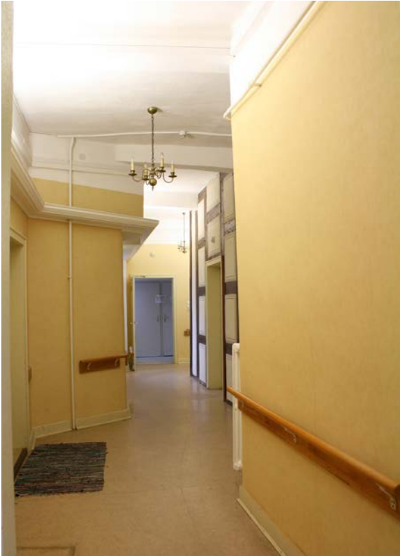
92 | Basteiturm West, 1. OG, Flur (BaW-1OG01) in den vorderen Schlossbau gegen Nordosten im Ausbauzustand nach dem Umbau von 1956 (s. XVII.8) (Nov. 2012)
