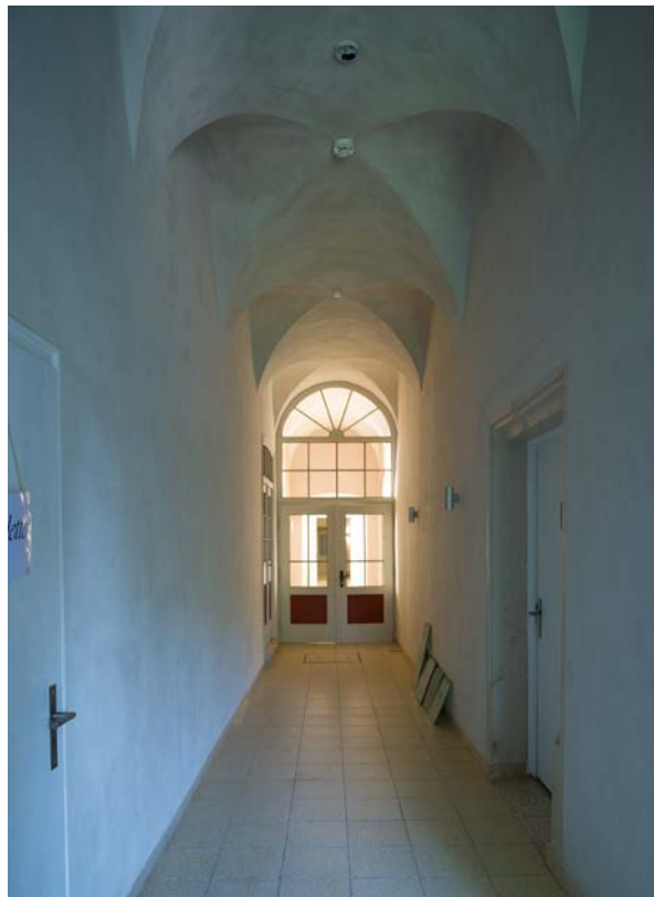
49 | EG, Gang (HbS-EG01b) westlich der Durchfahrt gegen Osten, rechts Zugang (HbS-EG03-Wa-T01) in die ehem. Gesindekammer (s. VII.54) mit Werksteinrahmen vom Typ B (Taf. XIVb) aus Bauphase II (Juli 2017) | © Isabel Muehlhaus TUM
