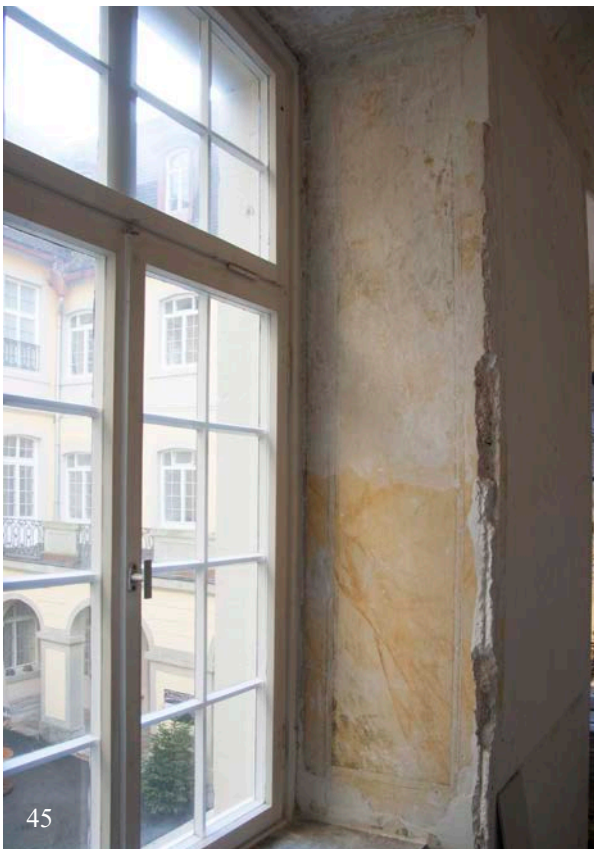
45-47 | Gang (HbW-1OG02) im 1. Obergeschoss, mittlere Fensternische (HbW-O-1OG-F04) ehemals im Bereich des Tafelzimmers, südliche Laibung mit Resten einer gelb-grünen Scheinmarmorierung, Fresko, entstanden wohl im Rahmen des Umbaus in Bauphase IV.3 um 1776 (Jan. 2018); vgl. Entwurf zum Umbau X.85
