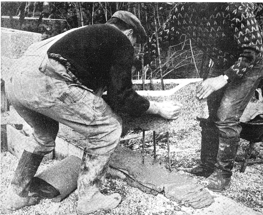
Abb. 2: Das Fundament wird mit Dachpappe abisoliert. Die unterste Steinreihe wird auf ein Ausgleichsmörtelband gesetzt.
