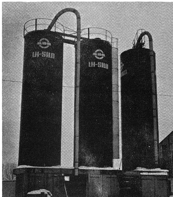
Abb. 10: Glasfaserverstärkte Kunststoffsilos auf einem Hochfundament. Die Silos werden fertig angeliefert und aufgestellt
