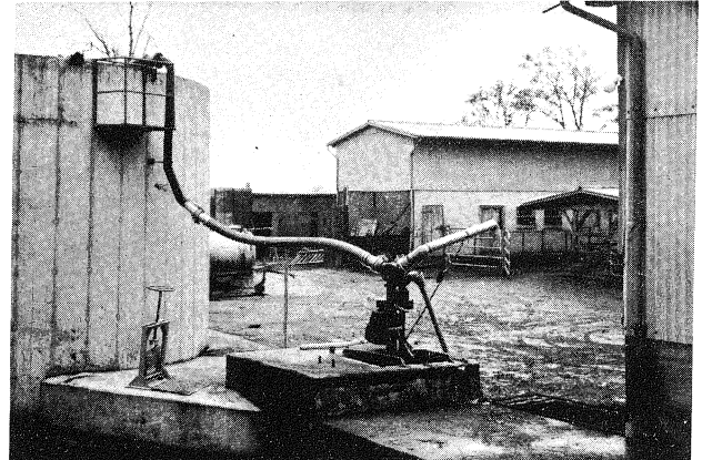
Abb. 10: Vorgrube und Hochbehälter für einen Schweinestall mit mechanischer Entmistung. Aus der Vorgrube (40 cbm) wird alle drei bis vier Wochen das anfallende Gemisch nach dem Homogenisieren in den Hochbehälter gefördert. Vom Podest aus wird der Rücklaufschieber vom Hochbehälter zum Umpumpen oder Homogenisieren des Hochbehälterinhaltes und zum Entleeren bedient. Gefüllt wird der Hochbehälter immer von oben — Abb. 11: Flüssigmistanlage mit Hochbehälter, Vorgrube und einer schleppergetriebenen stationären Flüssigmistpumpe. Zwischen Hauptbehälter und Vorgrube ist der Rücklaufkanal mit dem Absperrschieber zu sehen.
