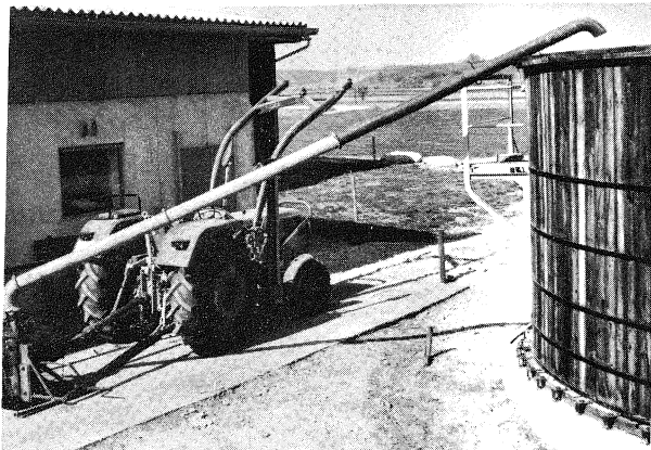
Abb. 10: Vorgrube und Hochbehälter für einen Schweinestall mit mechanischer Entmistung. Aus der Vorgrube (40 cbm) wird alle drei bis vier Wochen das anfallende Gemisch nach dem Homogenisieren in den Hochbehälter gefördert. Vom Podest aus wird der Rücklaufschieber vom Hochbehälter zum Umpumpen oder Homogenisieren des Hochbehälterinhaltes und zum Entleeren bedient. Gefüllt wird der Hochbehälter immer von oben — Abb. 11: Flüssigmistanlage mit Hochbehälter, Vorgrube und einer schleppergetriebenen stationären Flüssigmistpumpe. Zwischen Hauptbehälter und Vorgrube ist der Rücklaufkanal mit dem Absperrschieber zu sehen.
