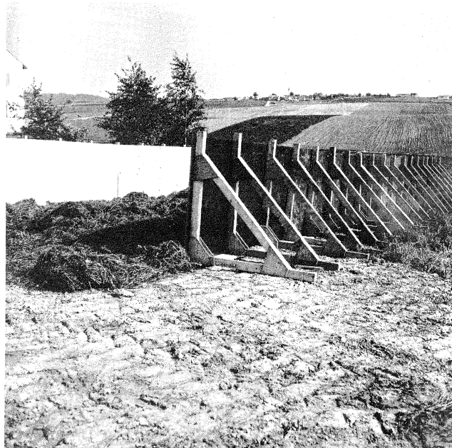
Abbildung 2: Hilfsschalung zum Anlegen von Foliensilos
