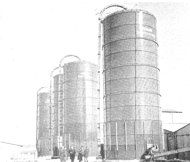
Abb. 8: Hochsiloanlage an emailliertem Blech mit Untenentnahmetechnik
