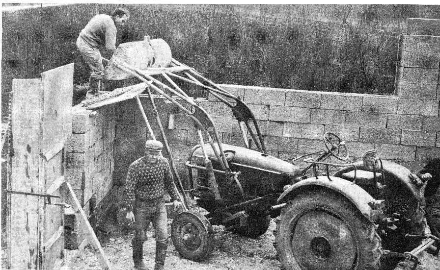
Abb. 5: Zum Befüllen höher gelegener Steinschichten nimmt man am zweckmäßigsten eine zusammengebaute Rutsche.
