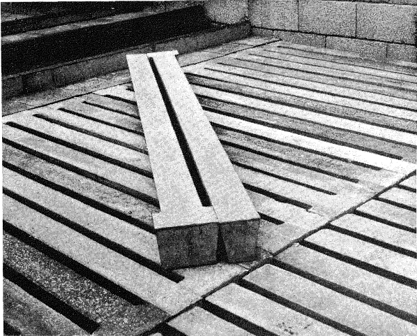
Abbildung 4 Spaltenbodenbalken mit einseitig angegossenen Distanzköpfen
