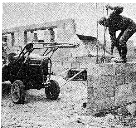
Abb. 4: Zum Einfüllen von Beton bietet sich der Frontlader an. Neben Tür- und Fensteröffnungen ist jeweils eine Armierung zur Aufnahme der Sturzlast notwendig.
