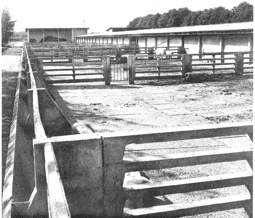
Bild 9: Eine Besonderheit waren diese weiträumigen Ausläufe an den Zucht- und Reproduktionsstätten. Bodenplatten und Trennwände bestehen aus vorgefertigten Betonteilen.
