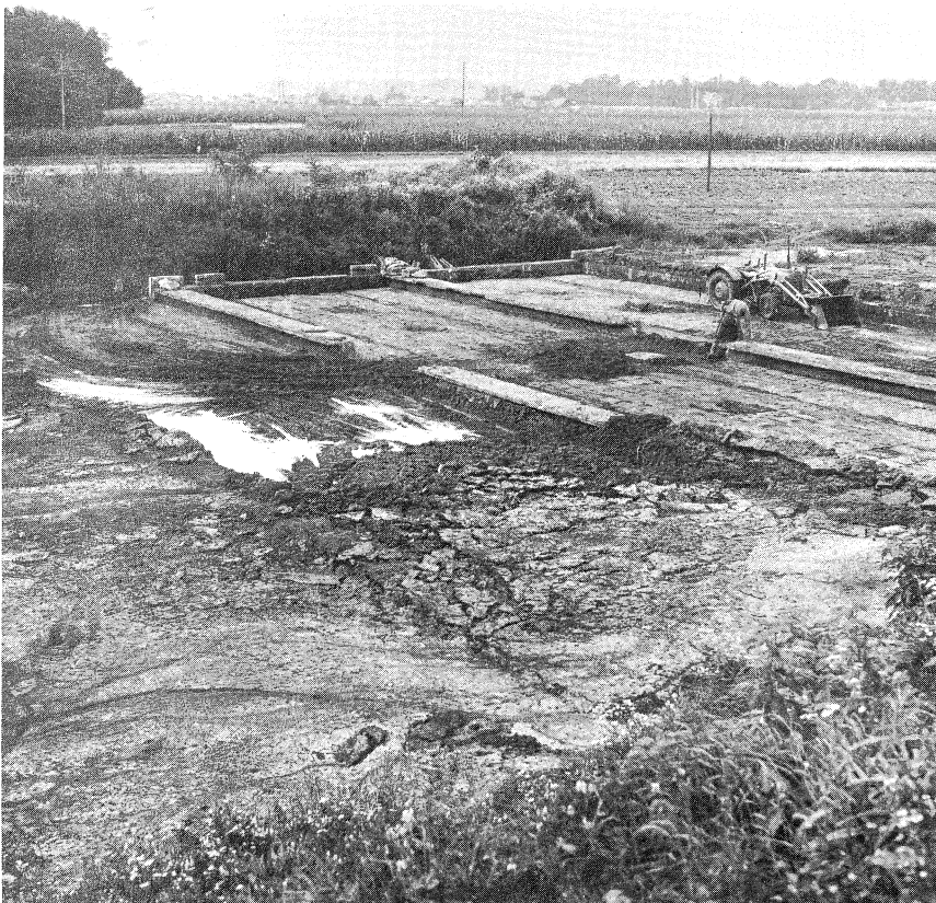
Bild 11: Dungseperatoranlage für Flüssigmist, eingesetzt bei einer Mastschweinefarm. Der gefilterte flüssige Anteil wird in einen nahegelegenen Fluß abgelassen!
