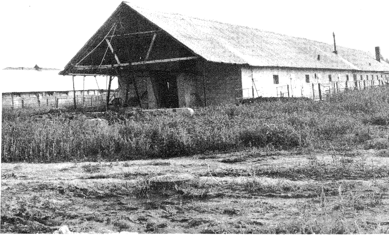
Bild 1: Typisches Altgebäude (ca. 20 Jahre) eines Großbetriebes, das nur schwer zu modernisieren ist und daher von neuen Gebäuden abgelöst werden soll
