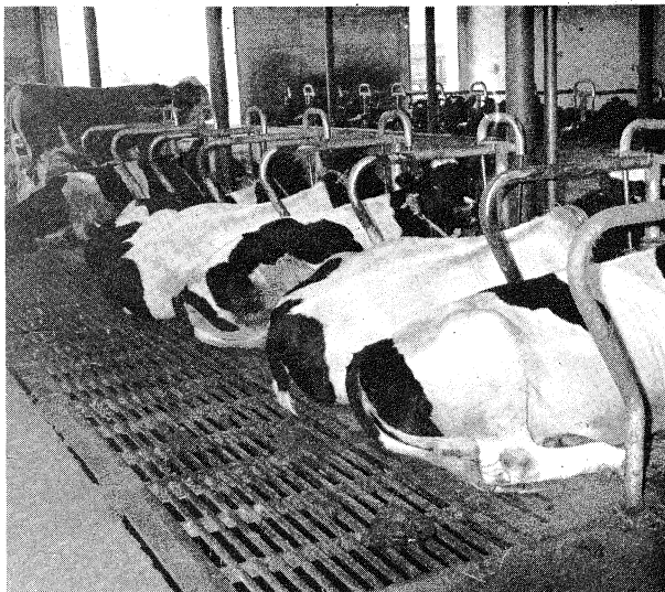
Bild 5: Ausführung von Spaltenbodenbalken
