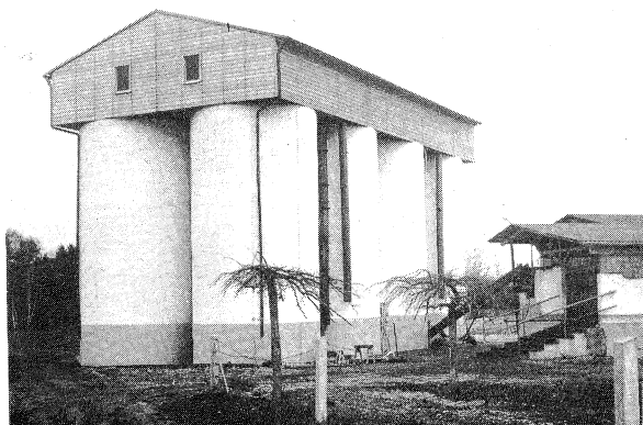
Abb. 6: Oberdachte Hochsiloanlage aus Formsteinen. Das Dach hat sich bei diesen Silos gut bewährt. Außen durch wasserabstoßende Farbe, innen durch Zweikomponentenanstriche geschützt. Die Entnahme erfolgt mittels Obenfräsen
