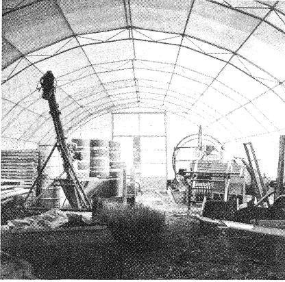
Abb. 10: Die versetzbare Leichtbauhalle eignet sich vor allem für die Unterbringung kleinerer Geräte und Maschinen. An der Entwicklung mit Spannweiten von 12 m und mehr wird gearbeitet
