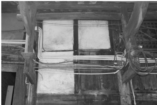
Abb. 348 Nachgetragene Kabelführung an der Fassade
