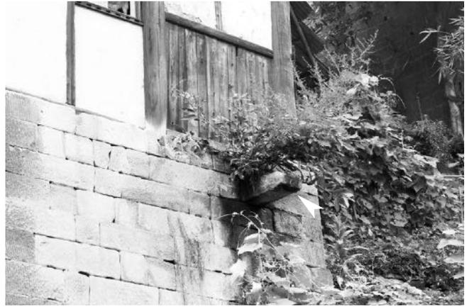
Abb. 240 Wasserspeiser aus Stein
