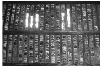
Abb. 134 Glasdachziegel im Dach
