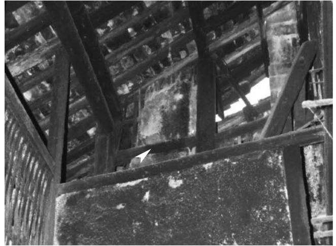
Abb. 108 Binderriegel an der Schnittstelle
