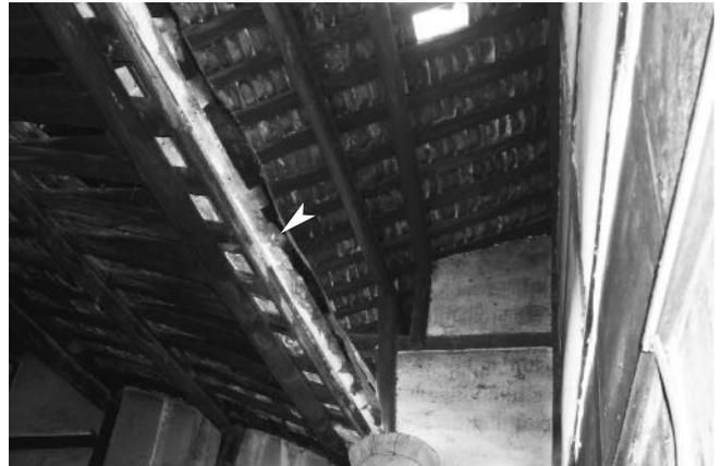
Abb. 118 Überlappung der Dachdeckungen (Raum 006)
