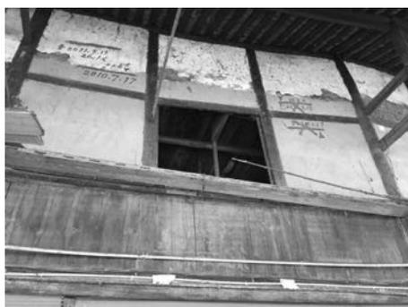
Abb. 21 Schädigung durch Hochwasser (Xiaoxi)
