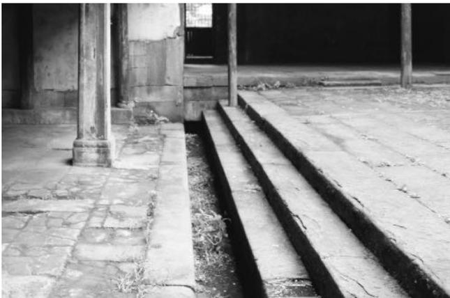
Abb. 191 Graben zur Entwässerung
