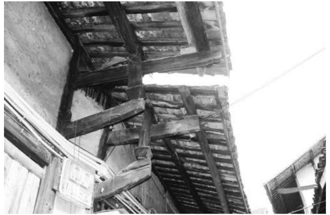
Abb. 333 Tragkonsole unter dem Vordach
