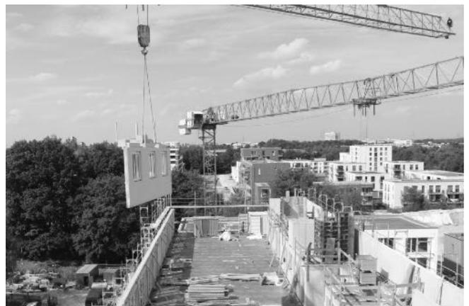
Abb. 350 Montage der Bauteile vor Ort
