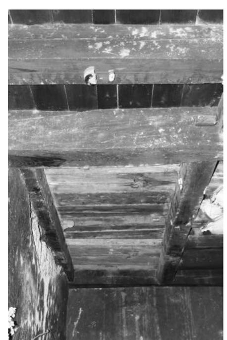
Abb. 287 Aussparung in der Balkenlage (Raum 202)
