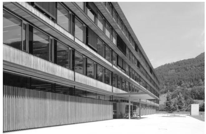
Abb. 355 IZM, fünfgeschossiger Bürobau aus Holz
