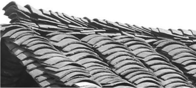
Abb. 339 Dachdeckung am First
