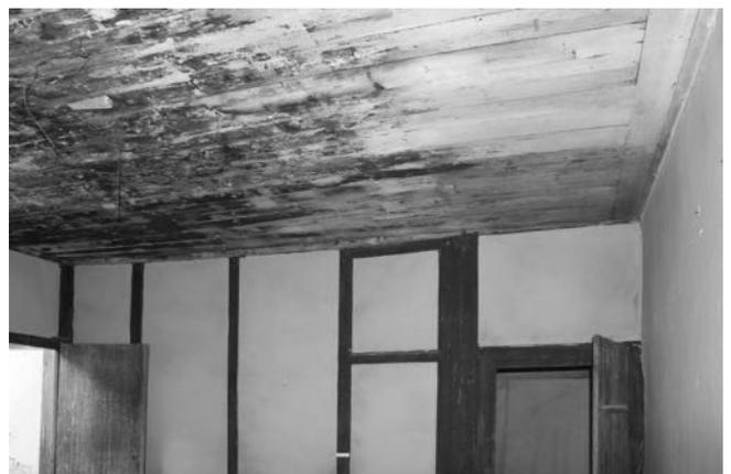
Abb. 345 Decke mit unterer Bekleidung
