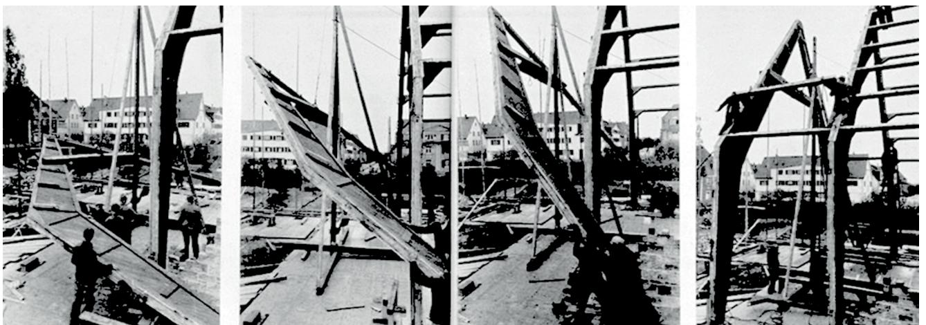
Abb. 40: Errichten einer Notkirche des Typs B
