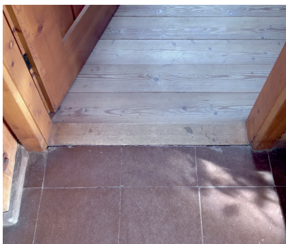
Abb. 94: Plattenbelag in der Kirche am Übergang zur Sakristei
