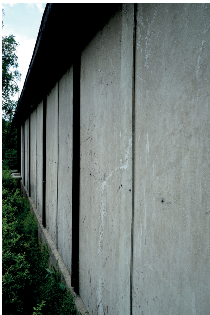
Abb. 98: Zementfaserplattenverkleidung an der Friedenskirche in Neufährn
