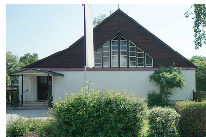
Abb. 86: Neuer Haupteingang mit Erschließungsmöglichkeit von der Straße aus in Pocking
