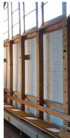
Abb. 82: Eingestellte Holzkonstruktion, Sitzbankradiatoren
