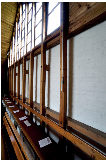
Abb. 104: Die Trennung von Holz- und Massivbaukonstruktion wird besonders klar ersichtlich anhand der vorgestellten Stützen an den Giebeln der Diasporakapellen (hier: Kreuzkiche in Pocking)
