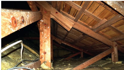
Abb. 97: Blick in den Dachraum in der Kreuzkirche in Pocking. Die Decke ist mit Mineraldämmung abgedeckt
