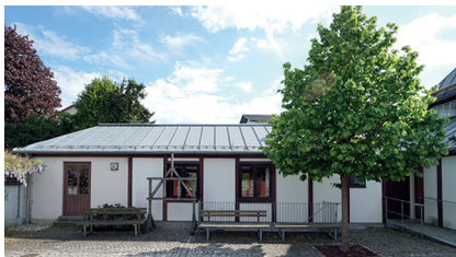
Abb. 71: 1980 zum Gemeinderaum umgebauter Anbau
