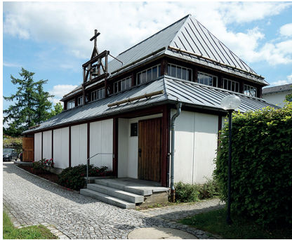
Abb. 69: Außenansicht Christuskirche in Viechtach
