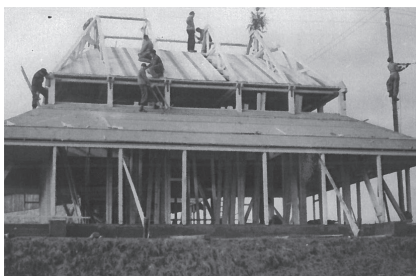
Abb. 60: Richtfest an der Friedenskirche
