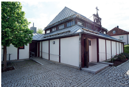
Abb. 70: Links ist unterkellerte Anbau zu sehen
