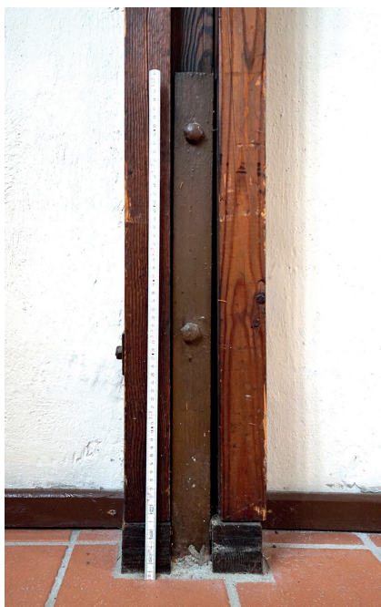
Abb. 54: Eingespannter zweiteiliger Binderstiel (Fotografiert in der Cyriakkapelle in Erfurt 2019)
