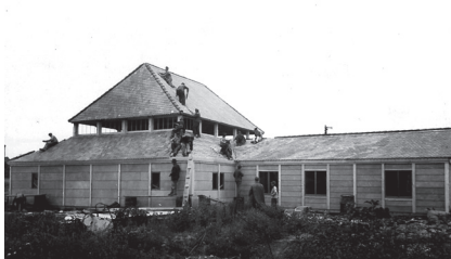
Abb. 59: Baustelle in Neufahrn Anfang 1950
