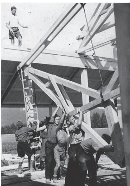
Abb. 49: Aufrichten der Dachbinder in Oberpleis
