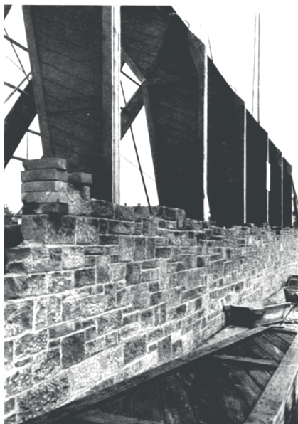
Abb. 41: Vor den Holzbindern durchgehendes Sichtmauerwerk
