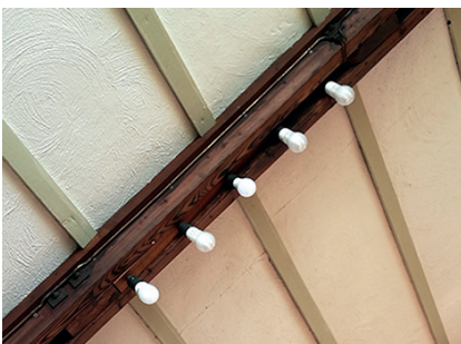
Abb. 81: Zum Vergleich: Ursprüngliche Beleuchtung an den Dachbindern in der Cyriakkapelle in Erfurt (Aufnahme 2019)
