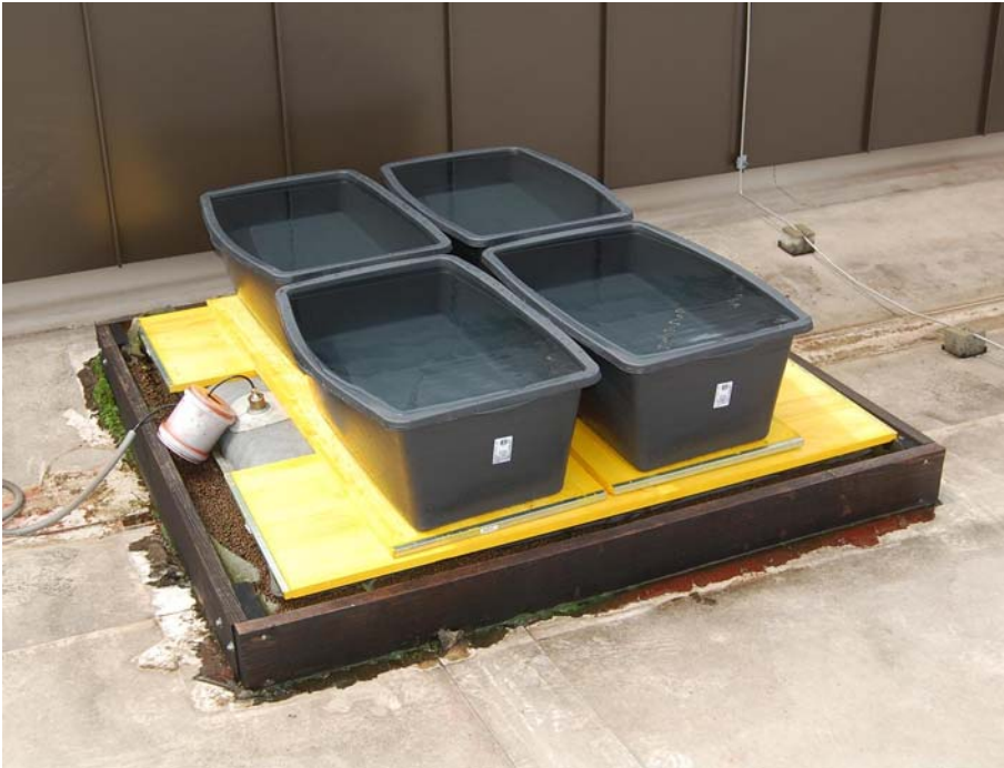
Abbildung 49: Belastung des östlichen Schneekissens mit wassergefüllten Mörtelkästen Mannlast
