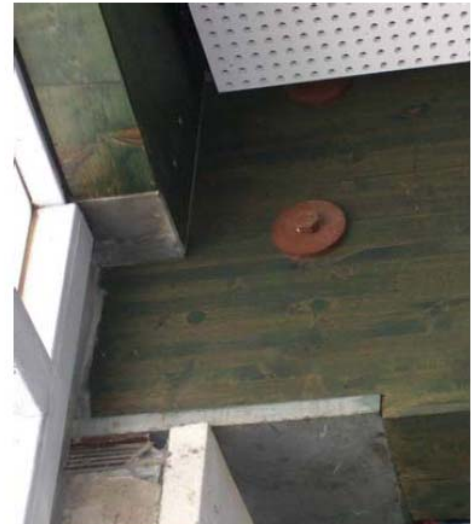
Abbildung 7: Turnhalle in Murnau, Landkreis Garmisch-Partenkirchen: Hauptträger Pos. H3 - Auflagerdetail
