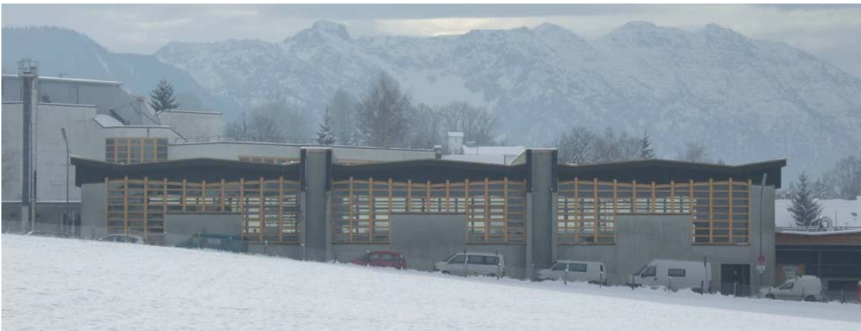
Abbildung 5: Turnhalle in Murnau, Landkreis Garmisch-Partenkirchen
