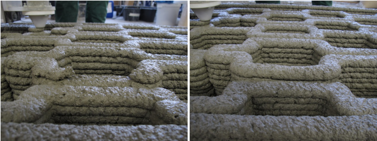
Abbildung 77: Fehlstelle in der Raupe (links) ist nach zwei weiteren Schichten (rechts) gut ausgeglichen
