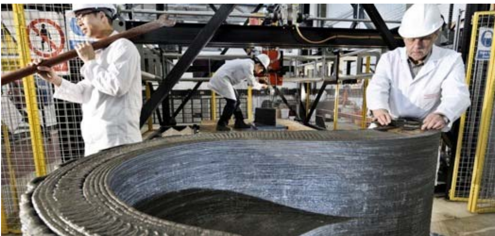
Abbildung 20: 3D Concrete Printing: Durch Extrusion von Beton additiv gefertigtes Wandelement mit integrierter Sitzbank (Loughborough University 2016b)
