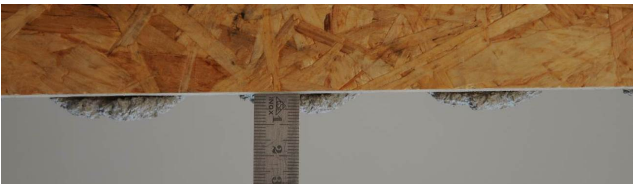
Abbildung 86: Überhangversuch I, Untersicht, Detail Schlaufe Nr. 5 mit einem Überstand von 7 mm
