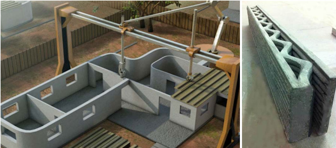
Abbildung 16: Contour Crafting: Modell des Bauprozesses vor Ort (links) und Prototyp eines mit Contour Crafting gefertigten Wandbauteils (rechts) (Khoshnevis 2016a)
