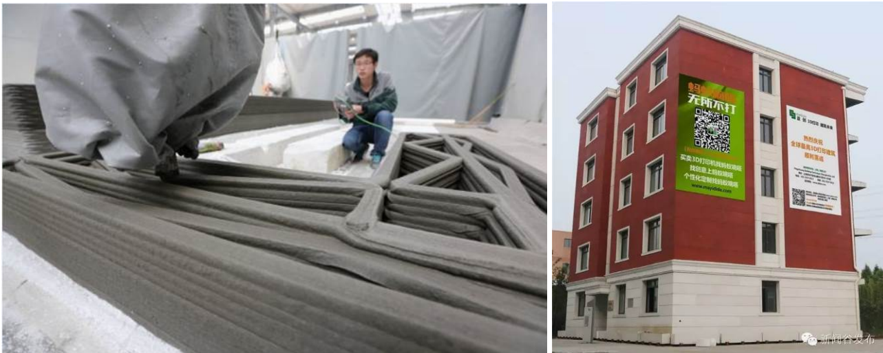
Abbildung 24: WinSun: Additive Fertigung von Bauelementen durch Extrusion von Beton im Werk (links) und aus additiv gefertigten Wandelementen aufgebautes fünfgeschossiges Wohnhaus (rechts) (WinSun 2016)
