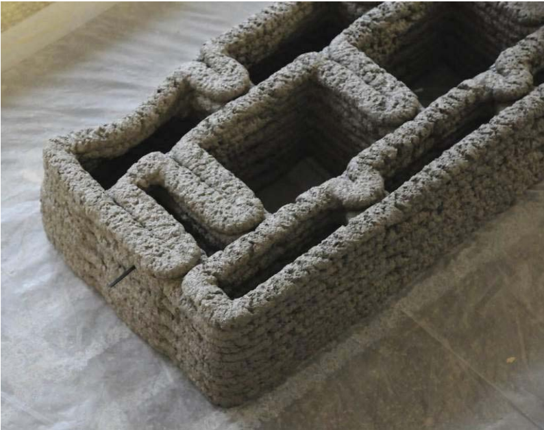
Abbildung 82: Bau eines Testobjektes mit Schichtgeometrie D, Wegkippen eines der ungehaltenen Abschnitte der einspurigen Außenscheibe nach 12 Schichten
