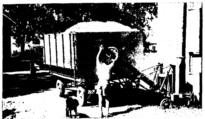
Abb. 9: Abladen von gehäckseltem Mähdrescherstroh in ein Fördergebläse, welches mit einem aufklappbaren Zubringertrog ausgerüstet ist
