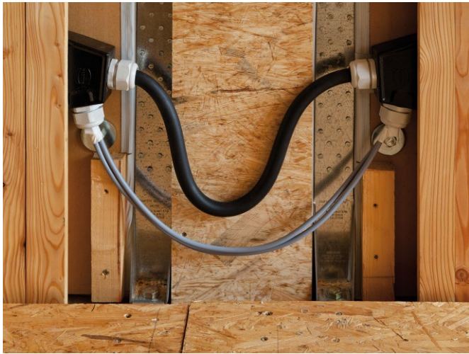
Bild 10 Kopplungsstelle für Strom zwischen zwei Raummodulen vor Zugverbindungen zur vertikalen Zugverankerung Electrical connection of two basic modules in front of two vertical tension connections of vertical anchoring
