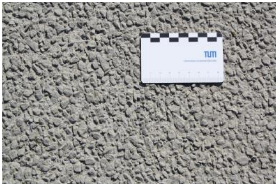
Abbildung 3: Ausbürsten des Oberflächenmörtels (oben), Waschbetontextur (unten)
