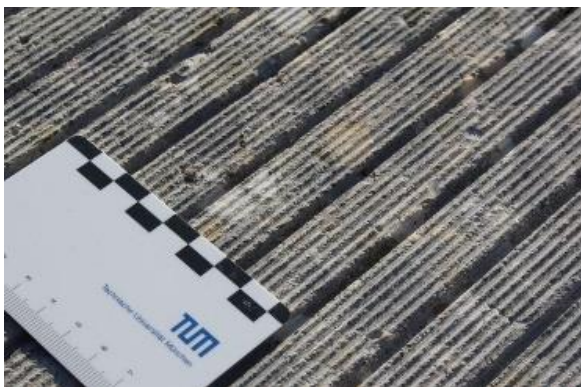
Abbildung 9: Akustisch optimierte Grindingtextur ohne (oben) und mit zusätzlichen Groovingrillen (unten) 4
