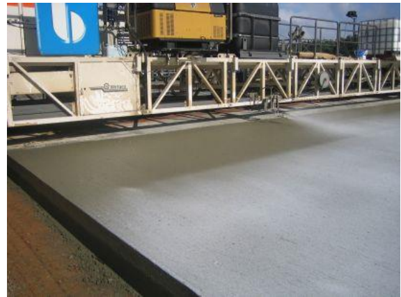
Abbildung 2: Aufsprühen des Nachbehandlungsmittels
