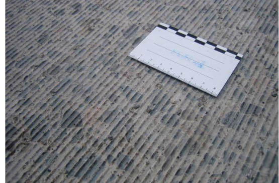
Abbildung 4: Grindingmaschine (oben), Grindingtextur (unten)
