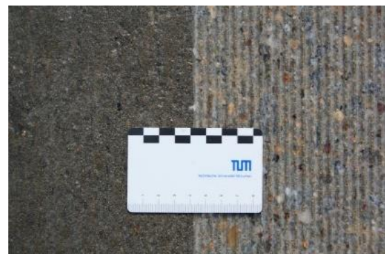
Abbildung 8: Betonoberfläche mit Jutetuchtextur (links im Bild) und Grindingtextur (rechts im Bild)
