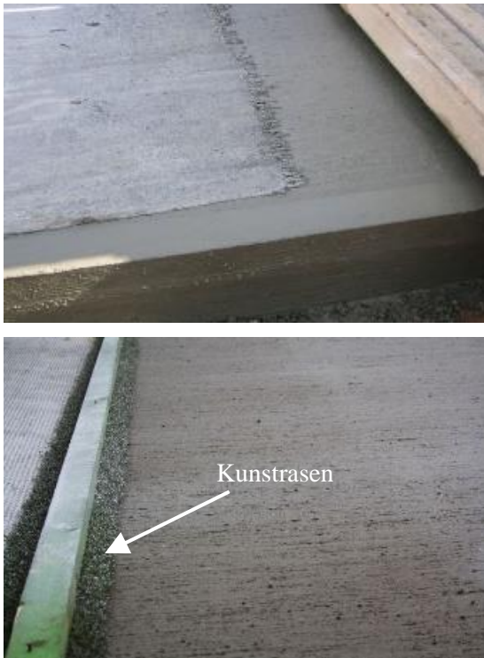
Abbildung 1: Texturieren des frischen Oberflächenmörtels: Jutetuchtextur (oben), Kunstrasentextur (unten)
